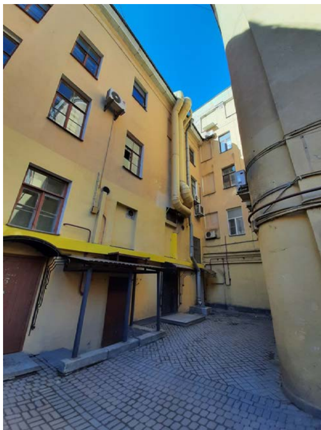
Фото 5 Фрагмент дворового фасада выявленного объекта культурного наследия «Дом Яковлевых», расположенного по адресу: Санкт-Петербург, ул. Маяковского, д. 1/96, лит. А (ул. Маяковского, д. 1, Невский пр-кт., д. 96)
