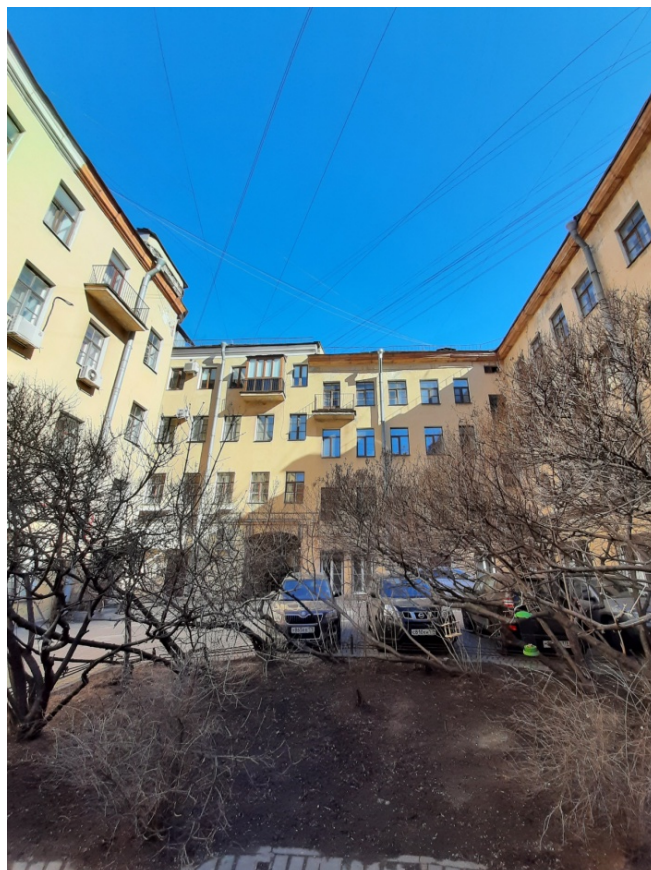
Фото 10 Фрагмент дворового фасада выявленного объекта культурного наследия «Дом Яковлевых», расположенного по адресу: Санкт-Петербург, ул. Маяковского, д. 1/96, лит. А (ул. Маяковского, д. 1, Невский пр-кт., д. 96)
