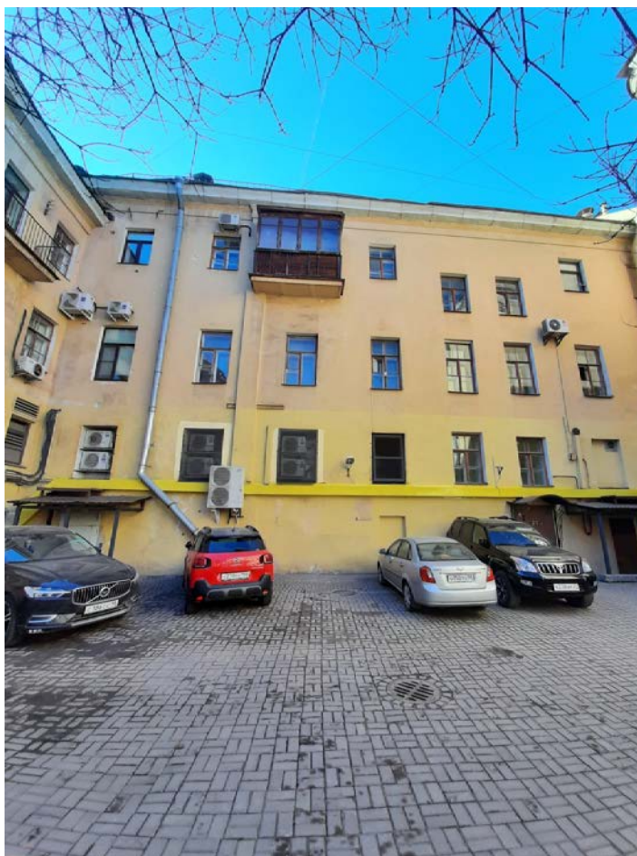
Фото 6 Фрагмент дворового фасада выявленного объекта культурного наследия «Дом Яковлевых», расположенного по адресу: Санкт-Петербург, ул. Маяковского, д. 1/96, лит. А (ул. Маяковского, д. 1, Невский пр-кт., д. 96)
