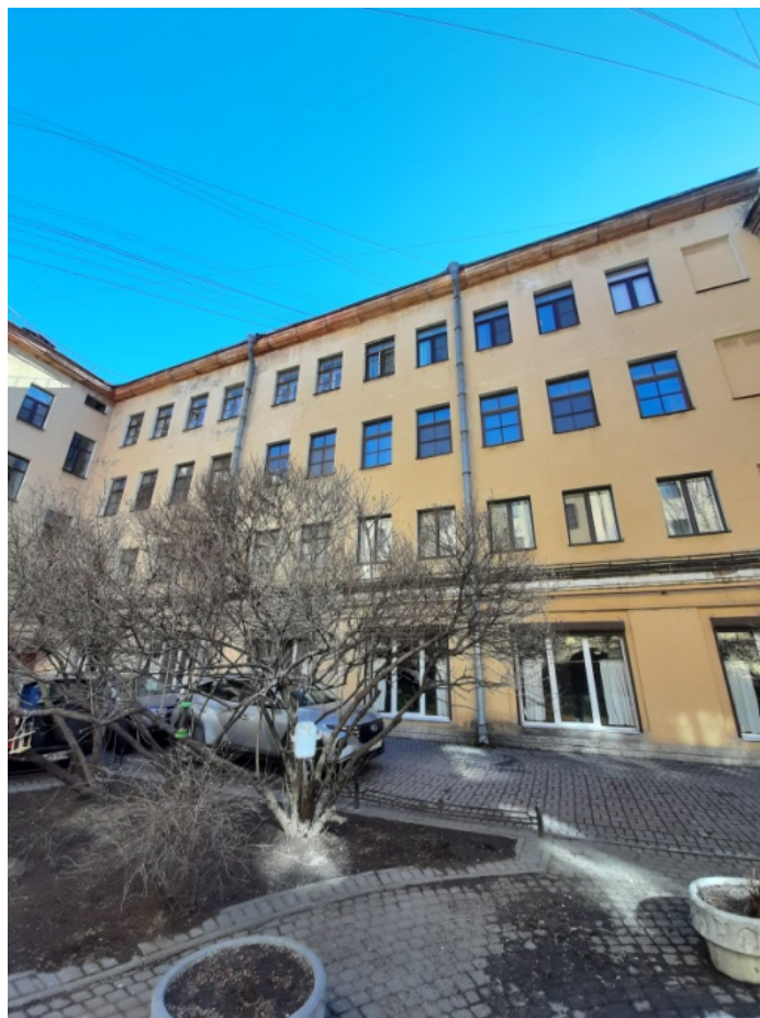
Фото 9 Фрагмент дворового фасада выявленного объекта культурного наследия «Дом Яковлевых», расположенного по адресу: Санкт-Петербург, ул. Маяковского, д. 1/96, лит. А (ул. Маяковского, д. 1, Невский пр-кт., д. 96)
