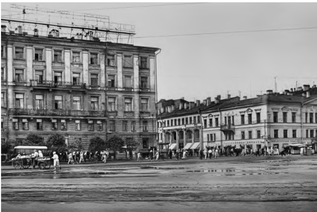
Илл. 10. 1959 год. Вид на фасады дома 56 и дома 58 со стороны Садовой улицы (источник: https://www.citywalls.ru/ ).
