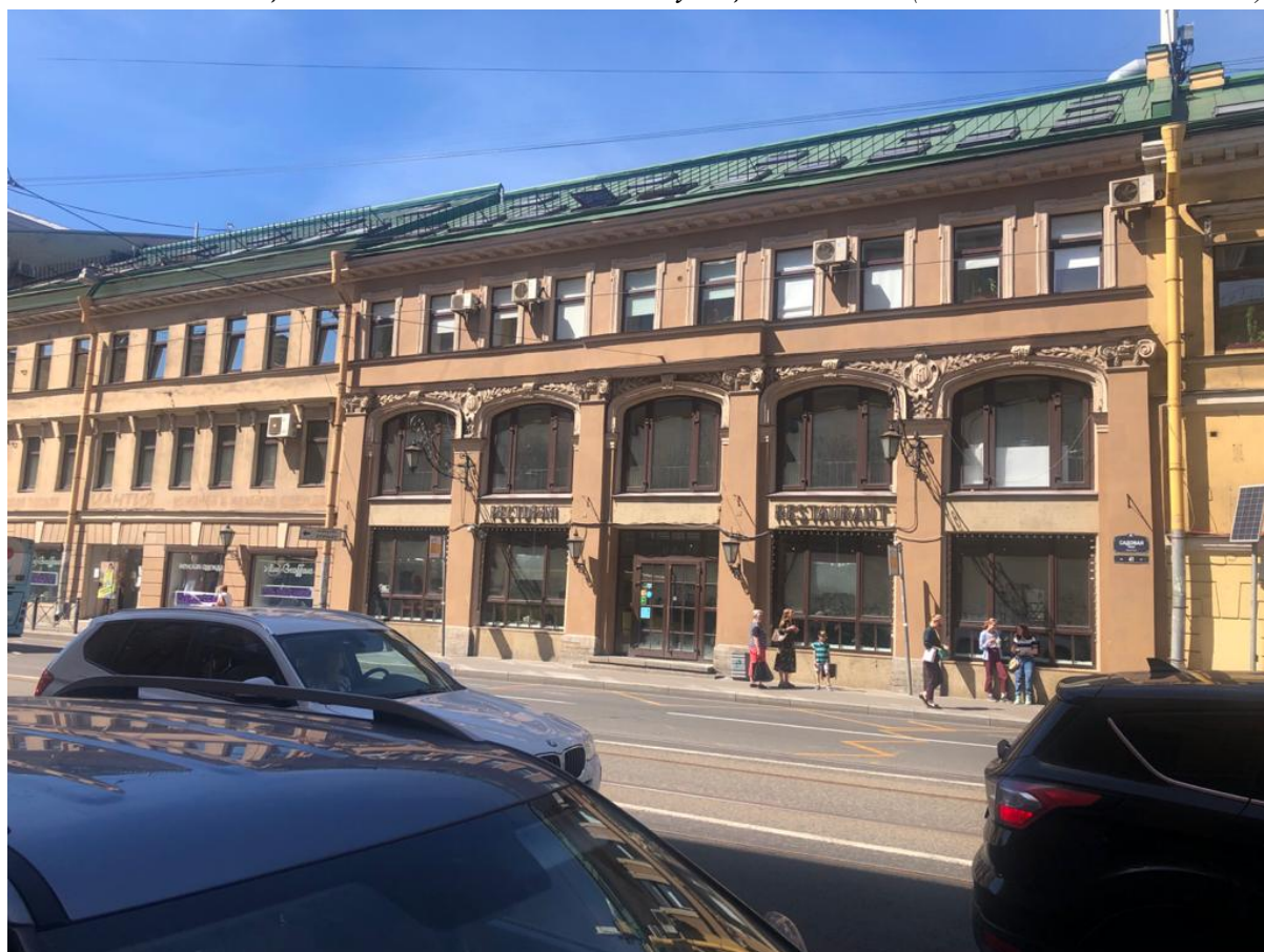
Илл. 12. Фасад лицевой юго-восточный. Вид с улицы Садовая. (Фото от 15 мая 2021г.)
