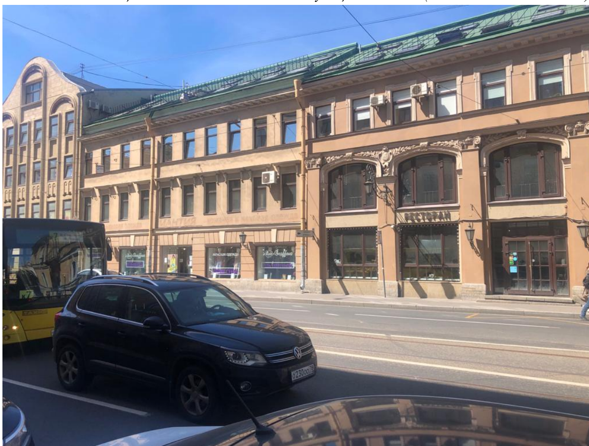
Илл. 14. Фасад лицевой юго-восточный. Вид с улицы Садовая. (Фото от 15 мая 2021г.)
