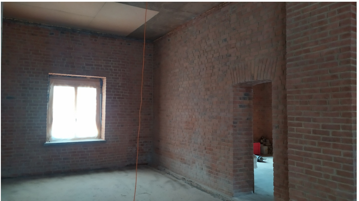
6. Помещение №1 (5-Н) в уровне 1-го этажа объекта культурного наследия регионального значения «Службы при дворце О.В. Гогенфельзен (Палей)», расположенного по адресу: Санкт-Петербург, г. Пушкин, Московский пер. д. 7/20, литера А. 30.01.2022.
