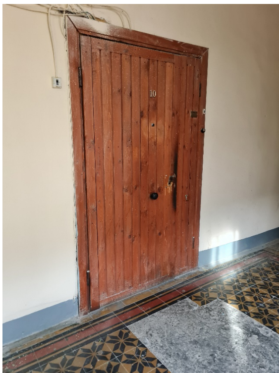
Фото 3. Входное дверное заполнение в квартиру №10
