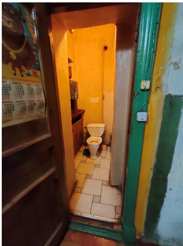
Фото 6. Интерьер квартиры №10, ч.п. №3, вид на ч.п. 4
