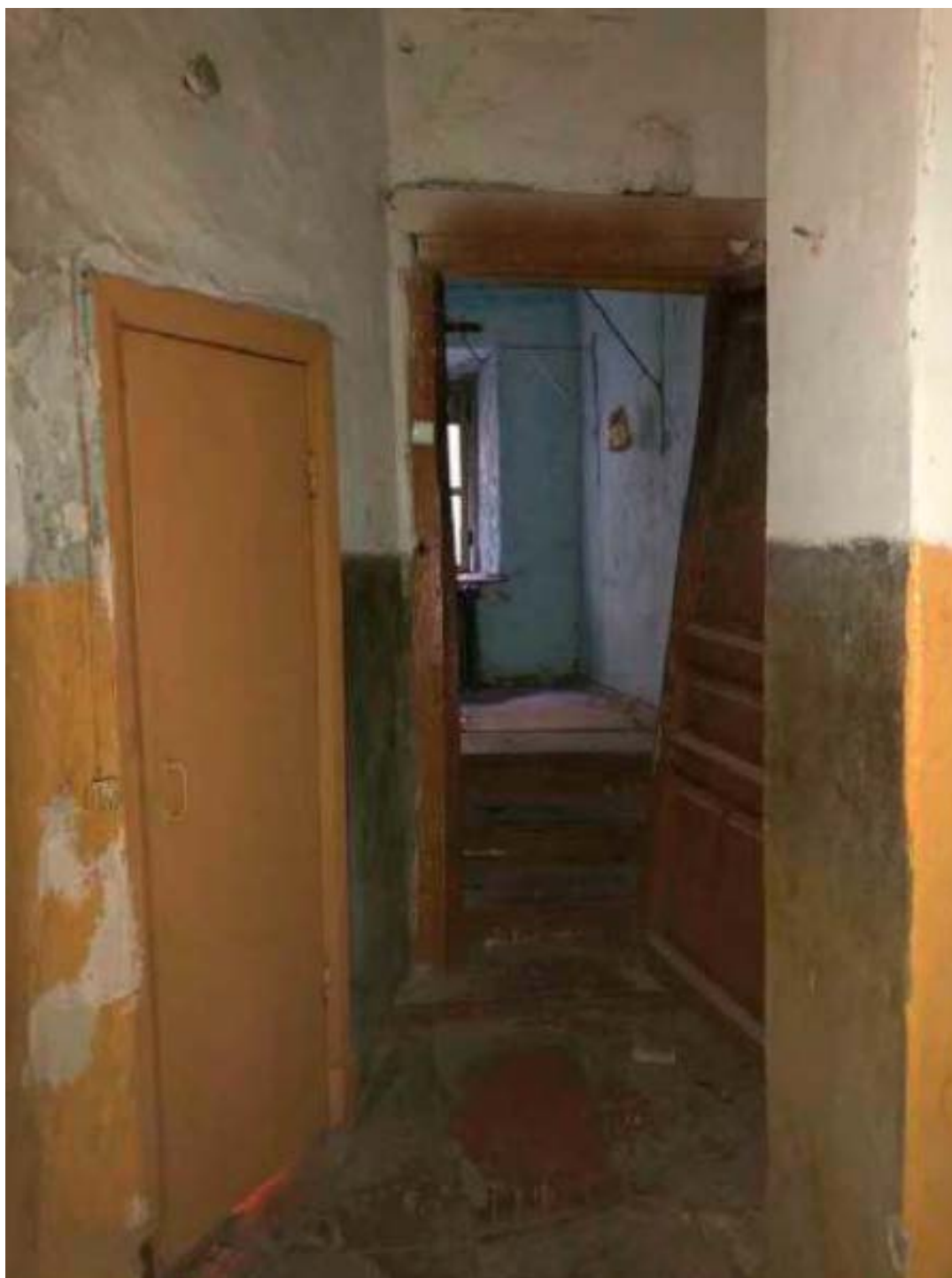
10. Помещение №16 кв. №11 в уровне 1-го этажа объекта культурного наследия регионального значения «Дом кн. Л.Д. Вяземского», расположенного по адресу: г. Санкт-Петербург, Галерная ул., д. 67, литера А. 15.12.2021.
