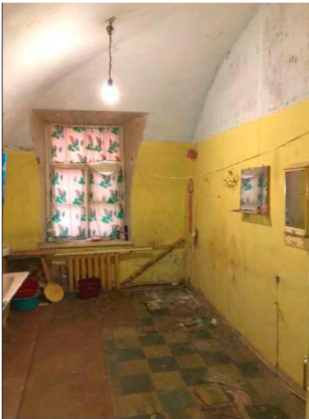
5. Помещение №6 кв. №11 в уровне 1-го этажа объекта культурного наследия регионального значения «Дом кн. Л.Д. Вяземского», расположенного по адресу: г. Санкт-Петербург, Галерная ул., д. 67, литера А. 15.12.2021.
