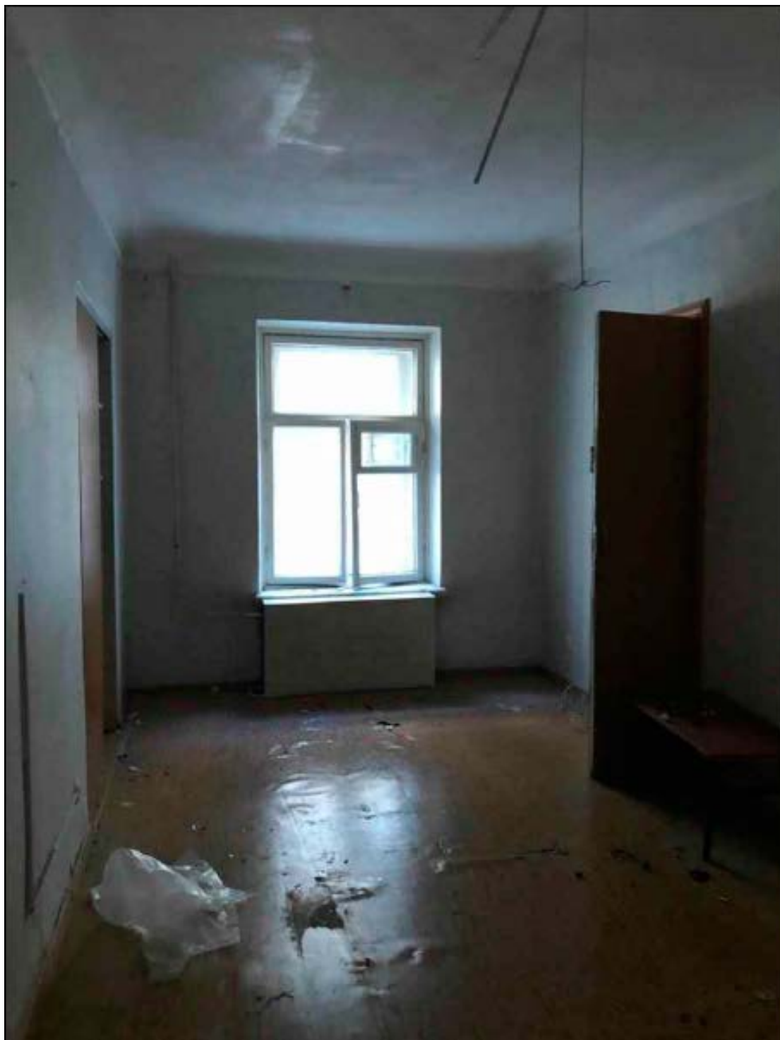
7. Помещение №10 кв. №11 в уровне 1-го этажа объекта культурного наследия регионального значения «Дом кн. Л.Д. Вяземского», расположенного по адресу: г. Санкт-Петербург, Галерная ул., д. 67, литера А. 15.12.2021.
