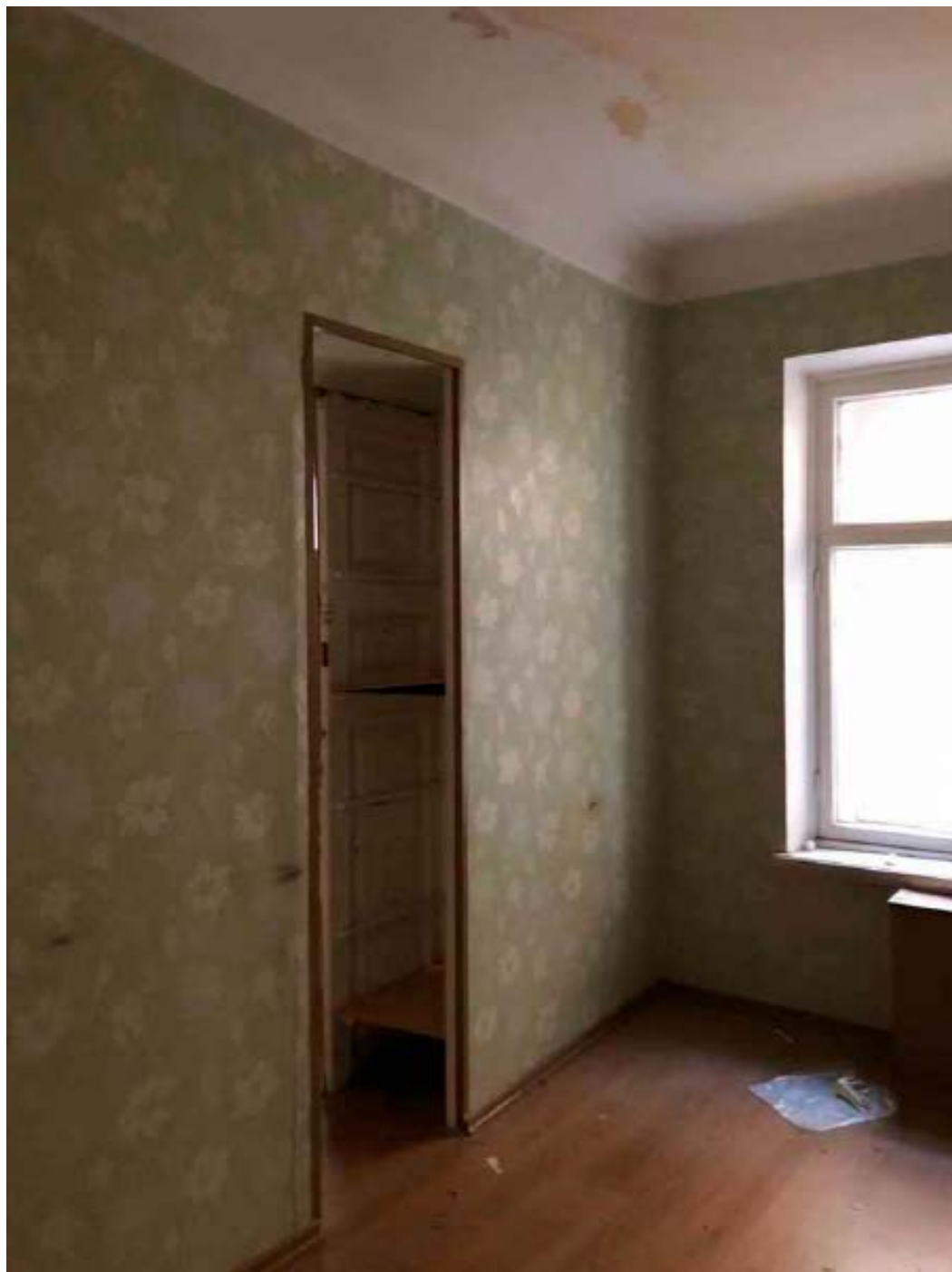
б. Помещение №8 кв. №11 в уровне 1-го этажа объекта культурного наследия регионального значения «Дом кн. Л.Д. Вяземского», расположенного по адресу: г. Санкт-Петербург, Галерная ул., д. 67, литера А. 15.12.2021.
