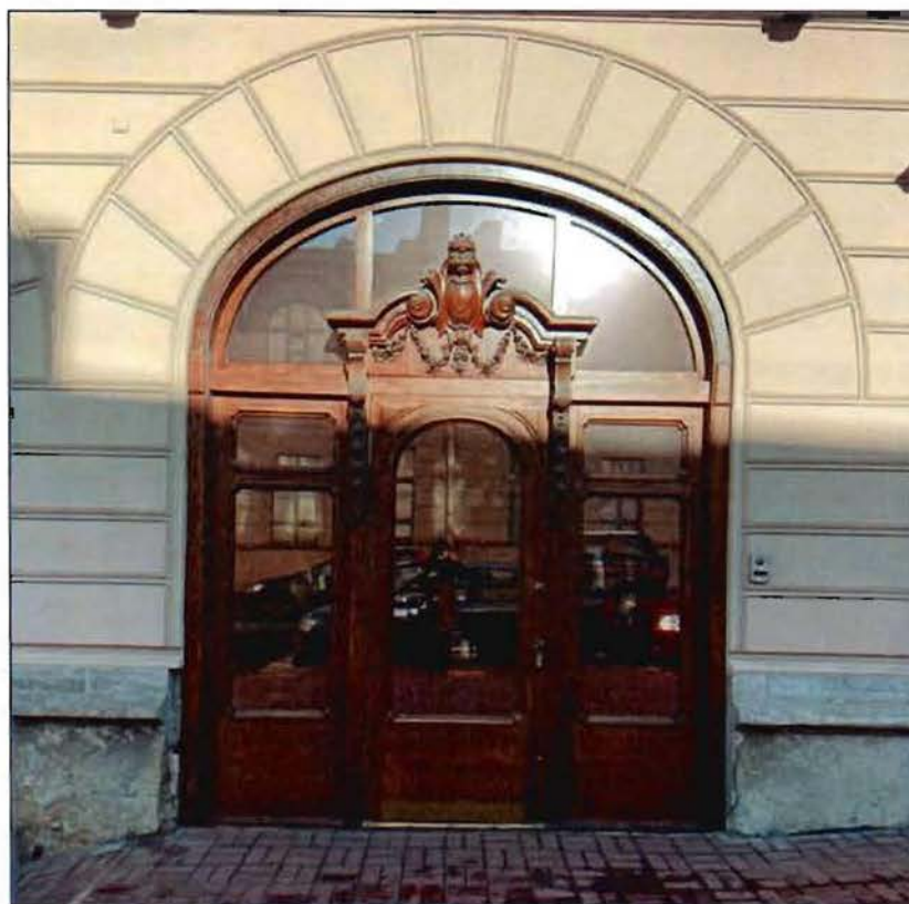
8. Деревянное заполнение входа со стороны Шпалерной улицы.
