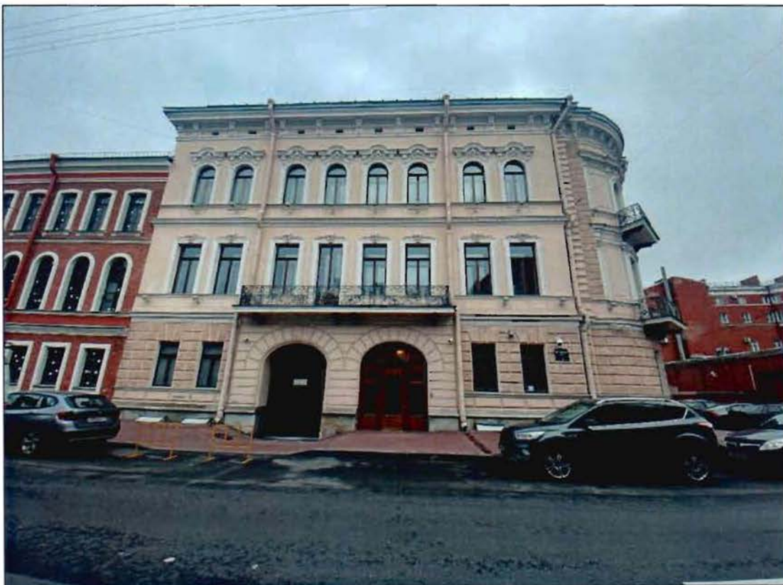
5. Южный фасад объекта культурного наследия.
