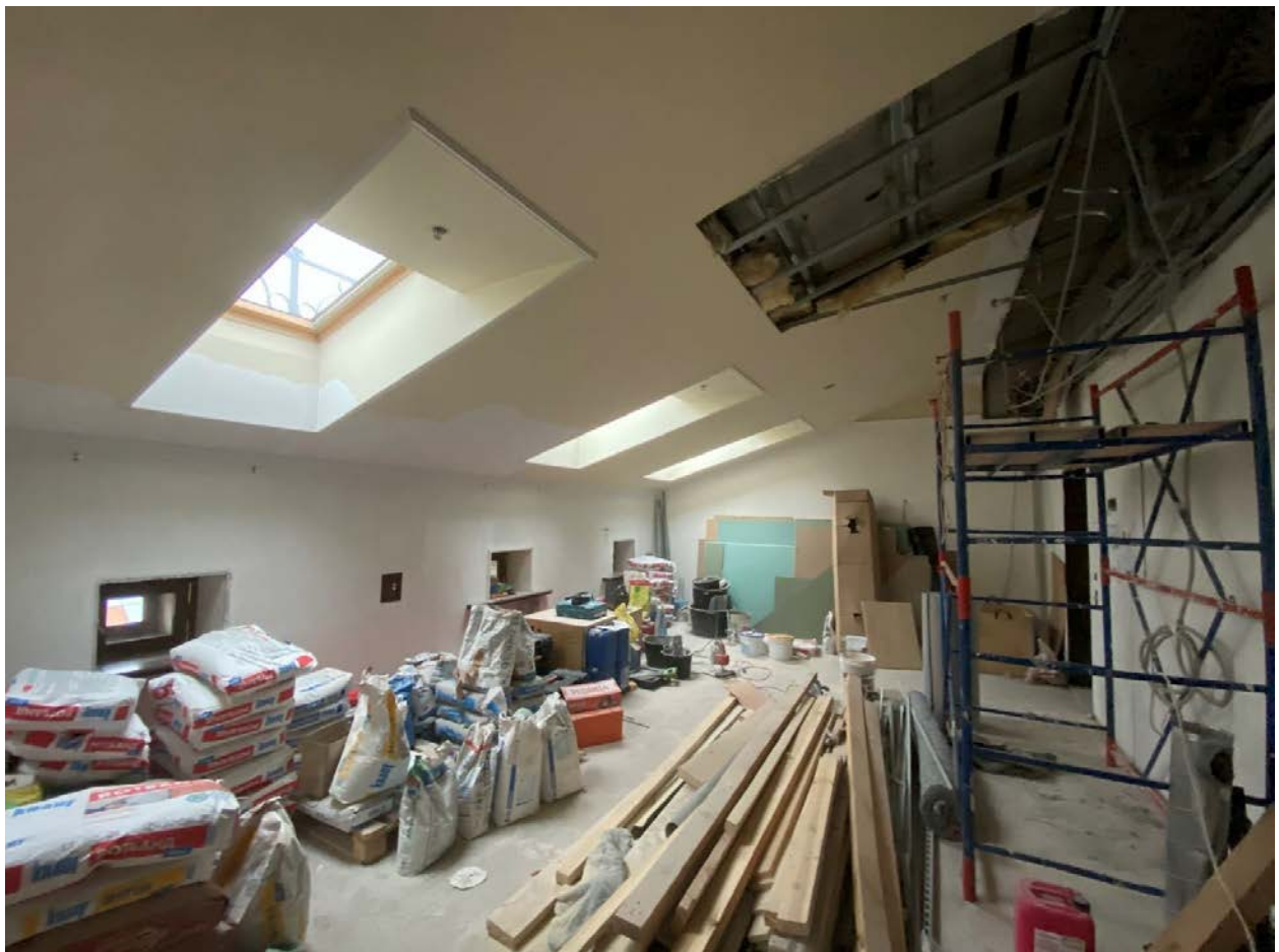
Фото 22. Помещение № 237. Кабинет. Вид с востока.
