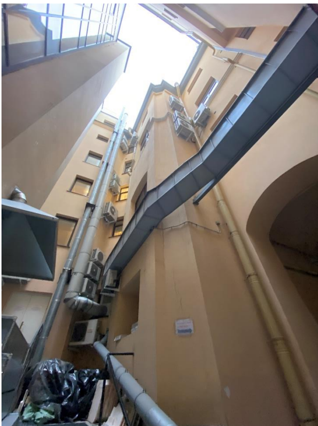
Фото 8. Северный дворовый фасад.
