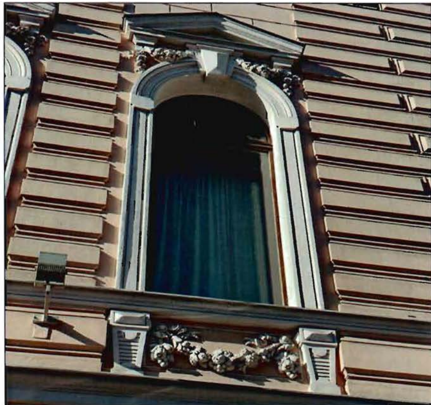
12. Профилированные наличники, раскрепованный сандрик с лепниной в тимпане в оформлении оконных проемов в уровне 3-го этажа.
