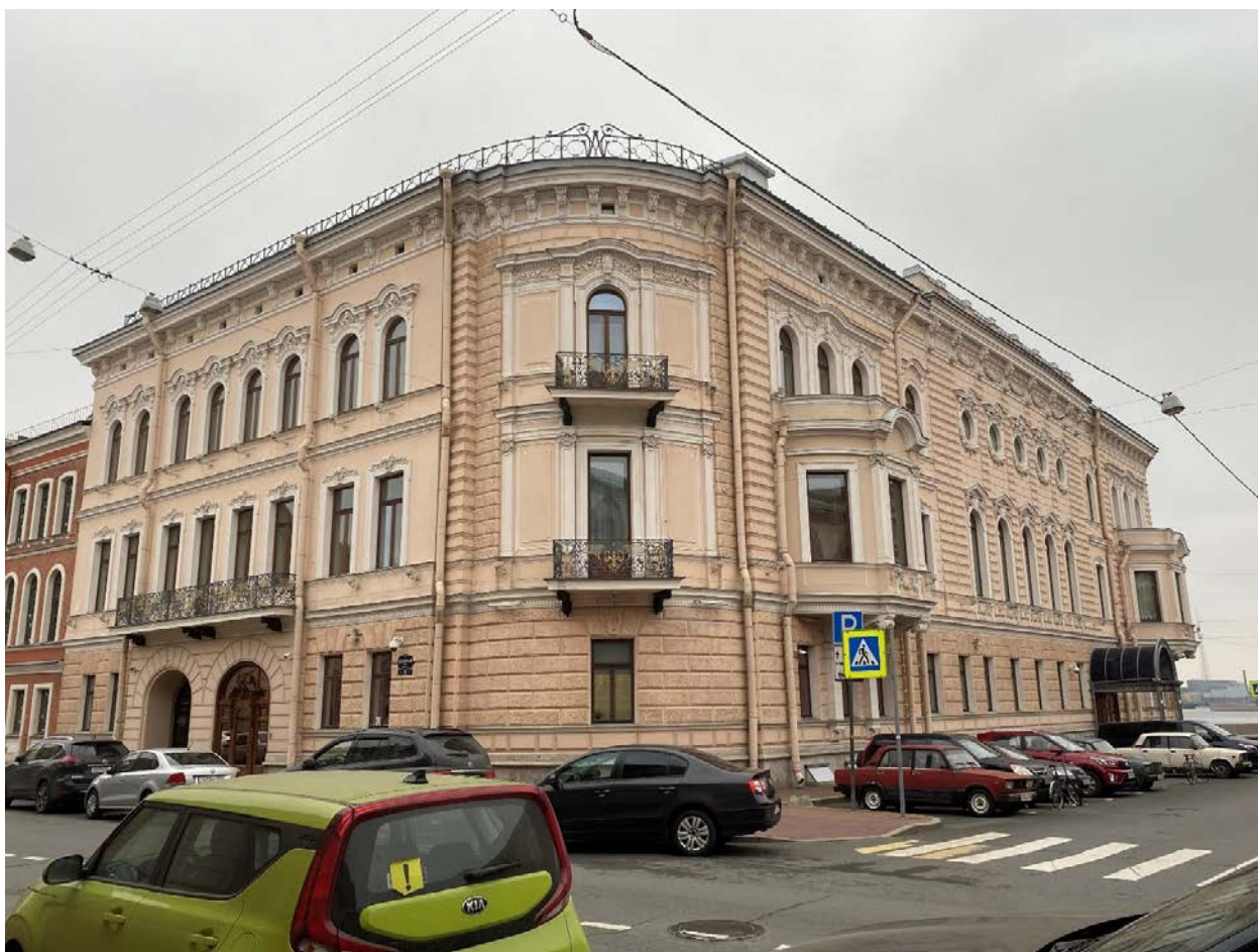
Фото 1. Общий вид объекта культурного наследия регионального значения «Особняк Шереметьева», расположенного по адресу: Санкт-Петербург, Шпалерная улица, дом 18, литера А.
