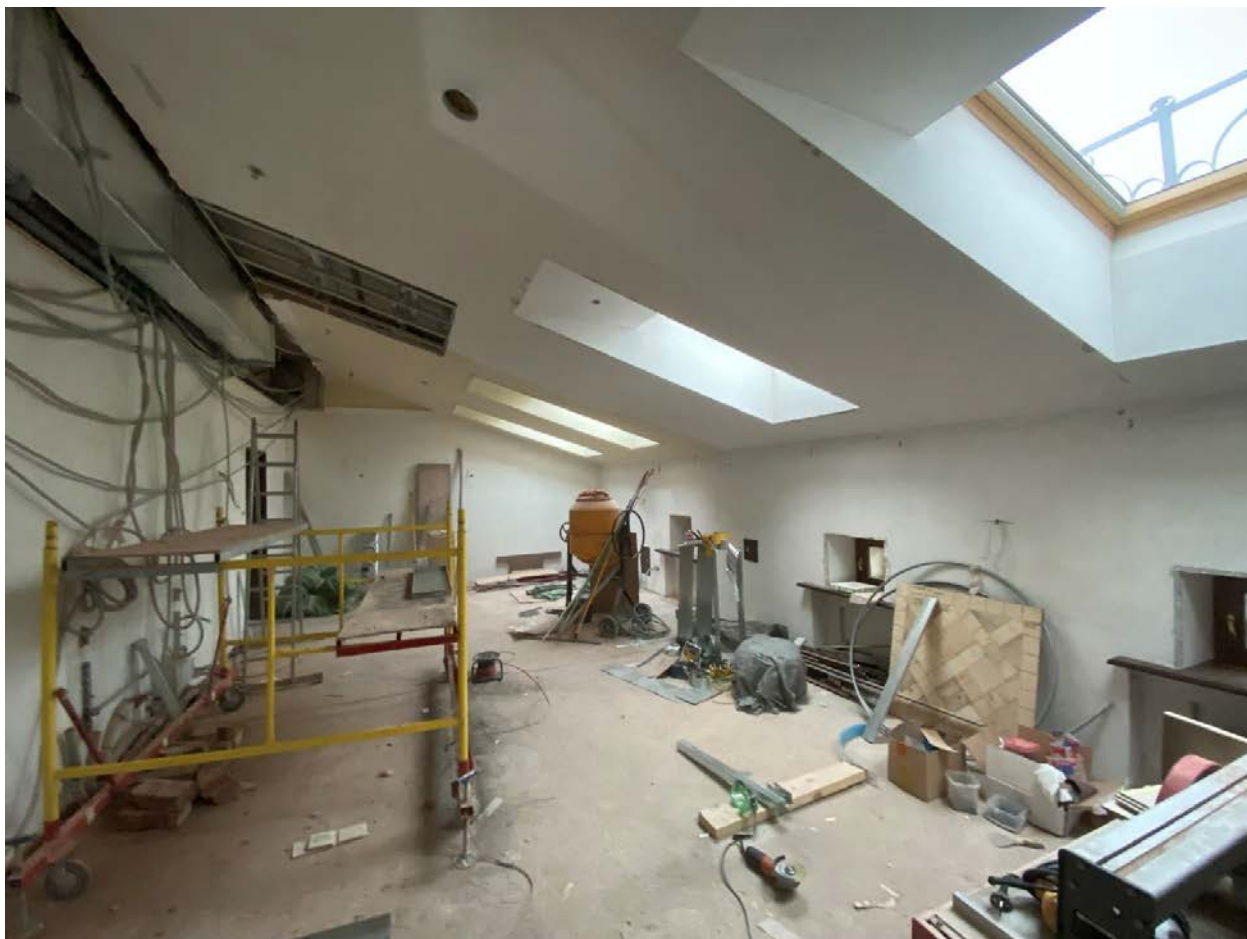
Фото 25. Помещение № 242. Кабинет. Вид с запада.
