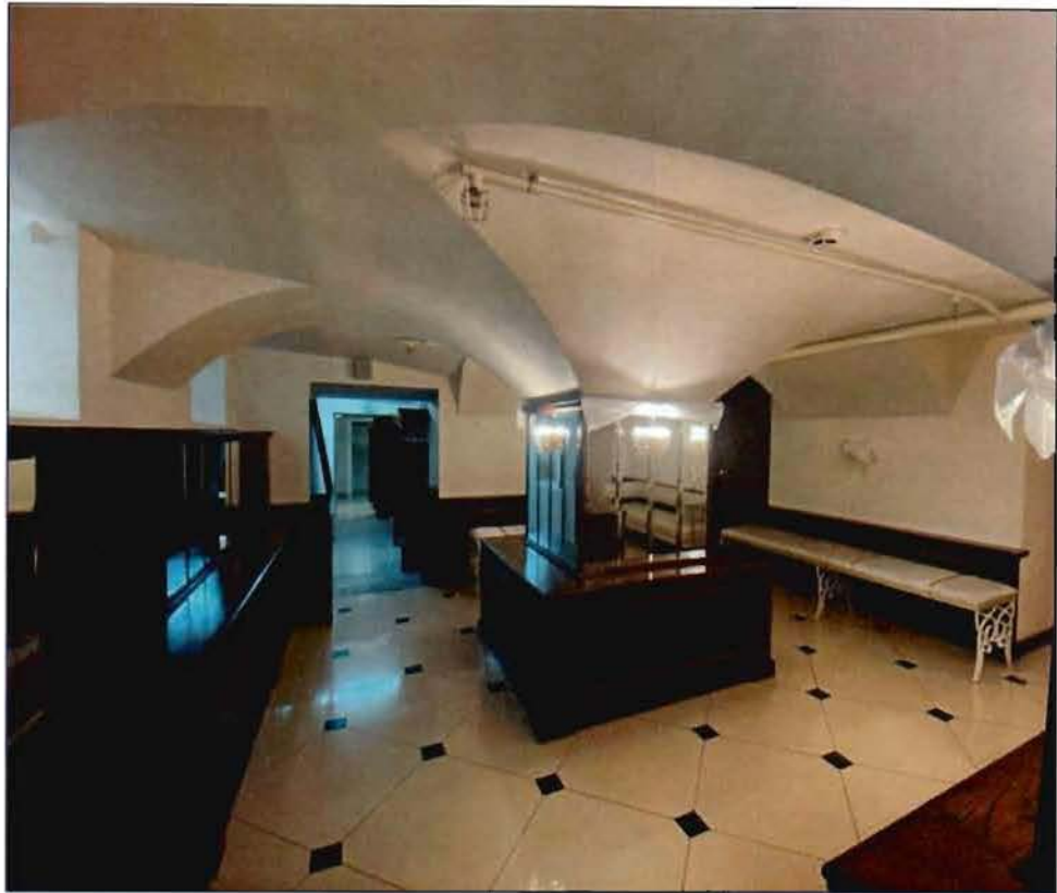
15. Сводчатые перекрытия помещений на столбах
