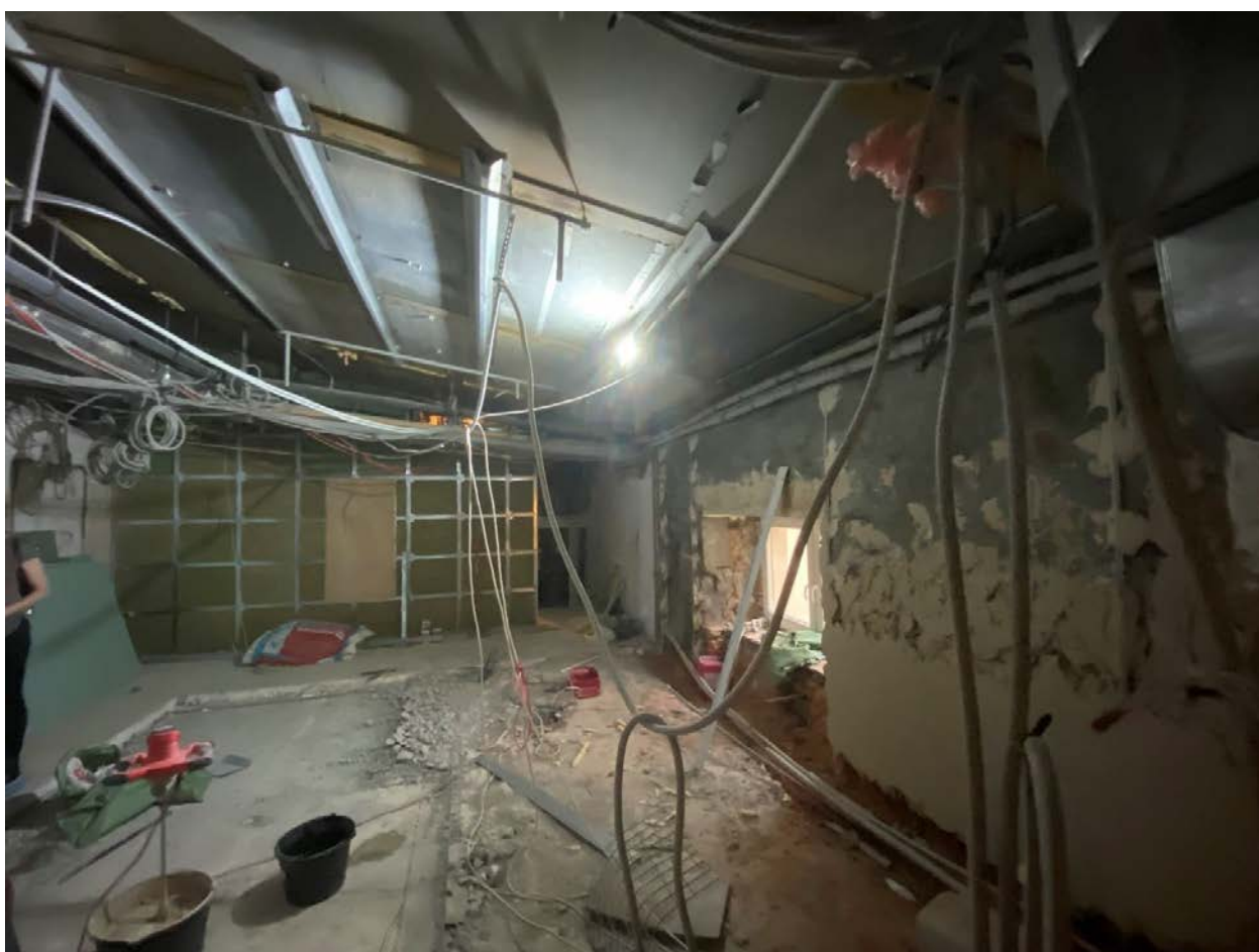
Фото 19. Помещение № 241. Кабинет. Вид с востока.
