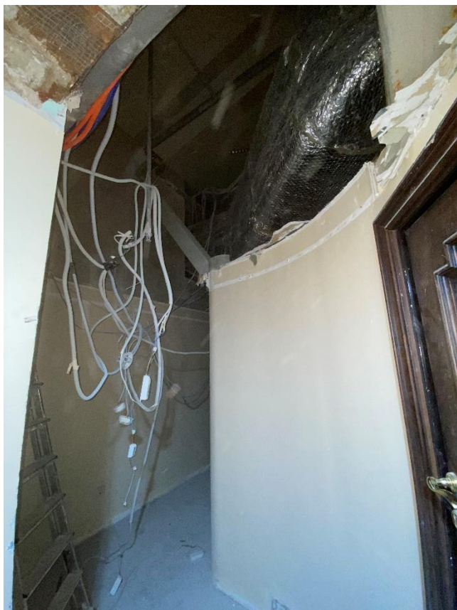
Фото 16. Помещений № 227. Коридор. Вид с северо-запада.
