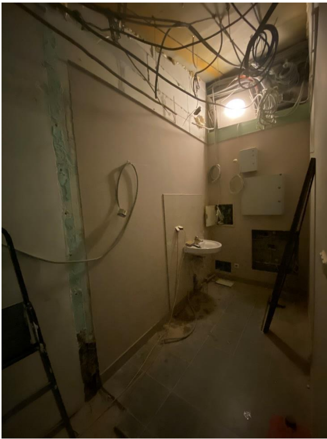
Фото 20. Помещение № 244. Умывальная. Вид с востока.
