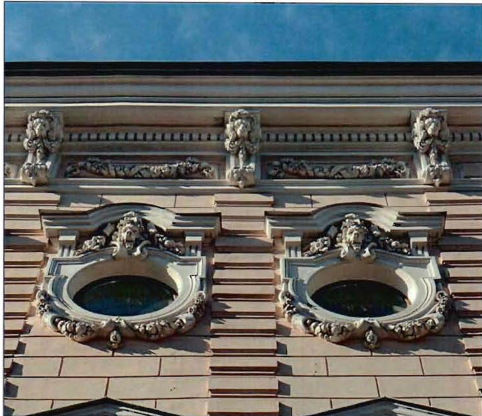
13. Круглые окна с сандриками на консолях, с лепниной в тимпане и лепными гирляндами.
