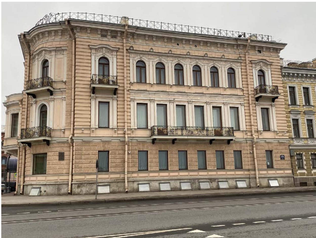
Фото 5. Северный личевой фасад, выходящий на набережную Кутузова.
