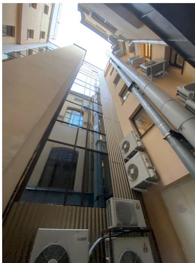
Фото 7. Западный дворовый фасад.
