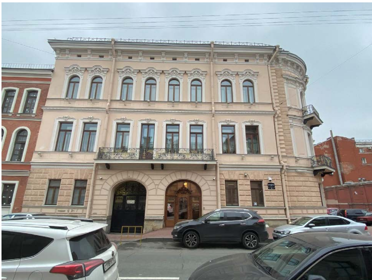
Фото 2. Южный лицевой фасад, выходящий на ул. Шпалерную.
