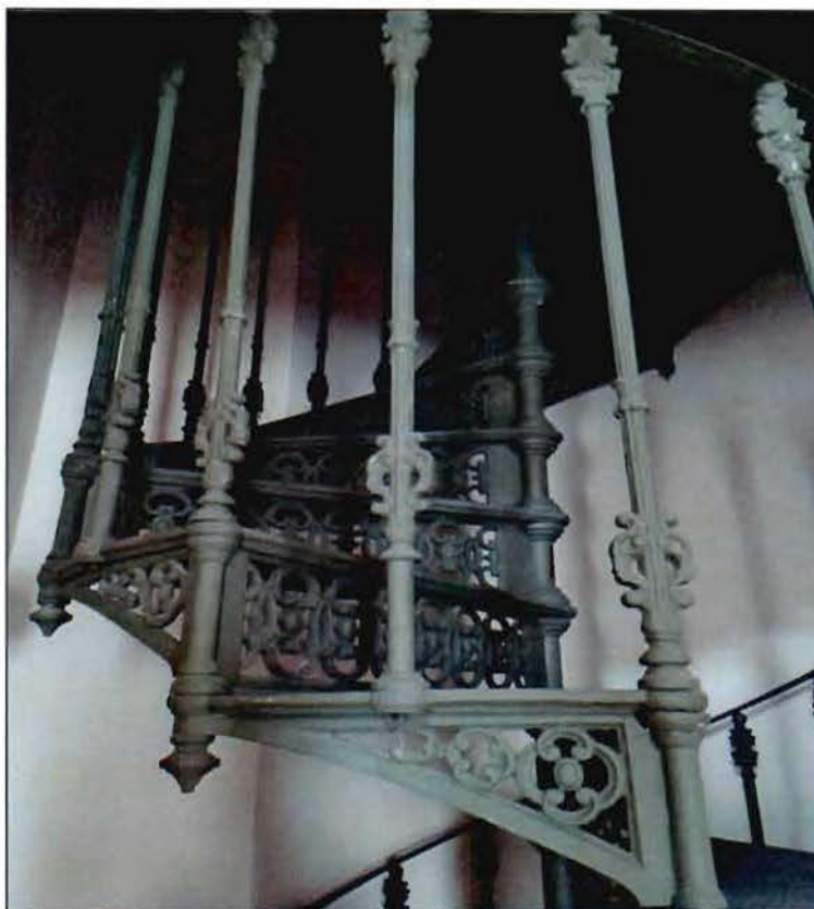
25. Чугунная, винтовая лестница.
