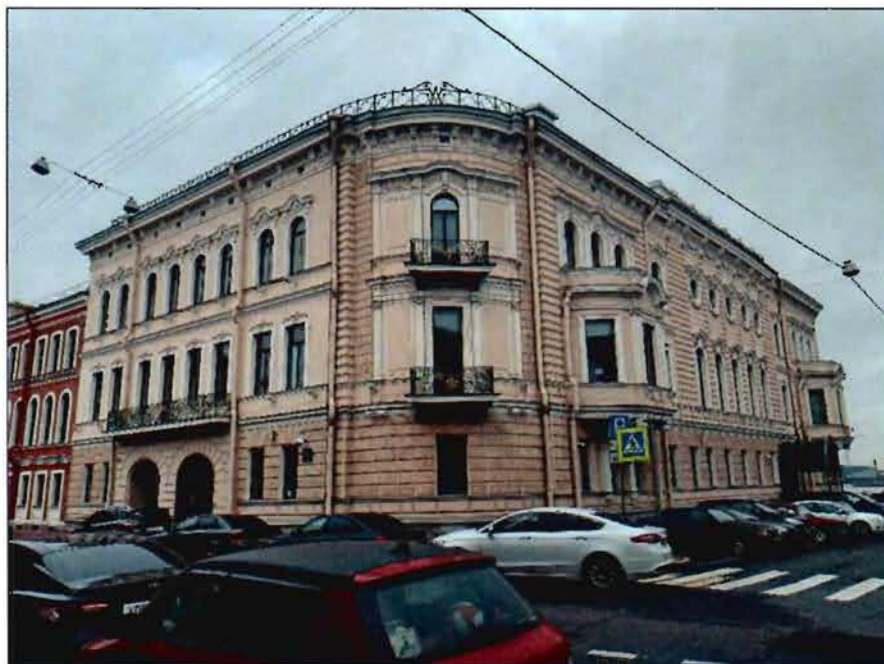
1. Общий вид на объект культурного наследия со стороны набережной Кутузова.
