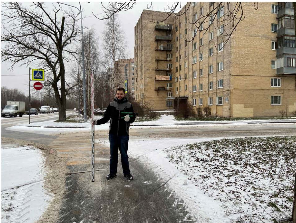
Рис. 41 Санкт-Петербург, Колпинский района. Пос. Металлострой. Ул. Садовая. Участок обследования. Точка съёмки №11. Вид на запад.
