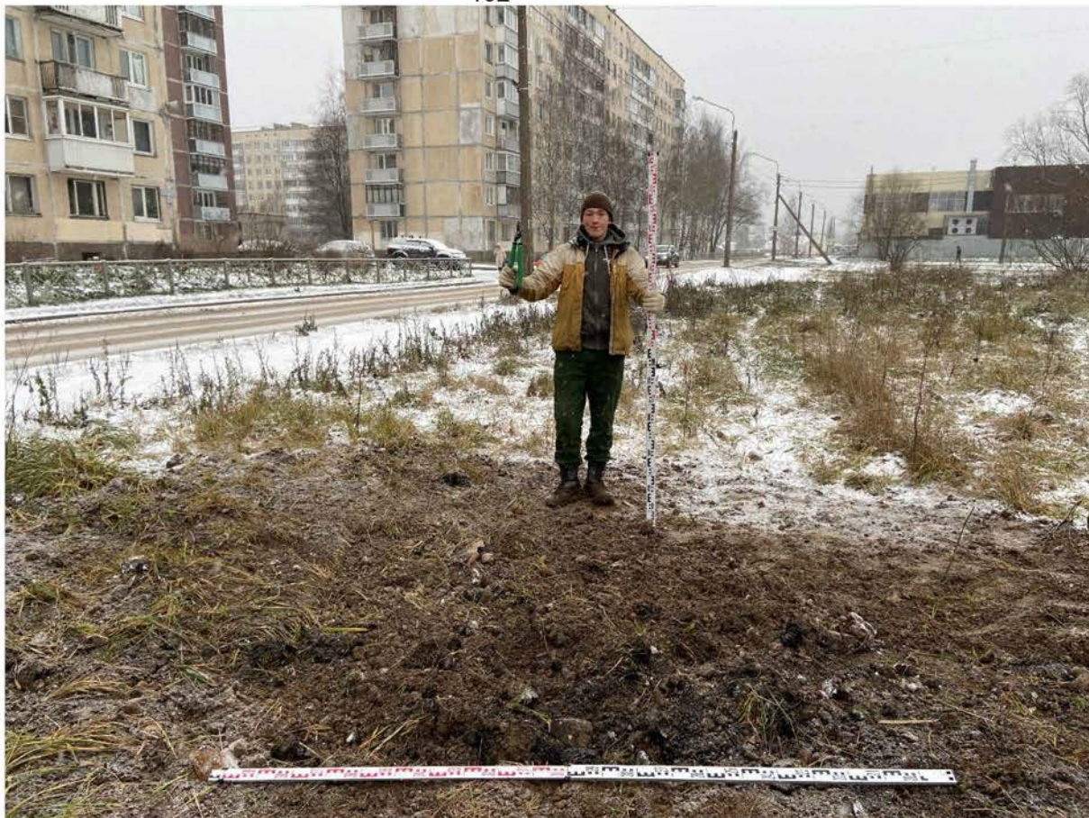
Рис. 53 Санкт-Петербург, Колпинский района. Пос. Металлострой. Ул. Садовая. Шурф №1. Вид после рекультивации. Вид на север.
