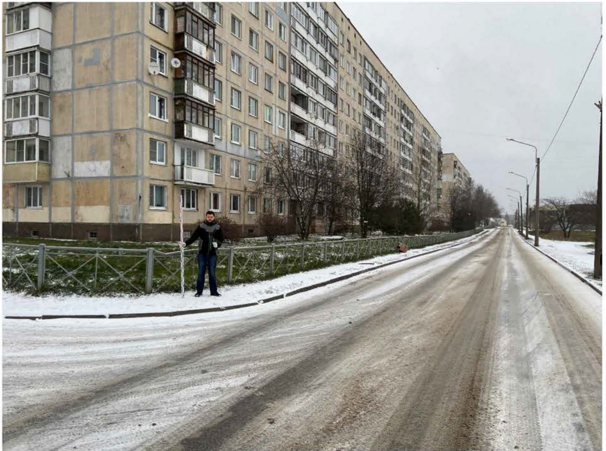
Рис. 27 Санкт-Петербург, Колпинский района. Пос. Металлострой. Ул. Садовая. Участок обследования. Точка съёмки №7. Вид на север.
