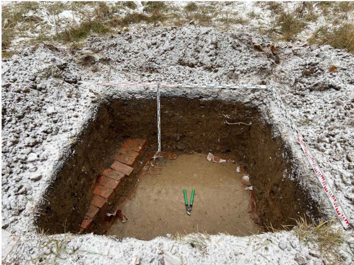
Рис. 49 Санкт-Петербург, Колпинский района. Пос. Металлострой. Ул. Садовая. Шурф №1. Общий шурфа на уровне прекращения работ. Вид на юг.
