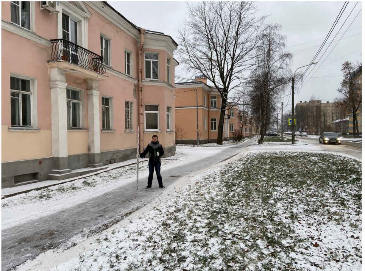
Рис. 35 Санкт-Петербург, Колпинский района. Пос. Металлострой. Ул. Садовая. Участок обследования. Точка съёмки №9. Вид на юг.
