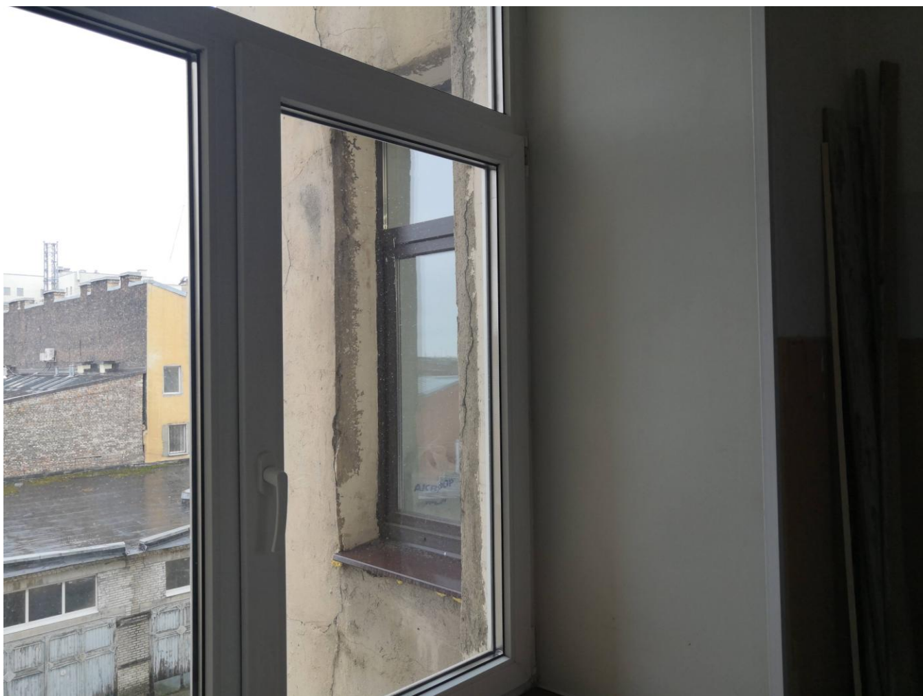
7. Вид из окна лестничной клетки на окно квартиры № 424.
