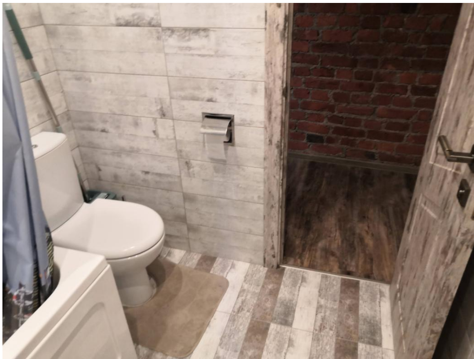
15. Совмещенный санузел в помещении № 3 по плану ПИБ.
