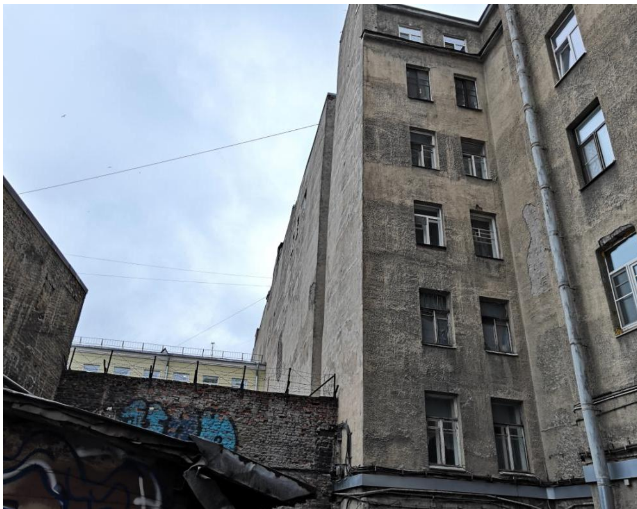
6. Брандмауэрная стена исследуемого флигеля.
