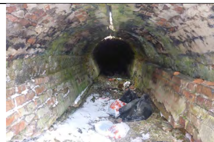
вид кирпичной галереи
