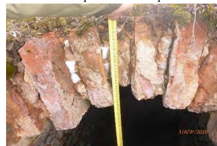
свод кирпичной галереи
