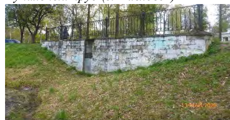
Водосливная плотина на пруду
