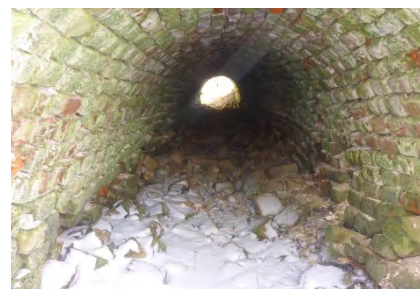
вид кирпичной галереи
