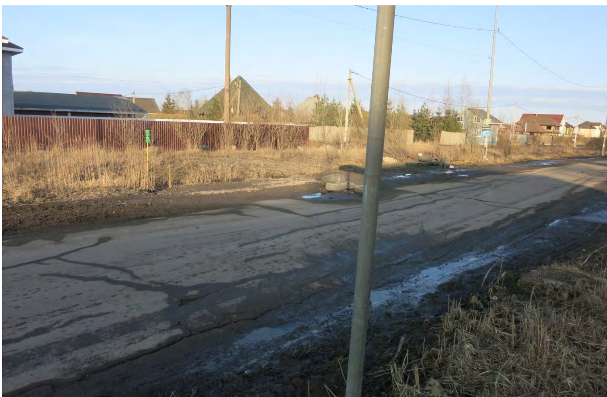
Фото 4. Вид на Рухколовское шоссе, водовод был устроен вдоль южной (правой) стороны дороги, с северной (левой) стороны расположено современное поселение Рухколово.
