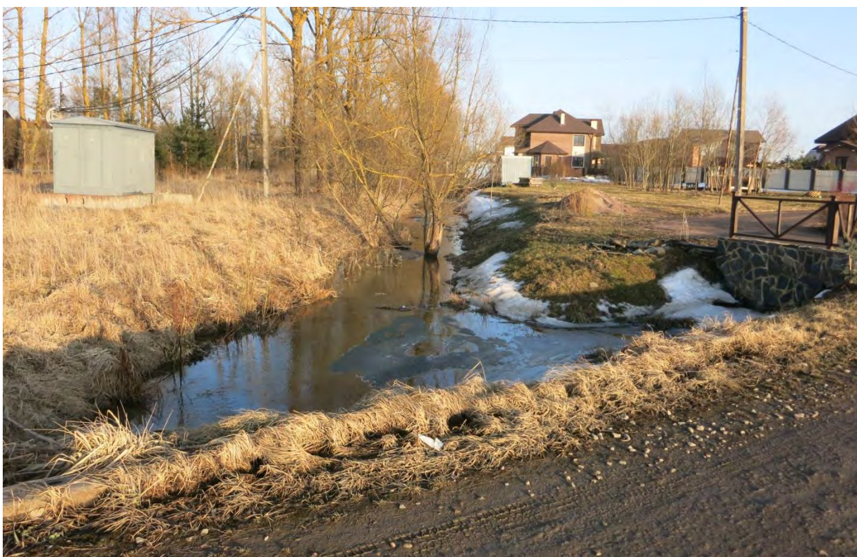
Фото 2. Вид на канал Виттоловского водовода с грунтовой дороги в восточном направлении в сторону территории дер. Александровки.
