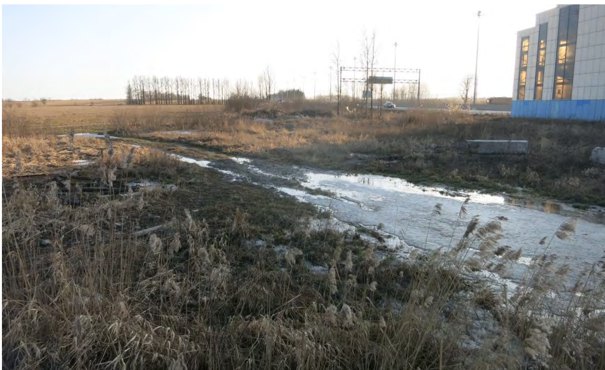
Фото 2. Вид на территорию Виттоловского водовода, канал на данном участке не сохранился, виден стихийный заезд на территорию поля.
