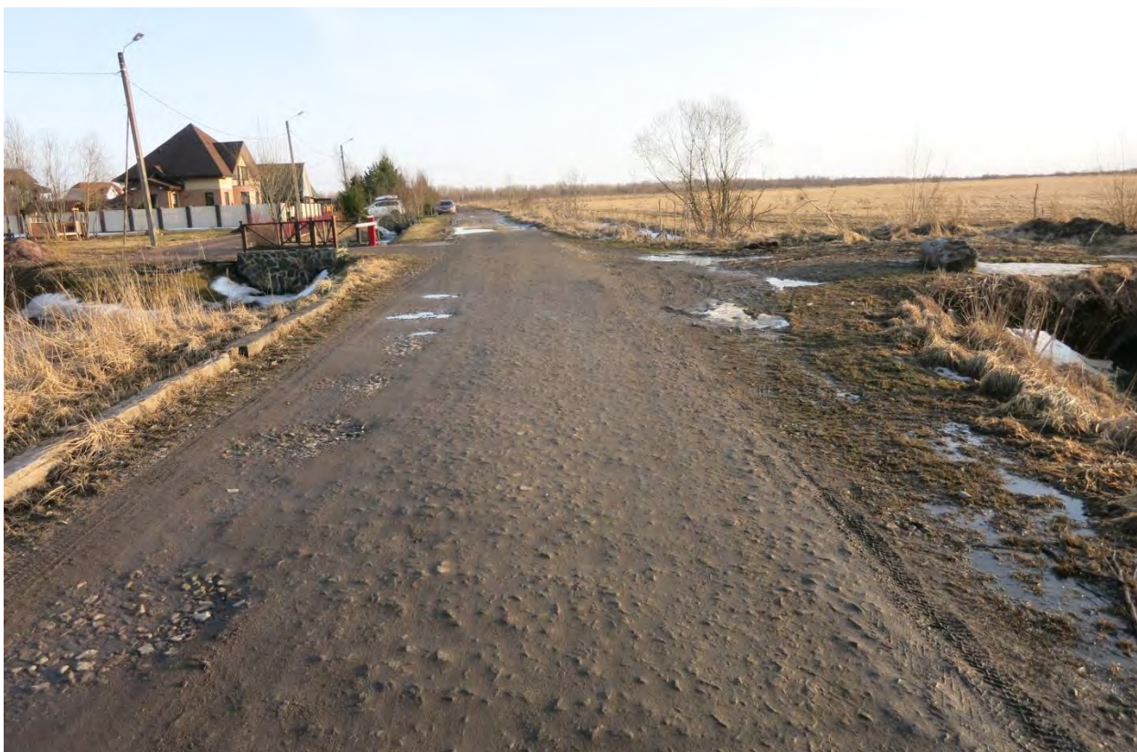
Фото 1. Вид на грунтовую дорогу - продолжение улицы 5 линия, проходящую по юго-западной границе дер. Александровка, в месте пересечения канала Виттоловского водовода устроен ж.б. трубопереезд.
