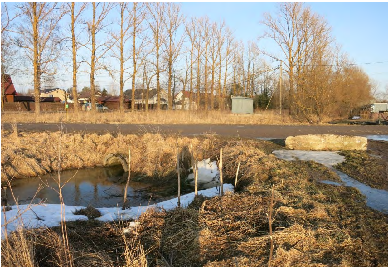
Фото 3. Вид на русло канала Виттоловского водовода и трубопереезд под грунтовой дорогой с западной стороны (со стороны поля).
