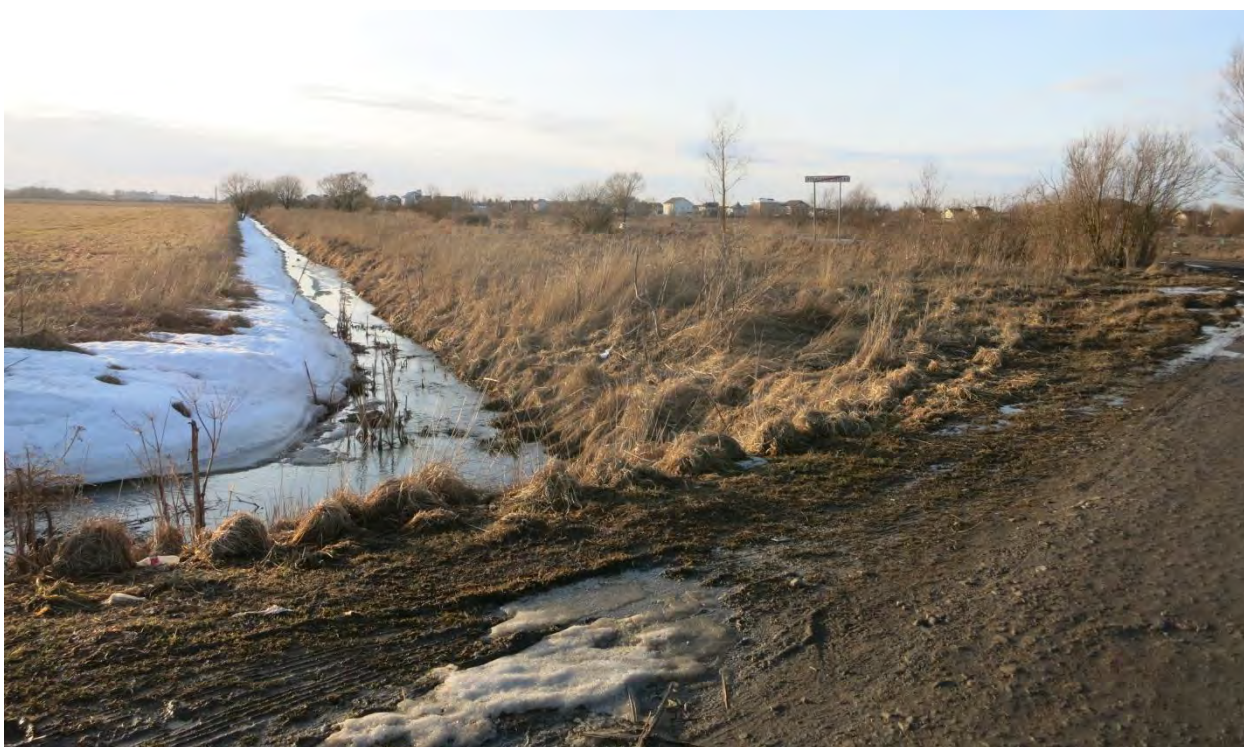
Фото 4. Вид с грунтовой дороги на Виттоловский водовод (в сторону Киевского шоссе), русло канала сохранилось, откосы одернованы.
