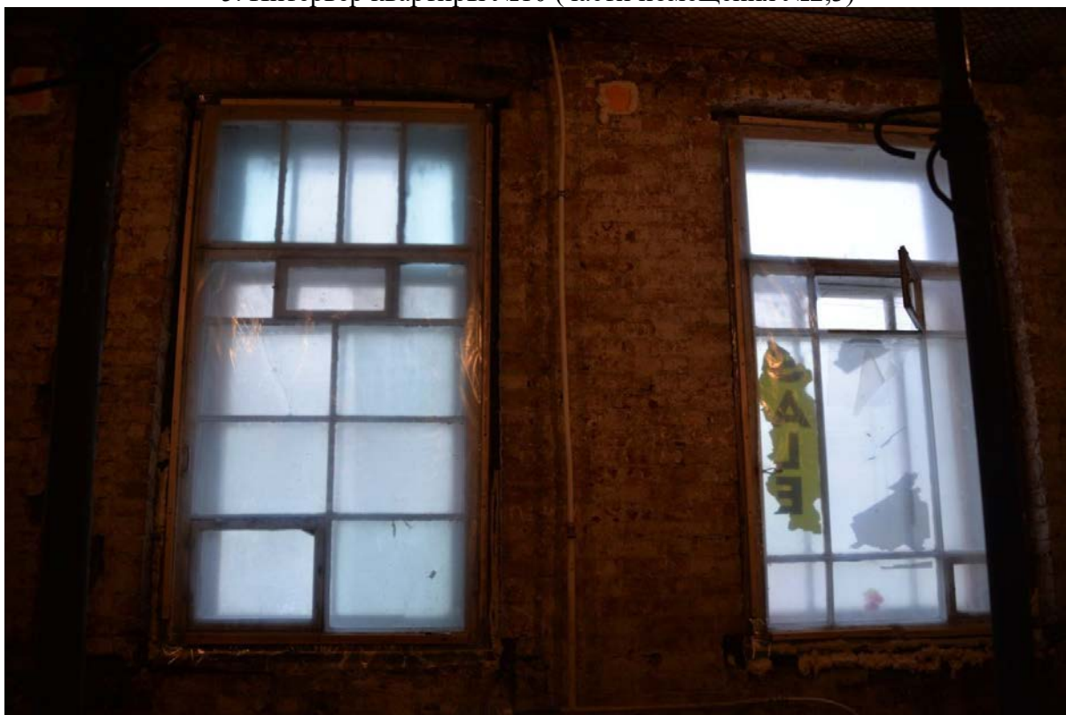
6. Оконные проемы в квартире №10 (части помещения 2, 3)
