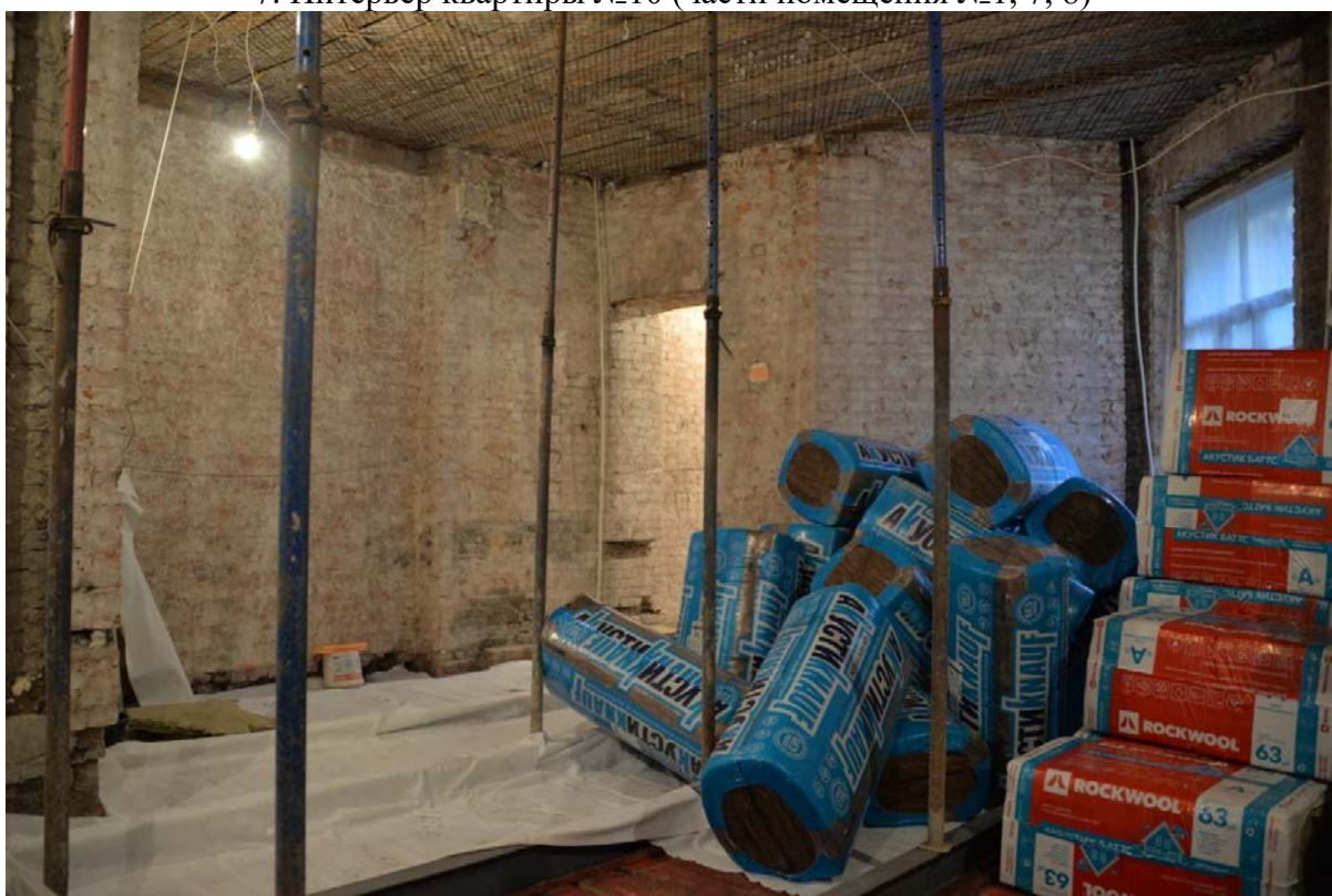
8. Интерьер квартиры №10 (части помещения №9, 11)
