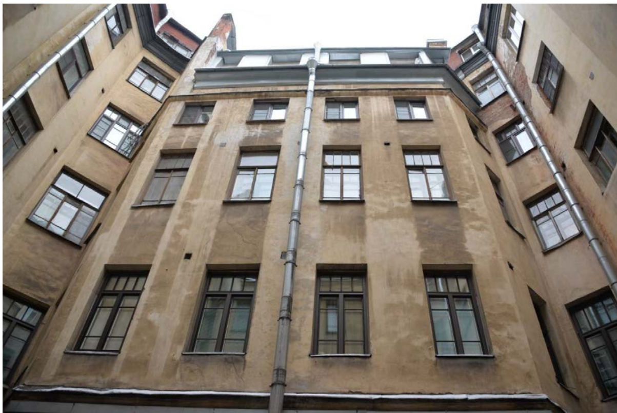
3. Фрагмент дворового фасада
