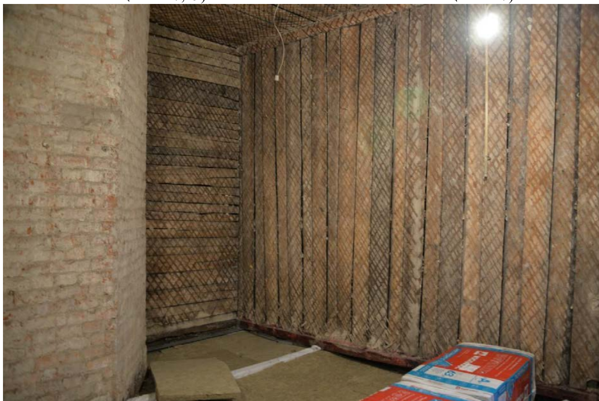
17. Интерьер квартиры №10 (части помещения №17)
