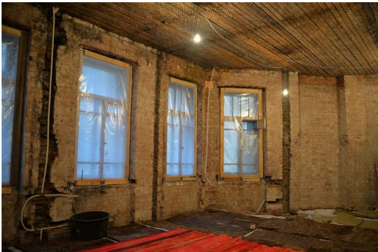
13. Интерьер квартиры №10 (части помещения №13, 14)
