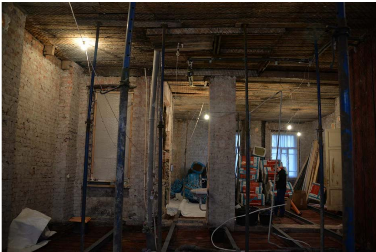
7. Интерьер квартиры №10 (части помещения №1, 7, 8)
