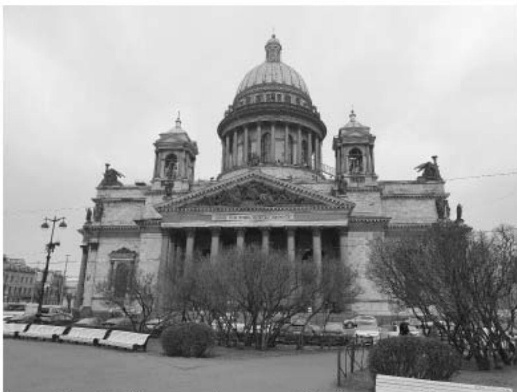
1. «Ансамбль Исаакиевской площади: Музей-памятник Исаакиевский собор», 1818-1858 гг., арх. А.А. Монферран, Исаакиевская площадь, дом 4, литера А. Юго-восточный фасад. Общий вид. Фото 31.01.2020 г.
