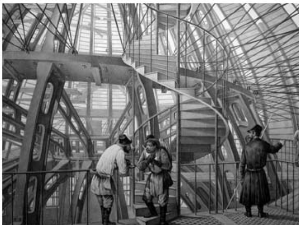
20. Металлические конструкции купола. Литография В. Адама по рисунку О. Монферрана. 1845г.
