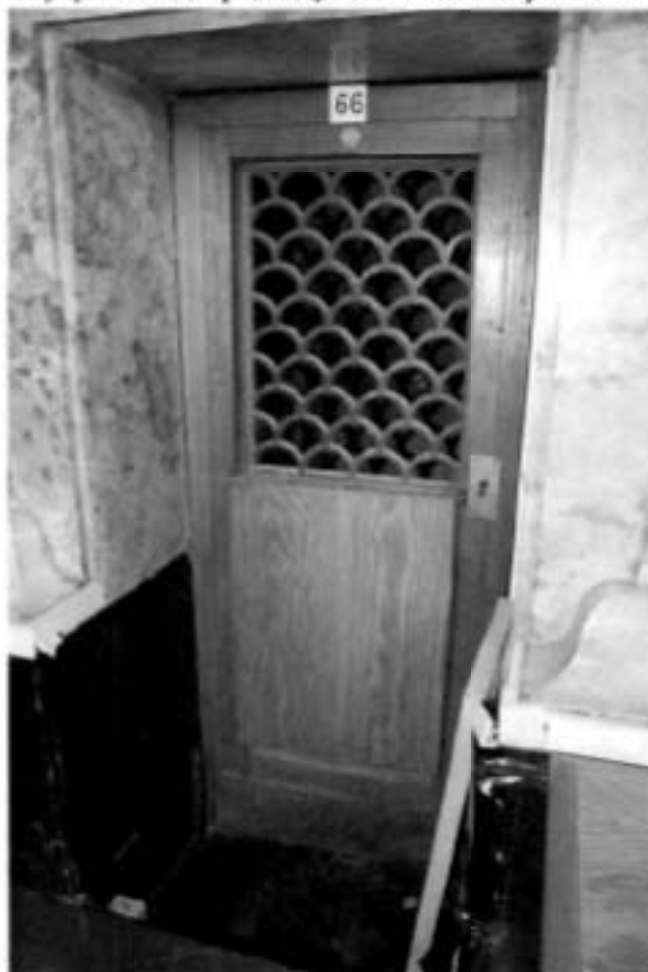
22. Внутренняя дверь, ведущая на винтовую лестницу
