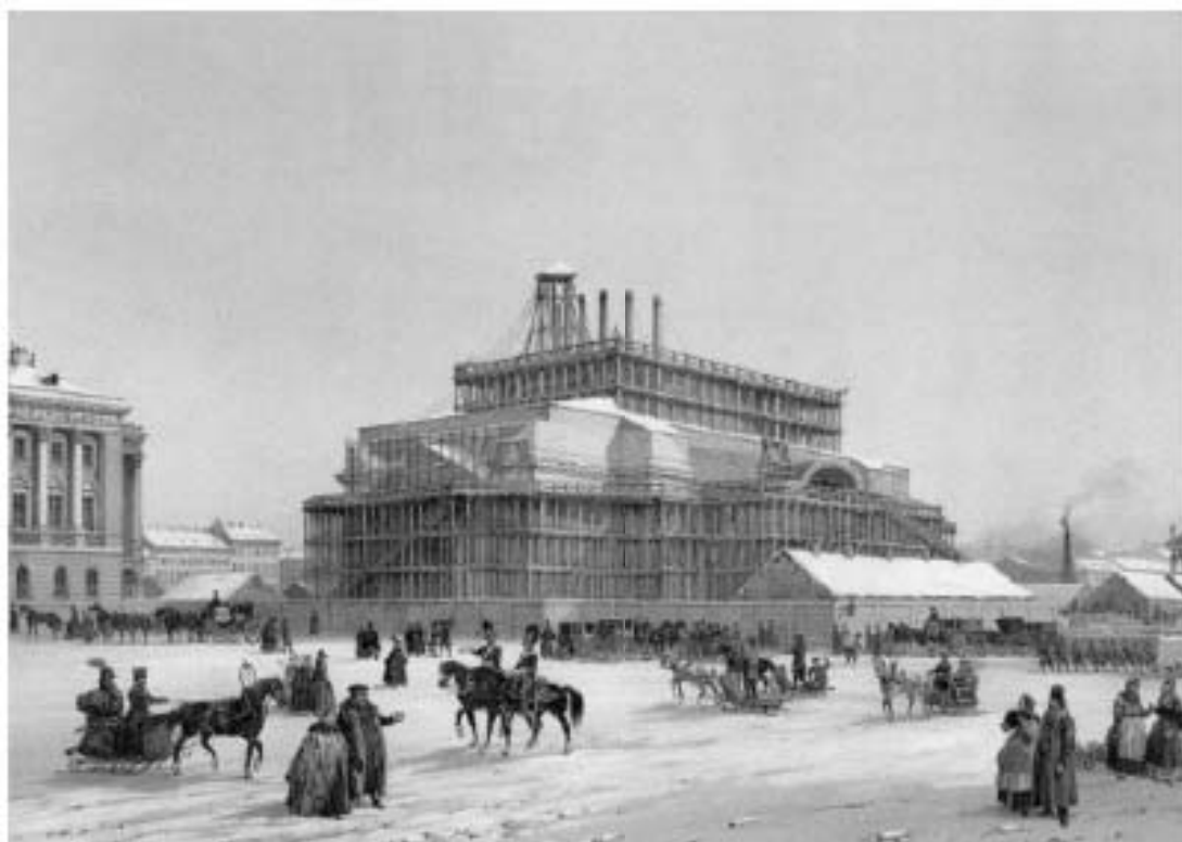
17. Вид строящегося Исаакиевского собора в 1838 г. Литография с тоном. Ф. Бенуа, по оригиналу О. Монферрана.
