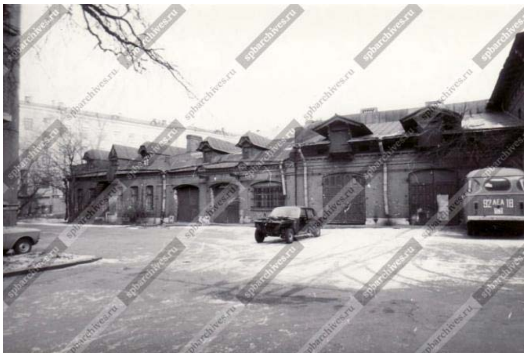
Илл. 5. Служебные гаражи во дворе дома 27 -А по проспекту Огородникова (бывшие конюшни особняка Э.А. Кириштина, архитектор А.Л.Гун, 1878 - 1879 гг.) Фото Овчинников К.В. 02.04.1989. // ЦГАКФФД СПб. Фотодокумент Ар 217803
