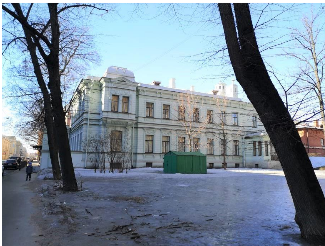
Фото 3. Вид с Рижского пр. на сад без названия (ЗНОП 1004), ОКН регионального значения «Особняк Киштена Э.А. со служебным флигелем, с металлической оградой, воротами и палисадником»
