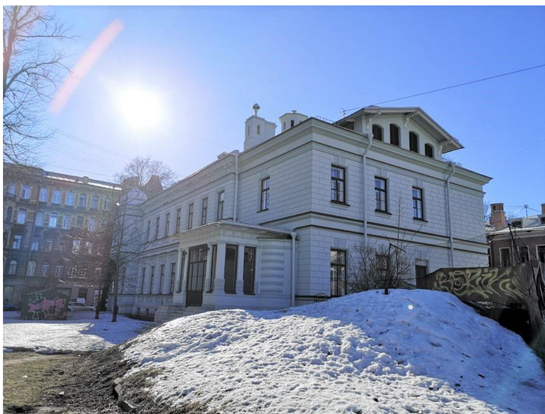
Фото 6. Вид на ОКН регионального значения «Особняк Кириштеня Э.А. со служебным флигелем, с металлической оградой, воротами и палисадником» и ледник расположенный в границах территории ОКН регионального значения «Особняк Кириштеня Э.А. со служебным флигелем, с металлической оградой, воротами и палисадником» с территории сада
