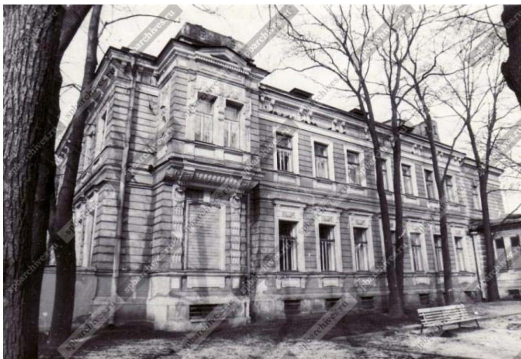
Илл. 4. Вид фасада дома № 27 на проспекте Огородникова со стороны палисадника (бывший особняк Э.А. Кириштина, архитектор А.Л. Гун, 1878 - 1879 гг.). Фото Овчинников К.В. 02.04.1989. // ЦГАКФФД СПб. Фотодокумент Ар 217801
