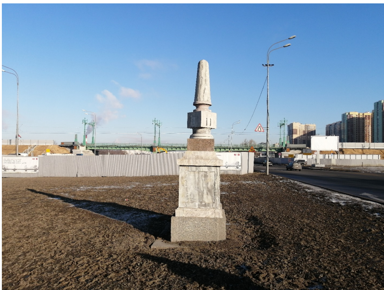
4. Вид на южный фасад столба «13/11» объекта культурного наследия федерального значения «Столбы верстовые (шесть)», расположенного по адресу: г. Санкт-Петербург, Пулковское шоссе, и зону производства работ. 24.03.2022
