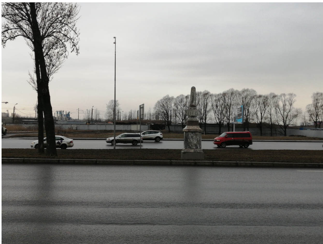
5. Вид на западный фасад столба «13/11» объекта культурного наследия федерального значения «Столбы верстовые (шесть)», расположенного по адресу: г. Санкт-Петербург, Пулковское шоссе, и зону производства работ. 24.03.2022
