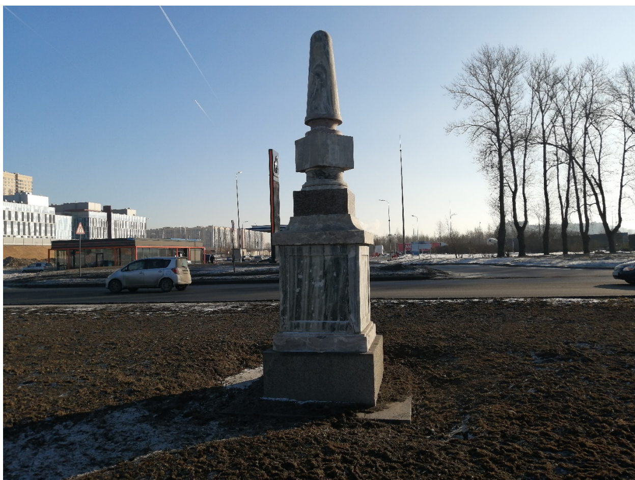
3. Вид на западный фасад столба «13/11» объекта культурного наследия федерального значения «Столбы верстовые (шесть)», расположенного по адресу: г. Санкт-Петербург, Пулковское шоссе, и зону производства работ. 24.03.2022
