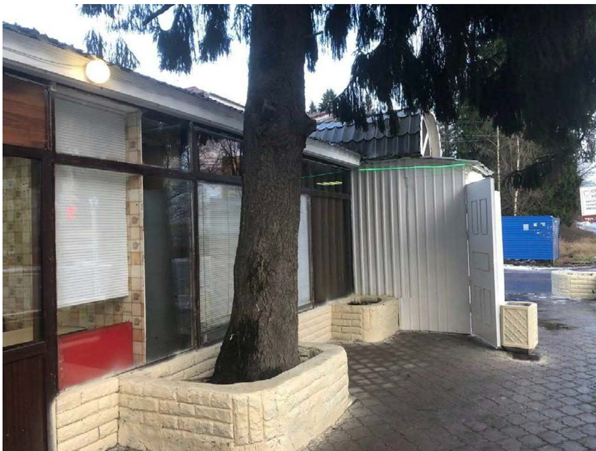
Фото 5. СПб, Осиновая Роща, Приозерское шоссе, дом 15, корп. 6. Фрагмент лицевого фасада. Вход
