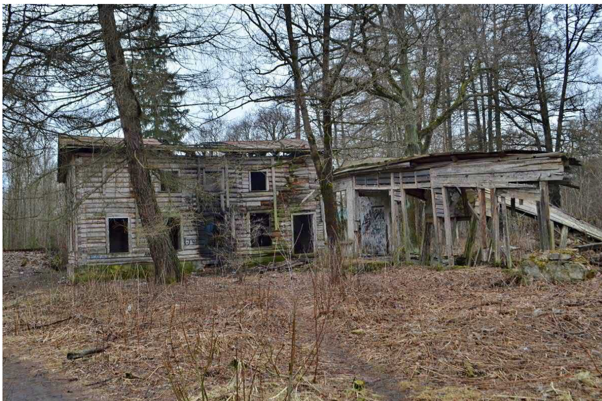
22. Современное состояние Усадьбы Вяземских (после пожара)
