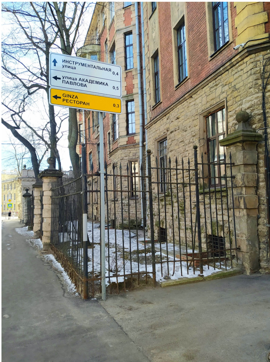
Общий вид со стороны Аптекарского пр. Муфтированная колонна разобрана, установлена временная металлическая стойка в виде трубы. Дата съёмки 09.04.2022.
