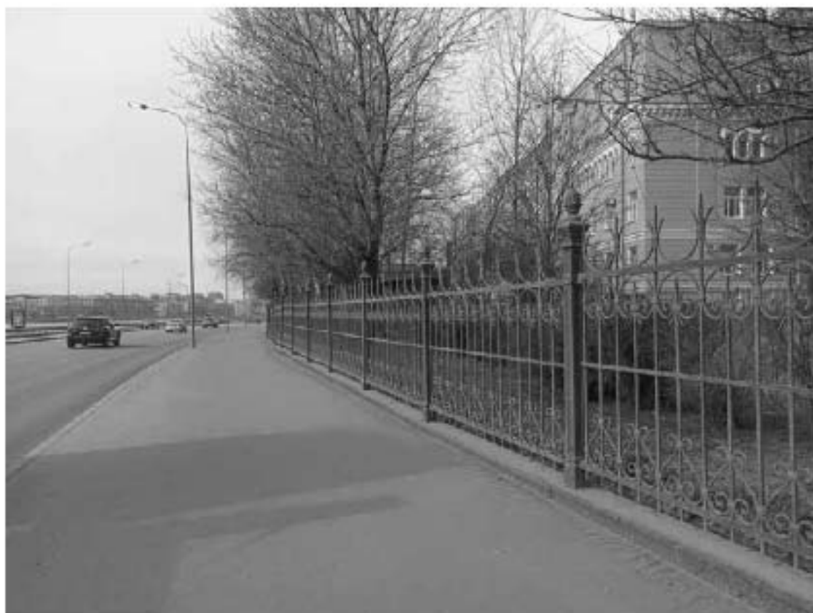
Фото №100. Общий вид ограды с Арсенальной наб.
