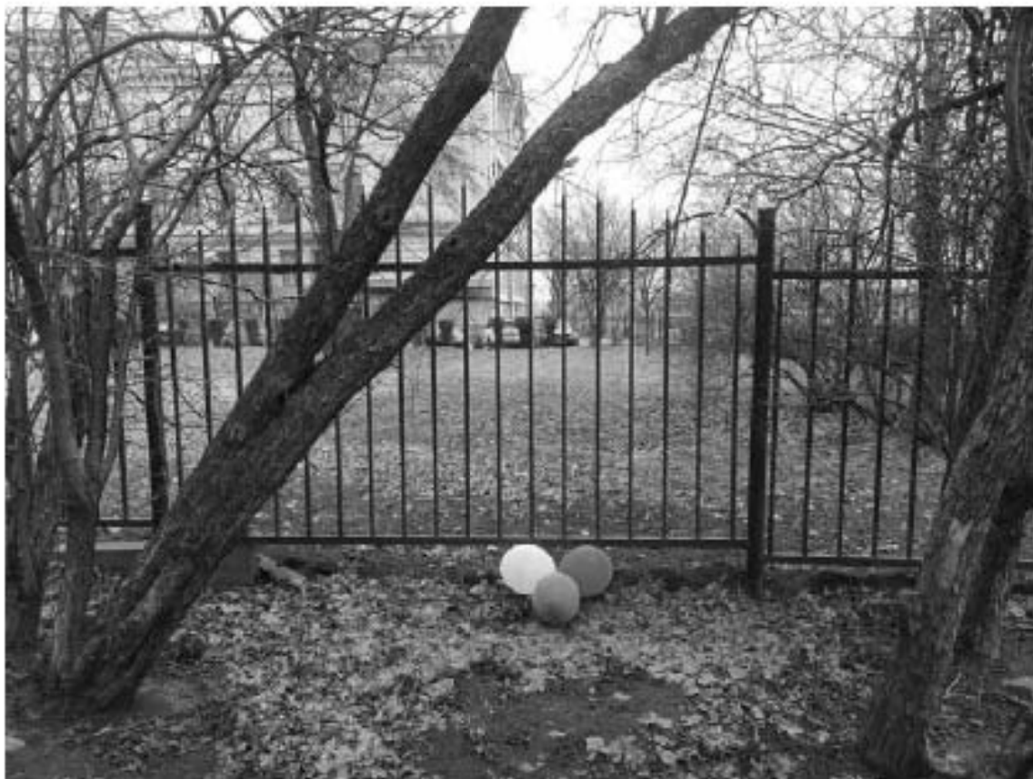
Фото №40. Вид на решетку ограждения со стороны проезда у детской больницы
