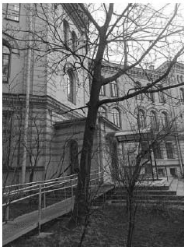
Фото №67. Общий вид на крыльцо здания с пешеходной дорожки
