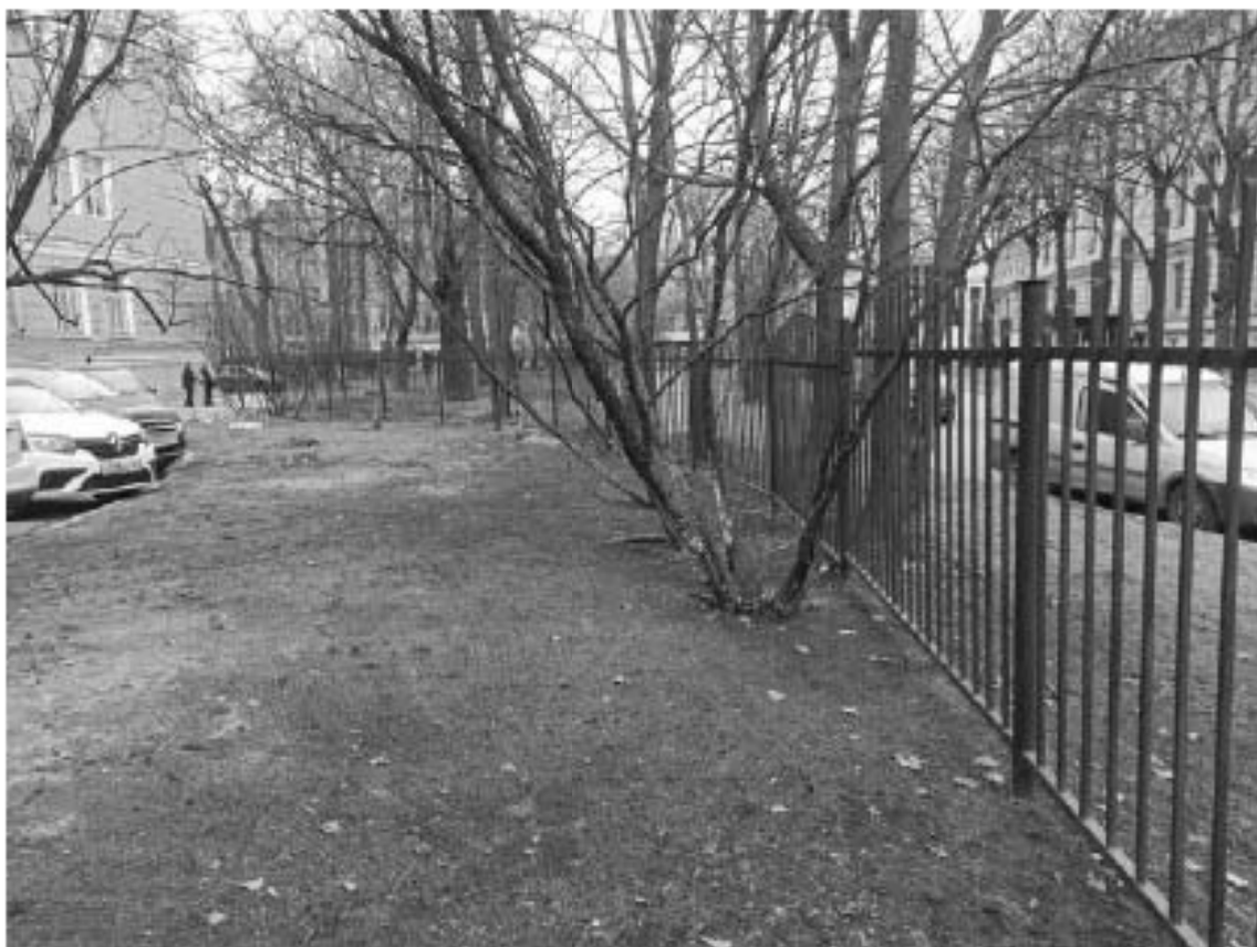
Фото №35. Общий вид ограждения со стороны проезда у детской больницы
