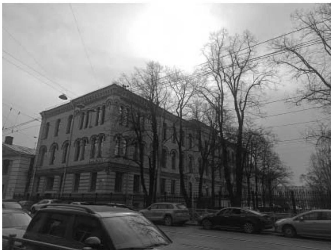
Фото №4. Общий вид на здание и ограду с ул. Комсомола
