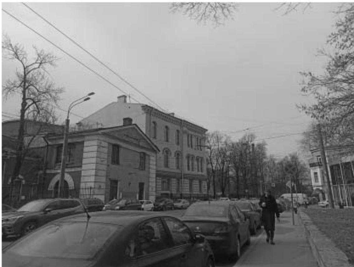
Фото №2. Общий вид на здание с ул. Комсомола
