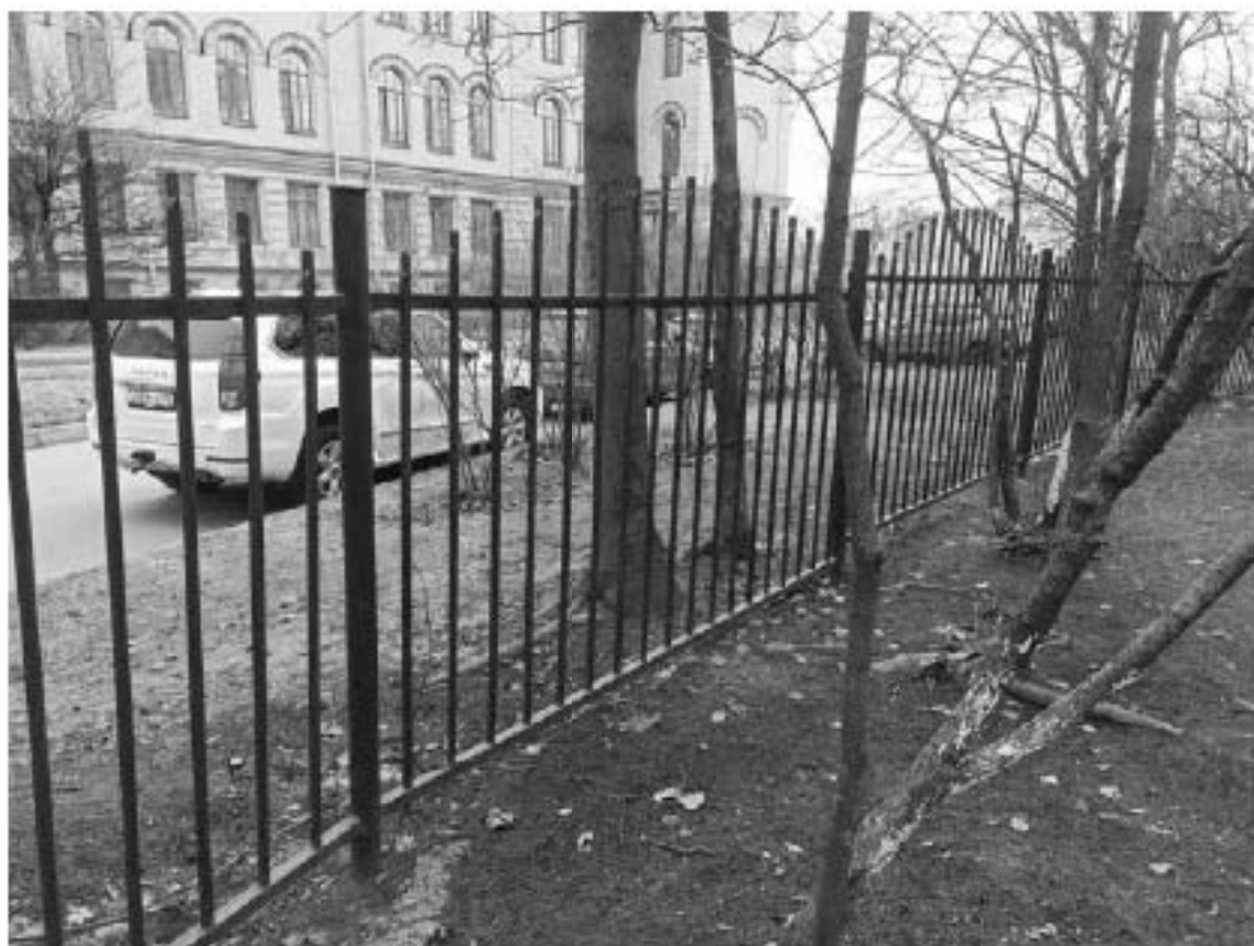
Фото №34. Вид ограждения со стороны проезда у детской больницы
