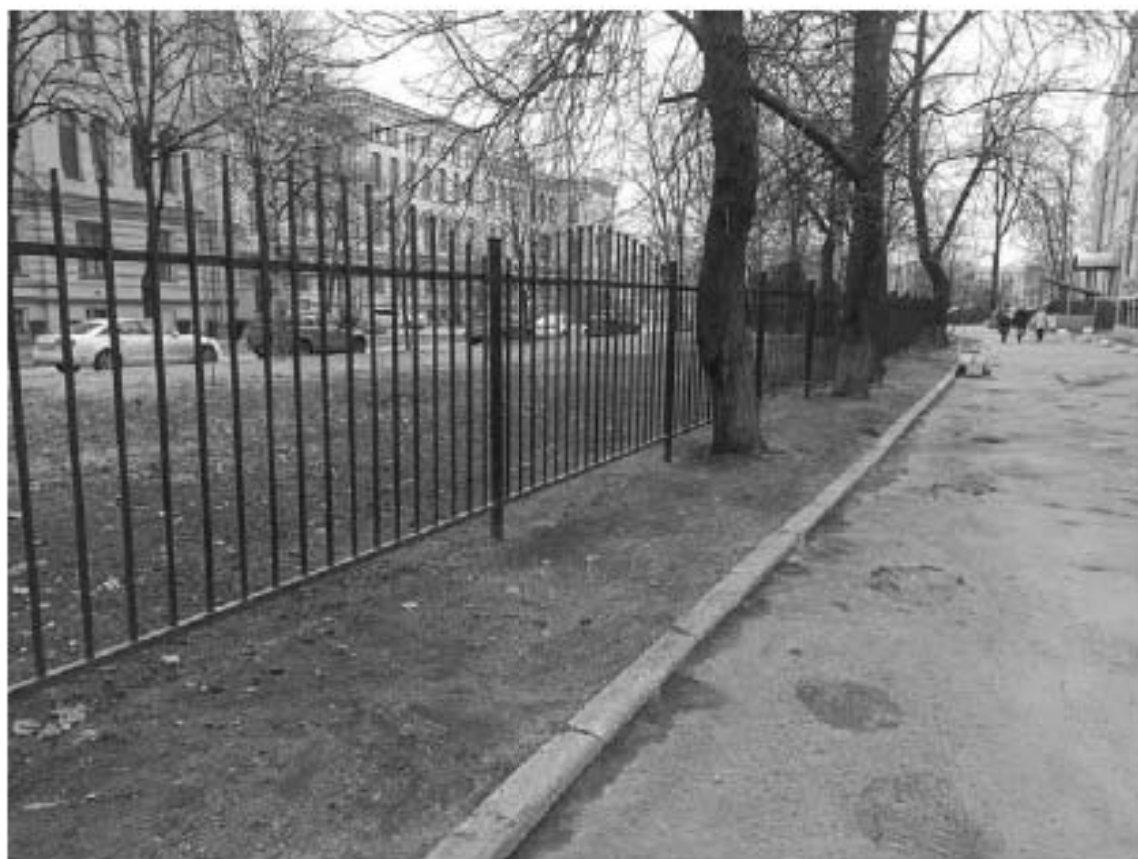
Фото №26. Общий вид ограждения со стороны проезда у детской больницы
