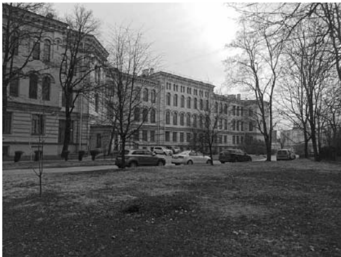
Фото №155. Общий вид на территорию и здание
