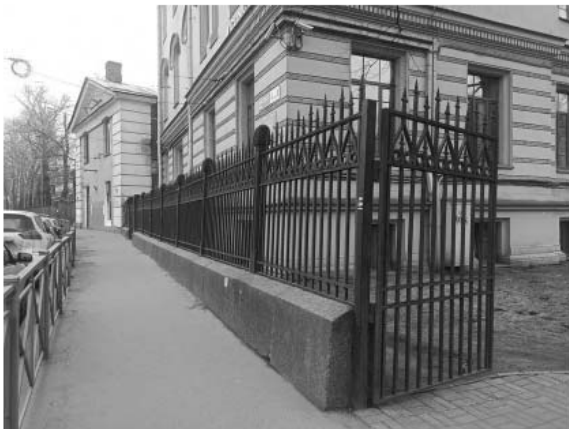
Фото №15. Общий вид ограды от входа с ул. Комсомола
