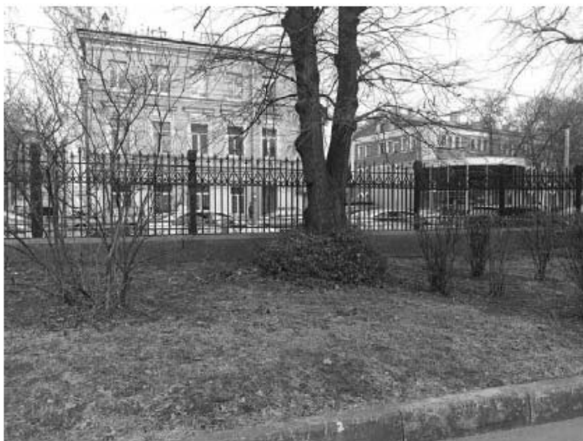
Фото №142. Вид на ограду с внутреннего проезда
