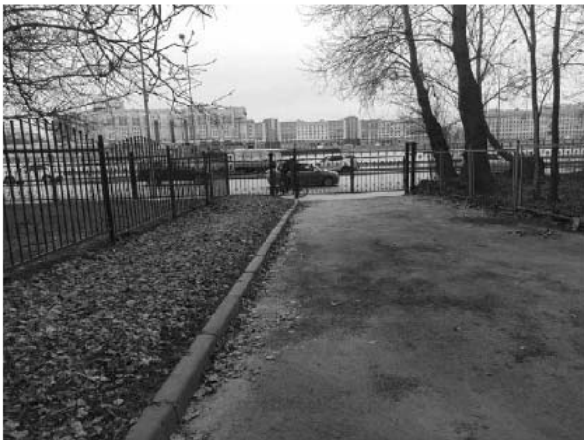
Фото №39. Общий вид ограждения с показом ворот на Арсенальной наб.
