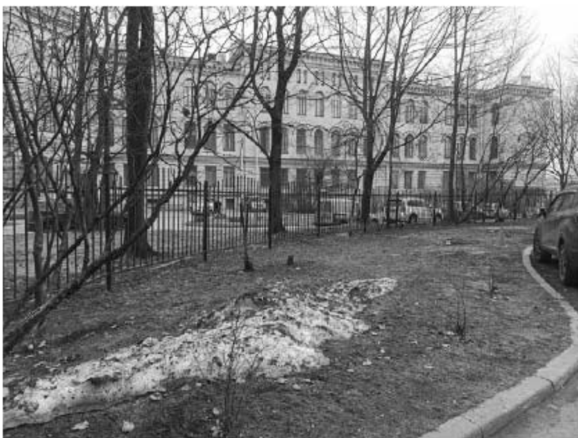
Фото №30. Общий вид ограждения со стороны проезда у детской больницы
