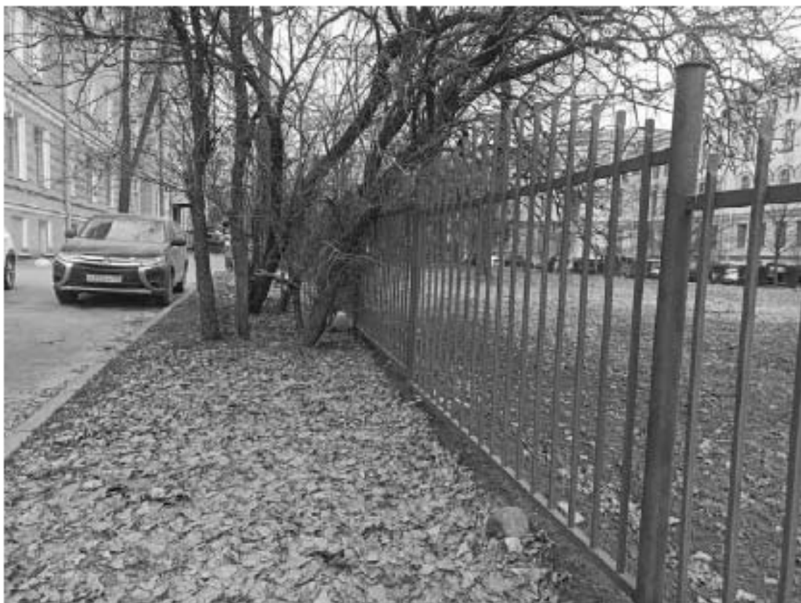
Фото №41. Общий вид ограждения со стороны проезда у детской больницы
