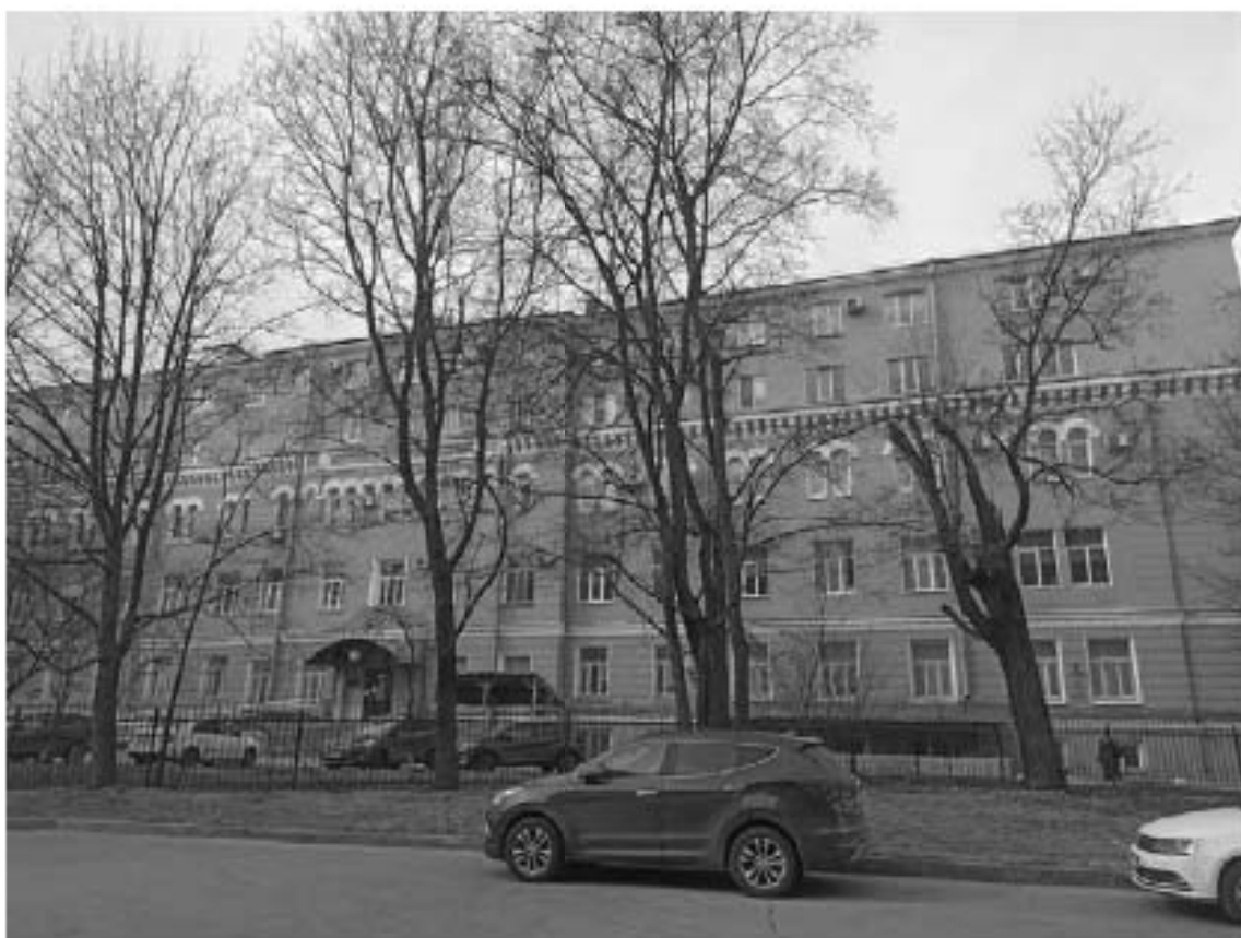
Фото №70. Общий вид на ограду с внутреннего проезда
