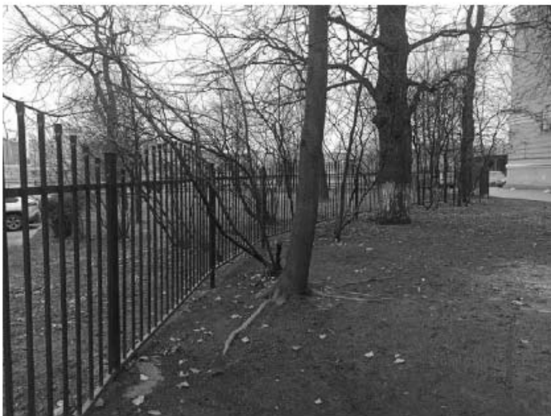
Фото №36. Общий вид ограждения со стороны проезда у детской больницы
