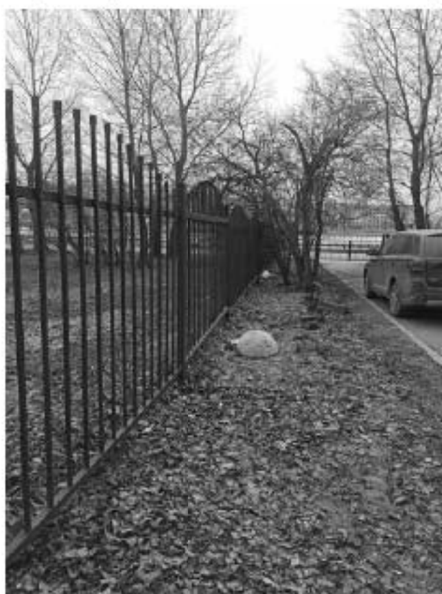
Фото №38. Общий вид ограждения со стороны проезда у детской больницы
