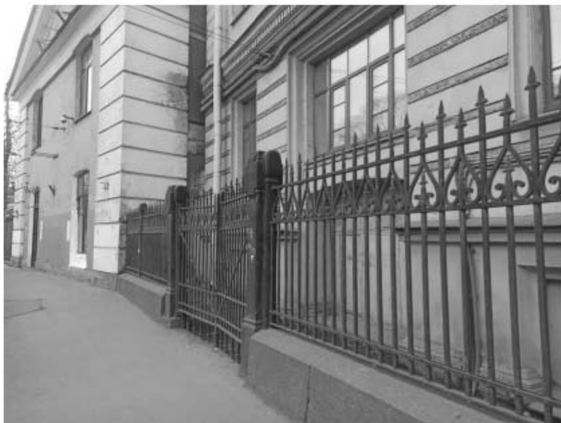
Фото №8. Вид на ограду с воротами с ул. Комсомола
