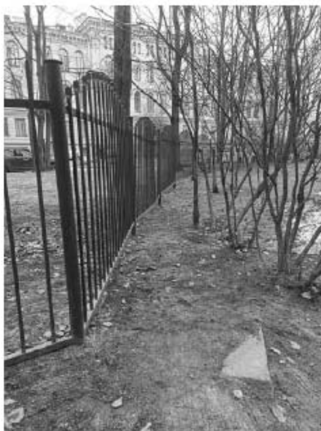
Фото №31. Общий вид ограждения со стороны проезда у детской больницы
