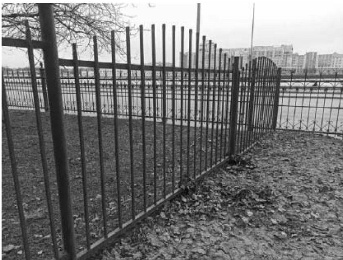
Фото №42. Вид ограждения со стороны проезда у детской больницы
