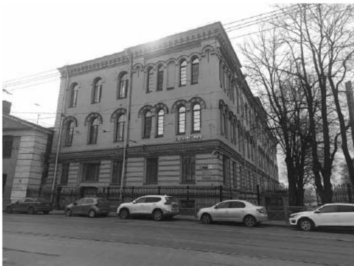
Фото №3. Общий вид на здание и ограду с ул. Комсомола
