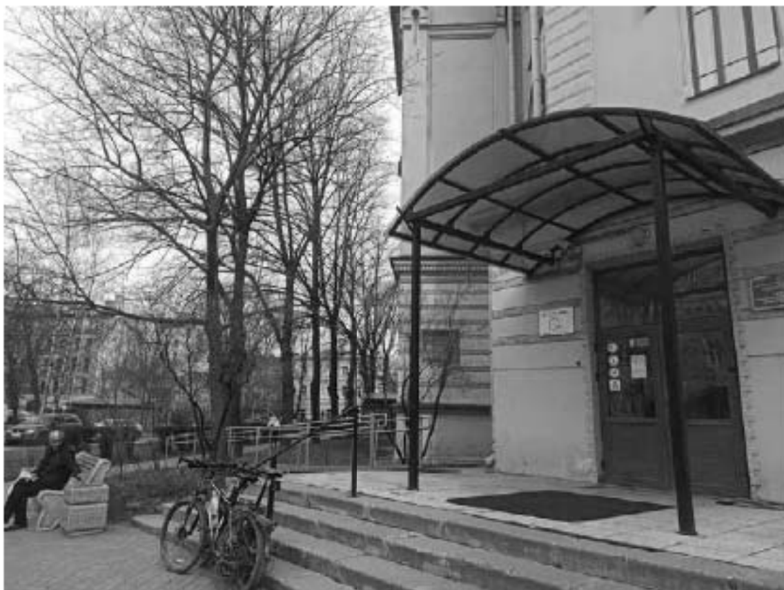
Фото №71. Вид на крыльцо
