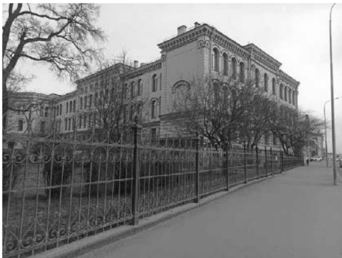
Фото №103. Общий вид ограды с Арсенальной наб.
