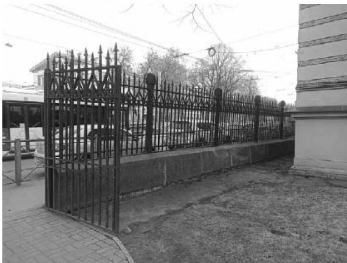
Фото №54. Общий вид решетки на ул. Комсомола со стороны входа на территорию
