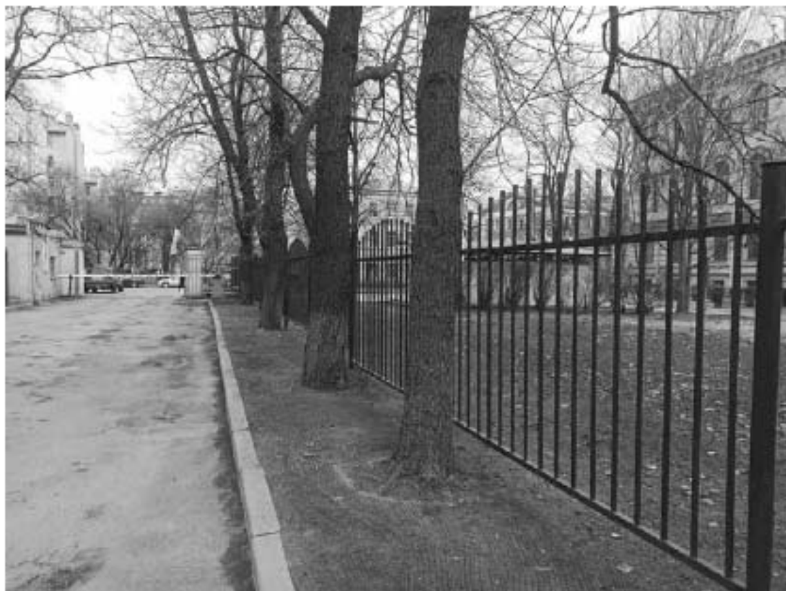
Фото №27. Общий вид ограждения со стороны проезда у детской больницы
