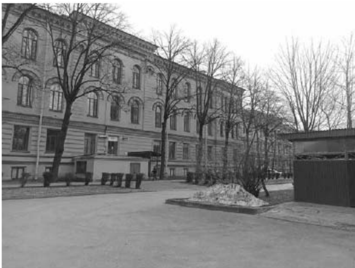
Фото №140. Вид на территорию и здание с внутреннего проезда
