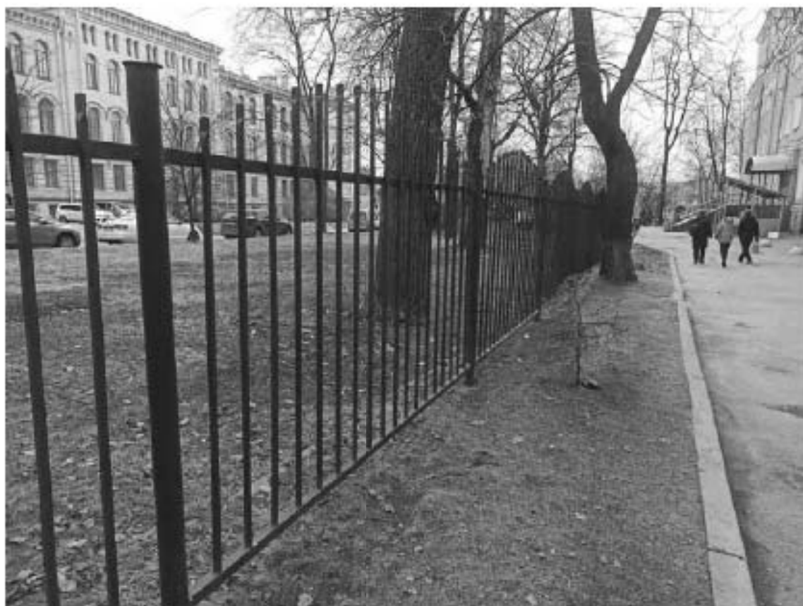
Фото №28. Общий вид ограждения со стороны проезда у детской больницы
