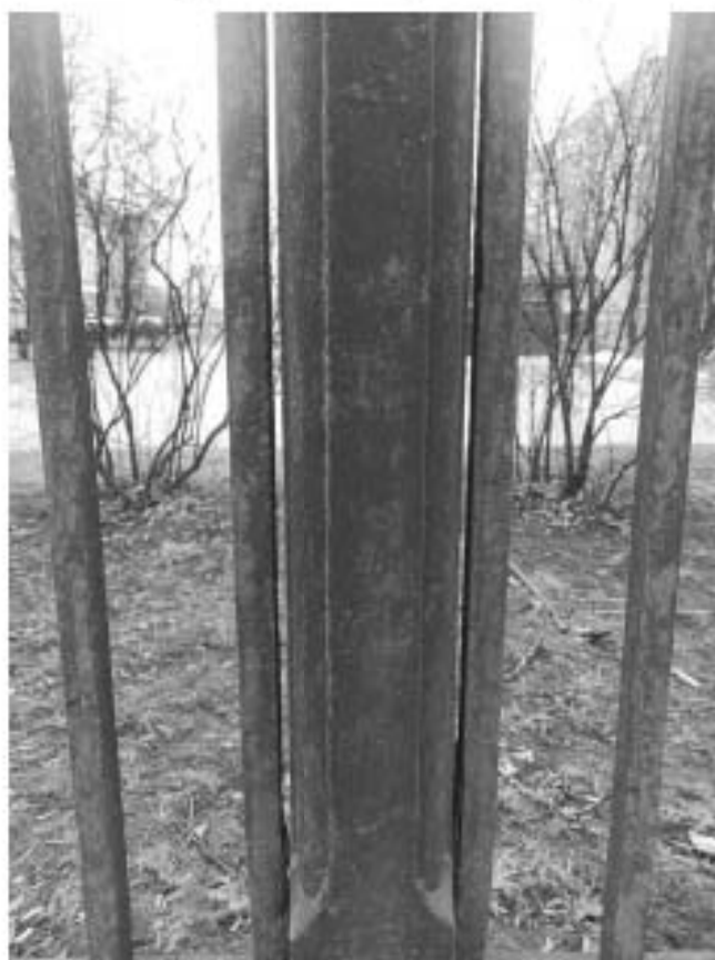
Фото №18. Фрагмент вида ограждения с ул. Комсомола
