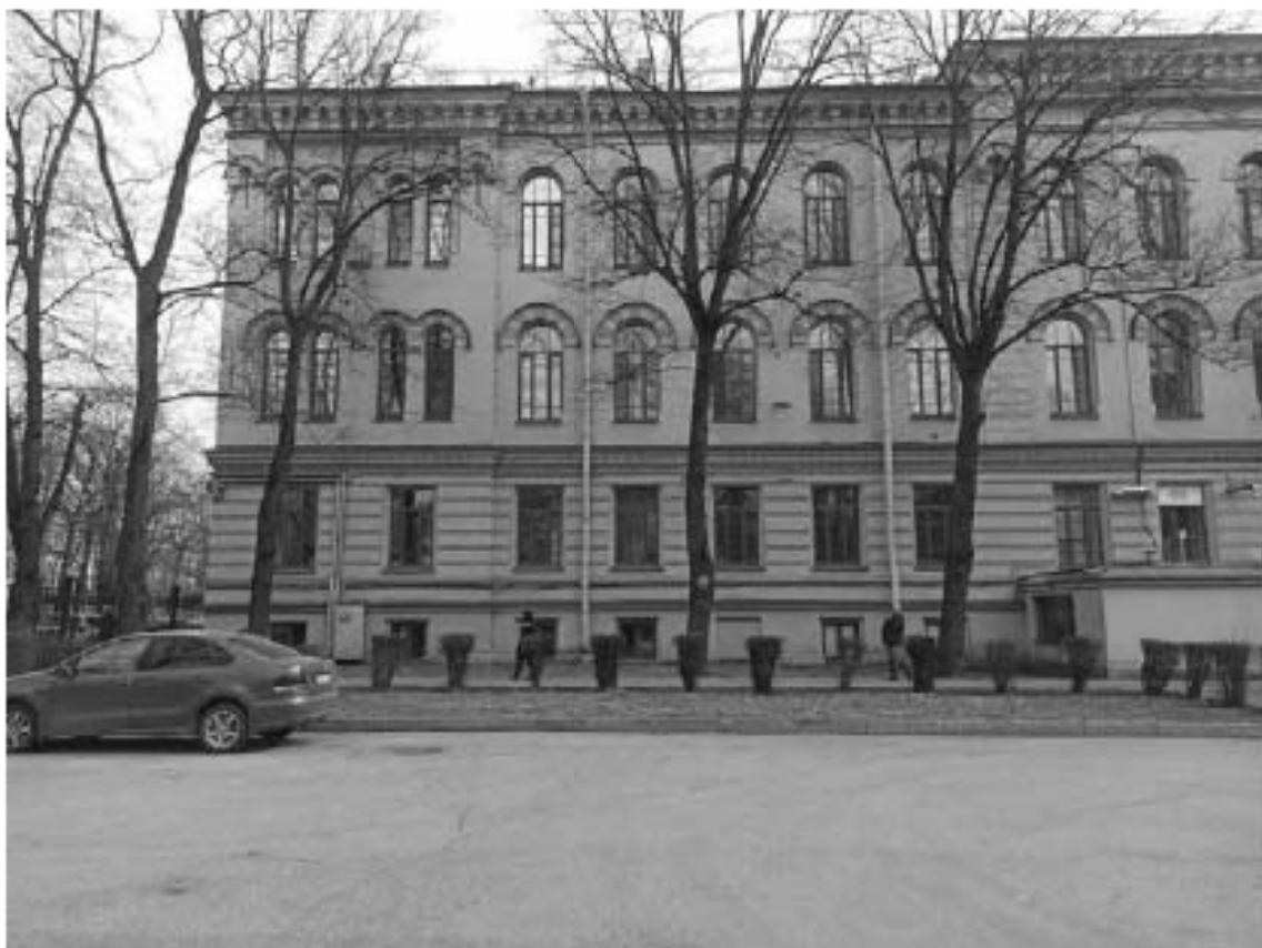
Фото №139. Вид на территорию и здание с внутреннего проезда
