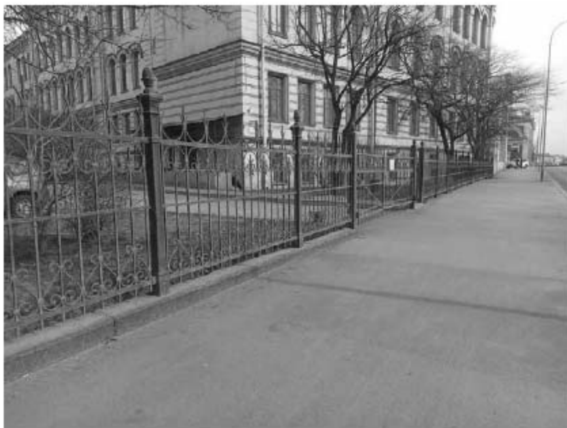
Фото №104. Общий вид ограды с Арсенальной наб.
