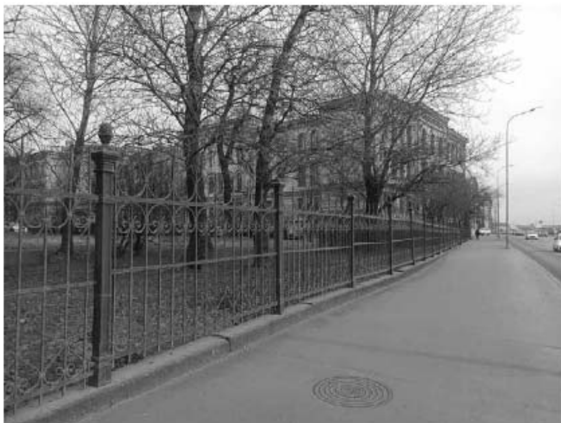
Фото №102. Общий вид ограды с Арсенальной наб.
