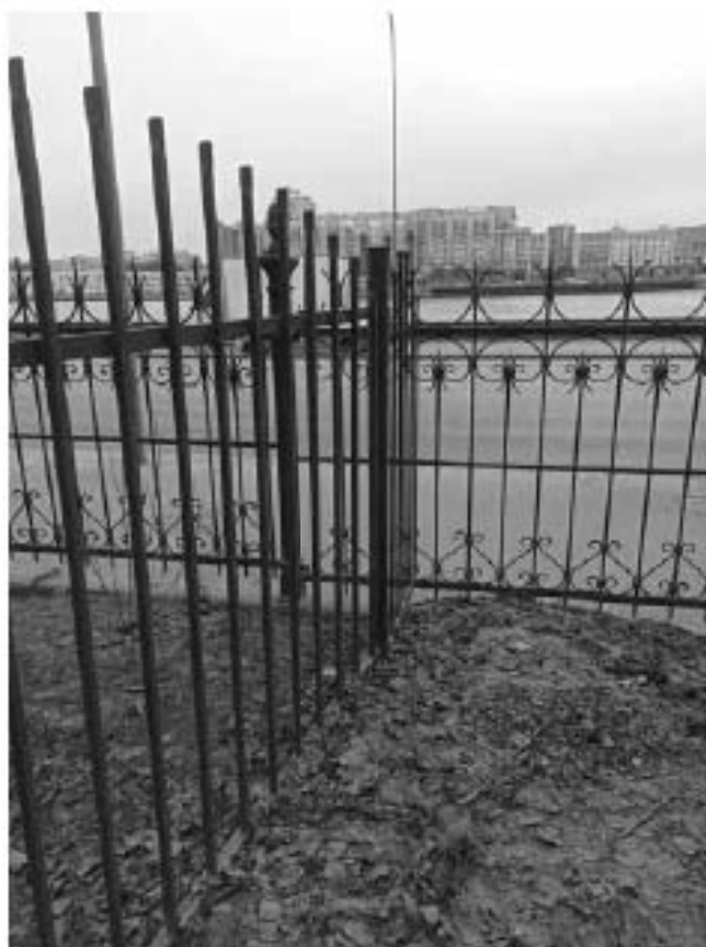
Фото №43. Вид ограждения со стороны проезда у детской больницы
