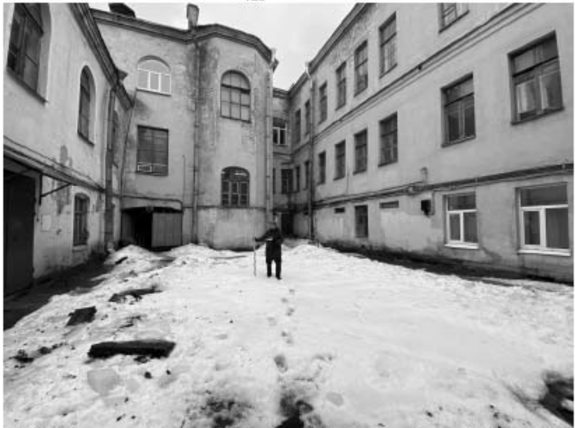
Рис. 18. СПб, 3-я линия В.О., дом 30-32, литера А (кадастровый номер: 78:06:0002021:16). Photo 1. Общий вид территории обследования. Вид с запада
