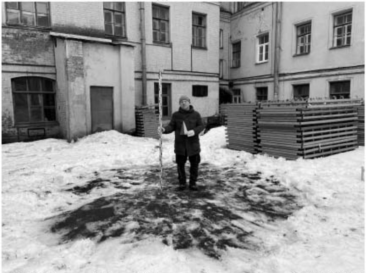
Рис. 52. СПб, 3-я линия В.О., дом 30-32, литера А (кадастровый номер: 78:06:0002021:16). Место заложения Шурфа 2. Вид с юга
