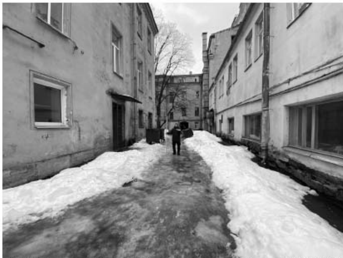
Рис. 27. СПб, 3-я линия В.О., дом 30-32, литера А (кадастровый номер: 78:06:0002021:16). Photo 10. Общий вид территории обследования. Вид с ЮЗ
