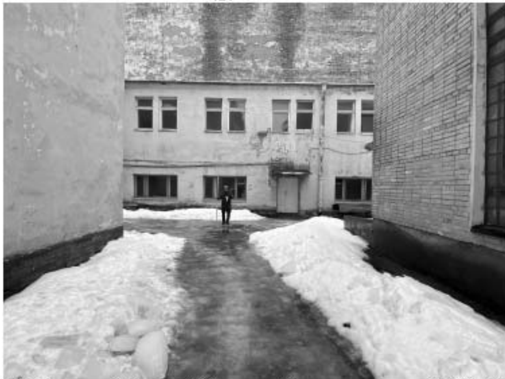
Рис. 26. СПб, 3-я линия В.О., дом 30-32, литера А (кадастровый номер: 78:06:0002021:16). Photo 9. Общий вид территории обследования. Вид с ССЗ
