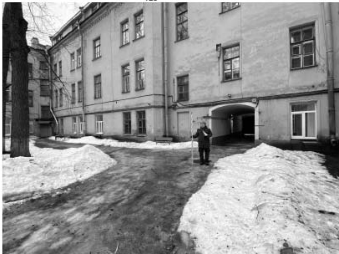
Рис. 30. СПб, 3-я линия В.О., дом 30-32, литера А (кадастровый номер: 78:06:0002021:16). Photo 13. Общий вид территории обследования. Вид с ЮЗ
