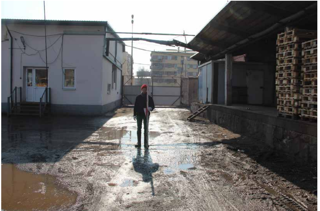
Рис. 16. Санкт-Петербург, Адмиралтейский район, Обводный канал. Точка съемки 5. Общий вид участка обследования. Вид на Ю.
