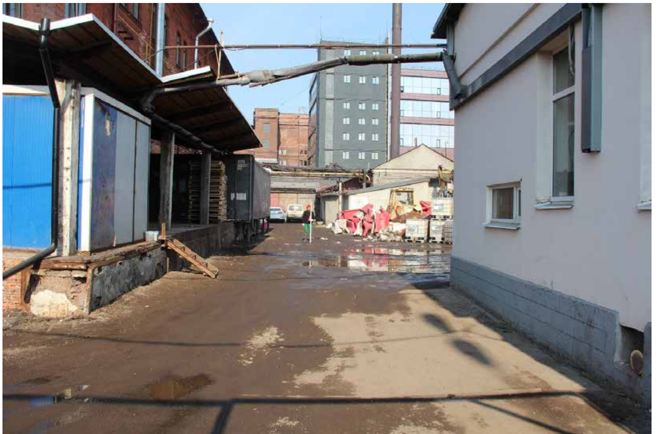
Рис. 17. Санкт-Петербург, Адмиралтейский район, Обводный канал. Точка съемки 5. Общий вид участка обследования. Вид на С.
