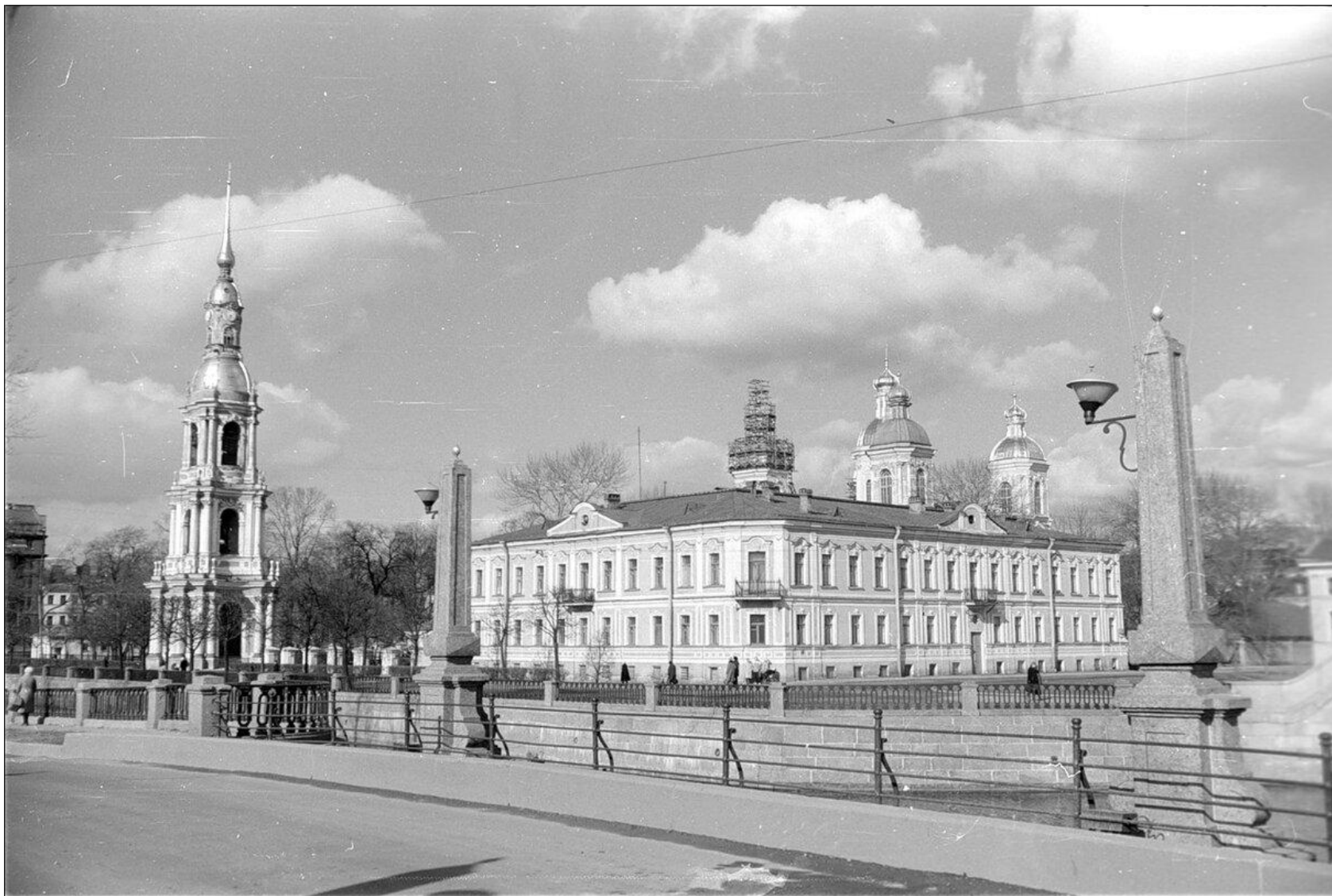
Ил. 30. Вид на Никольский собор с Пикалова моста. Фотография. 1989 г. Автор съемки: неизвестен.
