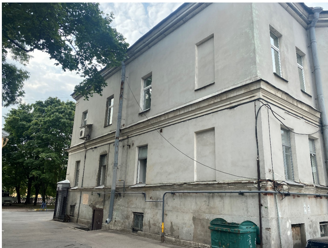
6. Вид на дворовой фасад;
