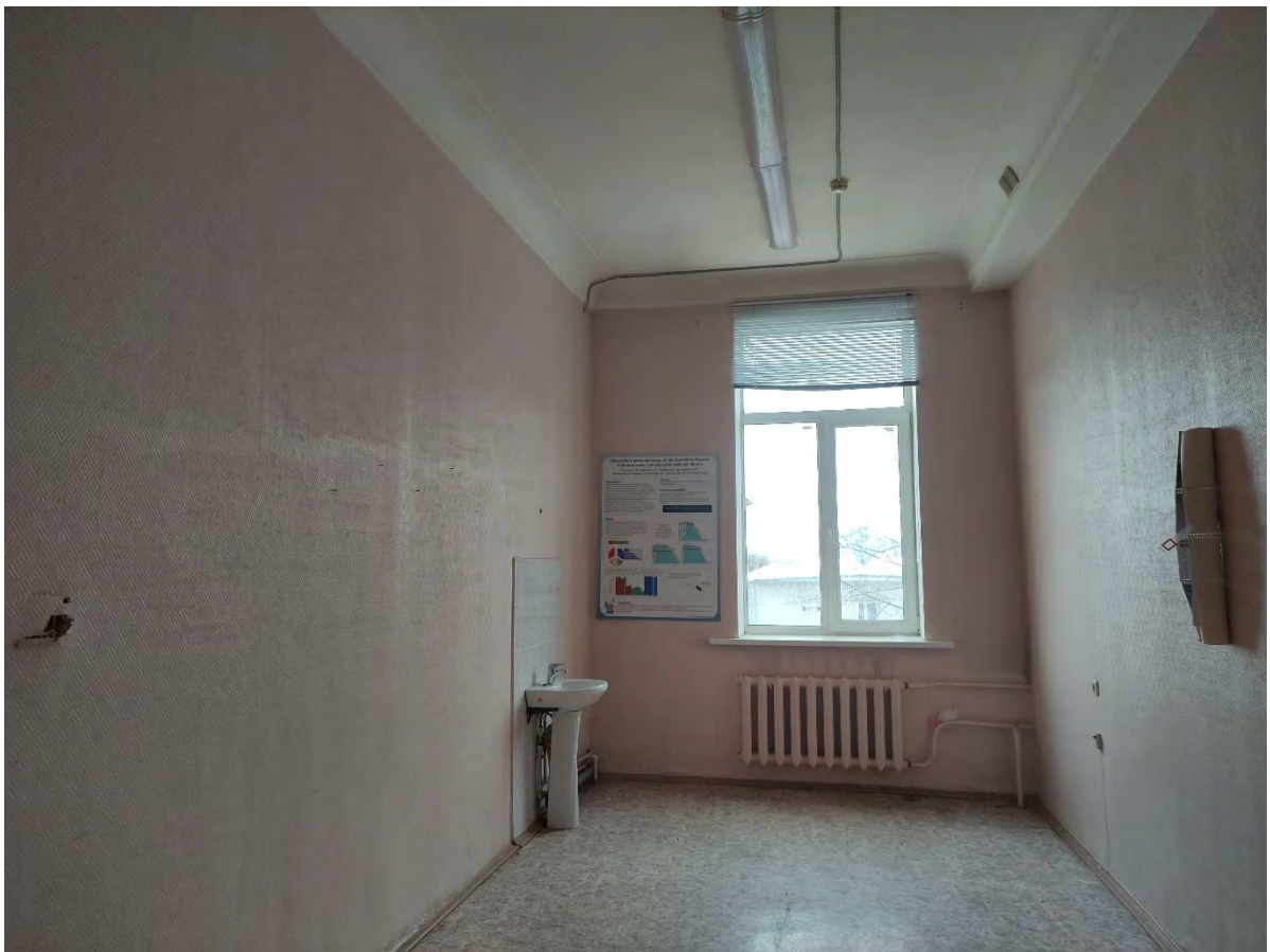
73. Общий вид пом. 4-Н (15) в уровне 3-го этажа.
