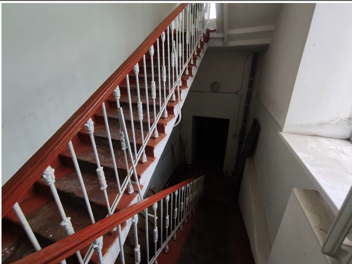
46. Общий вид объема двухмаршевой лестницы (пом. 2-Н (24)) в уровне 1-го этажа.
