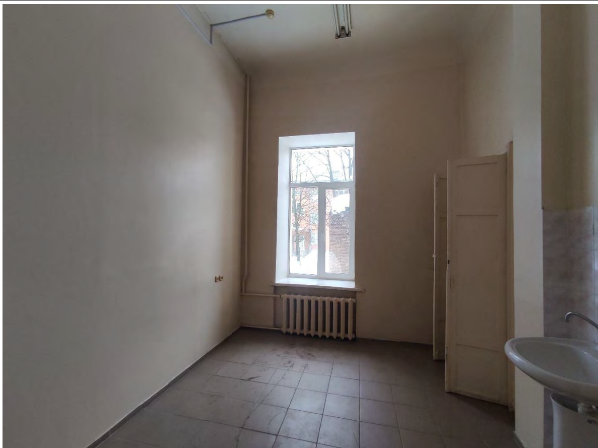
47. Фрагмент пом. 2-Н (6) в уровне 1-го этажа.
