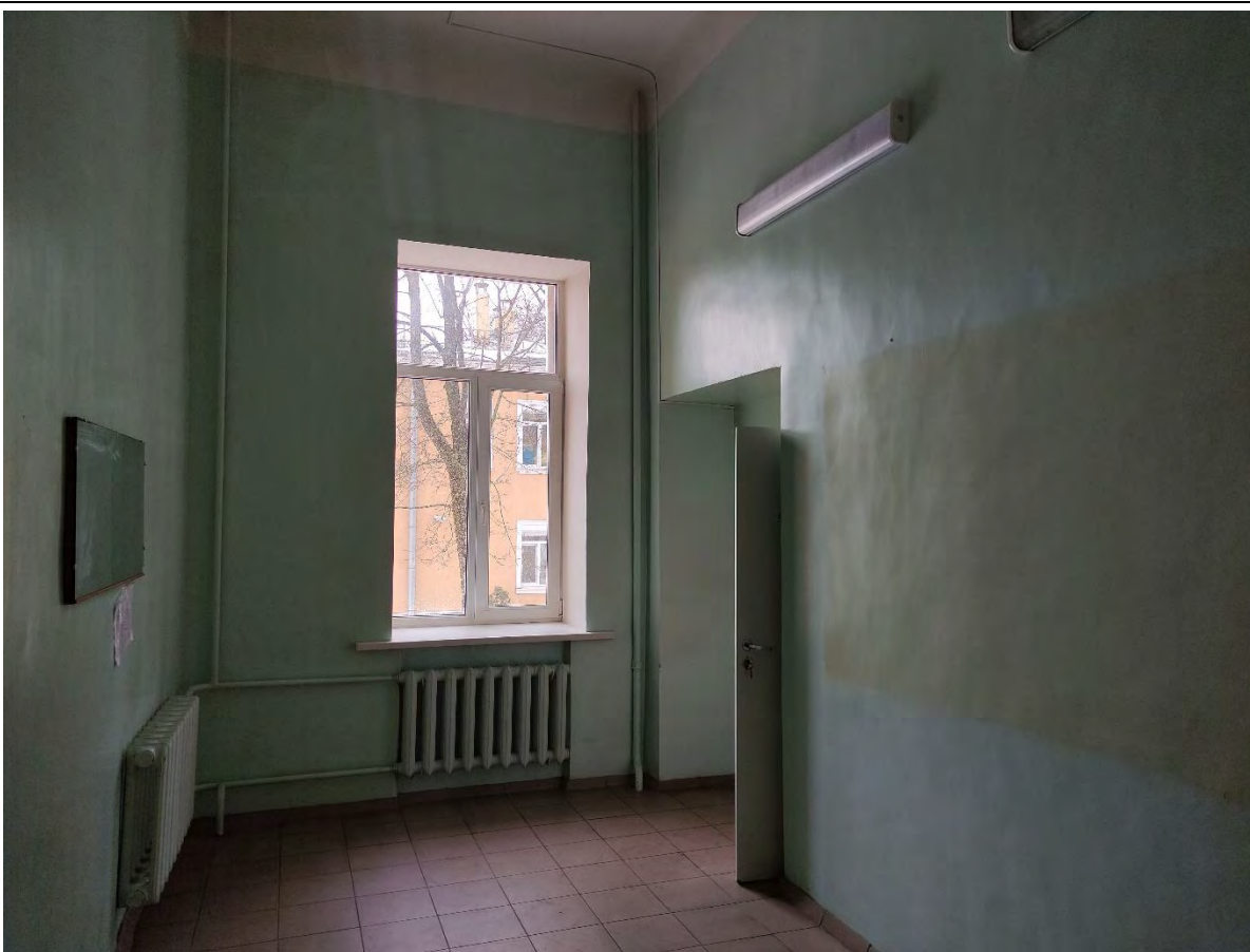
40. Общий вид пом. 2-Н (19) в уровне 1-го этажа.
