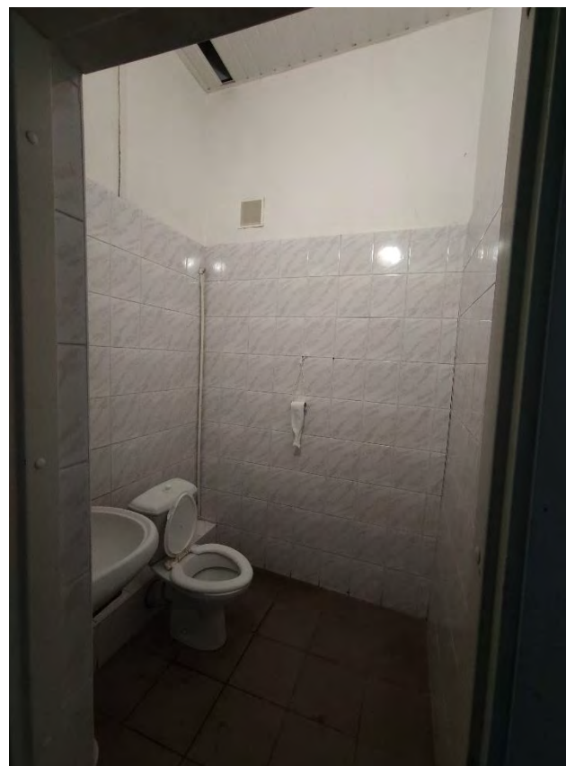
43. Общий вид пом. 2-Н (16) в уровне 1-го этажа.
