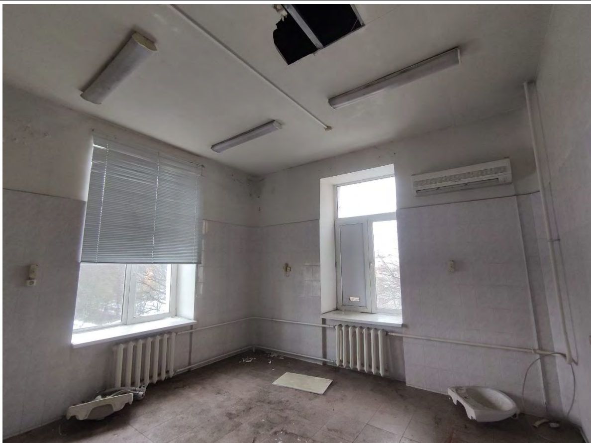
75. Общий вид пом. 4-Н (20) в уровне 3-го этажа.
