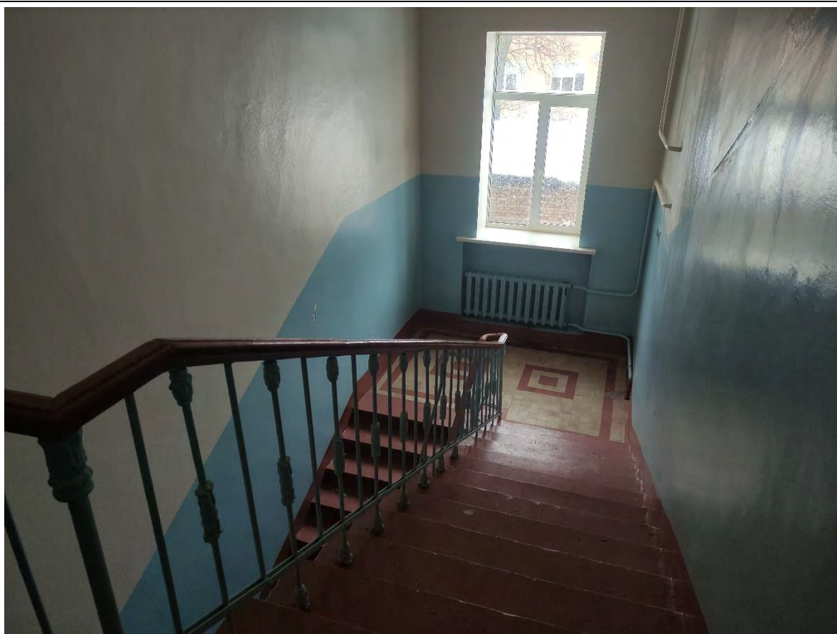
51. Общий вид объема двухмаршевой лестницы (пом. 3-Н (29)) в уровне 2-го этажа.
