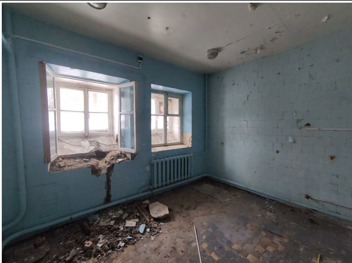
22. Общий вид пом. 1-Н (26) в уровне цокольного этажа.
