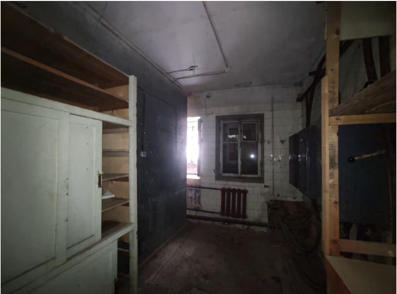
14. Фрагмент пом. 1-Н (16) в уровне цокольного этажа.
