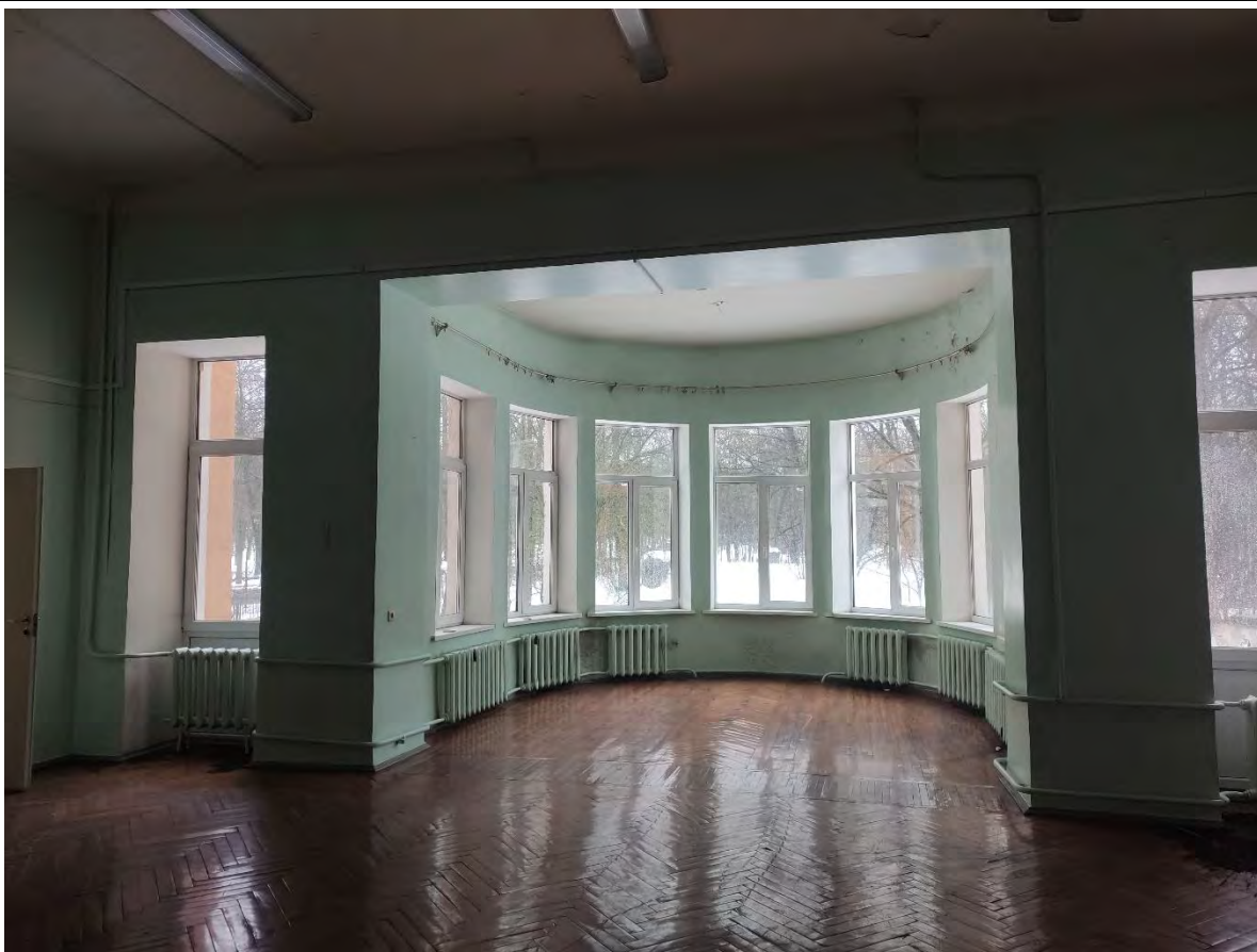
35. Общий вид пом. 2-Н (3) в уровне 1-го этажа.
