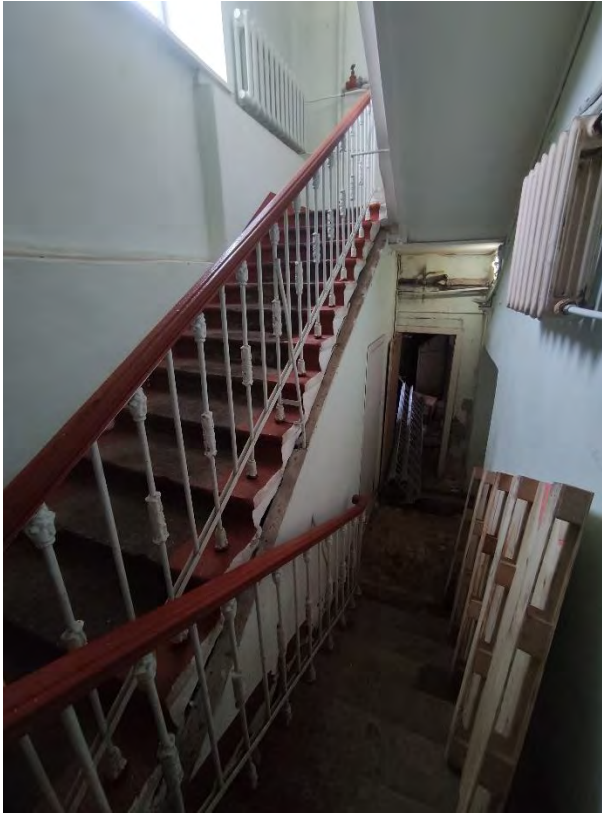
12. Общий вид объема двухмаршевой лестницы (пом. 1-Н (32)).
