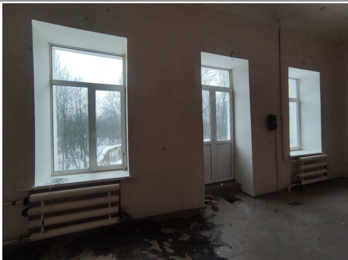
63. Фрагмент пом. 3-Н (4, 7, 26) в уровне 2-го этажа.
