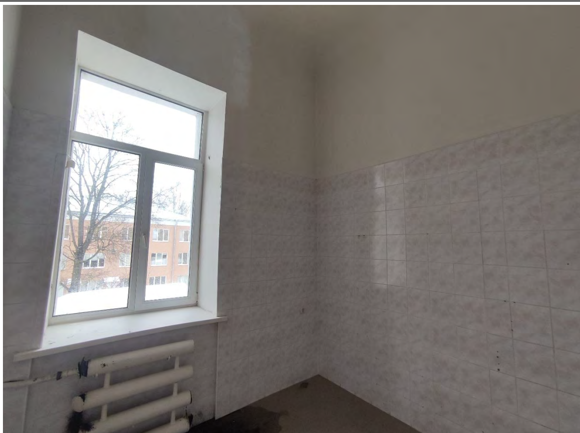
68. Общий вид пом. 3-Н (11) в уровне 2-го этажа.
