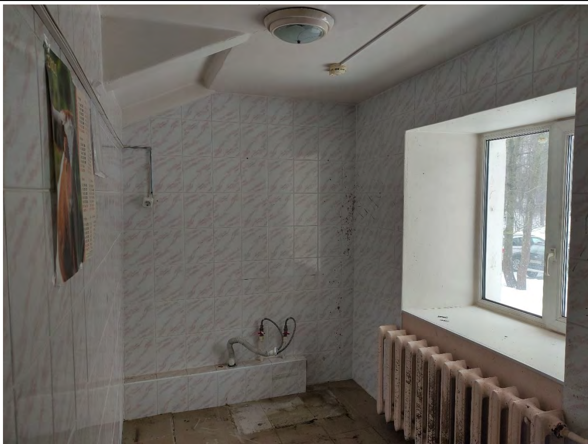
45. Общий вид пом. 2-Н (9) в уровне 1-го этажа.
