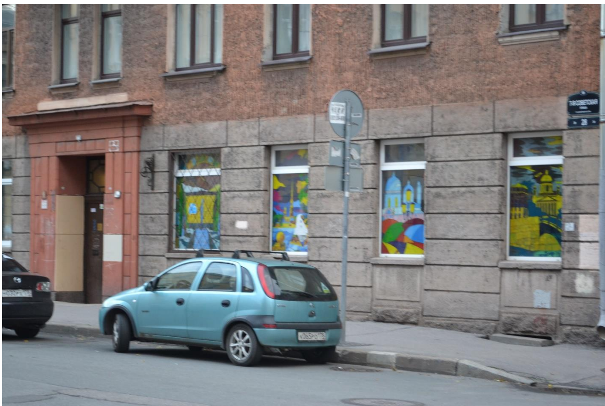
Фото 2. Фрагмент лицевого (юго-западного) фасада. Вид с юга.
