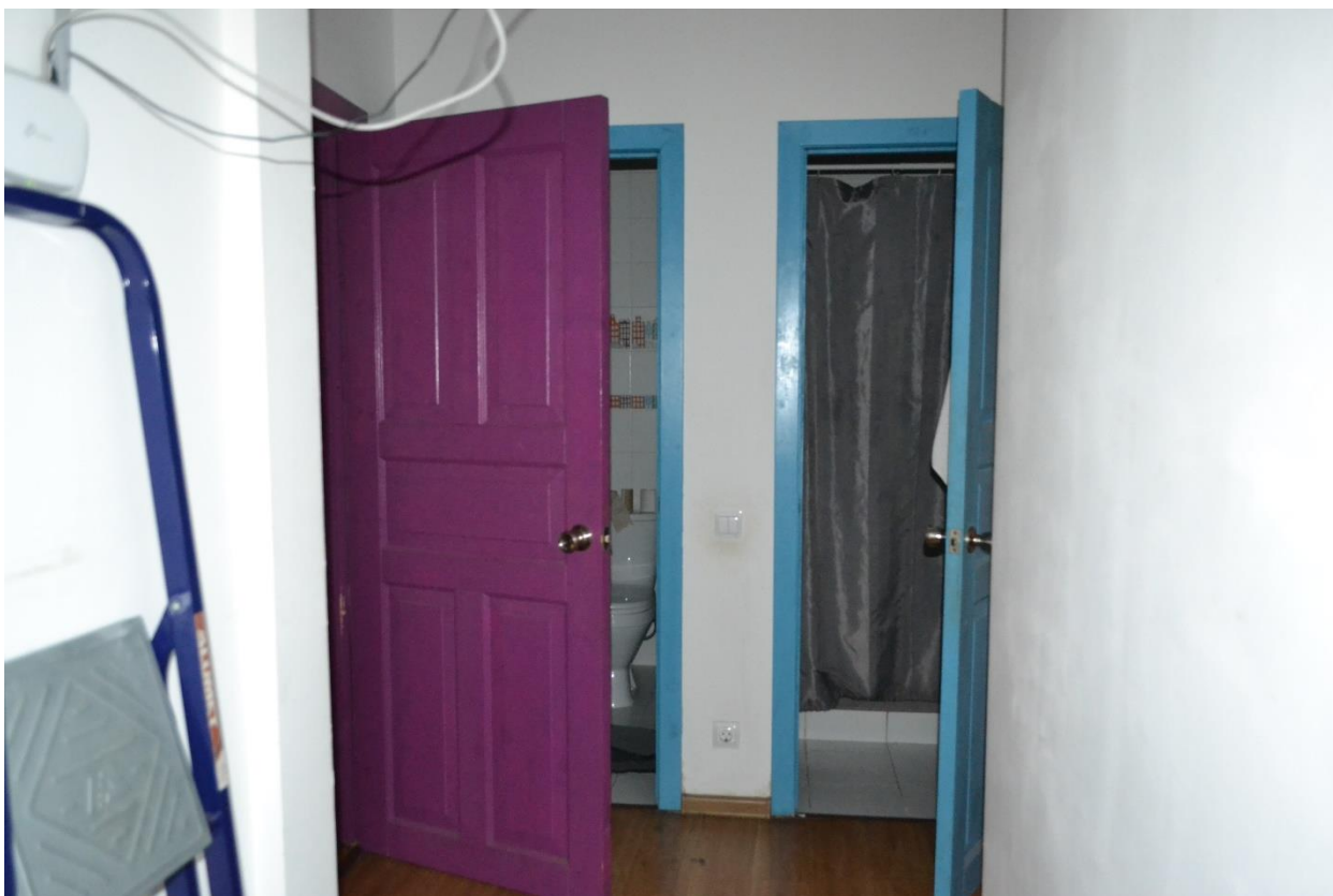
Фото 14. Помещение №10 – прихожая. Общий вид на помещение №7 – коридор.
