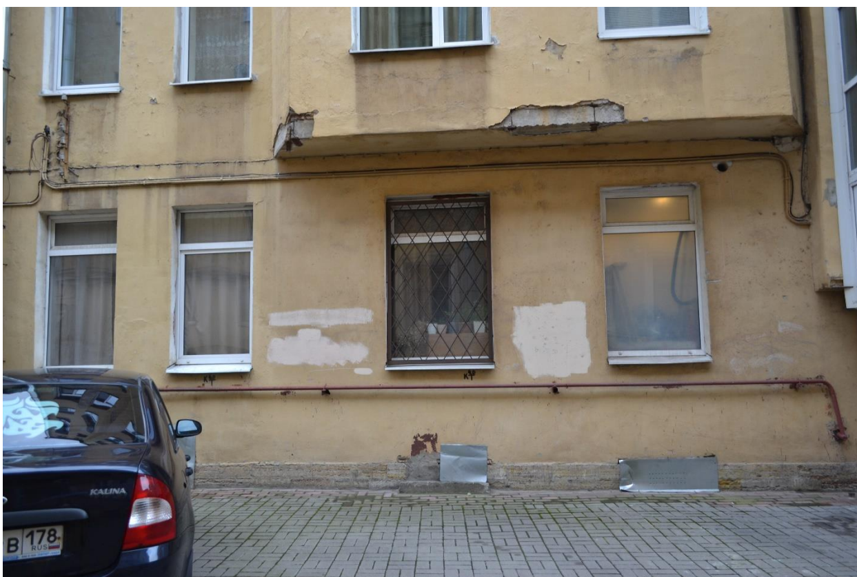
Фото 5. Фрагмент дворового фасада, оконные проемы квартиры №1. Вид с северо-востока.
