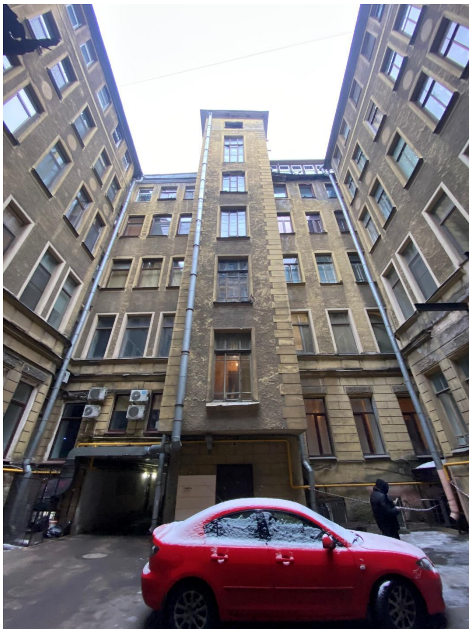
4. Вид на дворовой фасад
