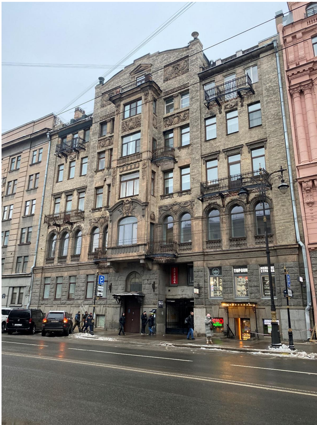
2. Вид на лицевой фасад
