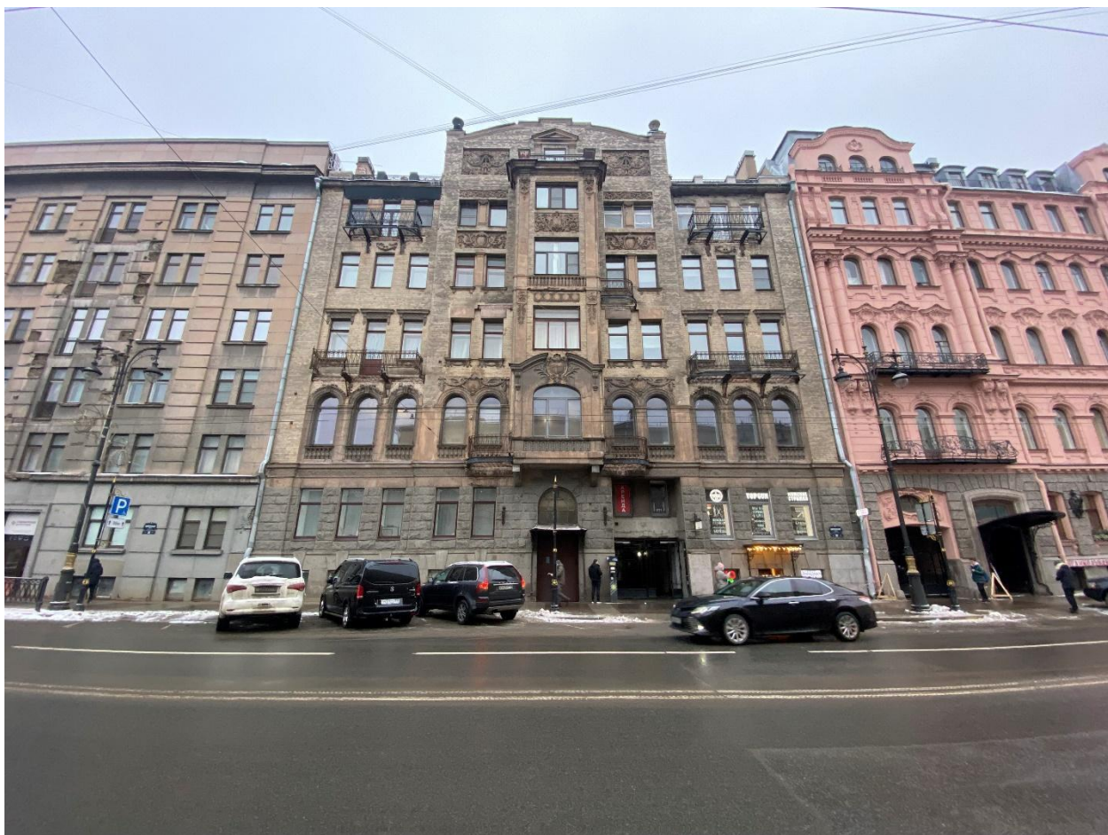
1. Вид на лицевой фасад
