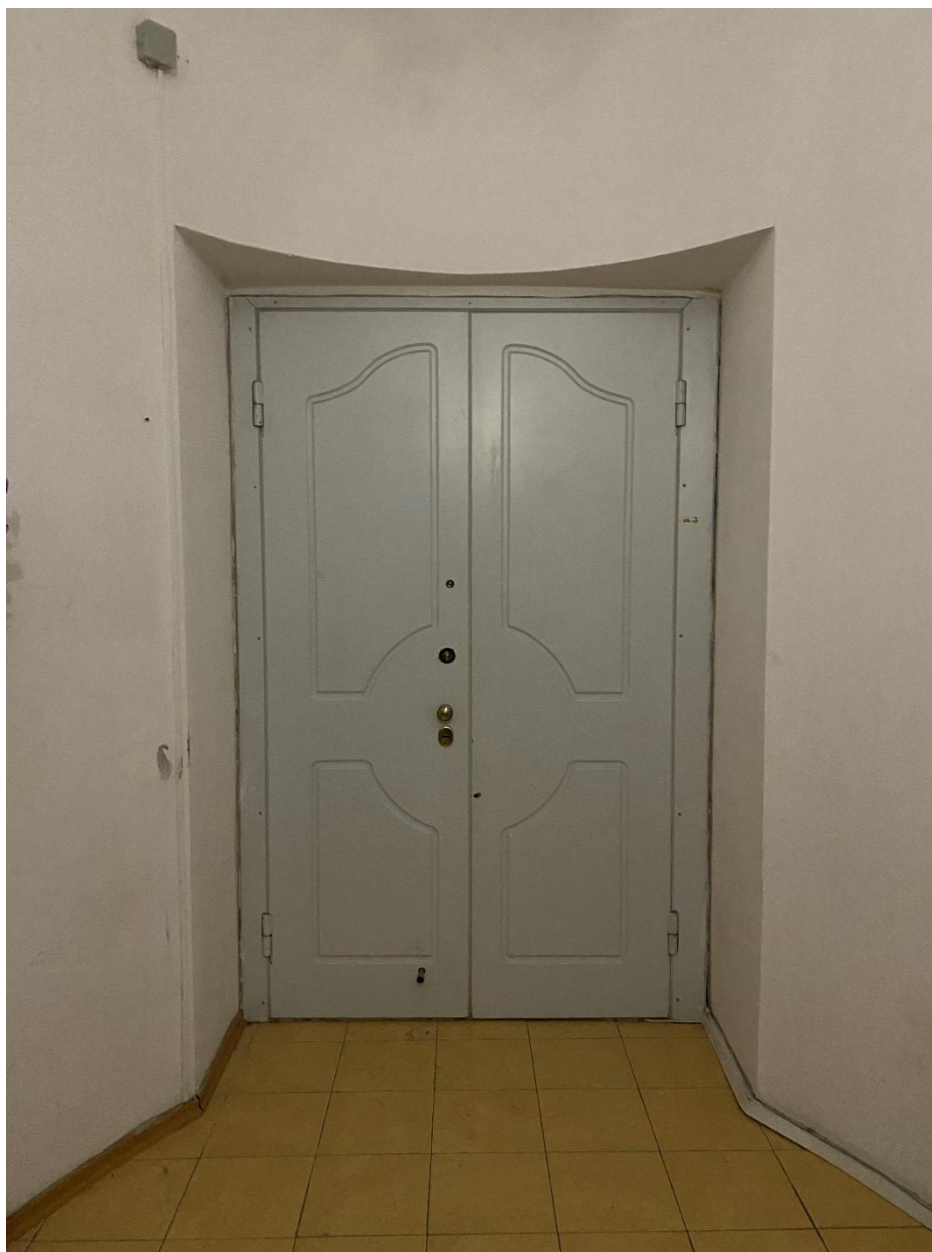
7. Вид на входную дверь квартиры
