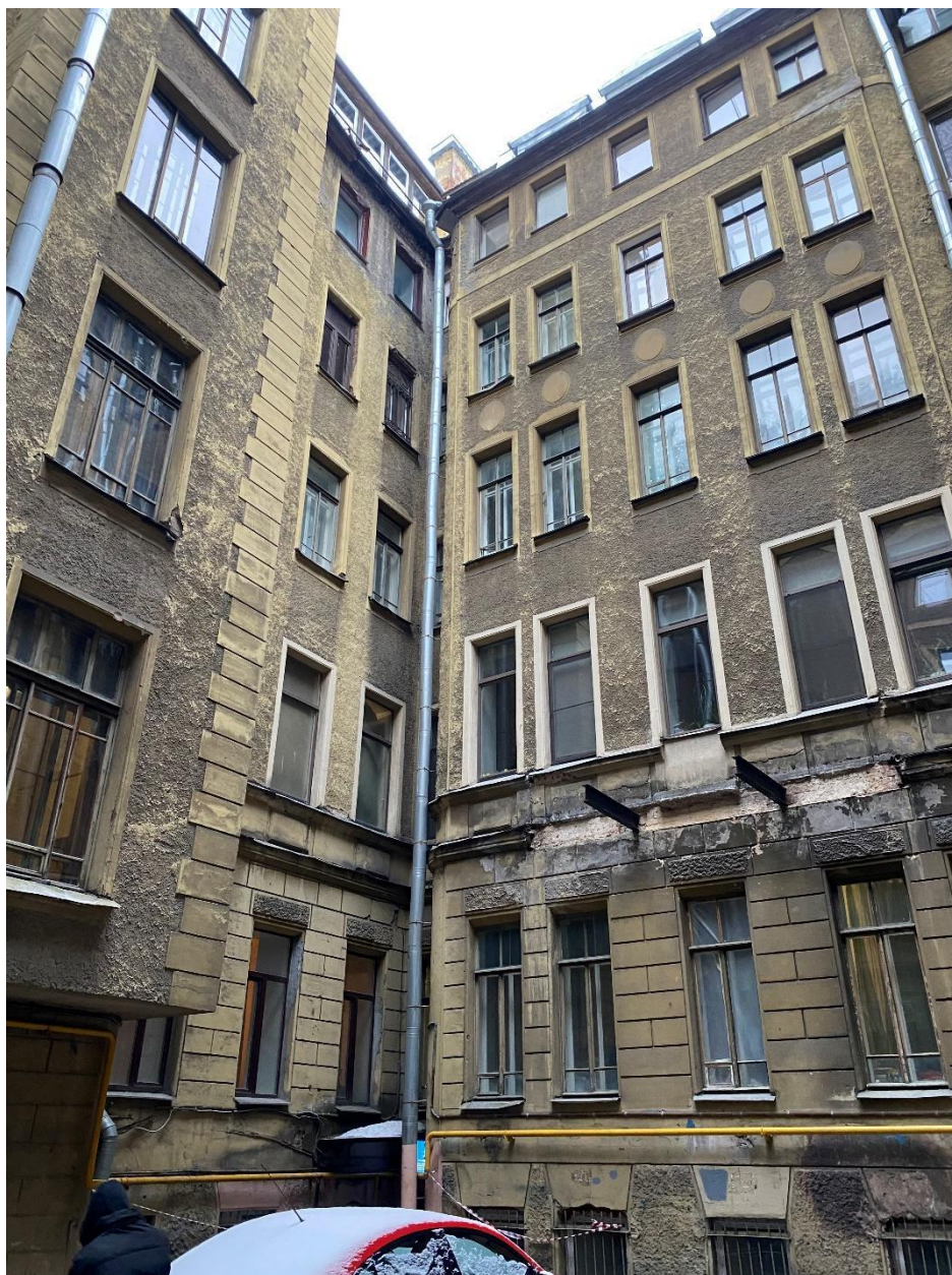
3. Вид на дворовой фасад
