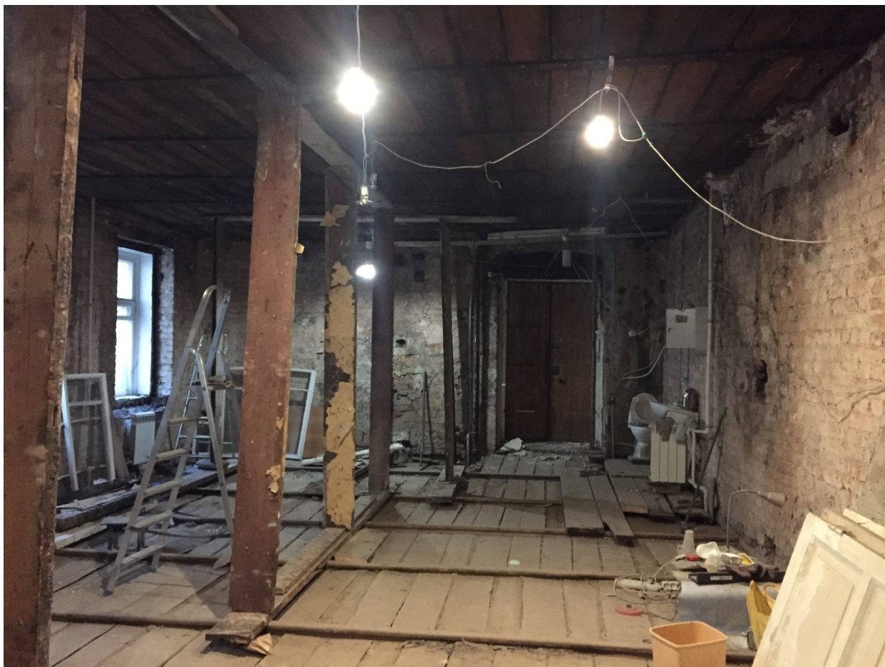
Фото 13. Общий вид существующего состояния помещений квартиры № 78.
