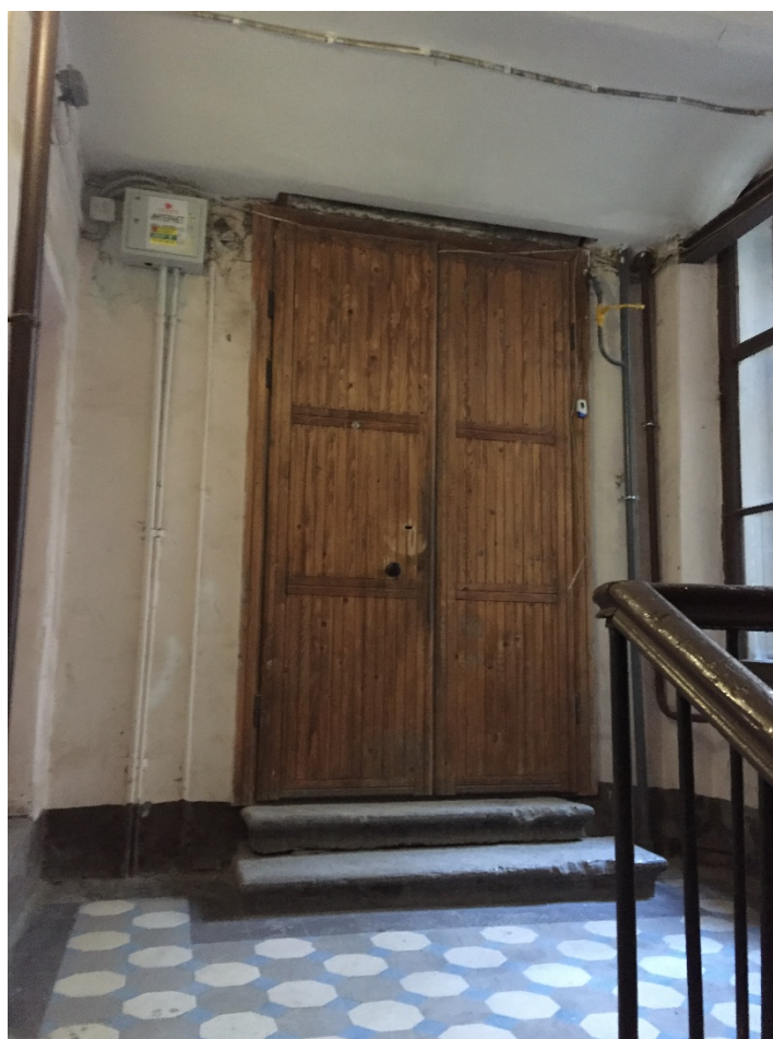
Фото 10. Входная дверь квартиры № 78. Общий вид со стороны лестничной клетки.
