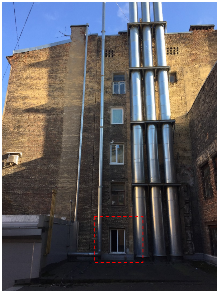
Фото 9. Северо-западный фасад дворового корпуса.
