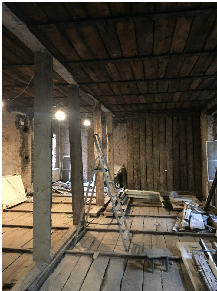
Фото 11. Общий вид помещений квартиры № 78.
