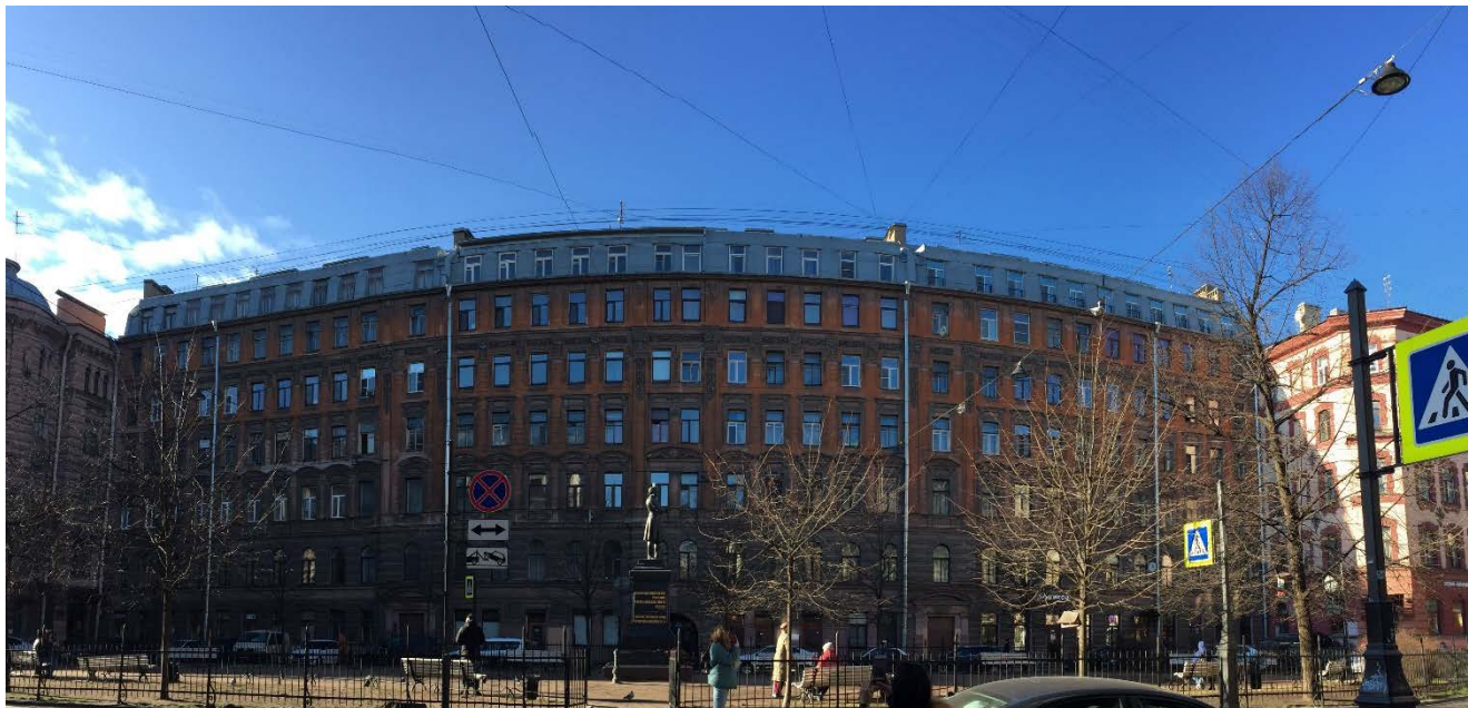
Фото 1. Общий вид главного юго-восточного фасада.
