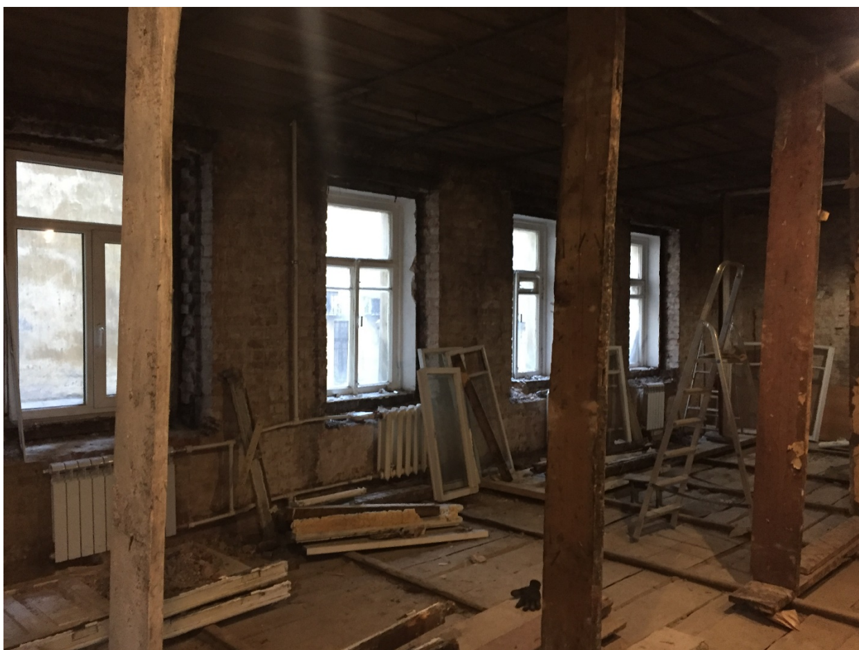
Фото 14. Общий вид существующего состояния помещений квартиры № 78 и оконных заполнений юго-восточного дворового фасада.
