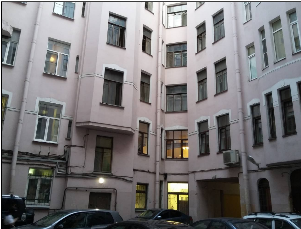
6. Фрагмент дворового фасада дворового флигеля.
