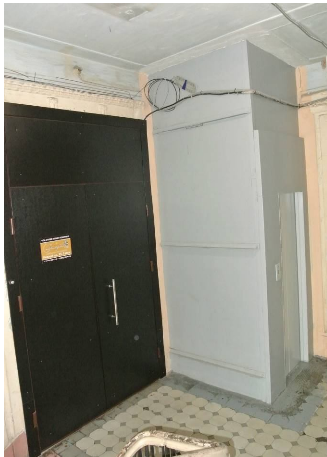
Фото 51. Вид на лестничной площадке.
