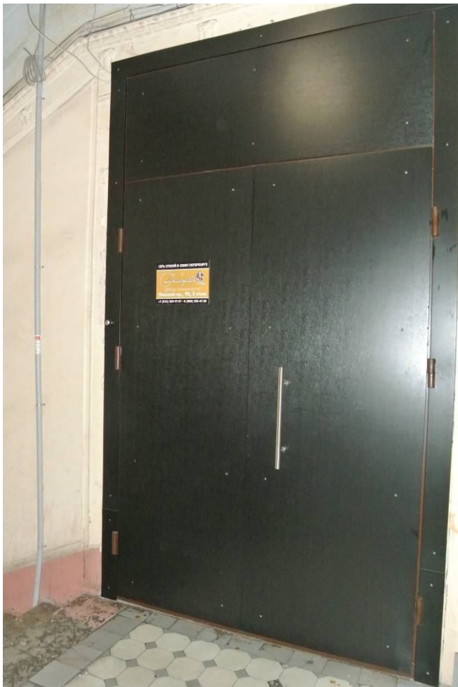
Фото 50. Вид на лестничной площадке.
