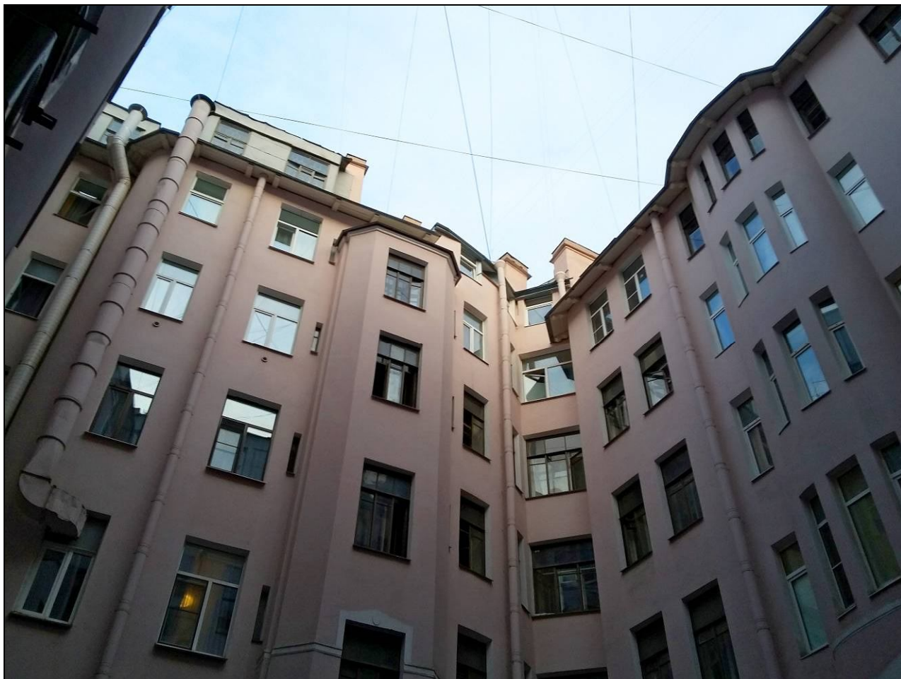
5. Фрагмент дворового фасада дворового флигеля.
