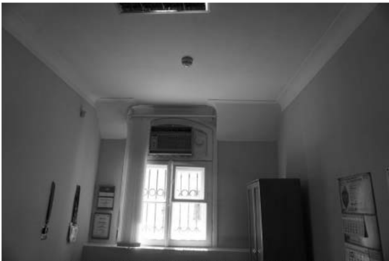
Фото 11. Интерьер помещения 12-Н (часть помещения №7) 5 этаж
