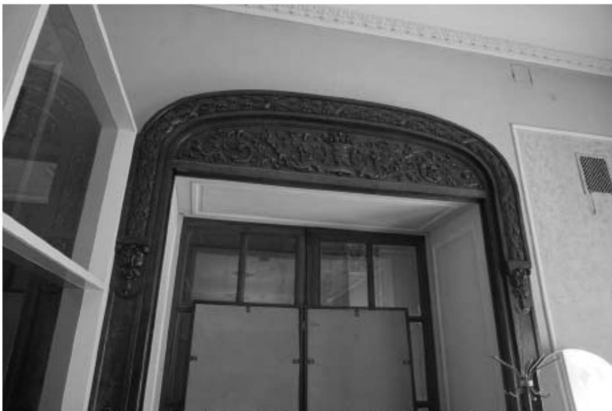
Фото 46. Интерьер помещения 9-Н (часть помещения №8) 3 этаж
