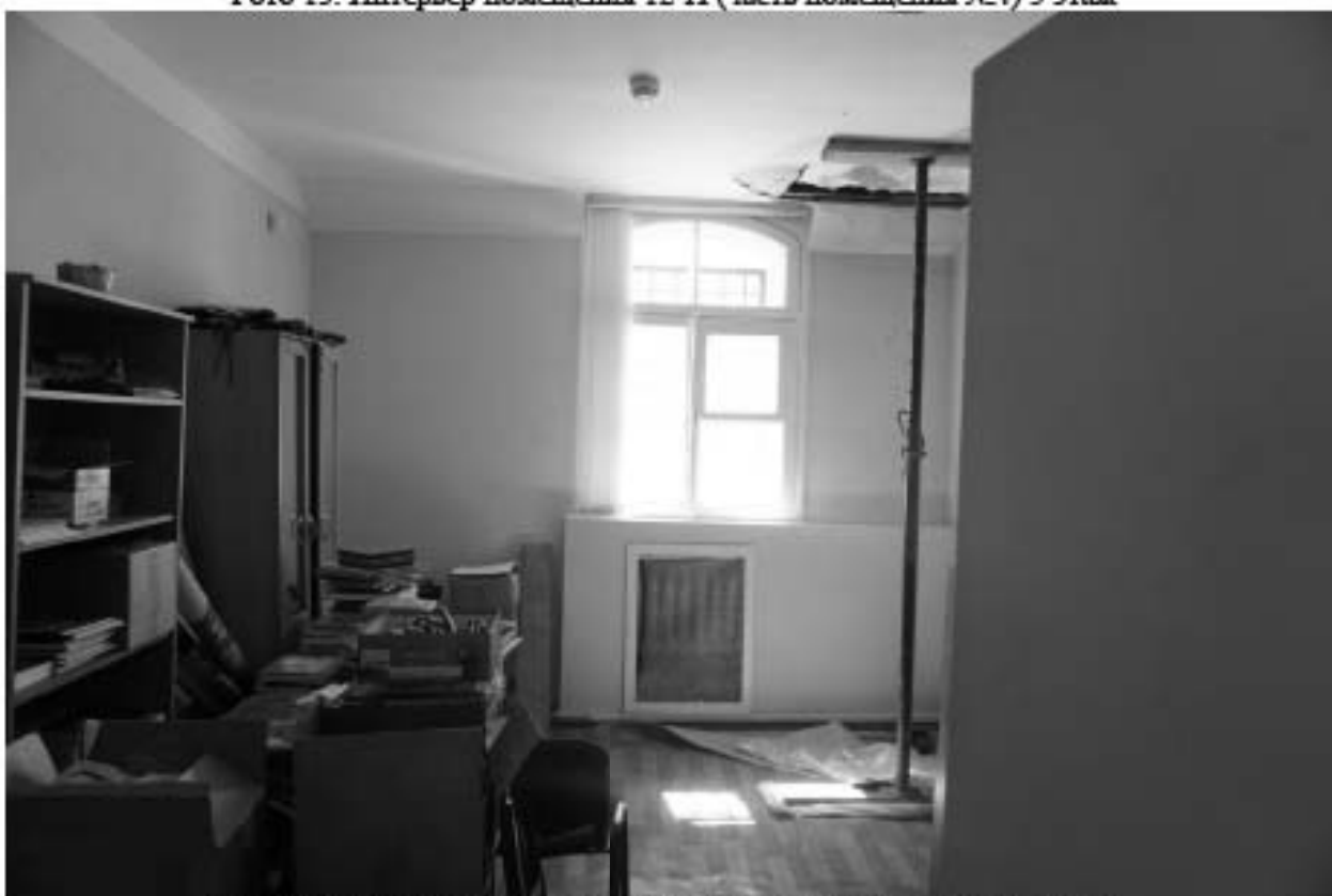
Фото 14. Интерьер помещения 12-Н (часть помещения №3) 5 этаж
