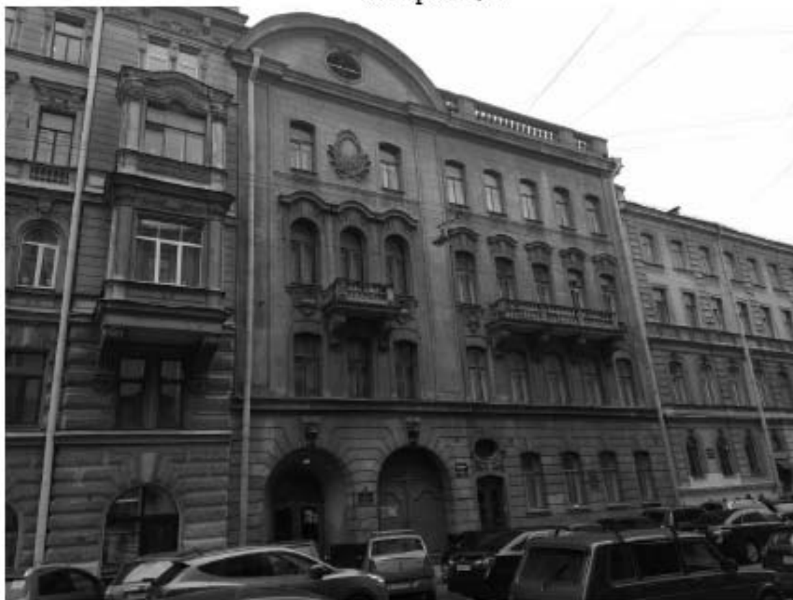
Фото 1. Лицевой фасад объекта культурного наследия регионального значения «Особняк Штифтер»
