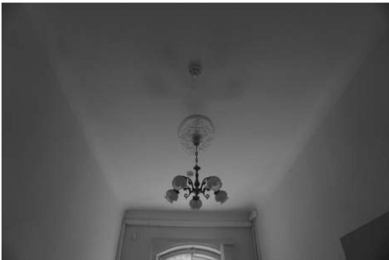
Фото 20. Потолок помещения 9-Н (часть помещения №30) 4 этаж
