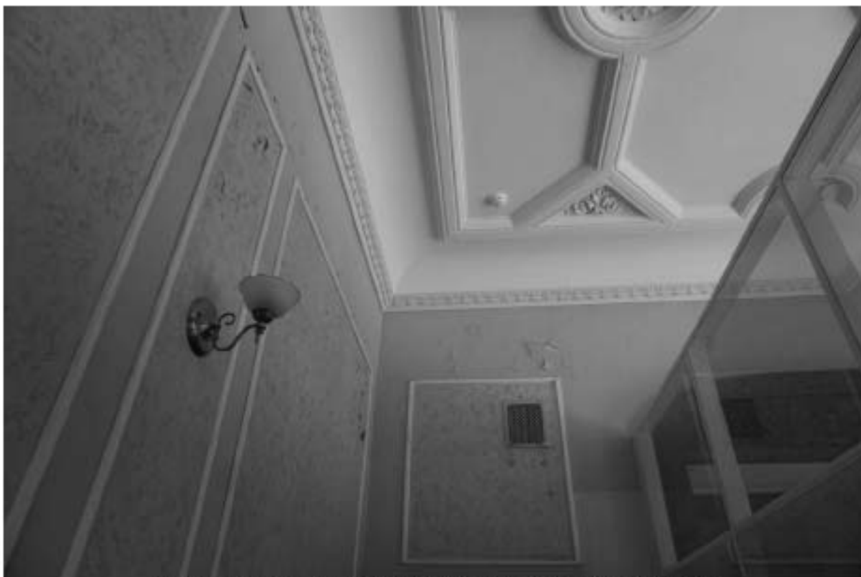
Фото 44. Интерьер помещения 9-Н (часть помещения №8) 3 этаж
