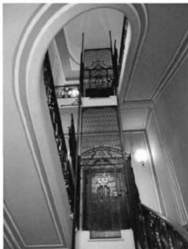
13. Кованое ограждение шахты лифта
