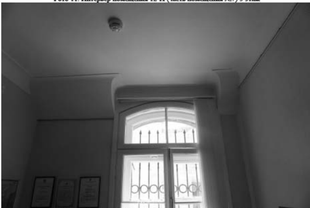
Фото 12. Интерьер помещения 12-Н (часть помещения №6) 5 этаж
