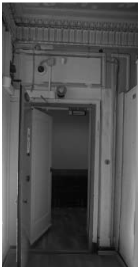
Фото 17. Дверной проём пом. 9-Н.
