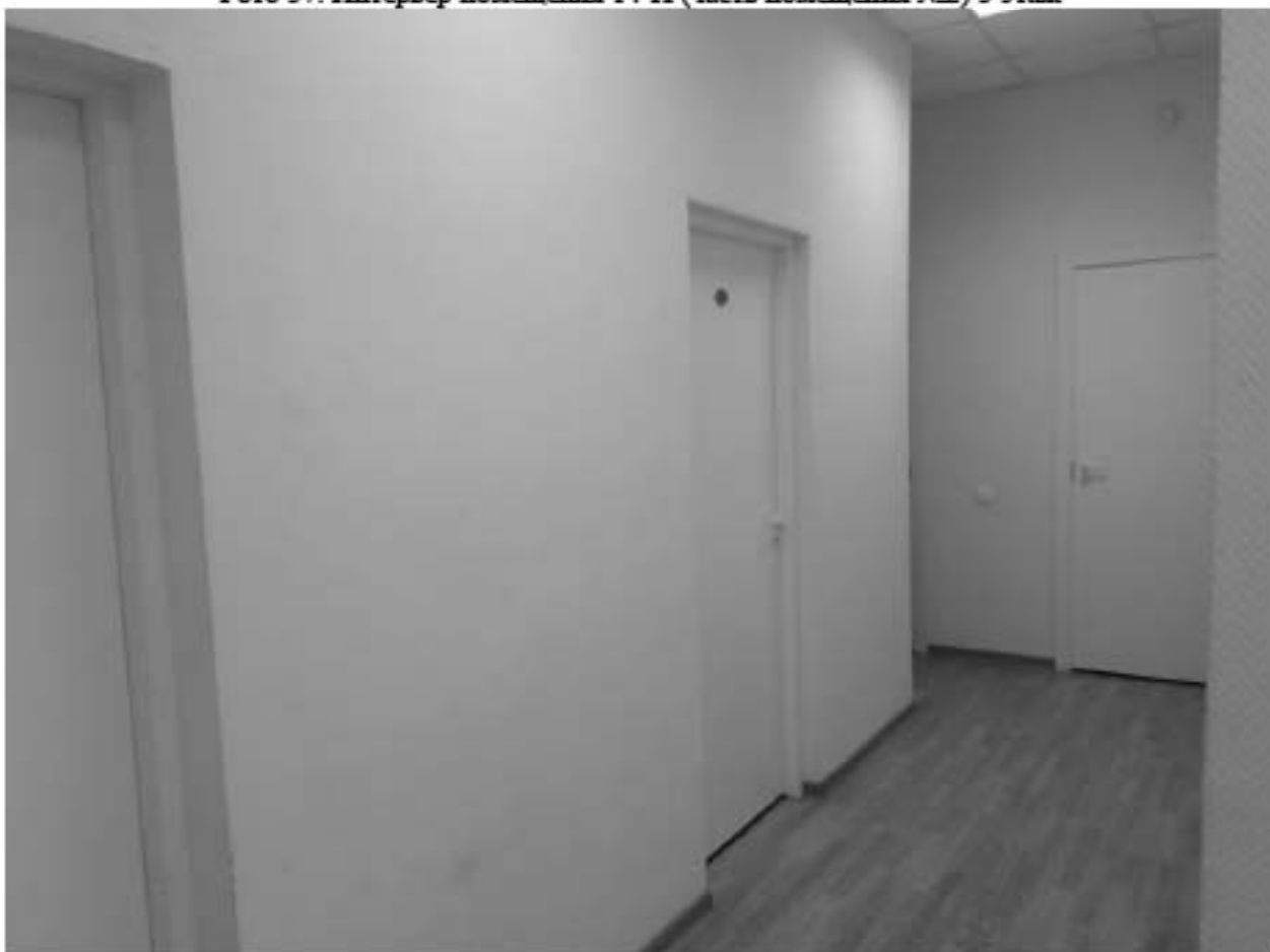
Фото 38. Интерьер помещения 14-Н (часть помещения №2) 3 этаж
