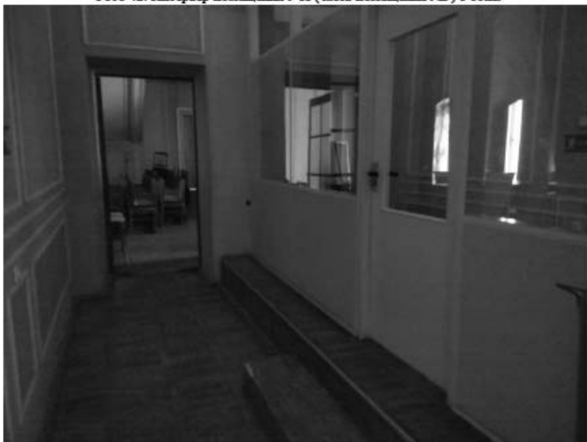
Фото 43. Интерьер помещения 9-Н (часть помещения №8) 3 этаж
