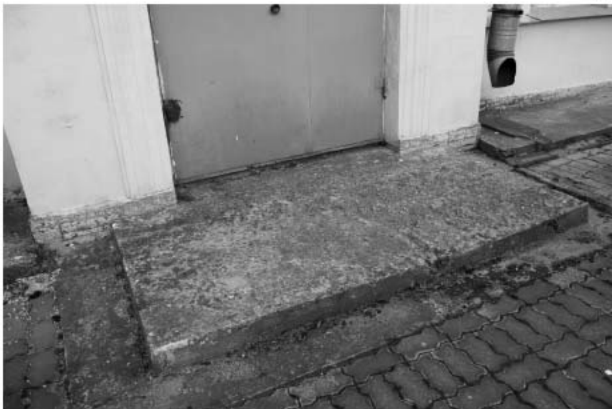
Фото 29. Площадка входа павильона гинекологических и глазных болезней.
