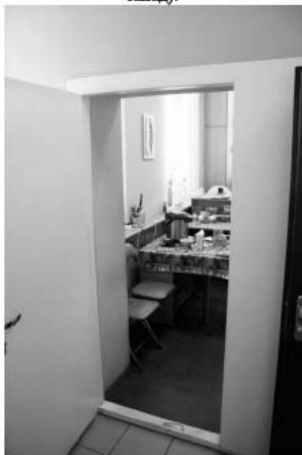
Фото 118. Вход в кабинет (юго-запад).
