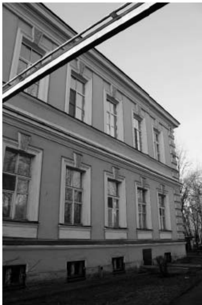
Фото 63. Восточный фасад восточного крыла главного здания.
