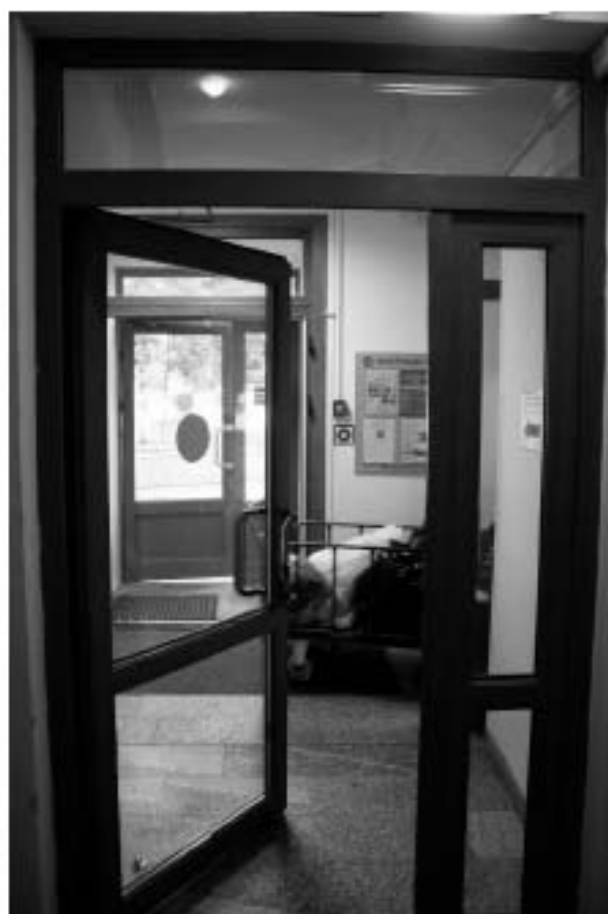
Фото 154. Общий вид на вестибюль.
