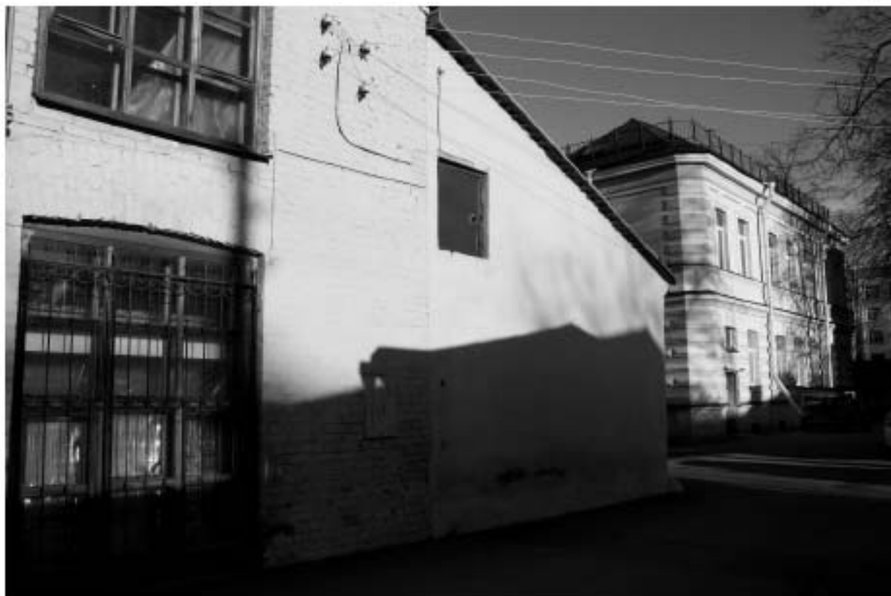
Фото 35. Пристройка к котельной и Павильон-приют.
