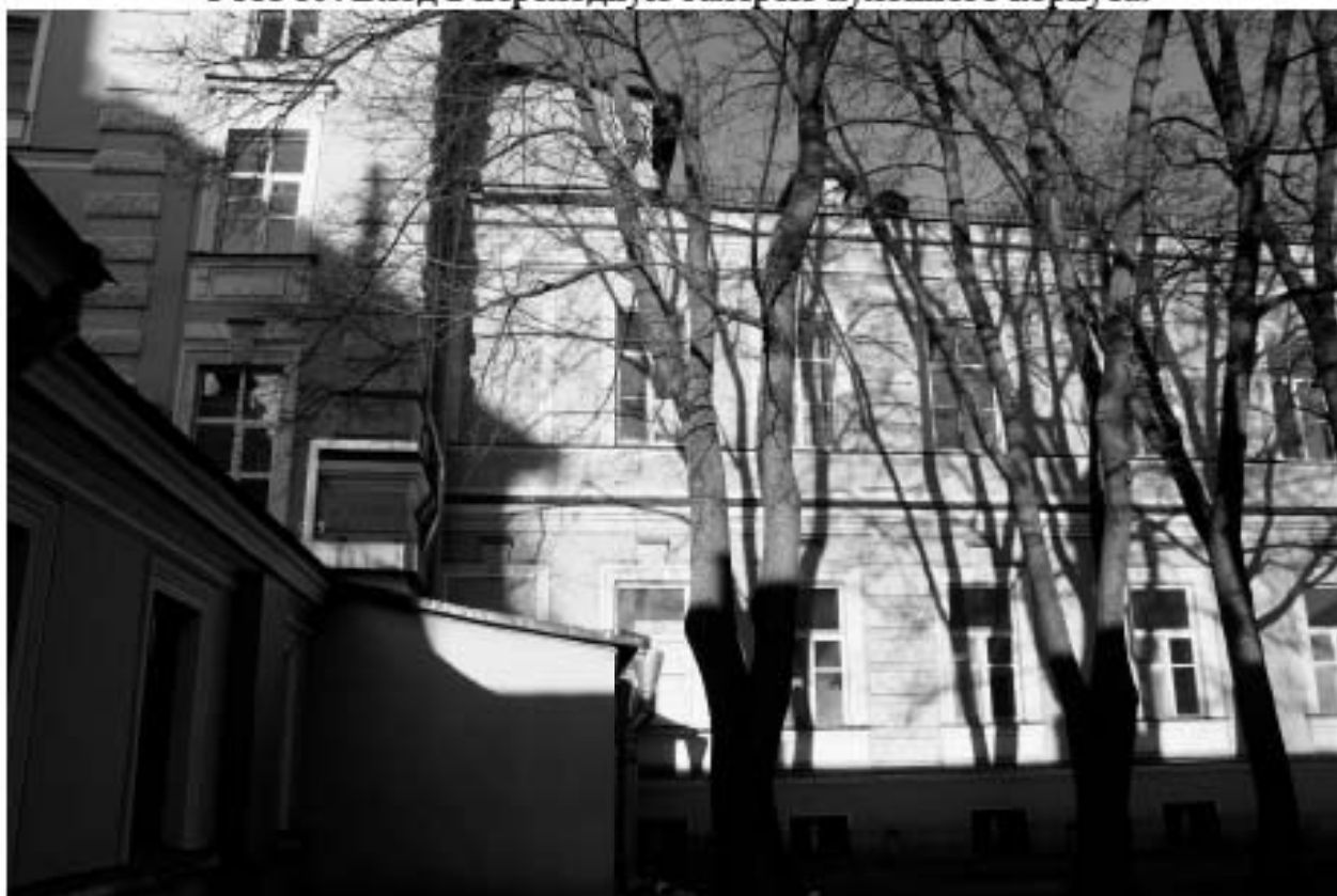
Фото 60. Юго-восточный угол восточного крыла главного здания.
