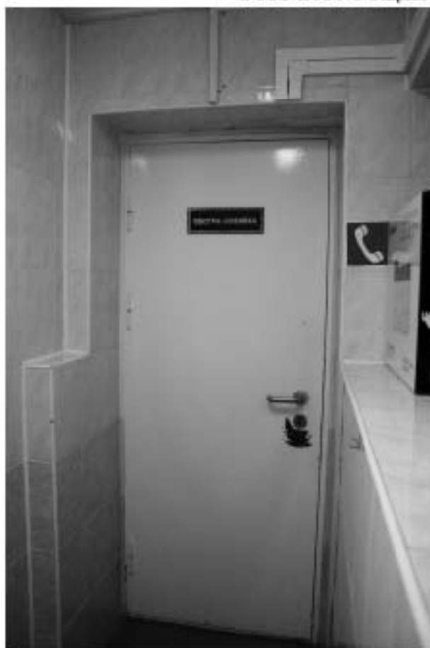
Фото 206. Дверной проем с заполнением служебного помещения.
