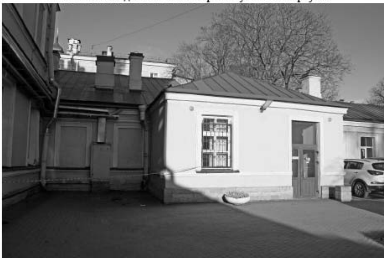
Фото 40. Входная пристройка с южной стороны переходной галереи кухонного корпуса.
