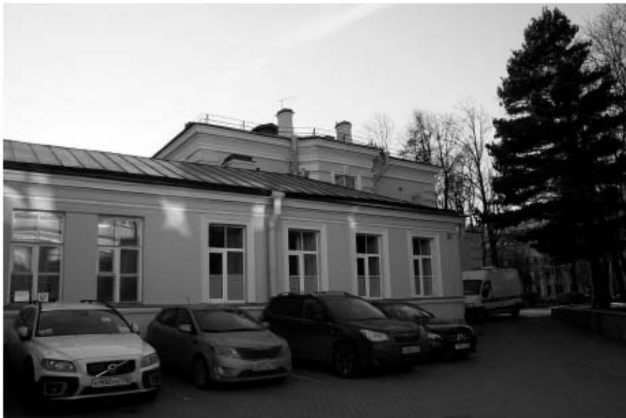
Фото 19. Северный фасад северной части кухонного корпуса.
