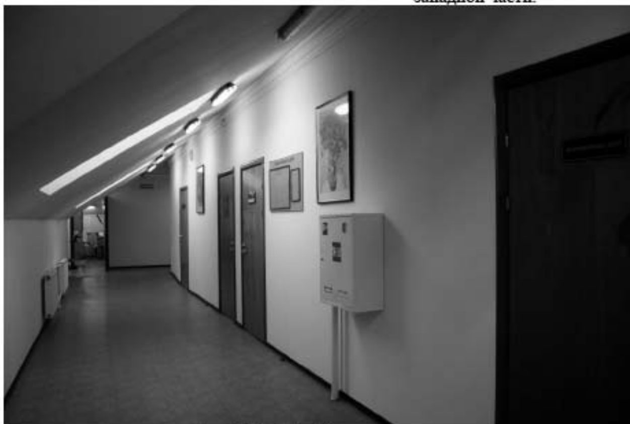
Фото 253. Общий вид коридора.
