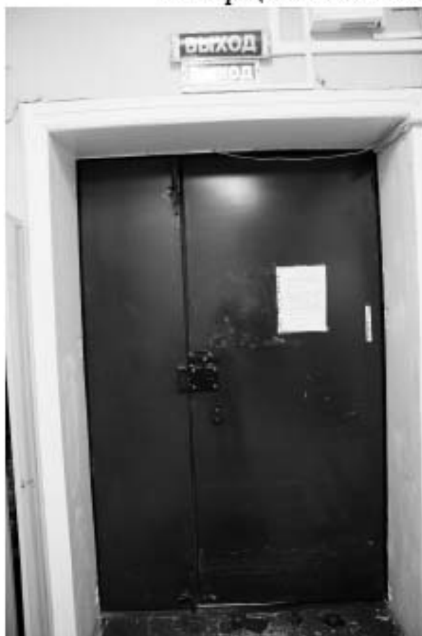
Фото 261. Входной дверной проем.
