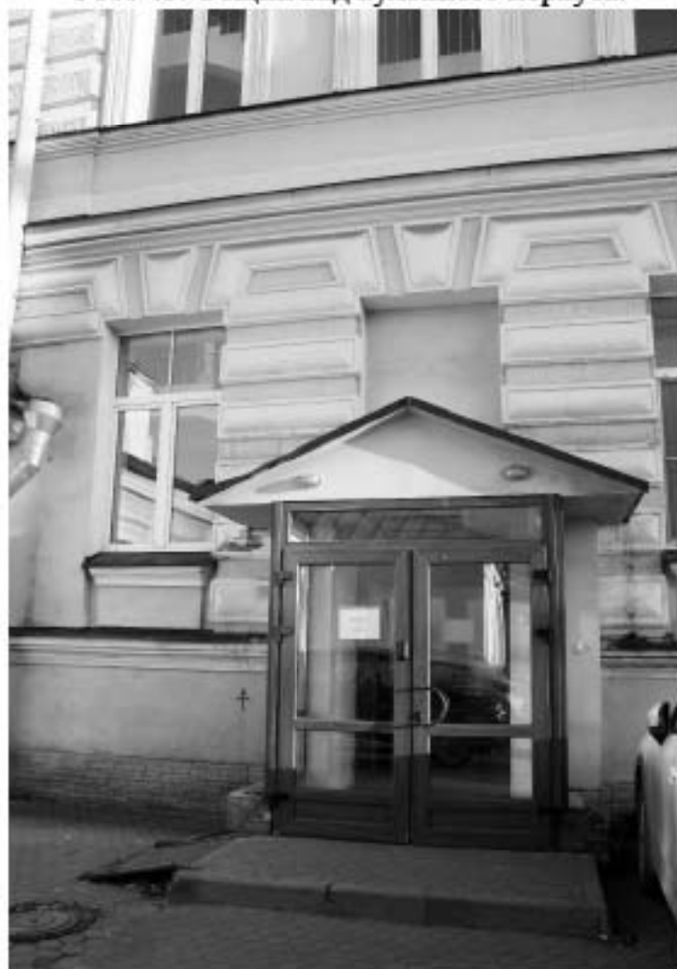
Фото 44. Входная пристройка западного фасада павильона-приюта.
