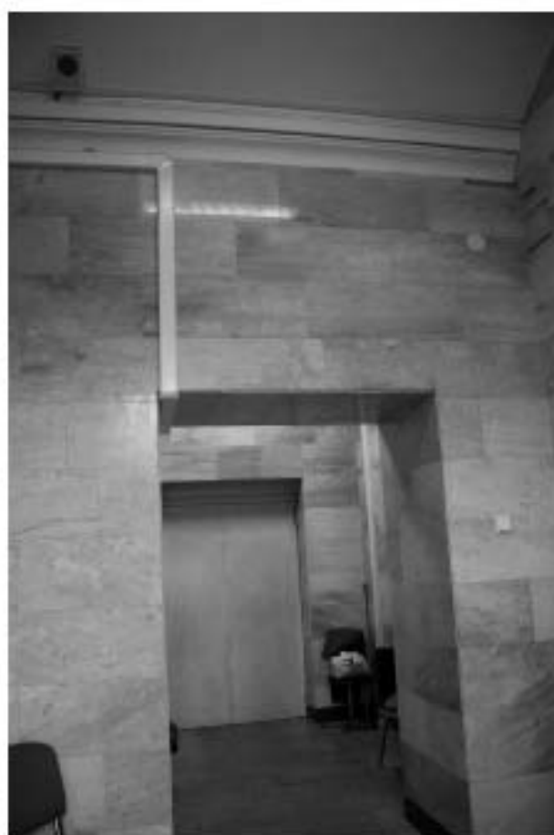
Фото 76. Проем в лифтовой холл.
