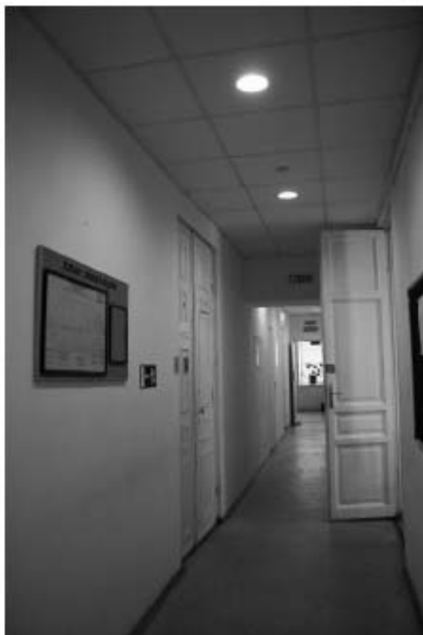
Фото 109. Общий вид 2 этажа.
