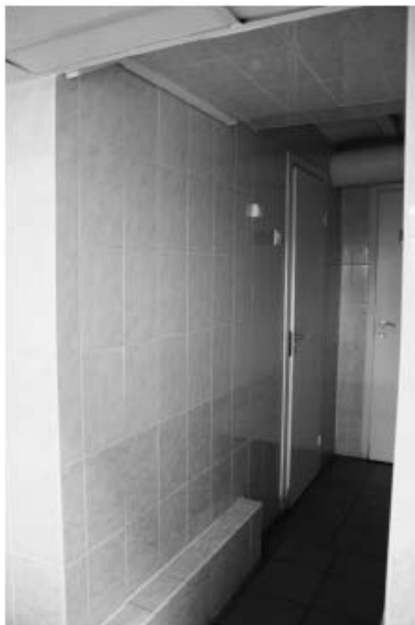
Фото 199. Проемы в помещении.
