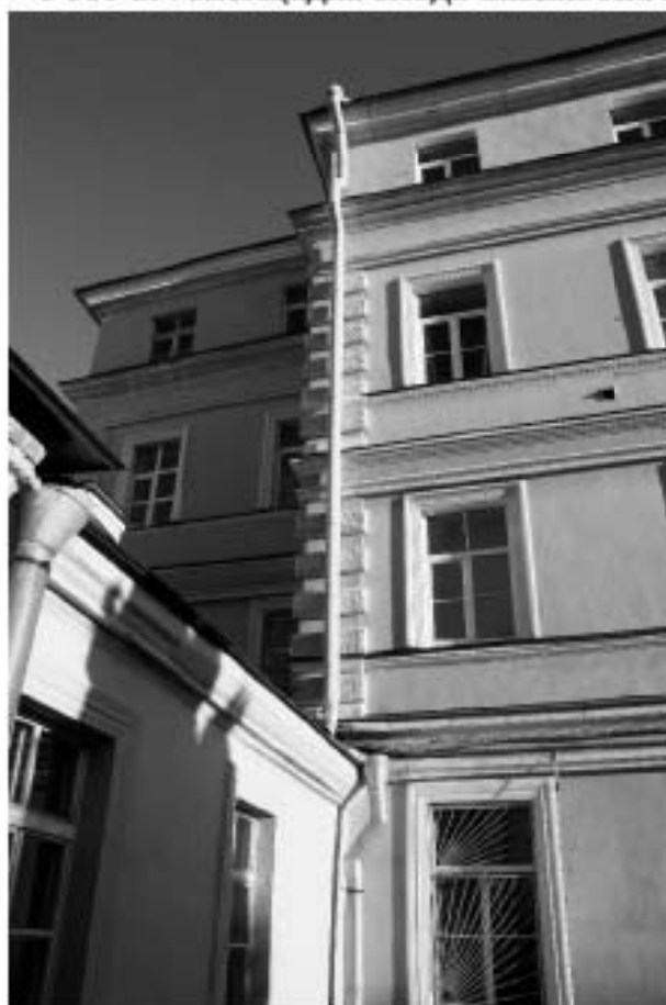
Фото 30. Северо-западный угол кухонного корпуса с переходной галереей.
