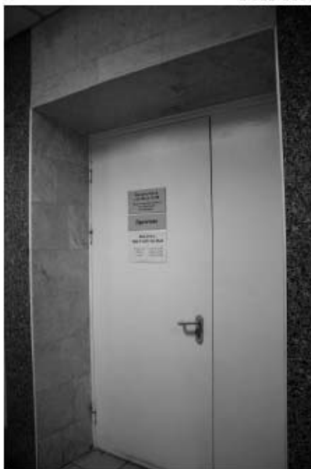
Фото 106. Дверной проем в прачечную.
