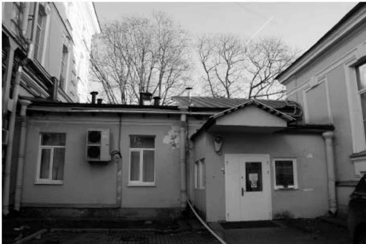
Фото 17. Западный фасад переходной галереи кухонного корпуса.
