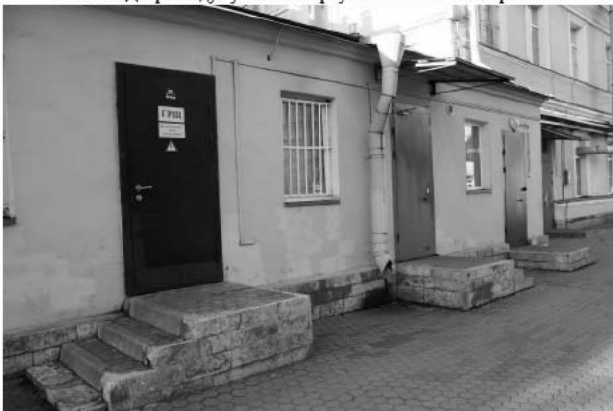
Фото 38. Крыльца с восточной стороны котельной.
