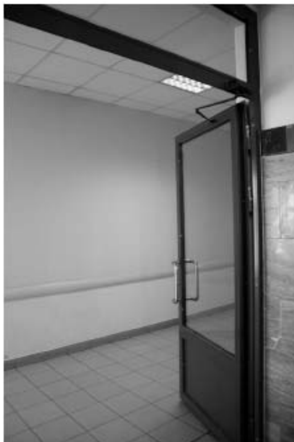
Фото 211. Проем в переходную галерею.
