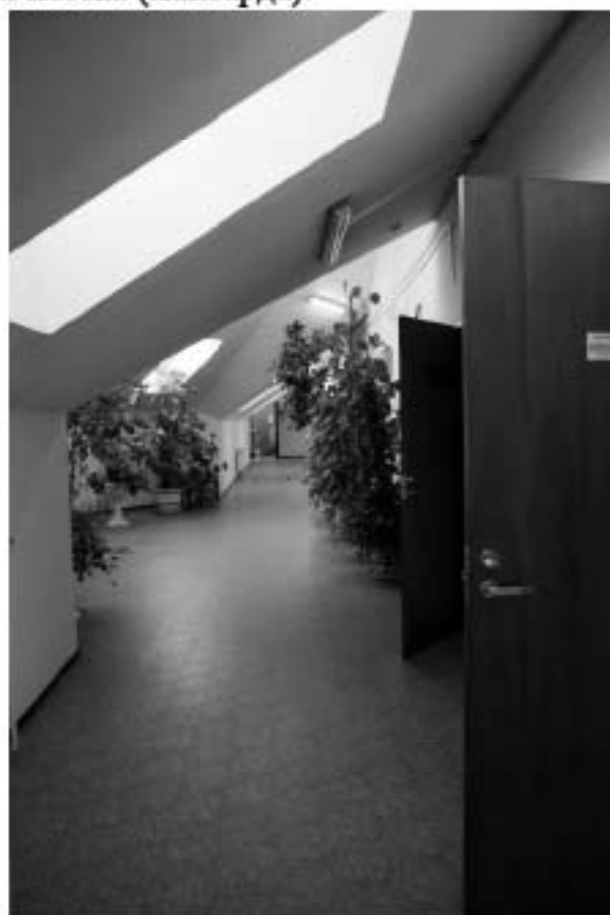
Фото 250. Общий вид мансарды.
