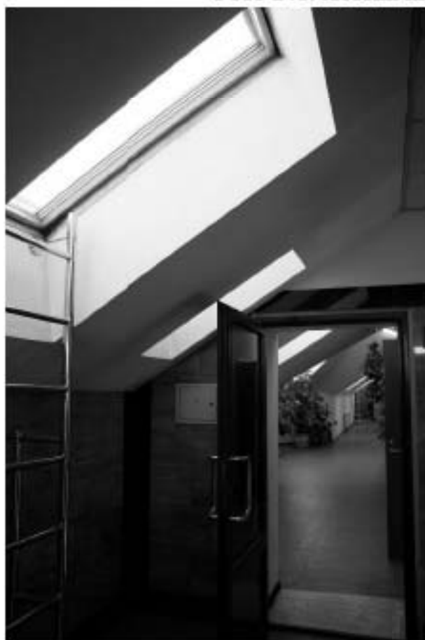
Фото 249. Общий вид мансарды с лестничной клетки.
