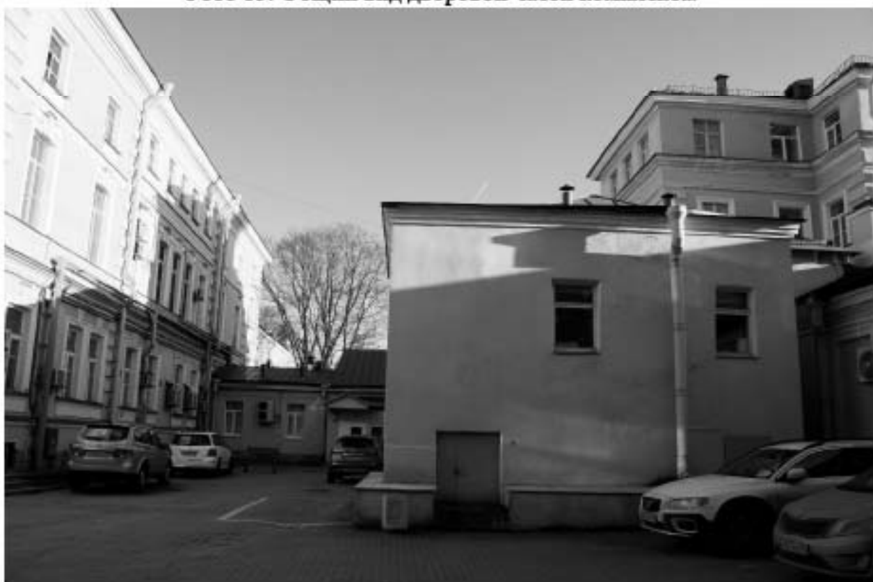
Фото 16. Западные фасады кухонного корпуса.
