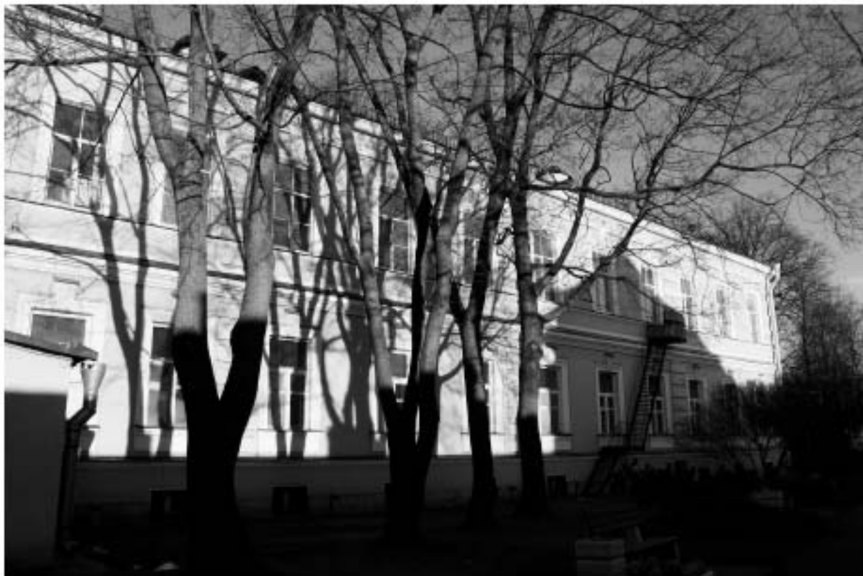
Фото 61. Общий вид южного фасада восточного крыла главного здания.
