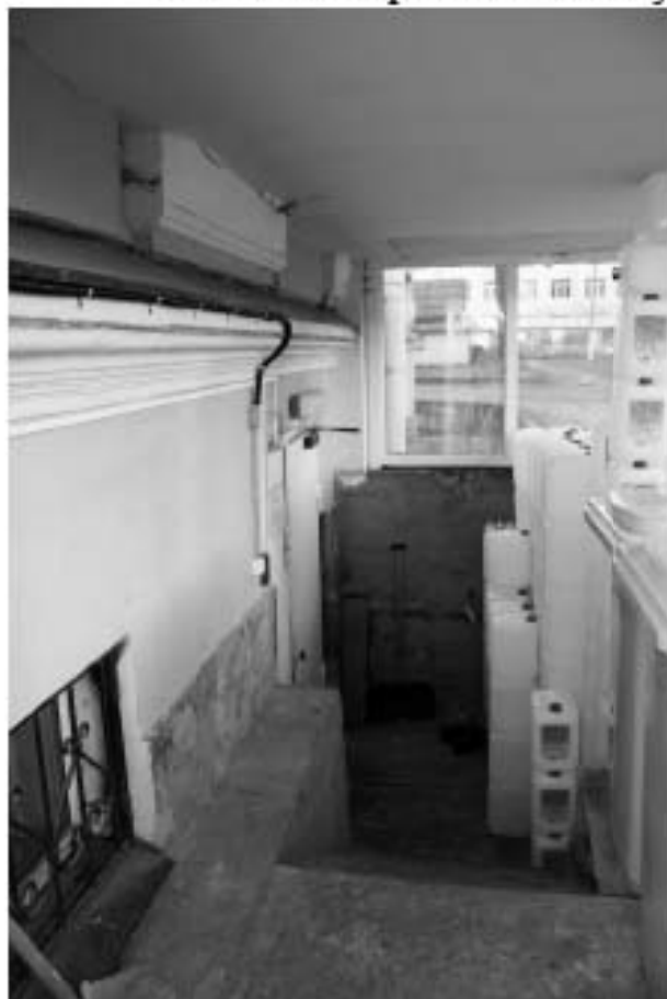
Фото 194. Вход в подвал с юга.
