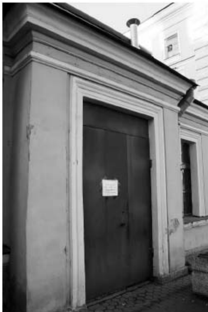
Фото 59. Вход в переходную галерею кухонного корпуса.
