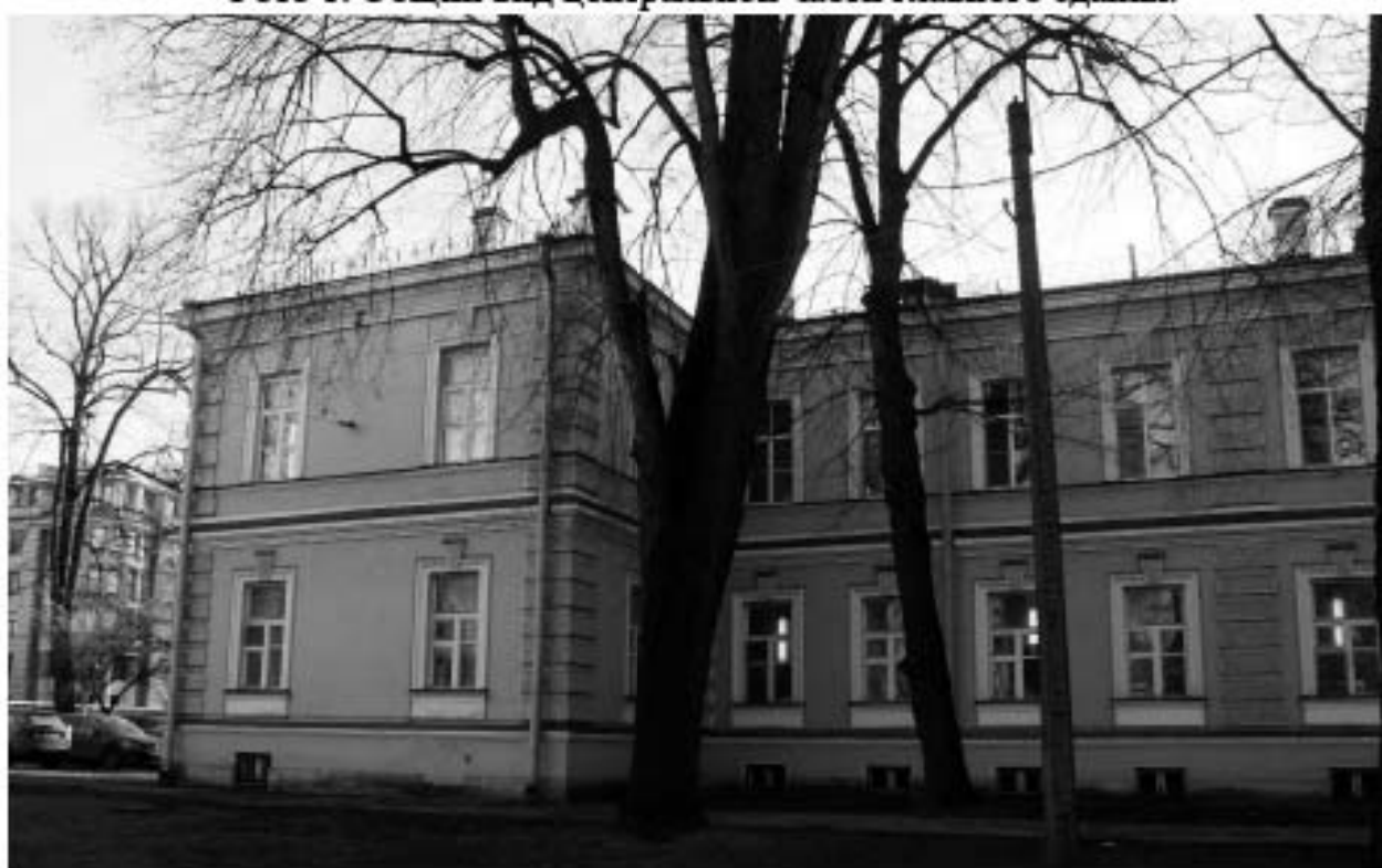
Фото 2. Восточное крыло главного здания. Лицевой фасад.
