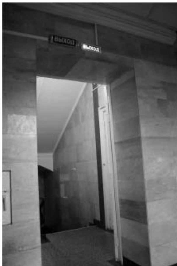
Фото 73. 1 этаж. Вход на лестничную клетку Л-2.
