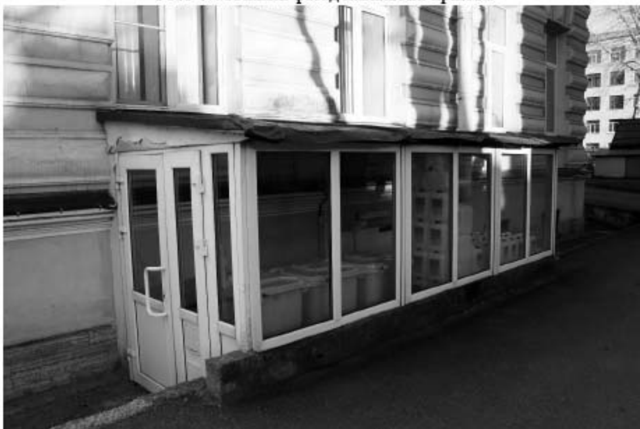
Фото 48. Остекленный приямок южного фасада павильона-приюта.
