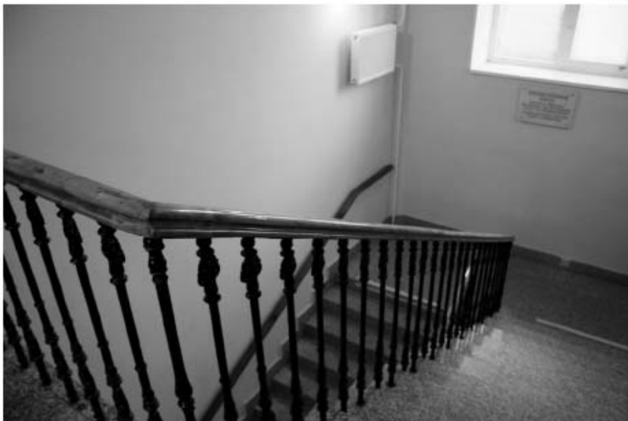
Фото 173. Лестничная клетка Л-7.
