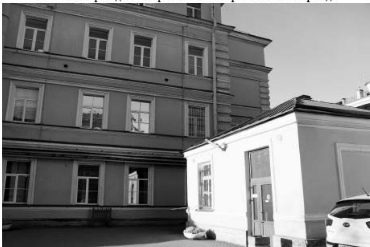
Фото 42. Северная часть восточного фасада кухонного корпуса и входная пристройки.
