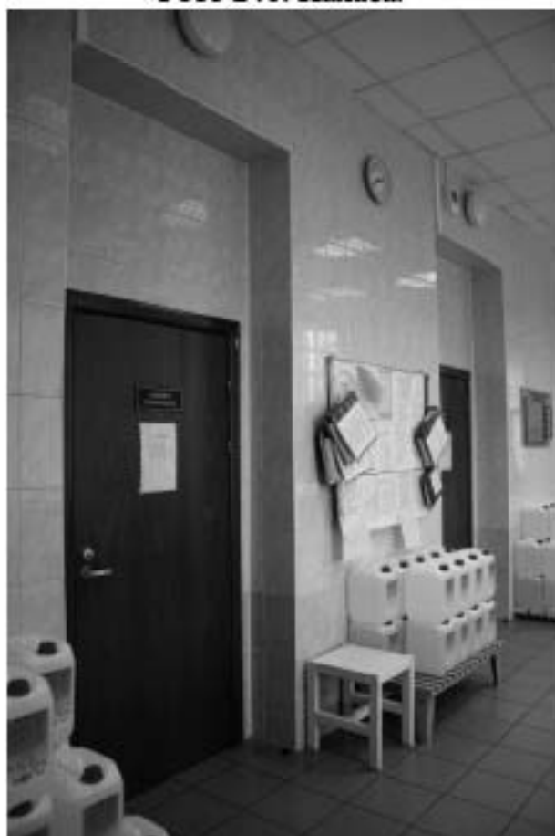
Фото 242. Дверные проемы в нишах.
