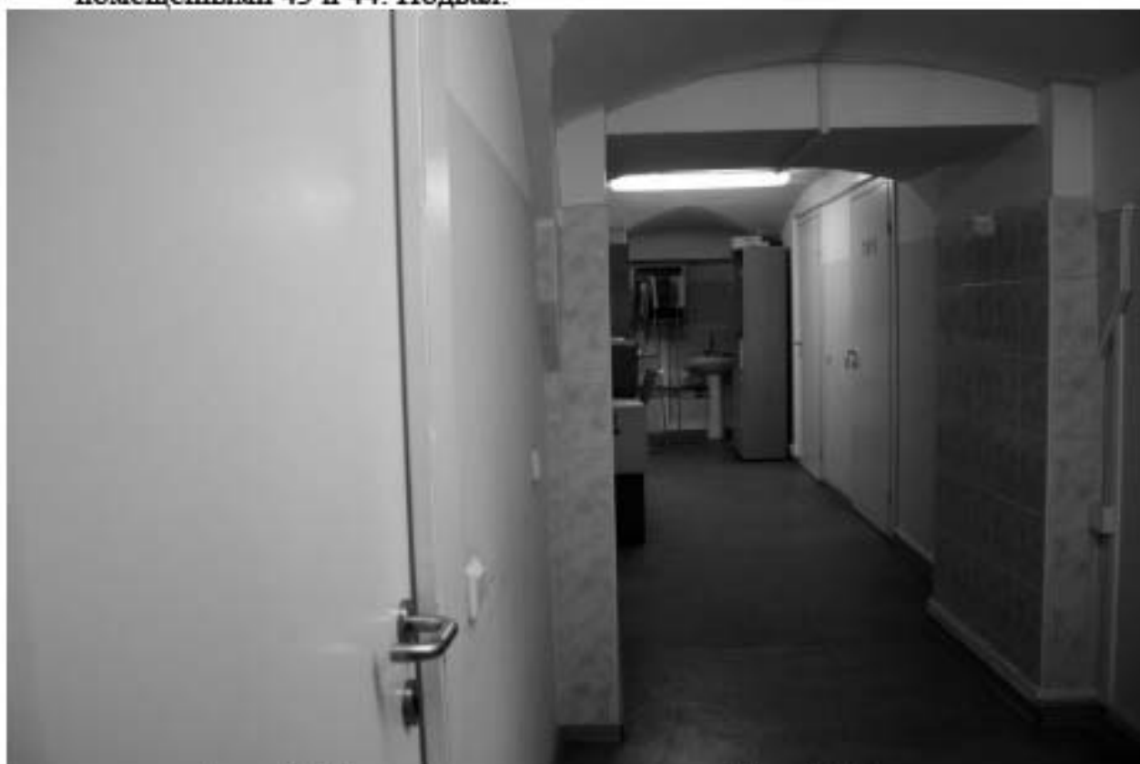
Фото 72. Проем между помещениями 43 и 44. Подвал.
