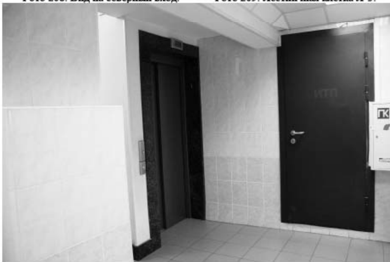
Фото 210. Лифтовой холл и проем в ИТП.
