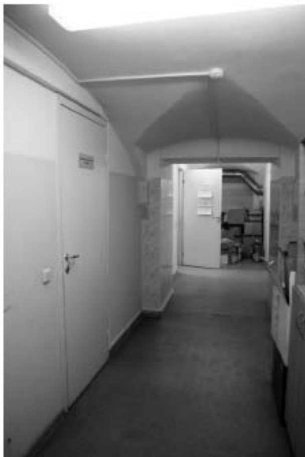
Фото 68. Вид на коридоры в помещениях 43 и 44. Подвал.
