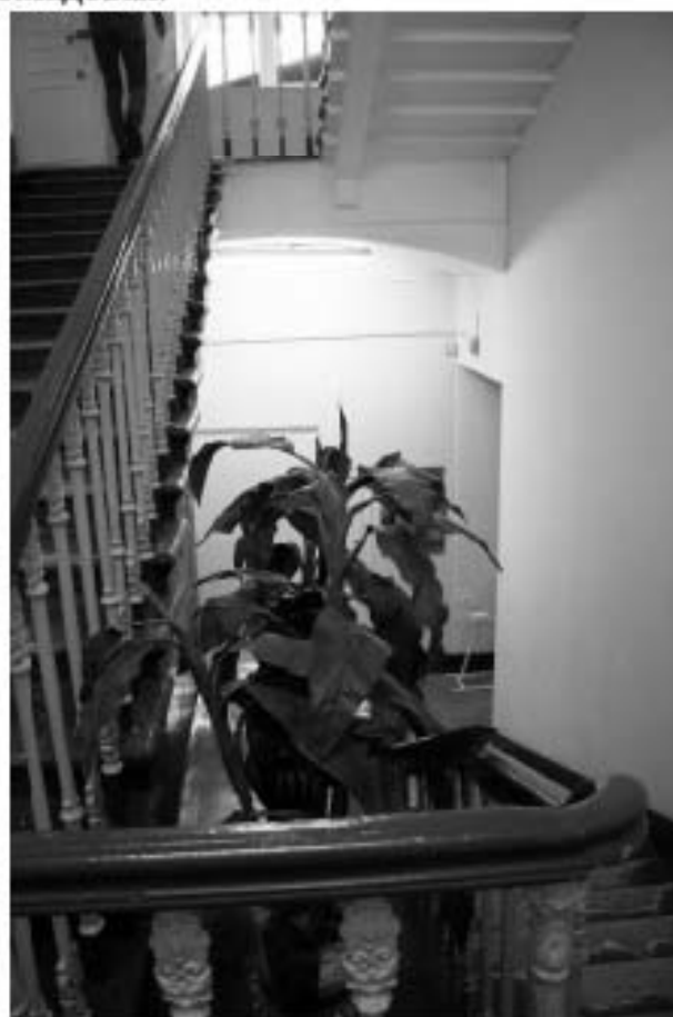
Фото 107. Лестничная клетка кухонного корпуса.
