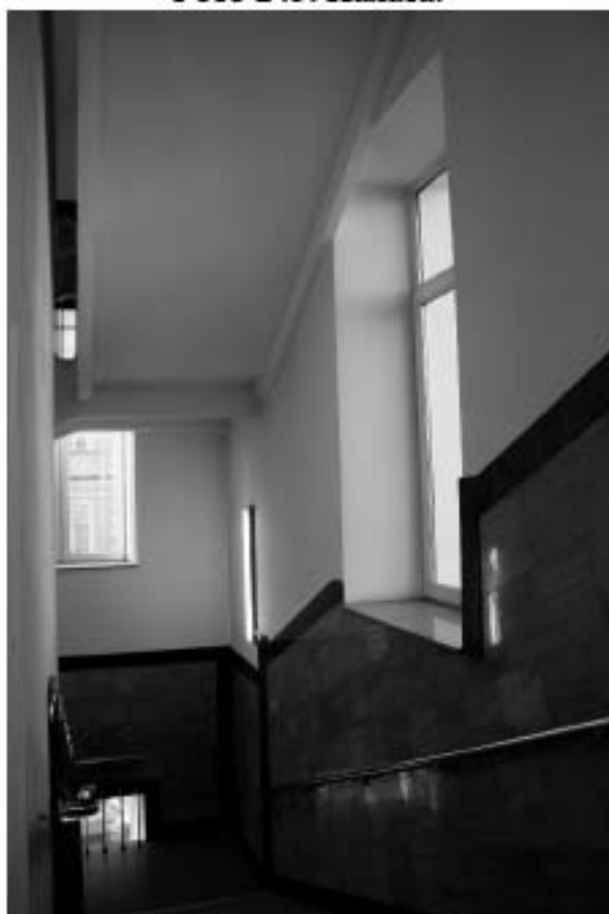
Фото 247. Лестничная клетка Л-3.
