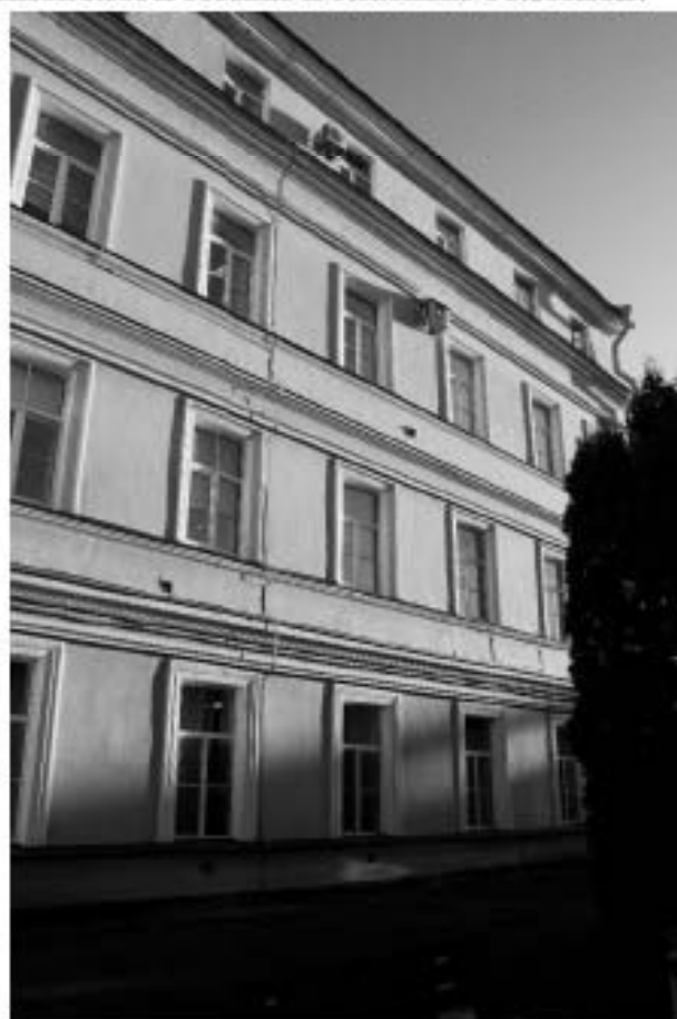
Фото 31. Общий вид кухонного корпуса.
