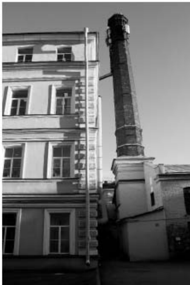
Фото 33. Место примыкания кухонного корпуса и котельной.
