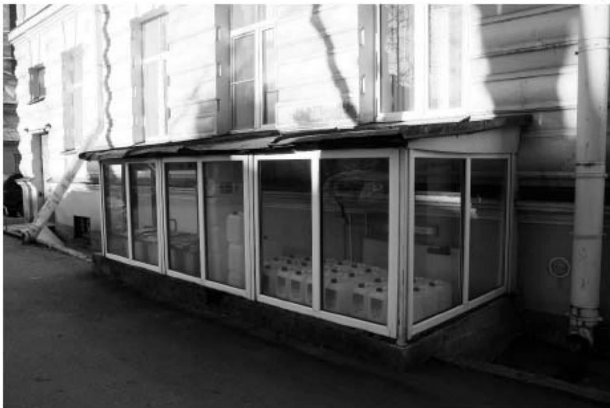
Фото 49. Остекленный приямок южного фасада павильона-приюта.
