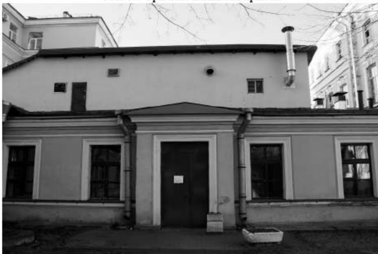
Фото 58. Переходная галерея кухонного корпуса.
