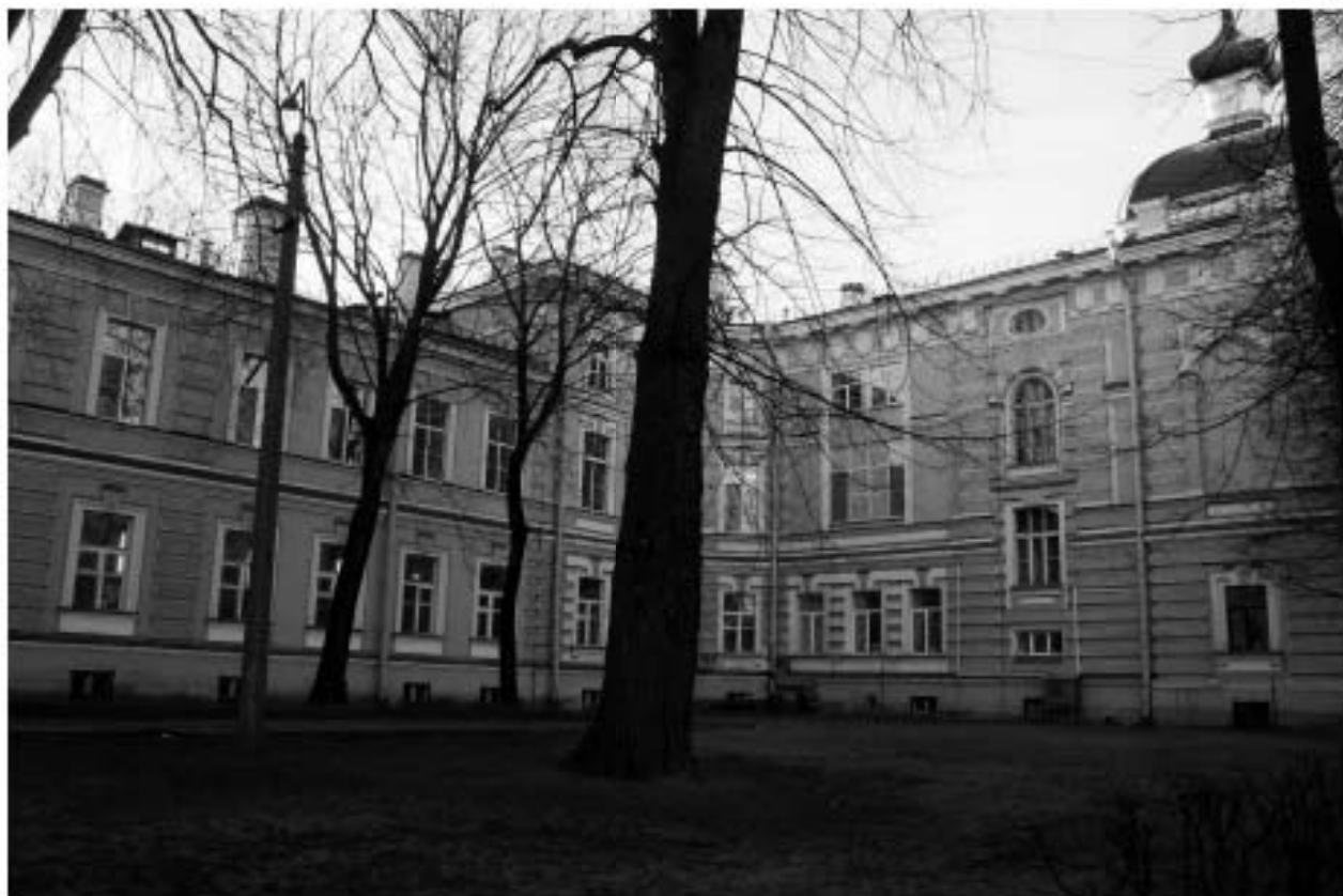
Фото 3. Северо-восточная часть главного здания. Лицевой фасад.
