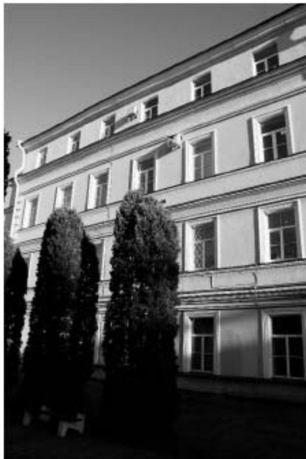
Фото 32. Общий вид кухонного корпуса.
