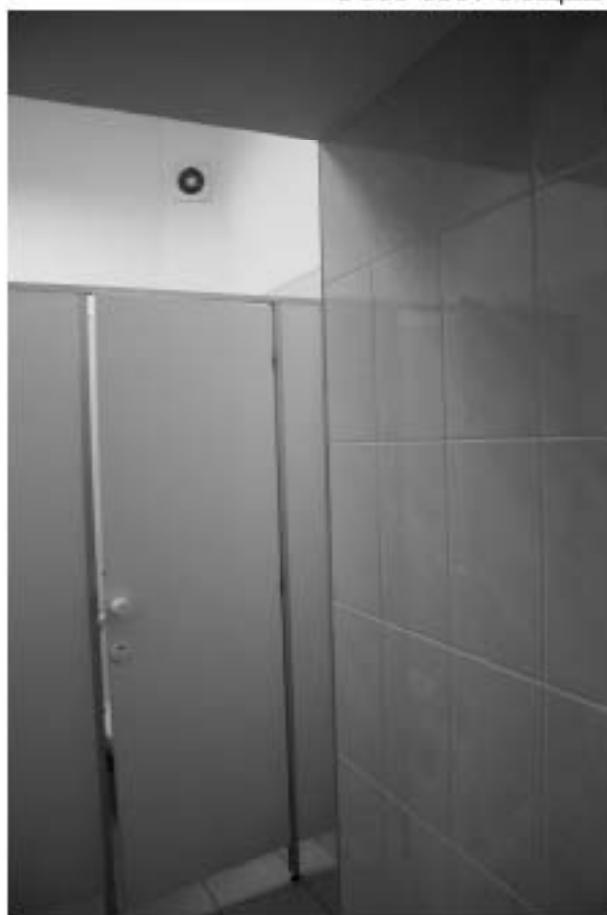
Фото 156. Общий вид санузлов.
