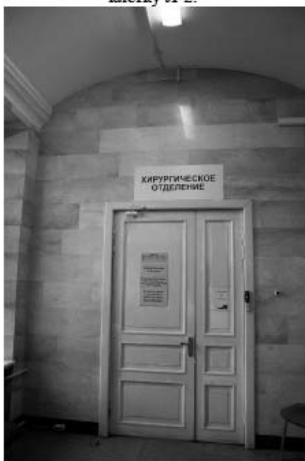
Фото 75. Проем с дверным заполнением в восточное крыло.
