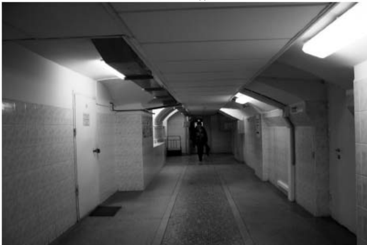
Фото 65. Коридор. Центральная часть подвала.
