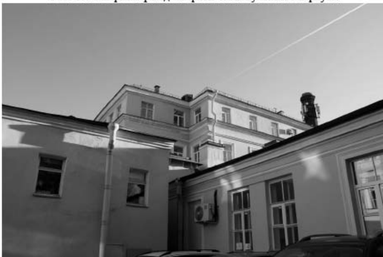
Фото 20. Общий вид дворовых корпусов с северо-запада.
