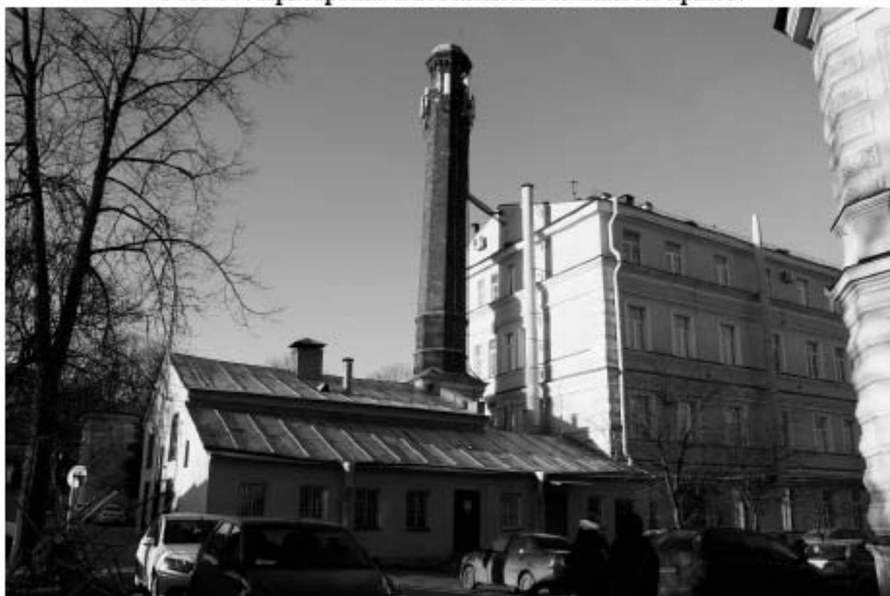
Фото 36. Общий вид на котельную и кухонный корпус с юго-востока.
