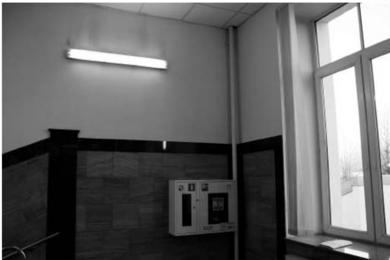
Фото 248. Лестничная клетка (мансарда).
