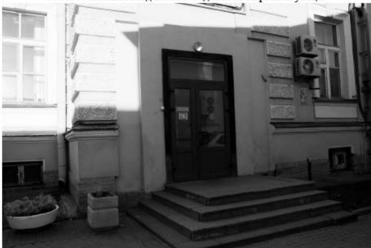
Фото 8. Крыльцо у лестничной клетки Л-8.
