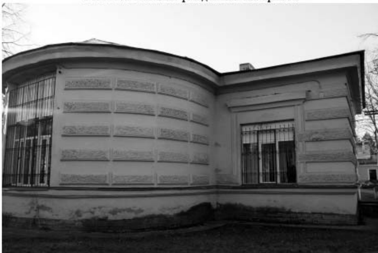
Фото 54. Северная часть восточного фасада операционного павильона.
