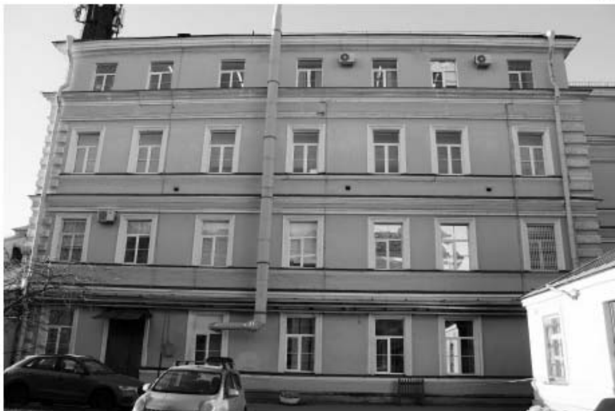
Фото 43. Общий вид кухонного корпуса.
