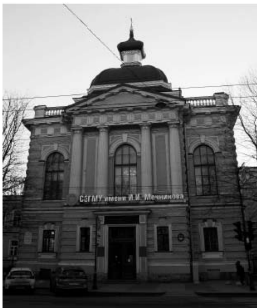
Фото 1. Общий вид центральной части главного здания.
