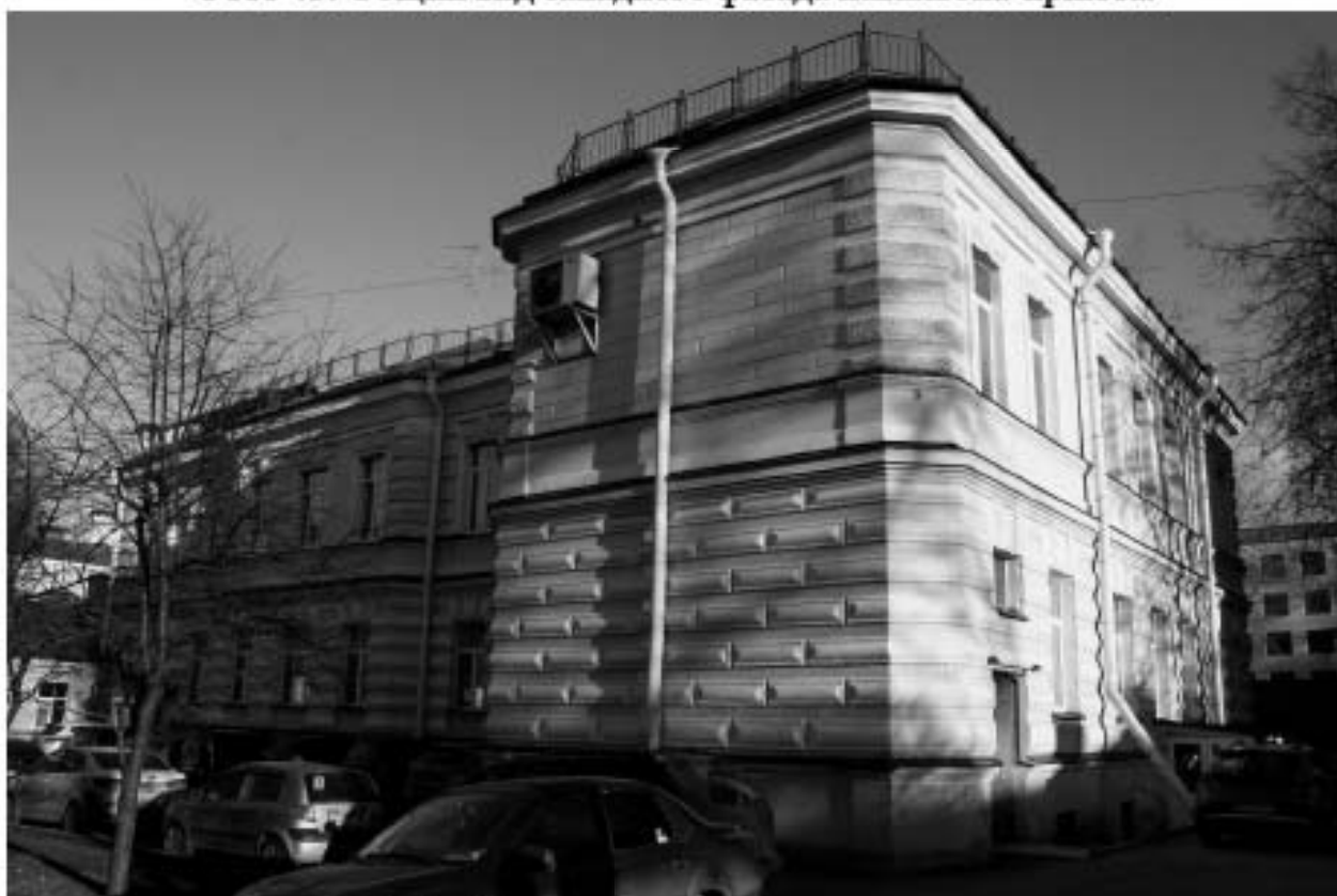
Фото 46. Общий вид павильона-приюта с юго-запада.
