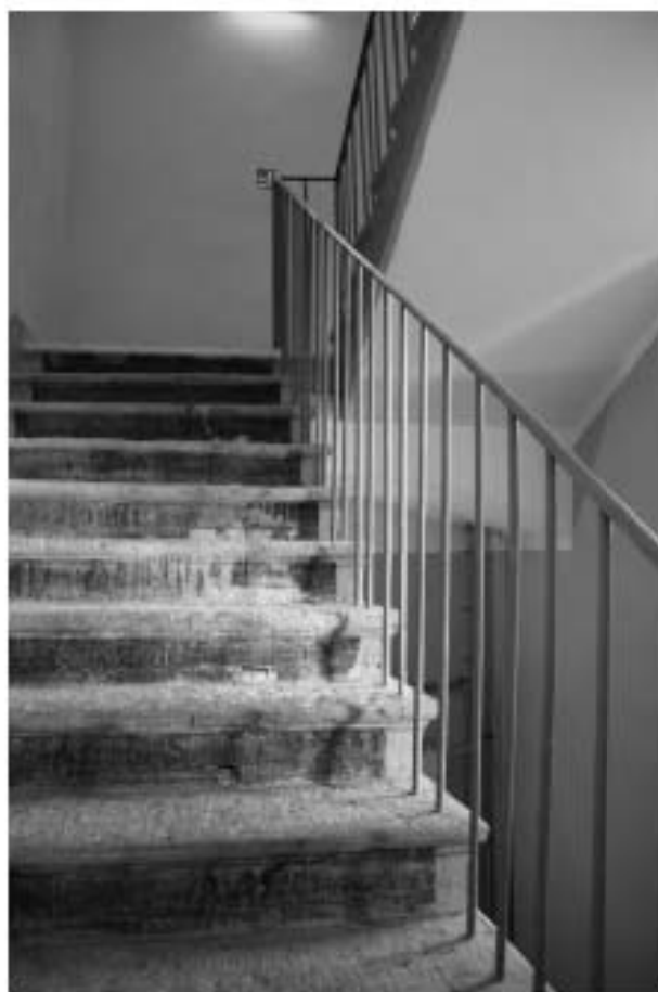
Фото 117. Лестничная клетка Л-5.
