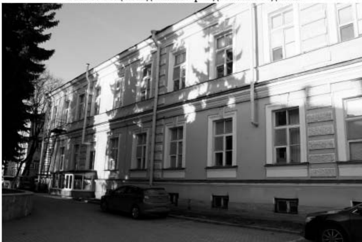
Фото 10. Южный фасад западного крыла главного здания.
