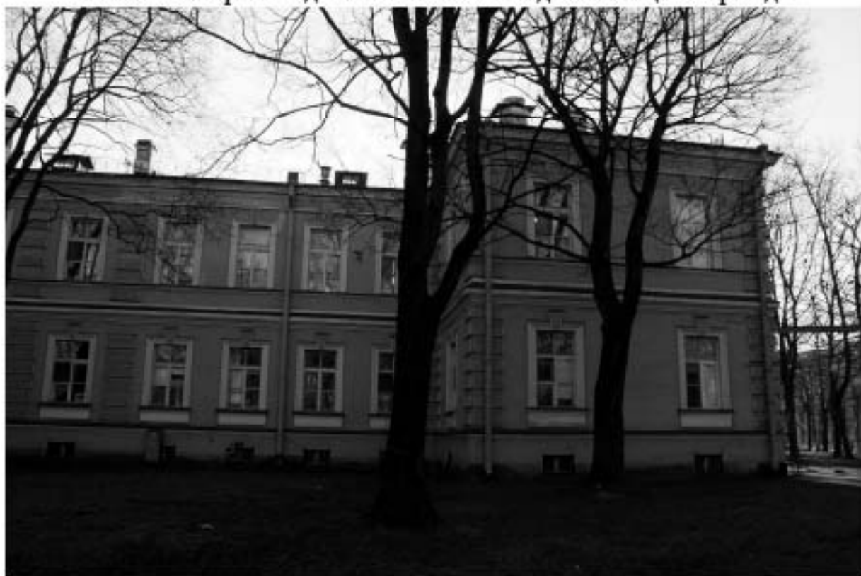
Фото 6. Западное крыло главного здания. Лицевой фасад.
