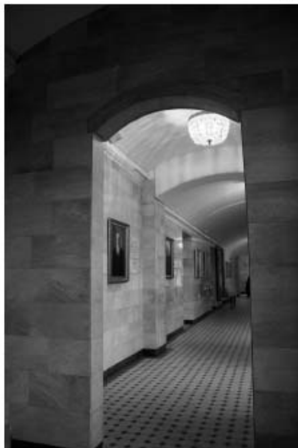
Фото 74. Проем в центральный холл.
