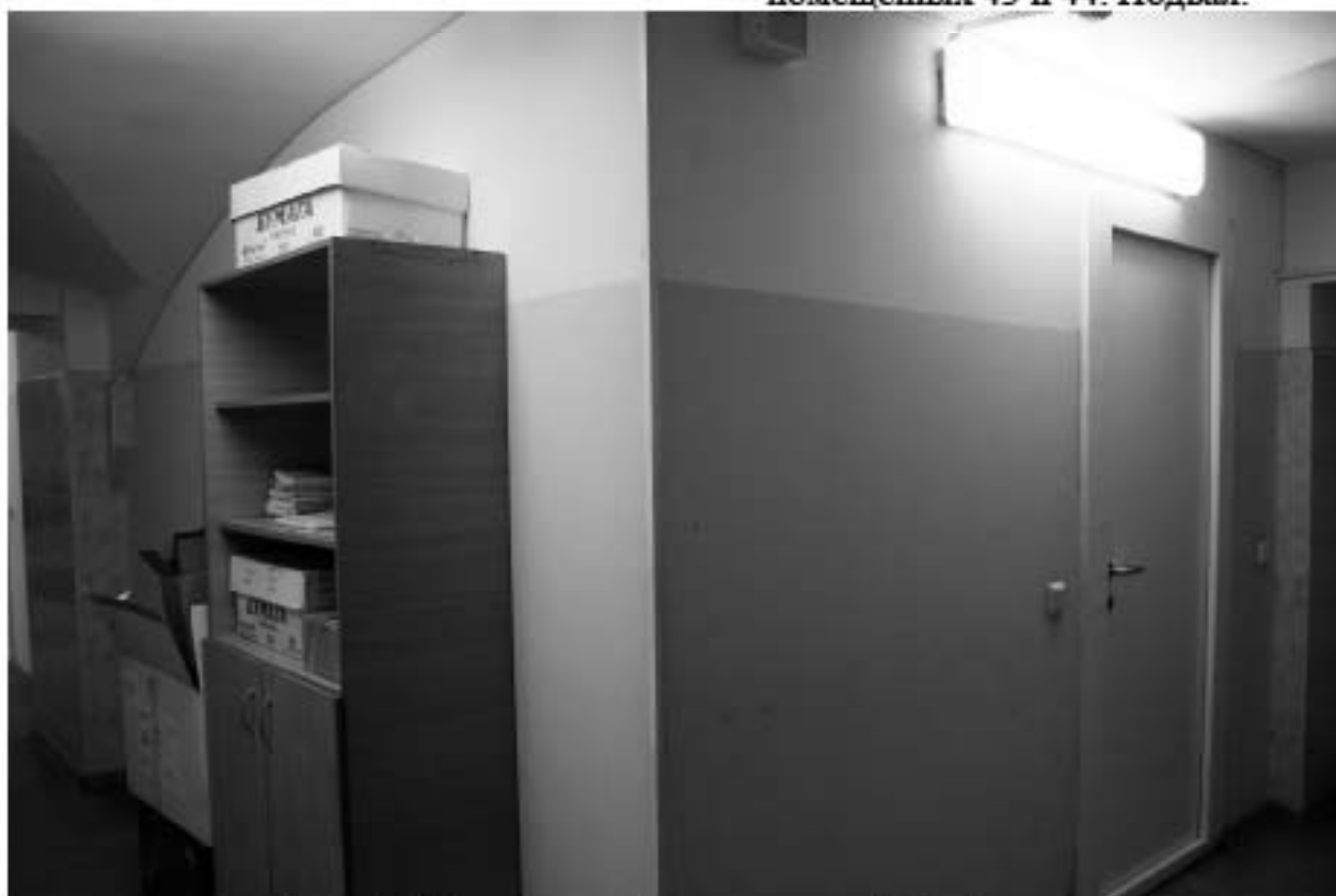
Фото 69. Перегородки в помещении 43. Подвал.
