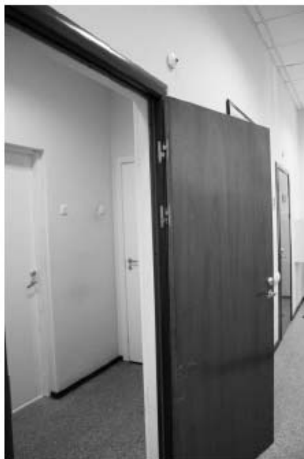
Фото 232. Перегородки и дверные проемы.
