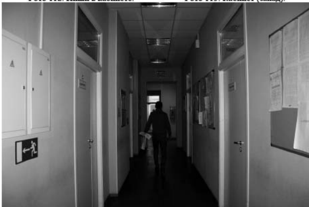
Фото 114. Общий вид коридора 3-го этажа.
