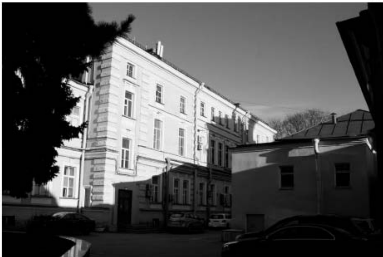
Фото 15. Общий вид дворовой части комплекса.
