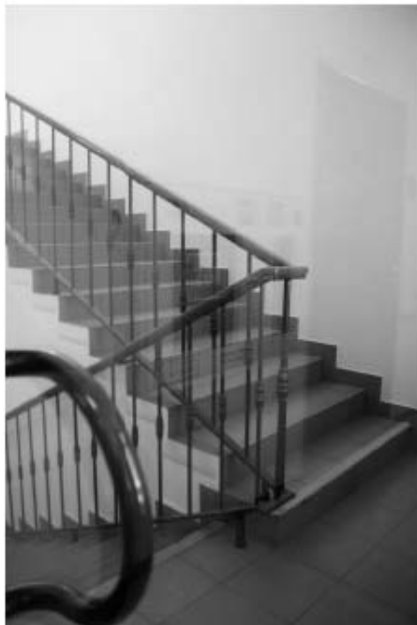
Фото 233. Лестничная клетка Л-4.
