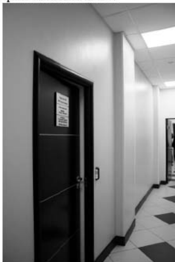
Фото 177. Дверной проем в корндоре.
