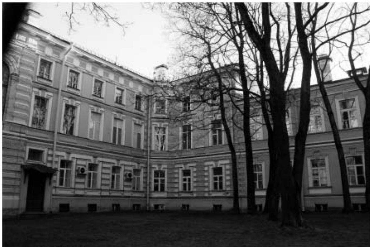
Фото 5. Северо-западная часть главного здания. Лицевой фасад.
