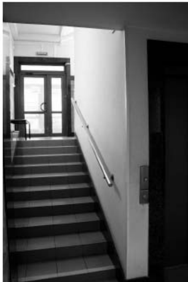
Фото 209. Лестничная клетка Л-3.
