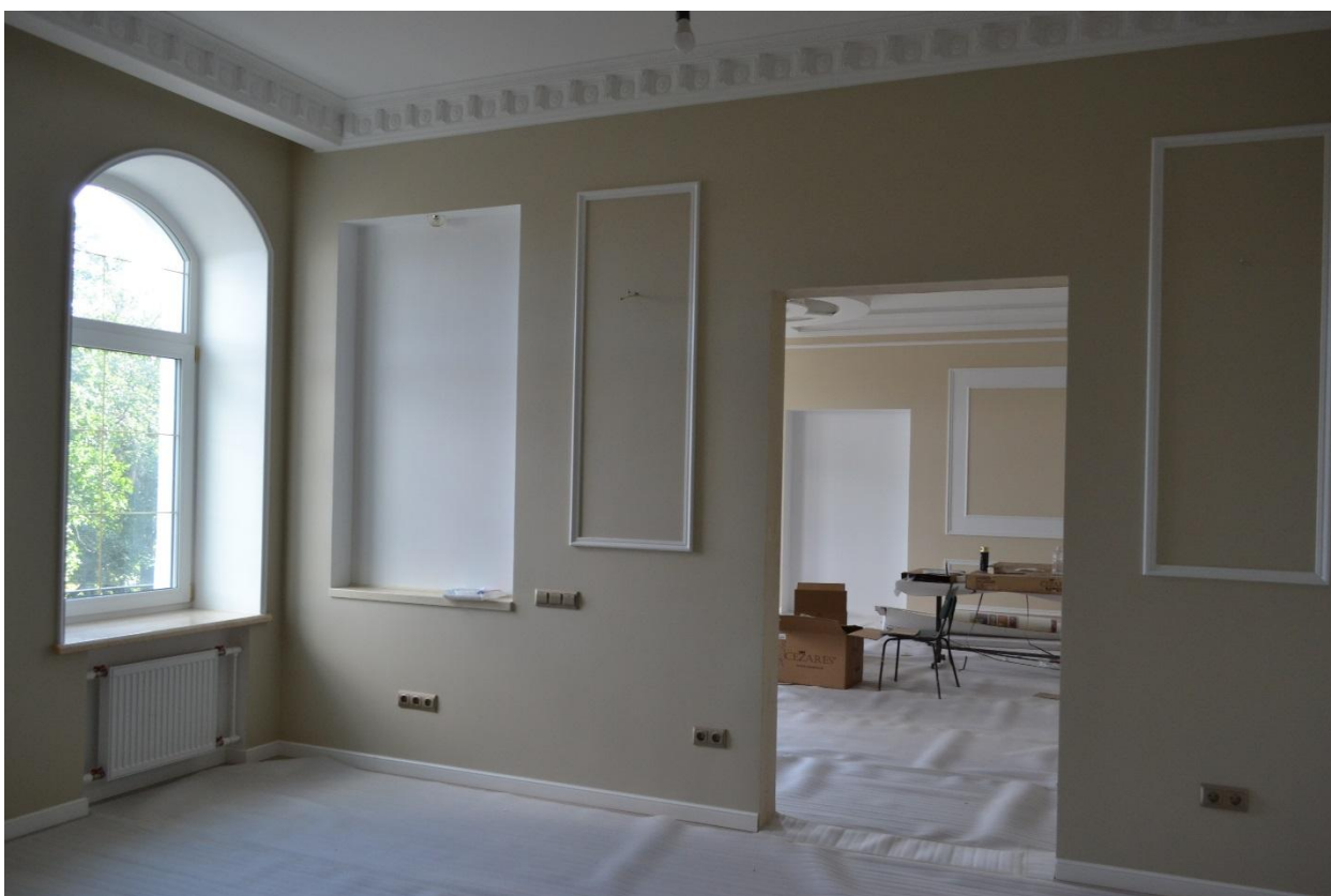
Фото 12. Помещения №3. Кабинет. Вид в помещение №2.
