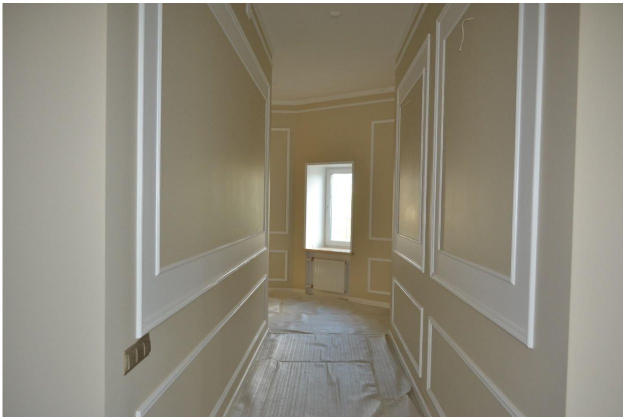
Фото 17. Помещение №7. Коридор. Общий вид.
