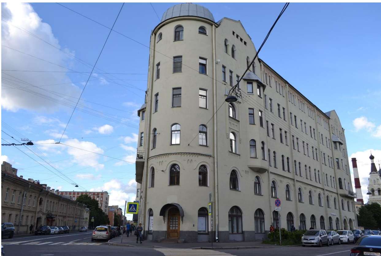
Фото 2. Фасад по Старорусской улице. Вид с юго-запада.
