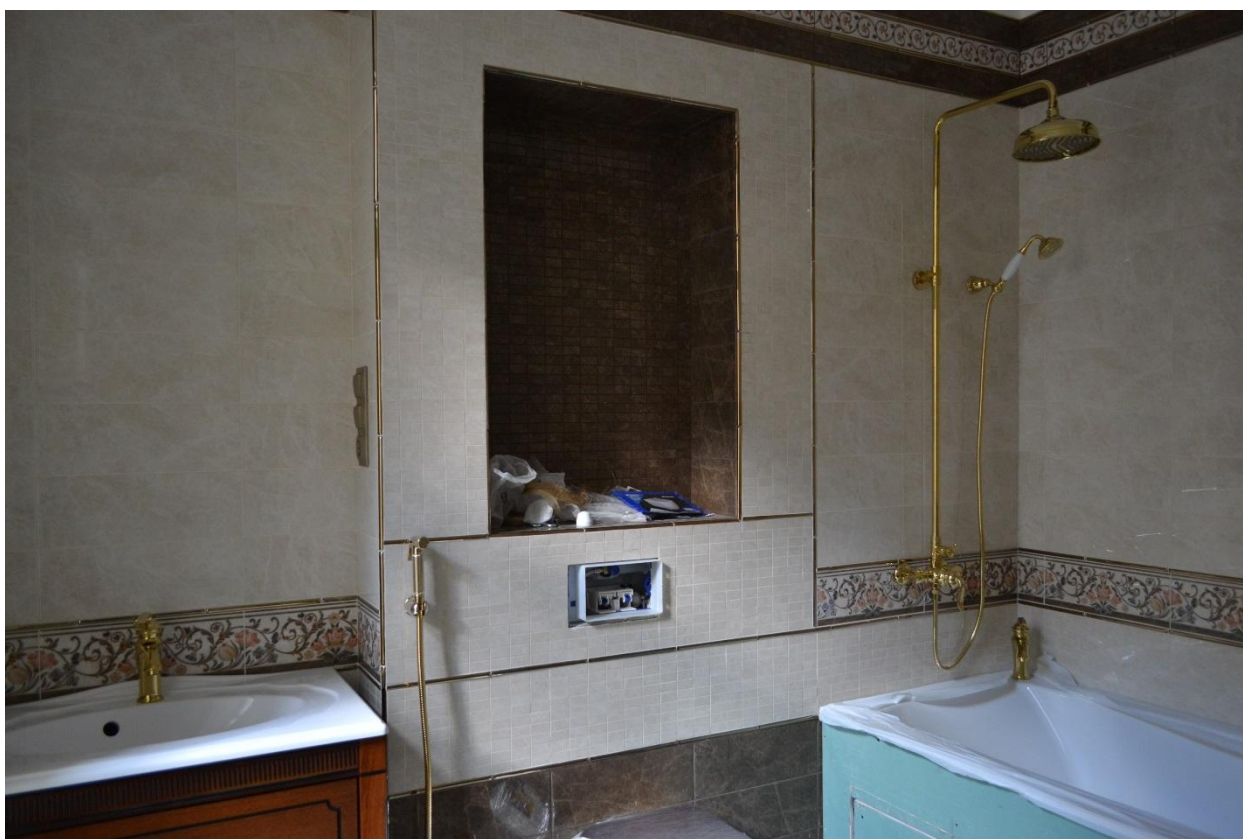
Фото 22. Помещение №12. Совмещенный санузел. Общий вид.
