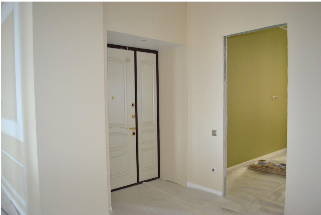
Фото 5. Общий вид помещения №1. Холл.
