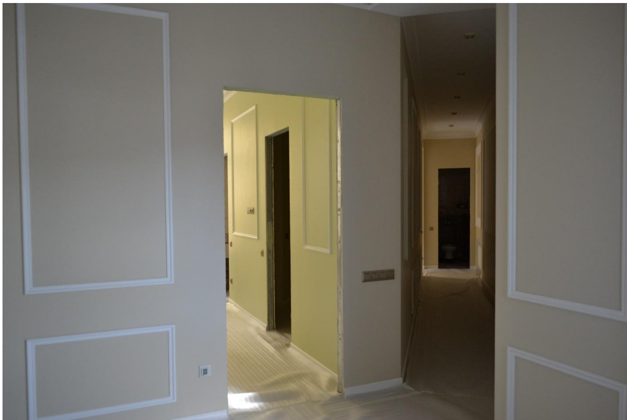
Фото 19. Помещение №7. Коридор. Общий вид в сторону помещения №9.
