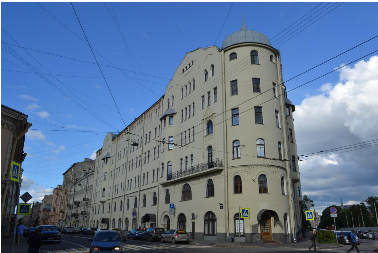
Фото 1. Фасад по Мытнинской улице. Вид с юго-запада.
