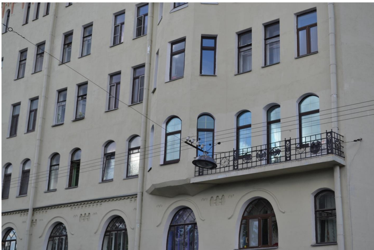
Фото 3. Фрагмент фасада по Старорусской улице. Вид с юго-востока.
