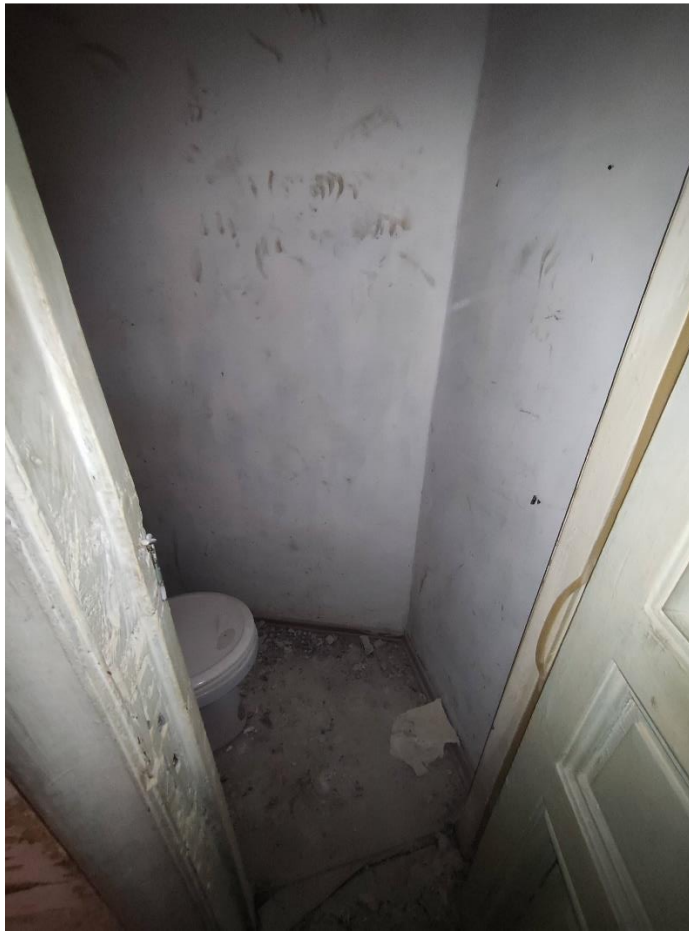
Фото 25. Общий вид пом. № 55(15).
