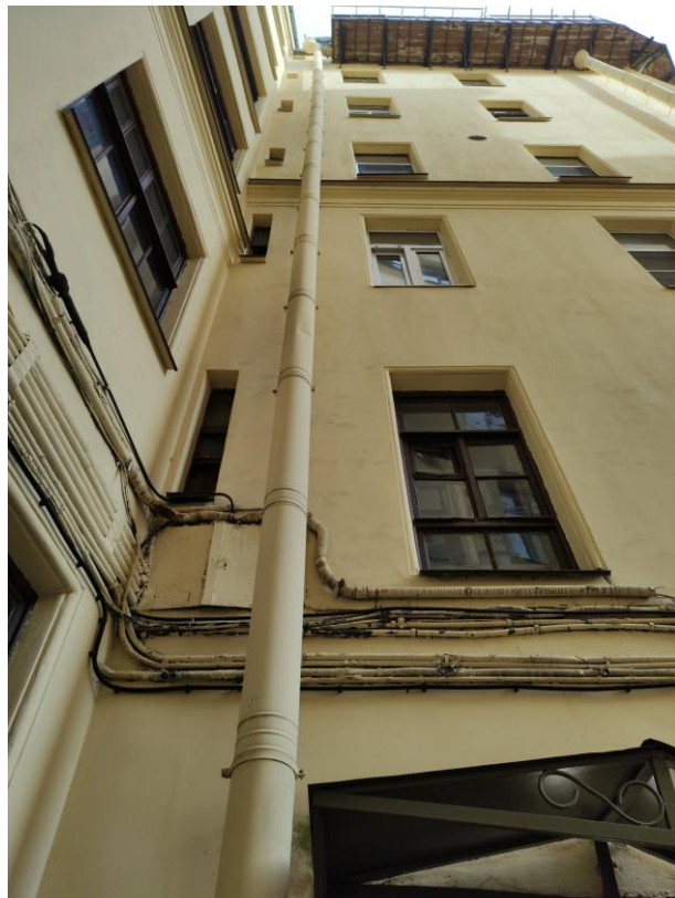
Фото 6. Фрагмент дворового фасада выявленного объекта культурного наследия «Дом Первого Российского Страхового общества». Рассматриваемая квартира № 55 расположена на втором этаже.
