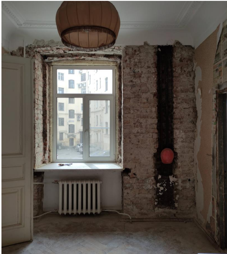
Фото 13. Общий вид пом. № 55(5). Оконный проем во внутренний двор, современное металлопластиковое оконное заполнение.
