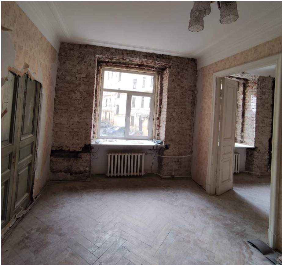
Фото 11. Общий вид пом. № 55(4). Оконный проем во внутренний двор, современное металлопластиковое оконное заполнение.
