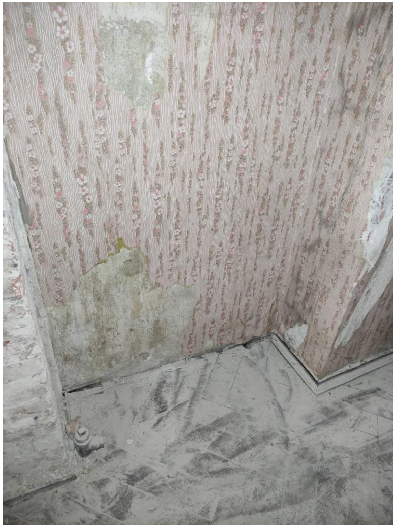
Фото 27. Фрагмент пом. № 55(6). Коридор, ниша в стене, смежной с соседней квартирой.
