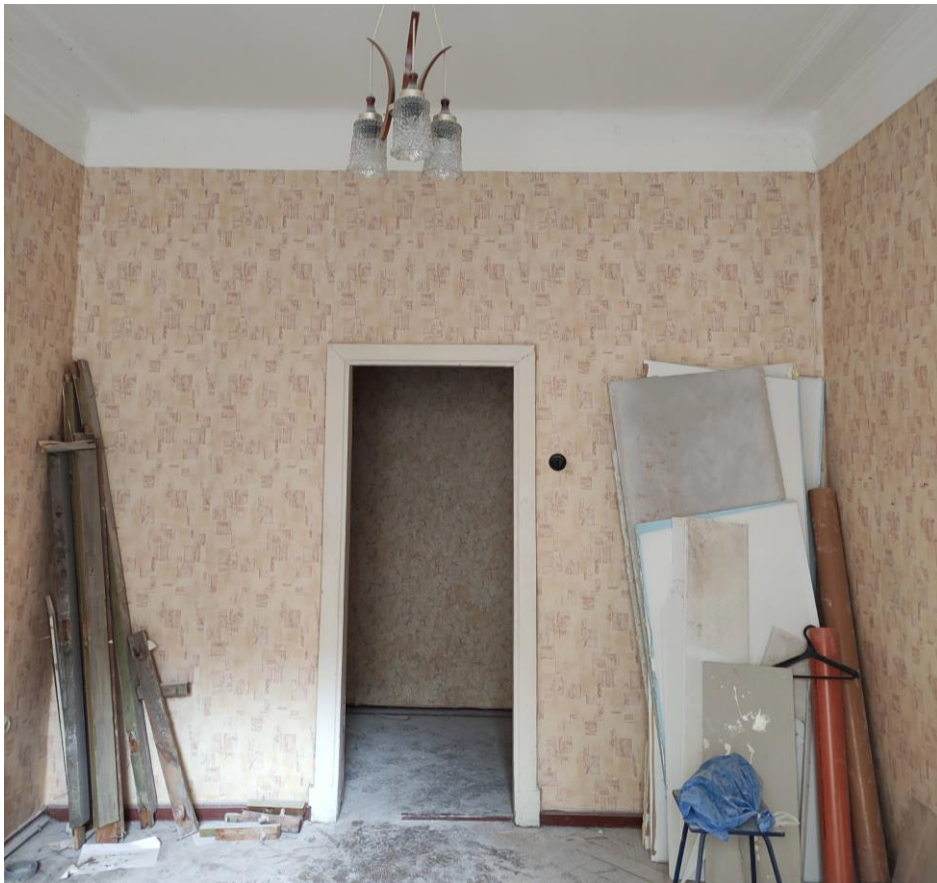
Фото 12. Общий вид пом. № 55(4). Дверной проем в пом. № 55(17).
