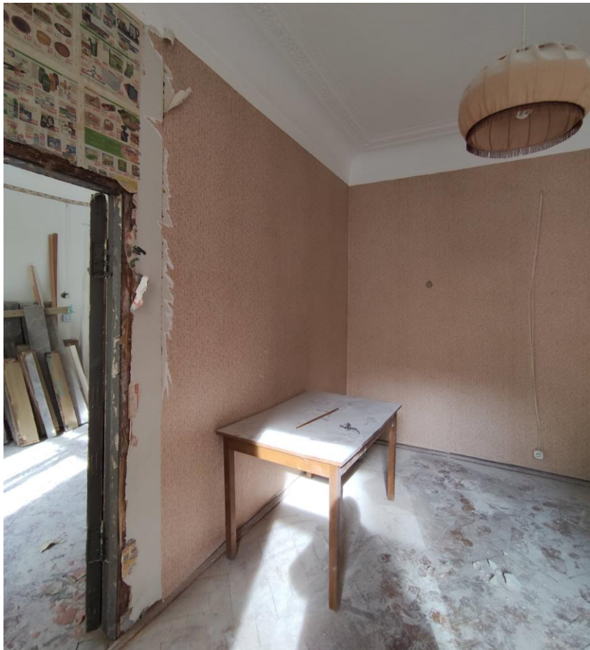
Фото 14. Общий вид пом. № 55(5). Дверной проем в пом. № 55(8).
