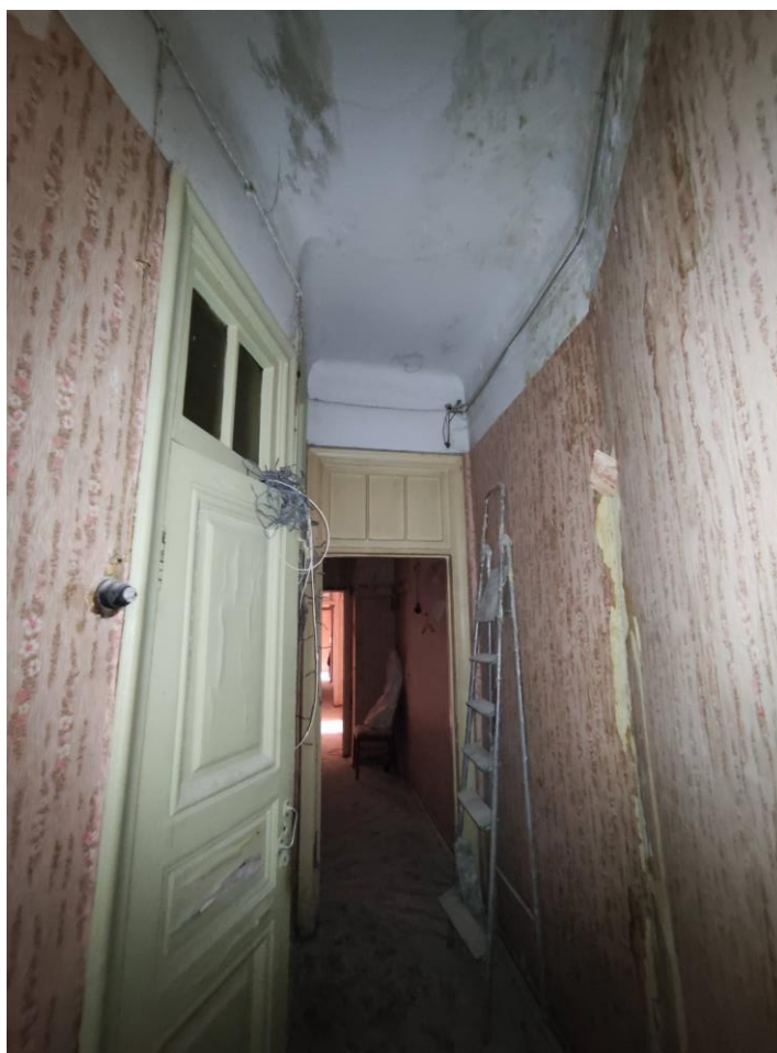
Фото 20. Общий вид пом. № 55(2,6,17,18). Коридор, вид в сторону входа с парадной лестницы.
