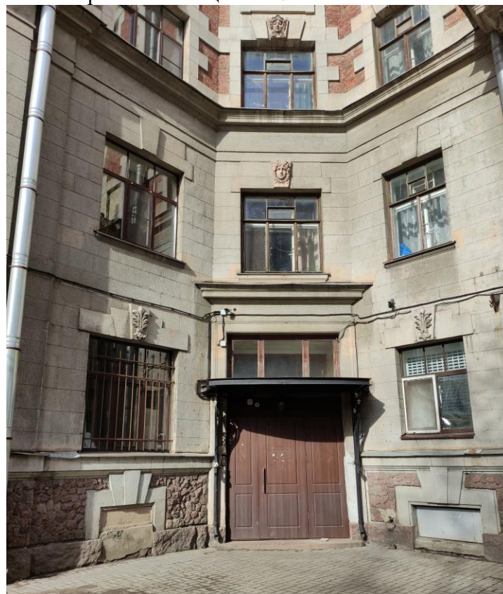
Фото 2. Фрагмент лицевого фасада курдонера выявленного объекта культурного наследия «Дом Первого Российского Страхового общества». Дверной проем в подъезд со стороны курдонера.
