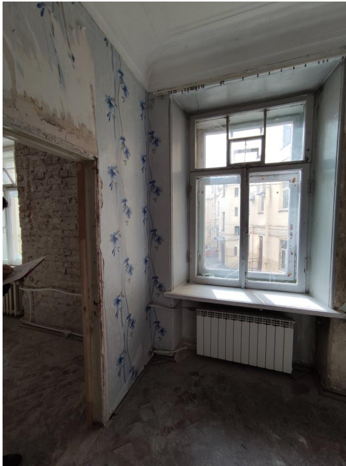
Фото 17. Общий вид пом. № 55(9). Оконный проем во внутренний двор, оконное заполнение с исторической расстекловкой.
