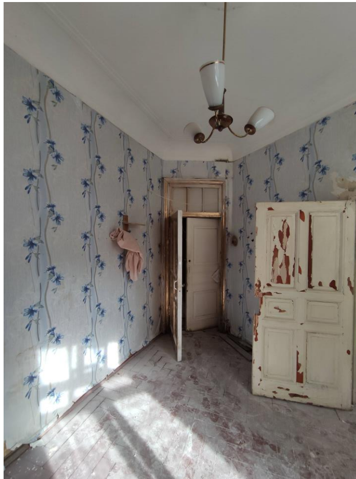
Фото 18. Общий вид пом. № 55(9). Дверной проем в пом. № 55(7).
