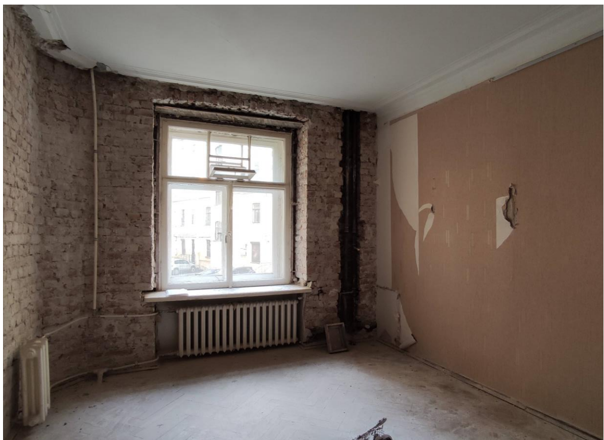
Фото 10. Общий вид пом. № 55(3). Оконный проем во внутренний двор, оконное заполнение с исторической расстекловкой.
