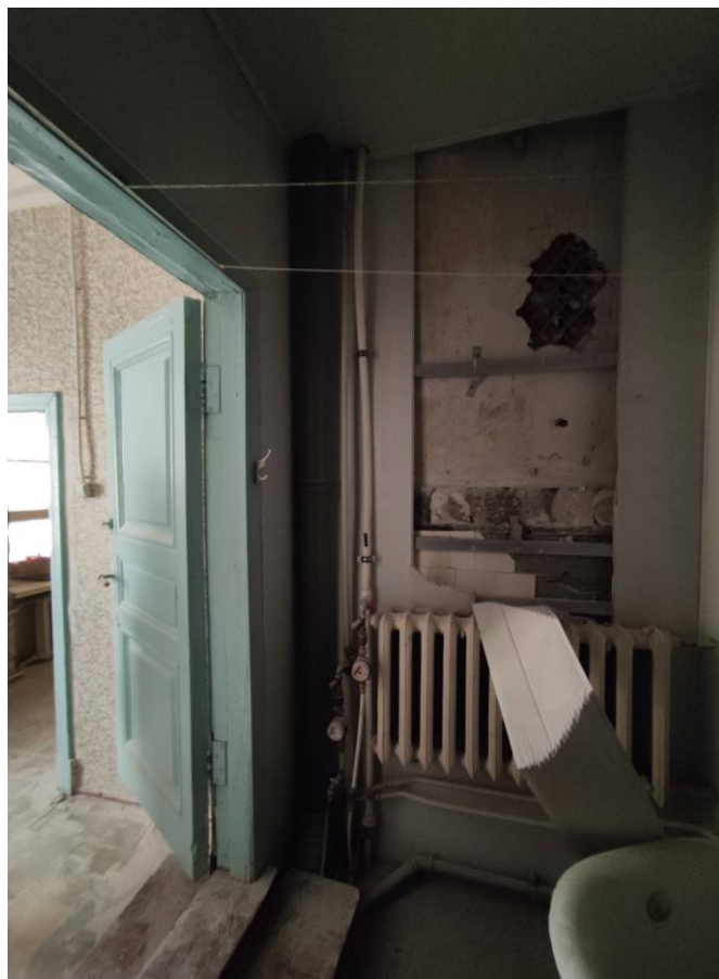
Фото 24. Общий вид пом. № 55(13). Дверной проем в пом. № 55(10).
