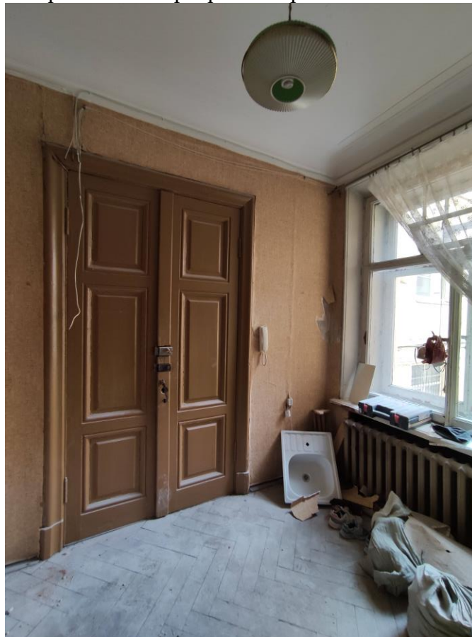
Фото 8. Общий вид пом. № 55(1). Дверной проем на парадную лестницу, оконный проем во внутренний двор.
