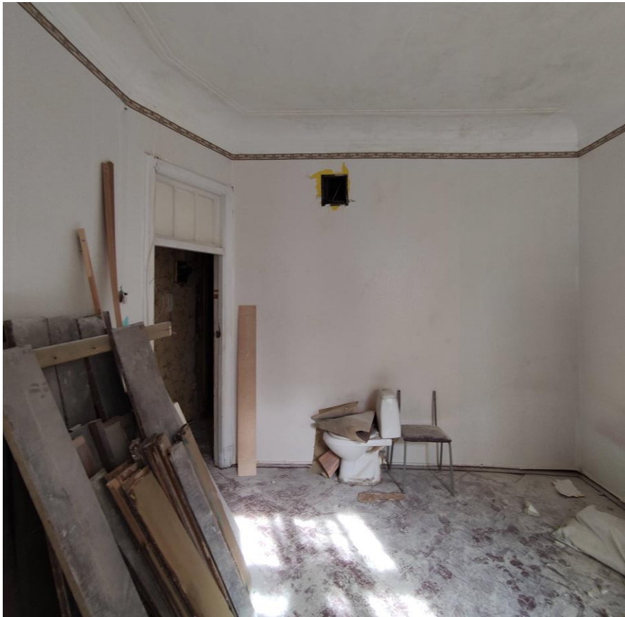
Фото 15. Общий вид пом. № 55(8). Дверной проем в пом. № 55(7).
