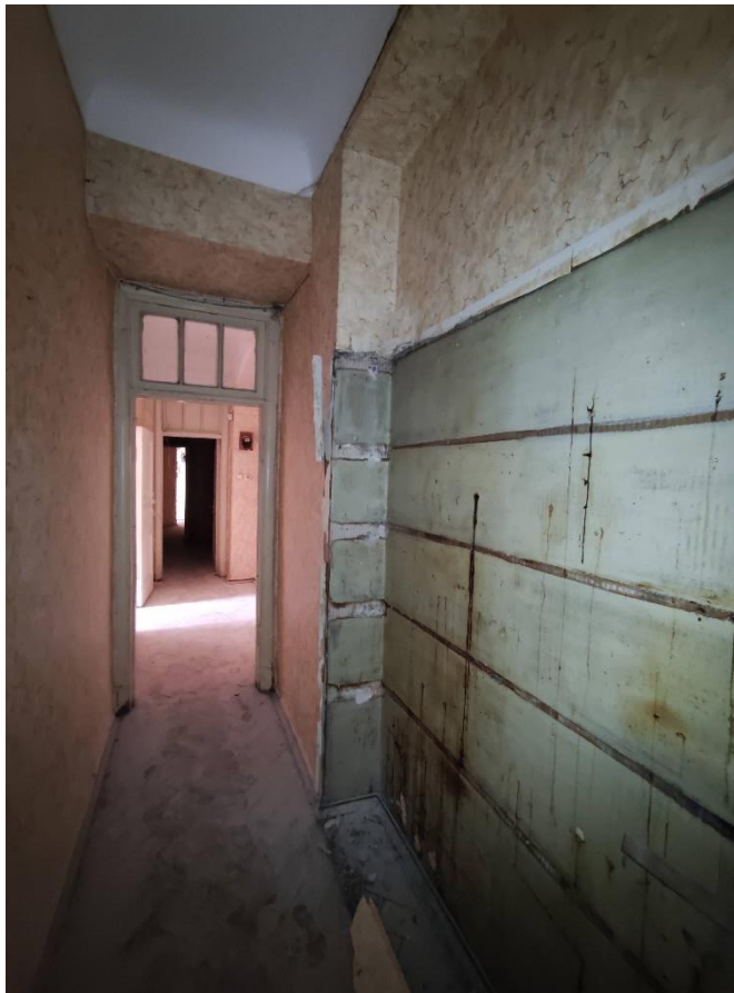
Фото 9. Общий вид пом. № 55(6,17,18). Коридор, справа-ниша в стене, смежной с соседней квартирой.
