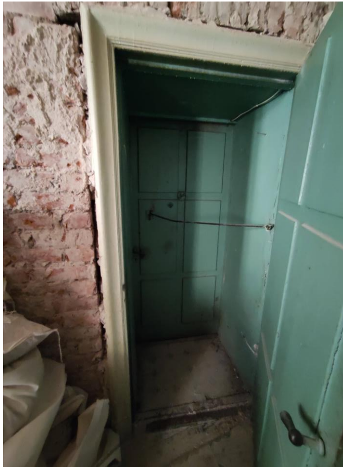
Фото 23. Фрагмент пом. № 55(11). Дверной проем на черную лестницу.
