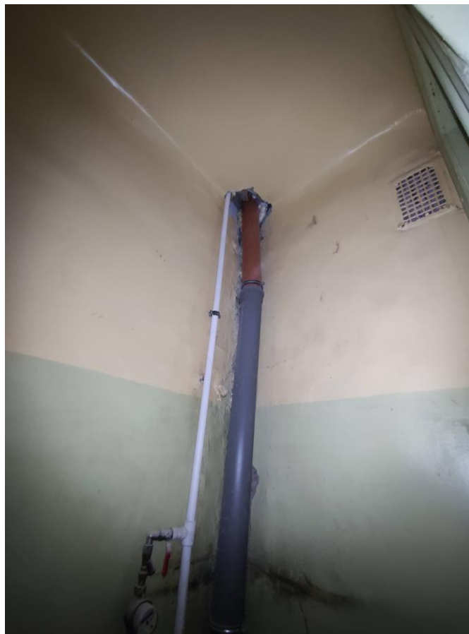
Фото 26. Общий вид пом. № 55(16).
