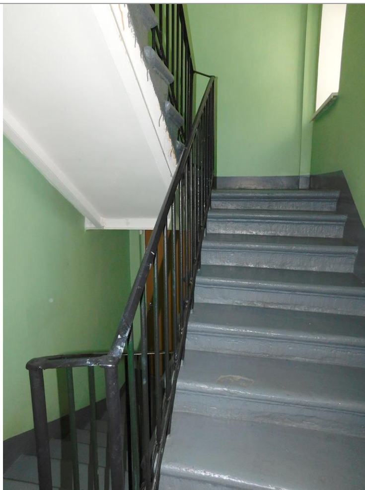
29. Второй марш лестницы западного входа. Фото М. И. Мильчика, 02.02.2018
