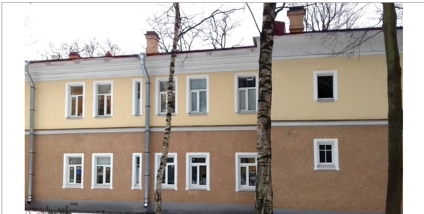
13. Северо-восточный фасад особняка. Фото М. И. Мильчика, 02.02.2018
