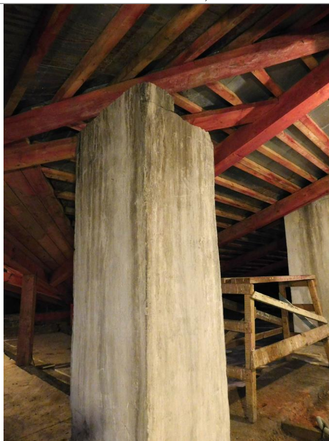
54. Чердак. Одиночная печная труба в центральной части особняка. Фото М. И. Мильчика, 02.02.2018
