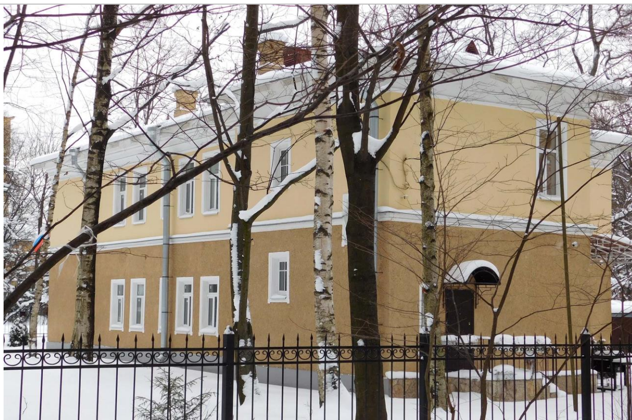
10. Северный фасад особняка. Фото М. И. Мильчика, 02.02.2018
