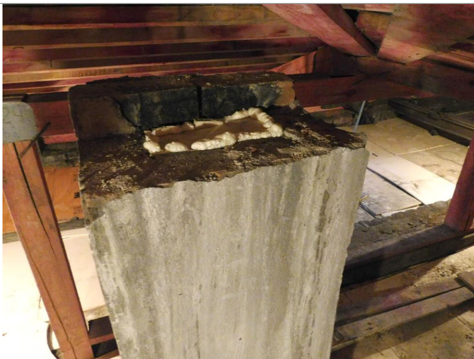
55. Чердак. Одиночная печная труба в центральной части особняка. Вид сверху Фото М. И. Мильчика, 02.02.2018
