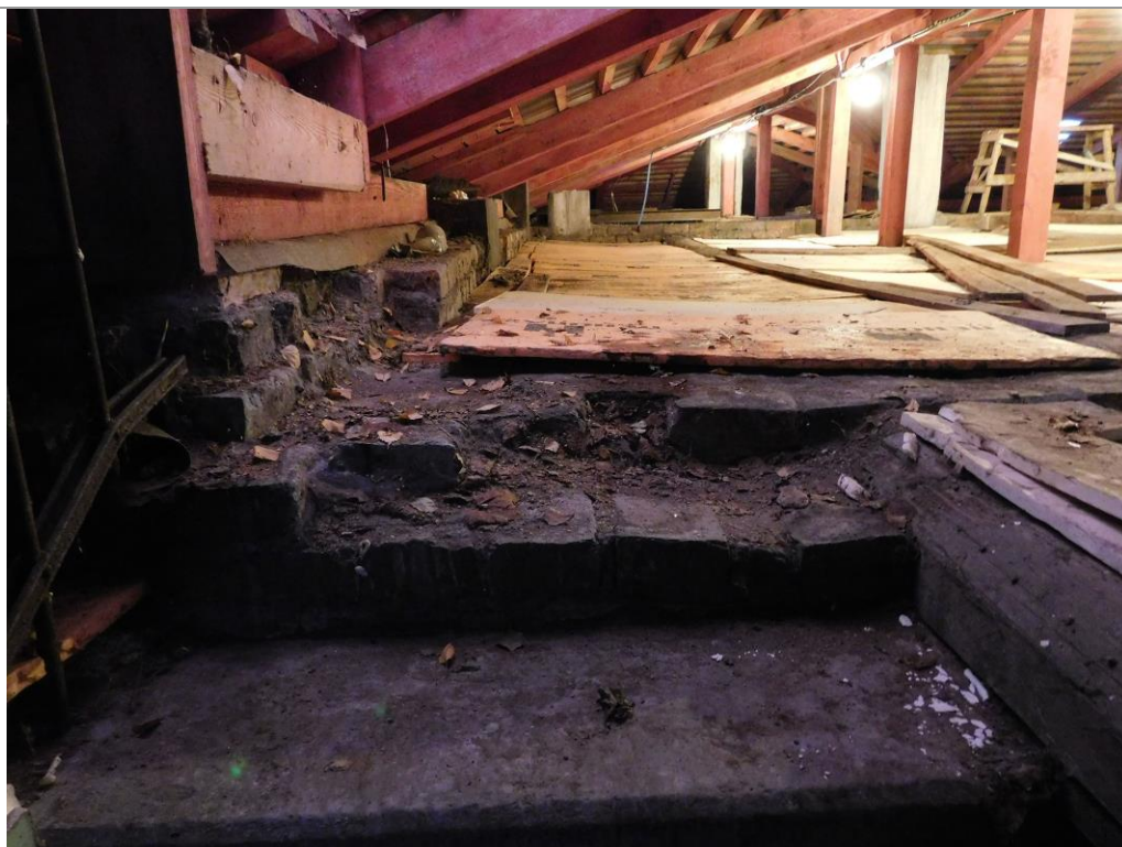
49. Конец верхнего марша на чердаке лестницы западного входа. Фото М. И. Мильчика, 02.02.2018
