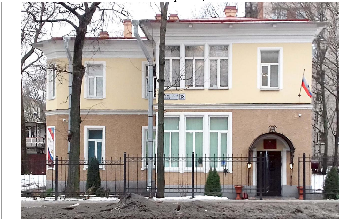
1. Фасад здания со стороны Институтского пр. Фото М. И. Мильчика, 02.02.2018
