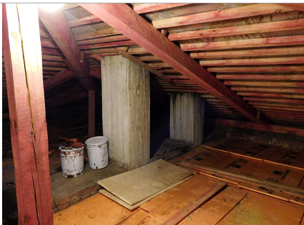
52. Чердак. Печные трубы в южной части особняка. Фото М. И. Мильчика, 02.02.2018
