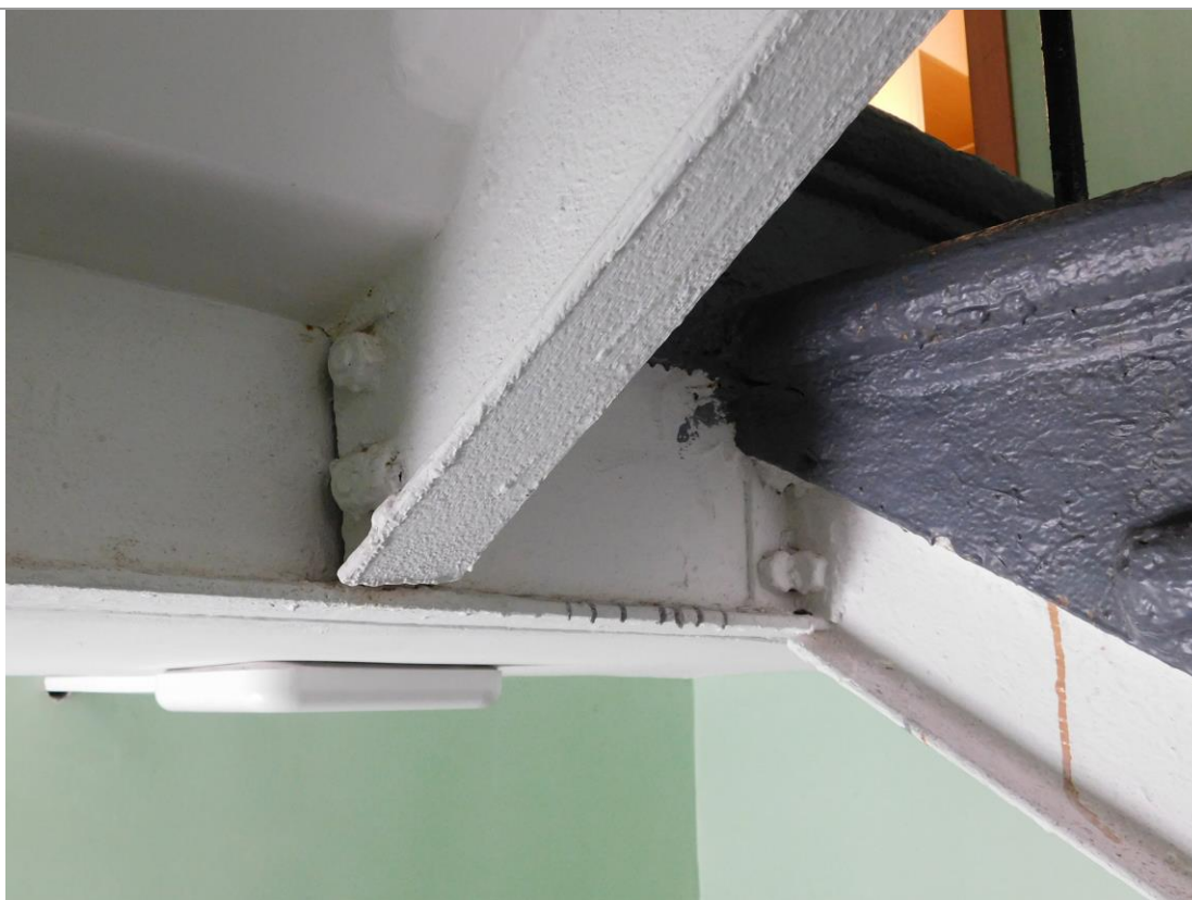
48. Элементы конструкции исторической лестницы западного входа. Под площадкой второго этажа. Фото М. И. Мильчика, 02.02.2018
