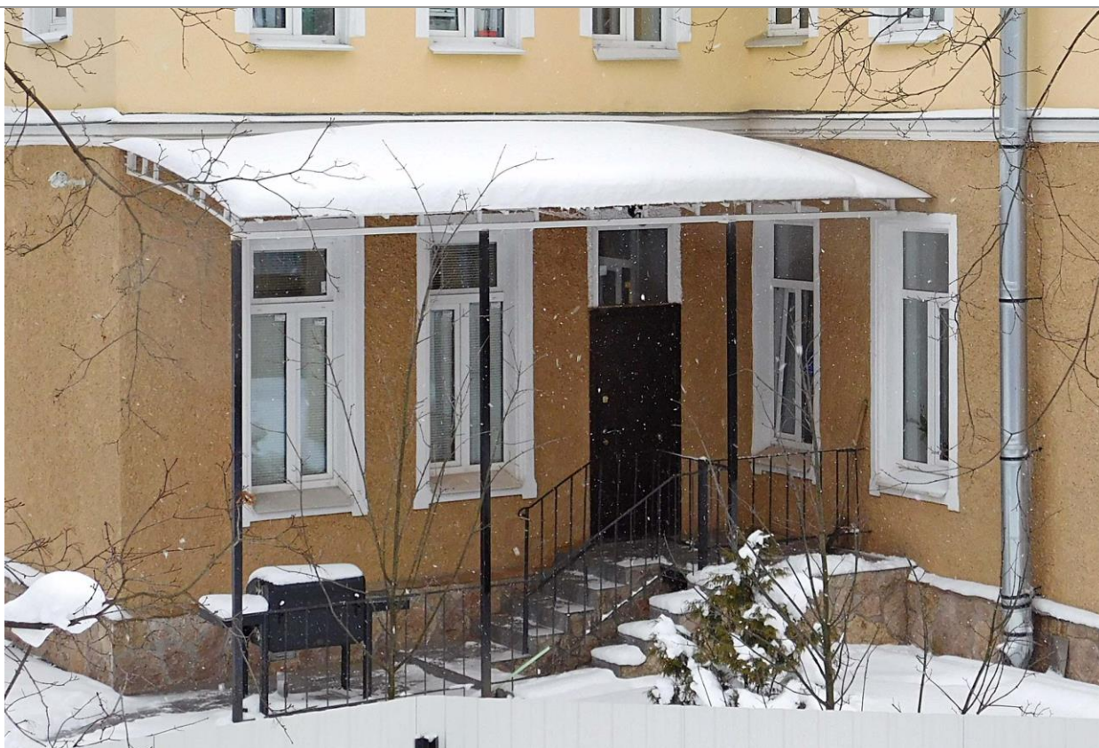
6. Крыльцо западного входа особняка. Фото М. И. Мильчика, 02.02.2018
