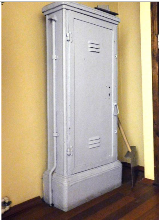
17. Исторический электросчет на лестничной площадке парадной лестницы первого этажа. Фото М. И. Мильчика, 02.02.2018.
