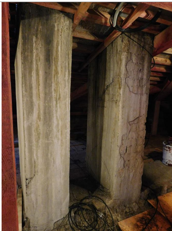
53. Чердак. Парные печные трубы в центральной части особняка. Фото М. И. Мильчика, 02.02.2018
