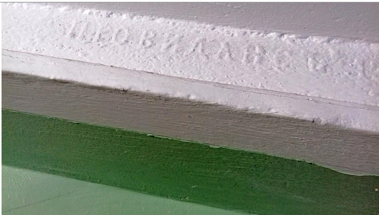
45. Маркировка швеллера – конструкционной детали лестницы западного входа. Съёмка с междуэтажной площадки. Фото М. И. Мильчика, 02.02.2018
