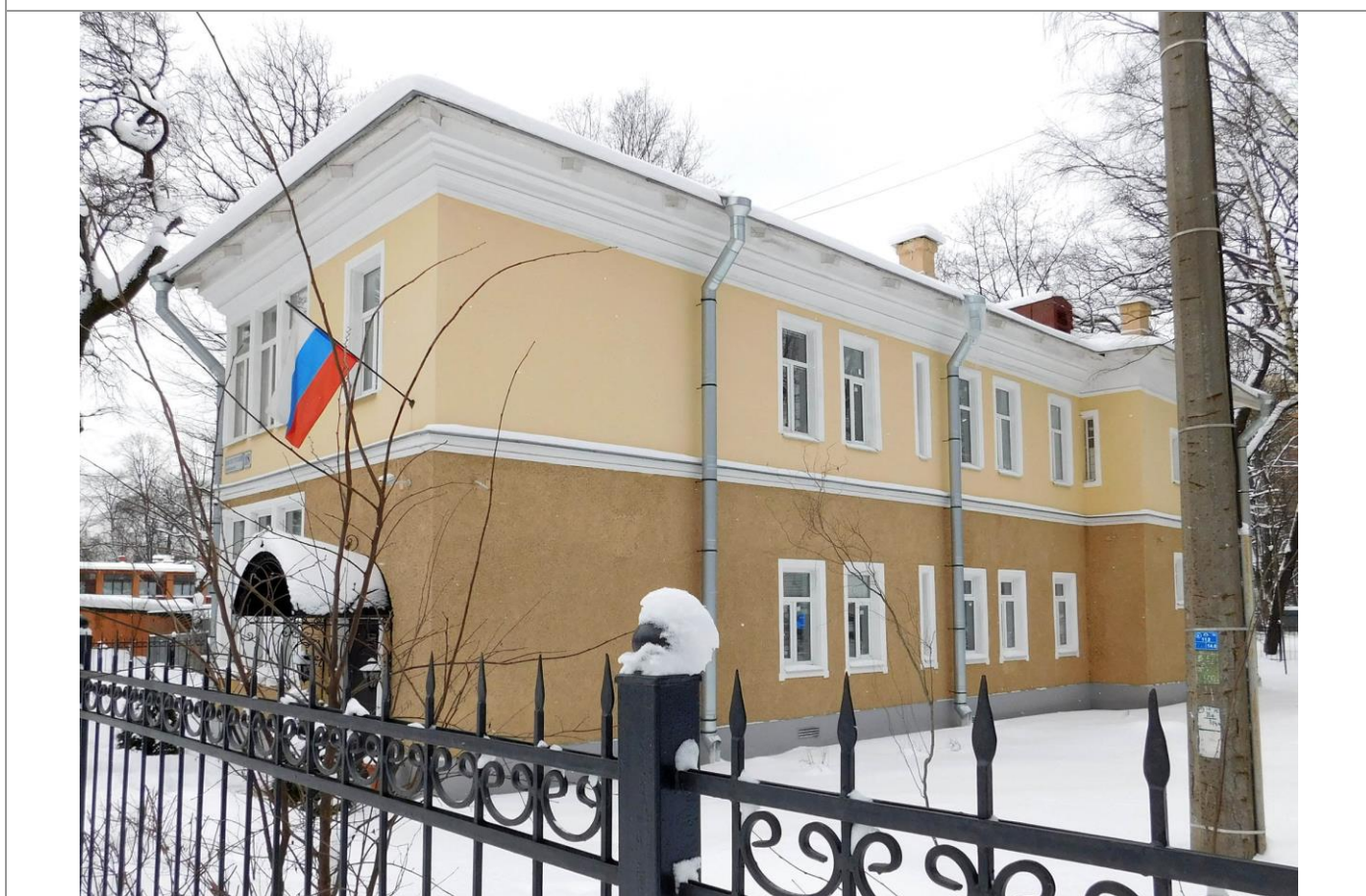
14. Северо-восточный фасад особняка. Фото М. И. Мильчика, 02.02.2018
