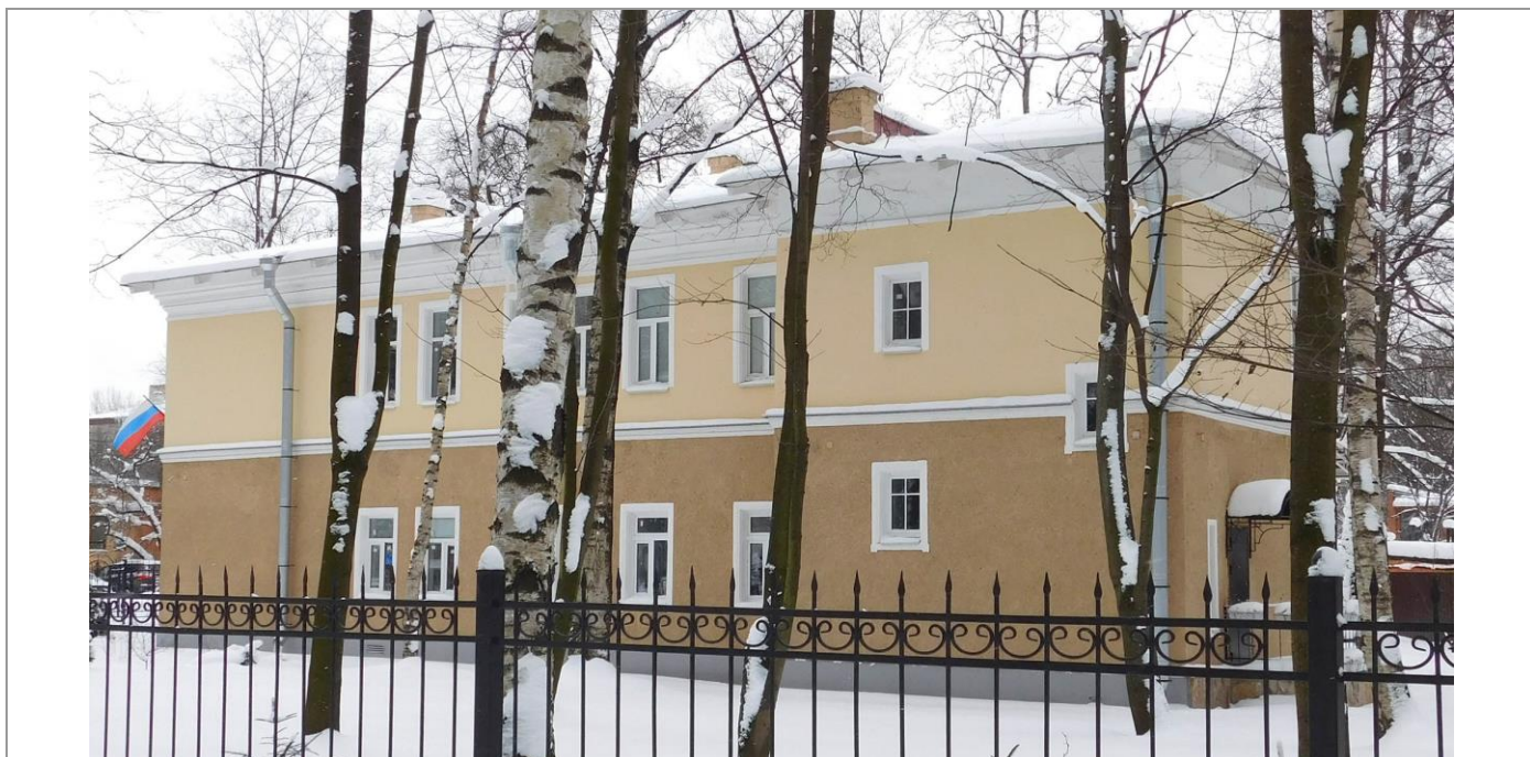
11. Северный фасад особняка. Фото М. И. Мильчика, 02.02.2018
