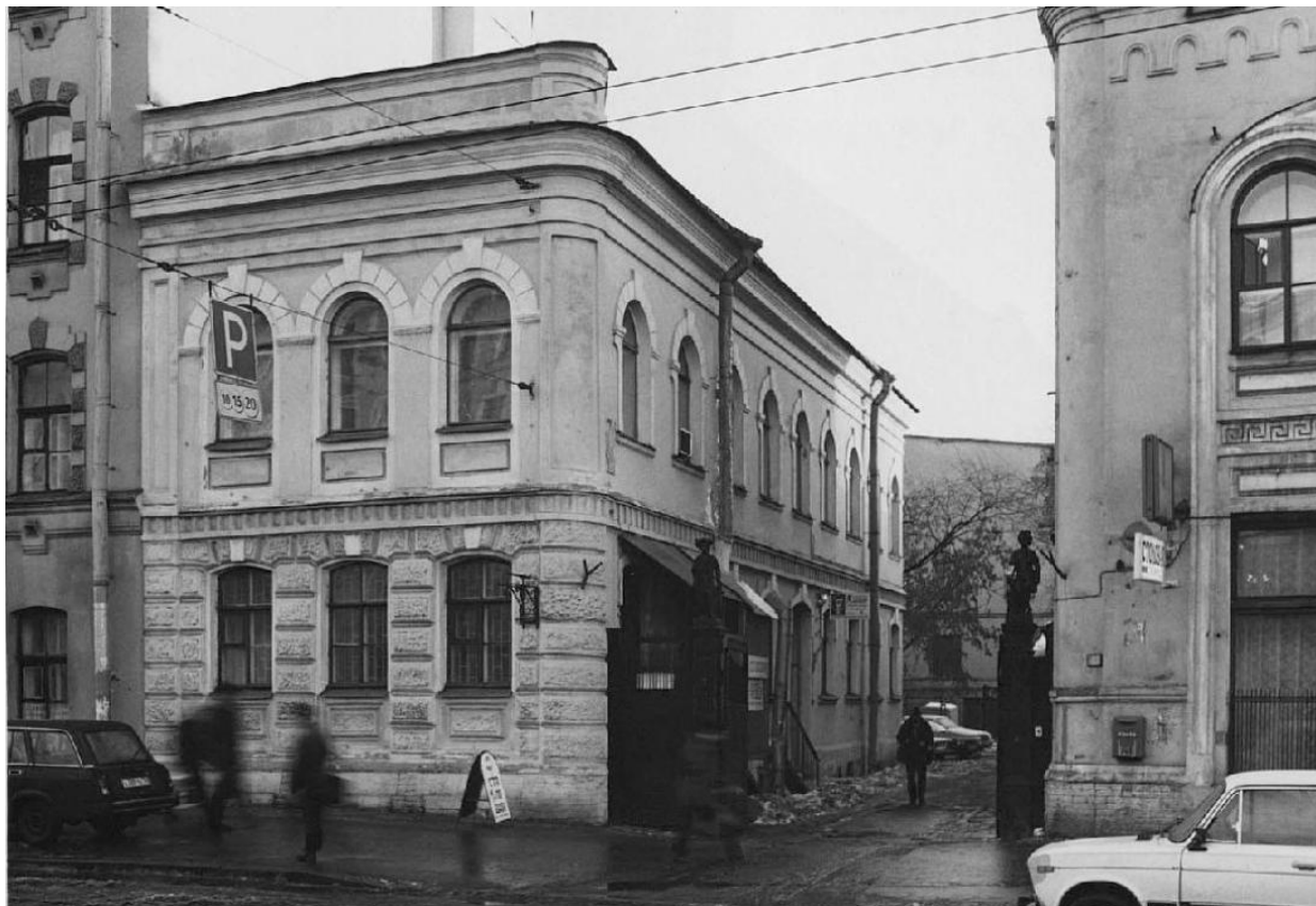
Илл. 72. Здание проходной. Общий вид со стороны Лиговского проспекта. Фото 1999 г. КГИОП. Паспорт. Завод Чугуно-литейный и механический Ф.К. Сан-Галли. Комплекс. 294-1. Инв. № 878п. Составитель Луцко Е.И.
