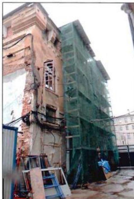
3. Общий вид северо-восточного фасада объекта культурного наследия.
