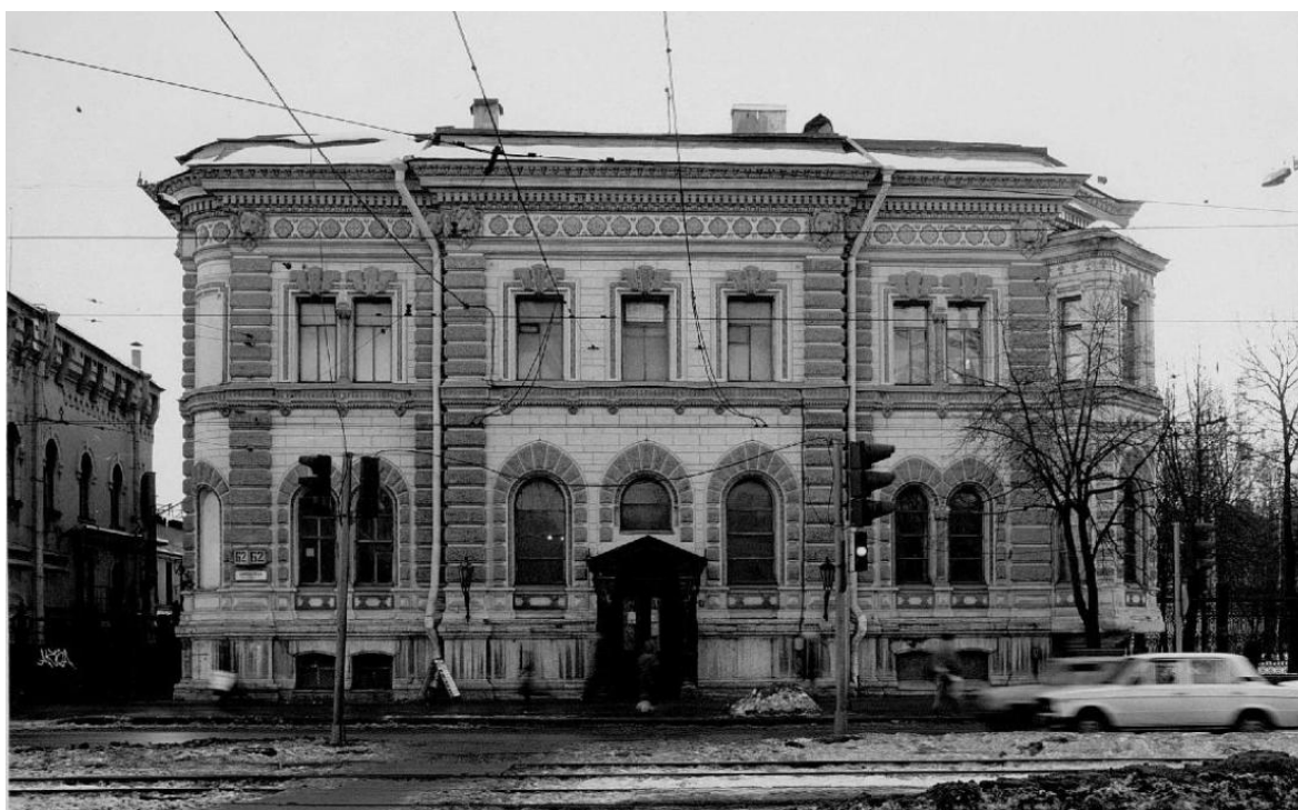
Илл. 66. Главный (северо-западный) фасад особняка Ф.К. Сан-Галли. Фото 1999 г. КГИОП. Паспорт Завод Чугуно-литейный и механический Ф.К. Сан-Галли. Особняк. 294-2. Инв. № 879п. Составитель Луцко Е.И.
