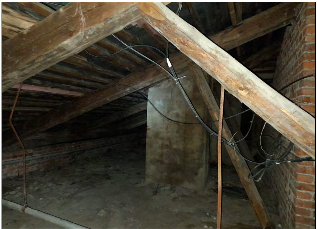
52. Объект культурного наследия «Казарма», в составе комплекса «Казармы 148-го пехотного Каспийского полка (с территорией)», расположенного по адресу: Санкт-Петербург, г. Петергоф, пер. Суворовцев, дом 8, литера А». Чердак. Дымовенткороб. 25.05.2021 г.
