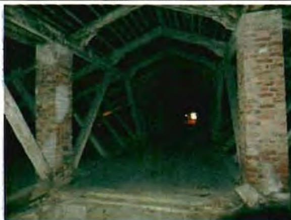
Фото 12. Конструкции крыши. Общий вид. 29.12.2015.
