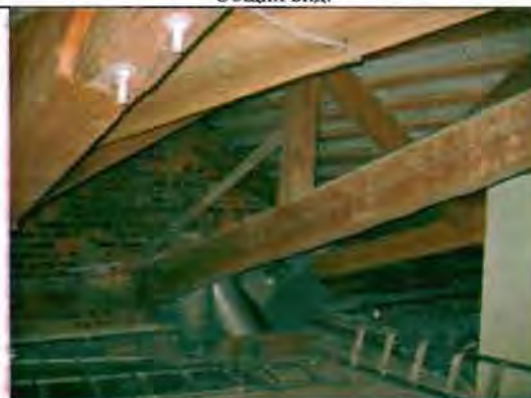
Фото 77. Конструкции крыши. Общий вид.
