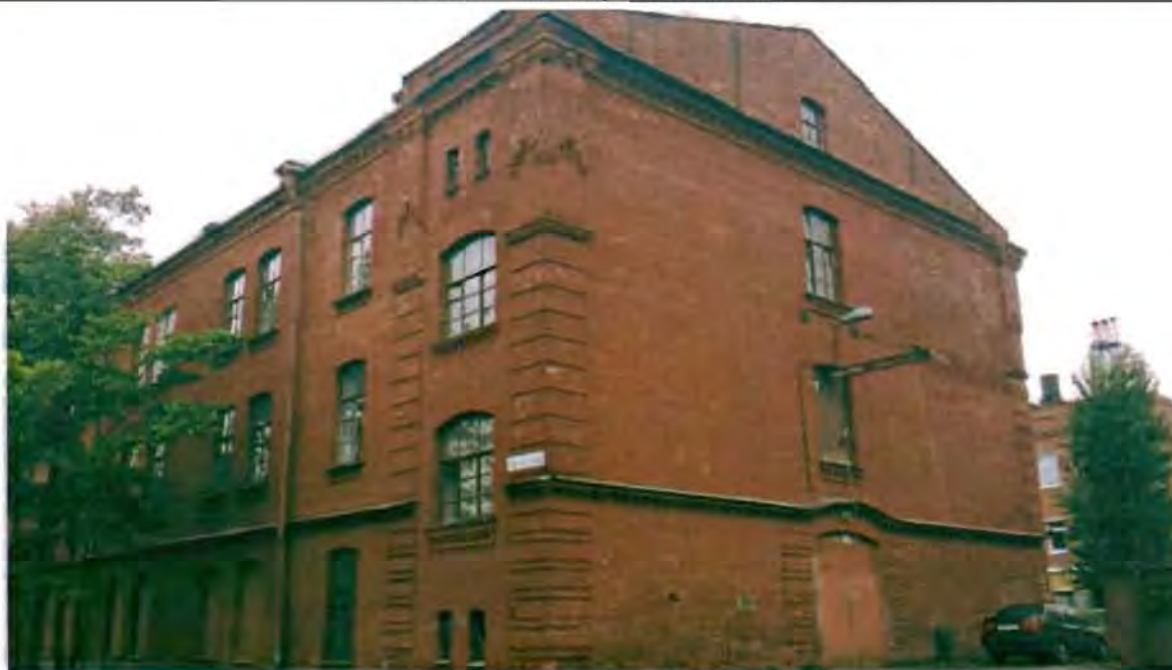
Фото 30. Северный фасад. Общий вид.
