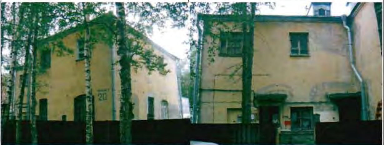
Фото 43. Северный, восточный фасады. Общий вид.
