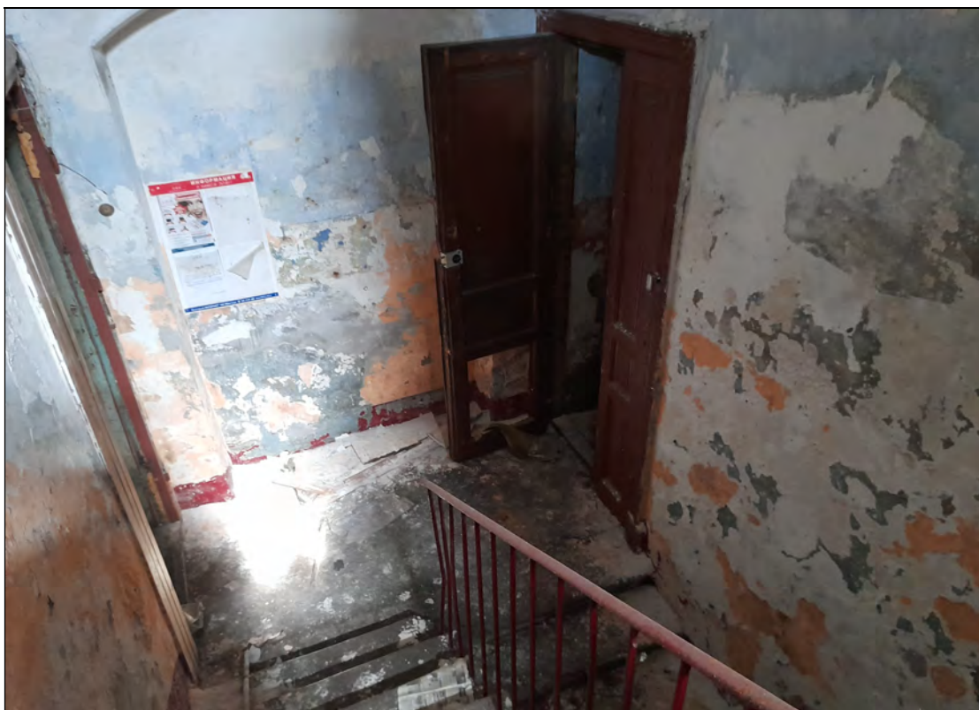
23. Объект культурного наследия «Казарма», в составе комплекса «Казармы 148-го пехотного Каспийского полка (с территорией)», расположенного по адресу: Санкт-Петербург, г. Петергоф, пер. Суворовцев, дом 8, литера А». 1-й этаж. Лестница в осях 1-4/В-Д. Площадка 1-го этажа. 25.05.2021 г.
