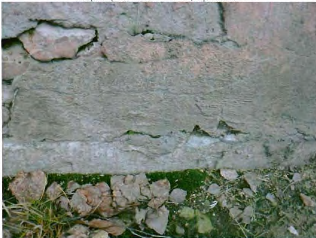
Цоколь, облицованный известняковой скобой. Съемка 27.11.2012, Воронина Н.В.
