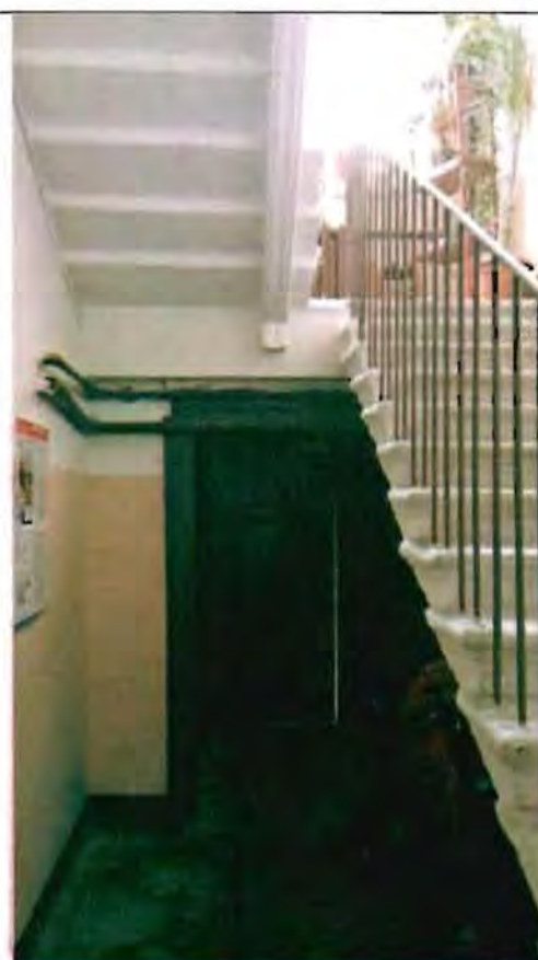
Фото 131. Лестница № 2 в северной части здания. Общий вид.
