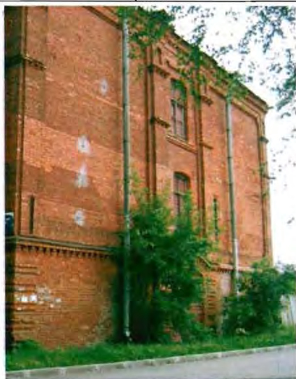
Фото 5. Южный фасад. Общий вид.
