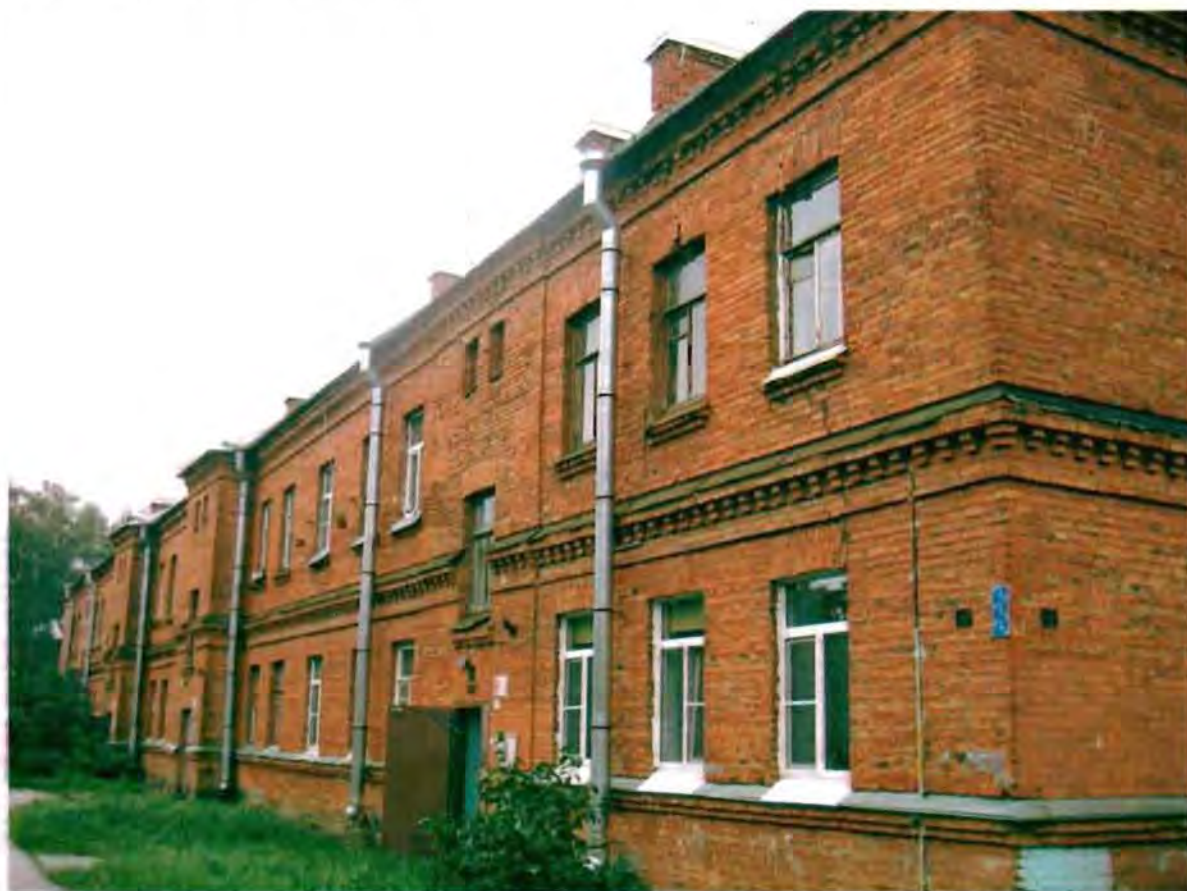
Фото 83. Северный фасад. Общий вид.
