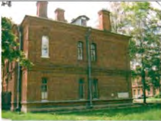
Фото 159. Северный фасад. Общий вид.
