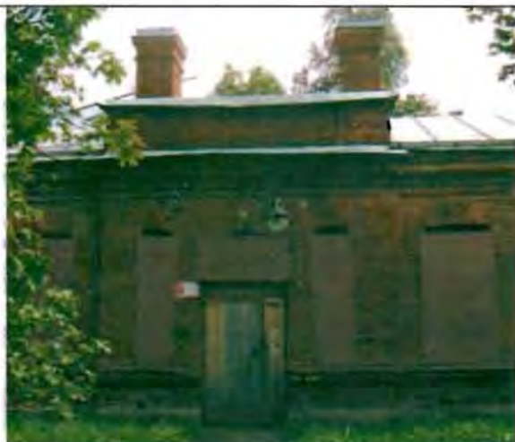
Фото 99. Западный фасад. Центральная часть. Общий вид.
