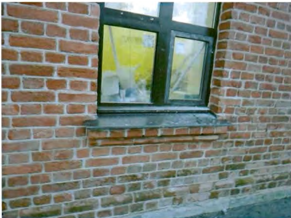
Ступенчатые подоконные доски. Съемка 20.11.2012, Воронина Н.В.
