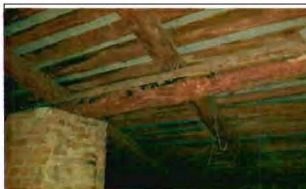
Фото 62. Конструкции крыши. Общий вид.
