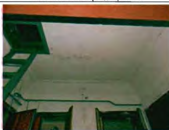
Фото 102. Отделка потолка тамбура. Общий вид.
