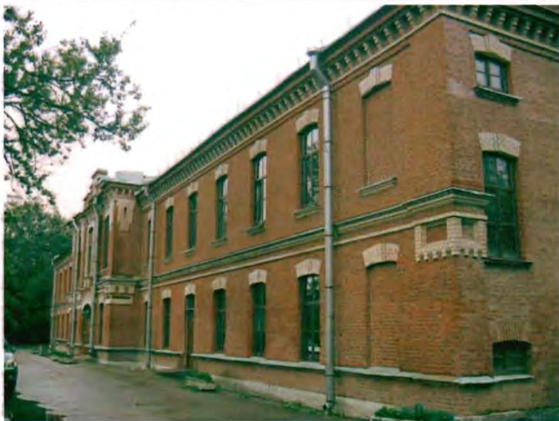
Фото 64. Северный фасад. Общий вид.
