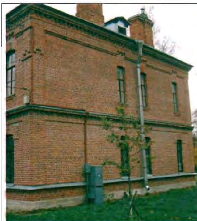
Фото 134. Южный фасад. Общий вид.
