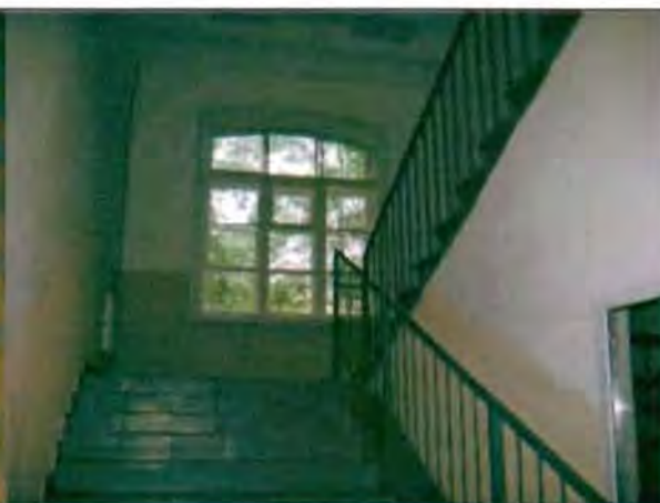
Фото 59. Интерьер. Лестница в северной части здания. Фрагмент.
