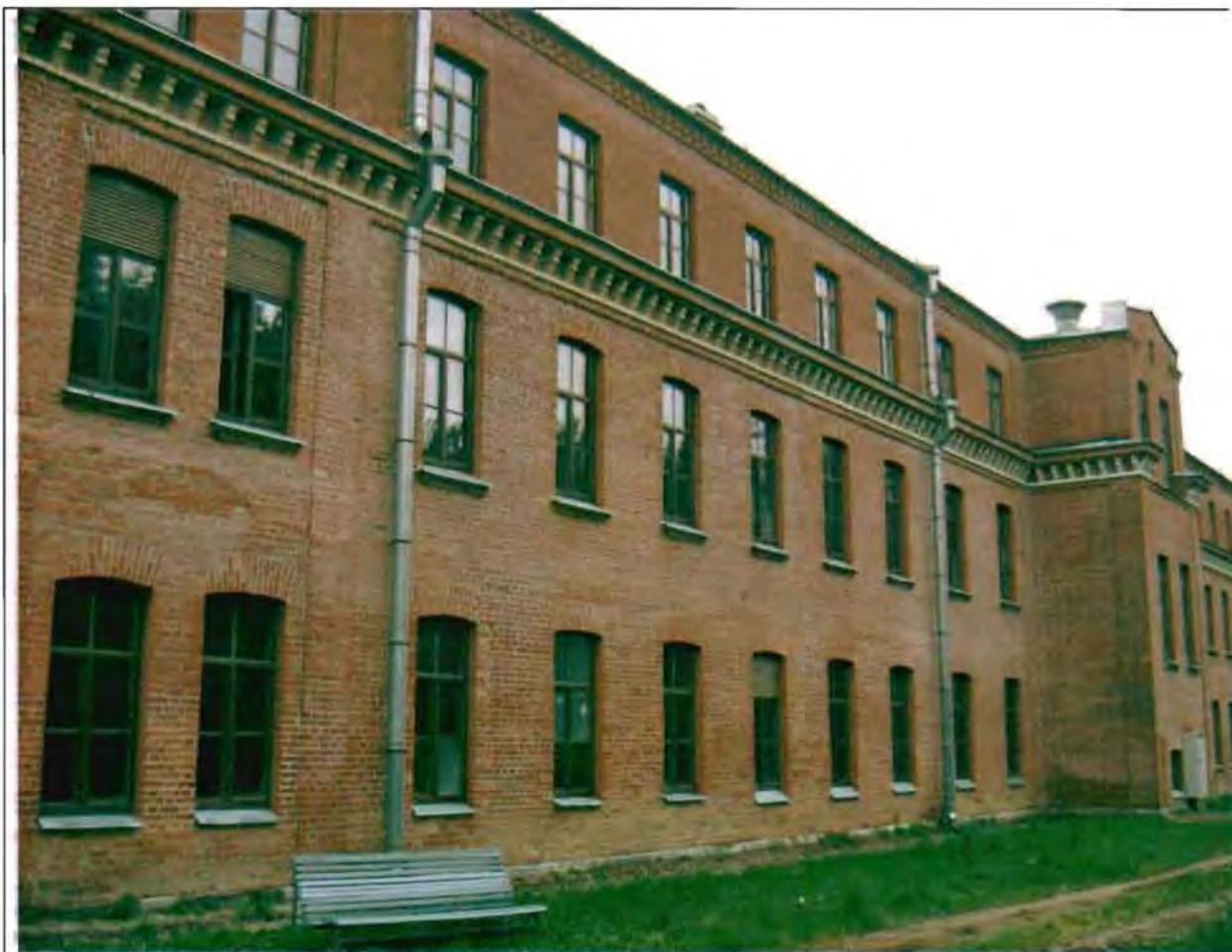
Фото 66. Южный фасад. Общий вид. 05.07.2016.
