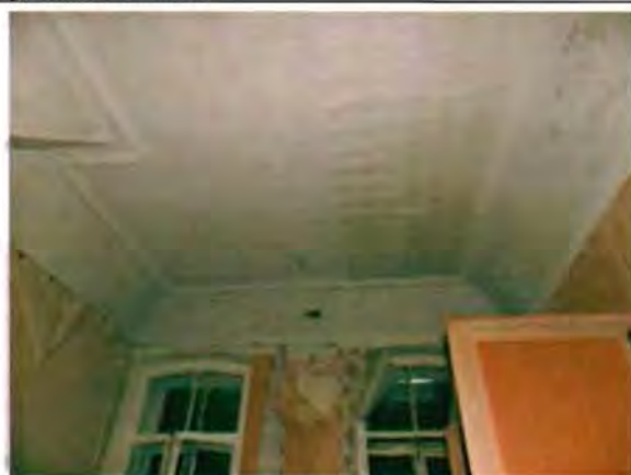
Фото 121. Помещение 1-го этажа.
