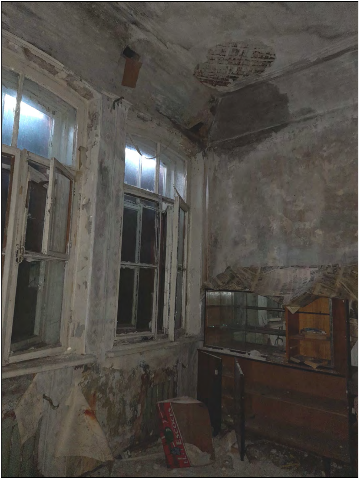
47. Объект культурного наследия «Казарма», в составе комплекса «Казармы 148-го пехотного Каспийского полка (с территорией)», расположенного по адресу: Санкт-Петербург, г. Петергоф, пер. Суворовцев, дом 8, литера А». 2-й этаж. Квартира № 8. Комната в осях 5-6. 25.05.2021 г.
