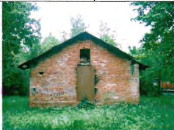
Фото 96. Западный фасад. Общий вид.
