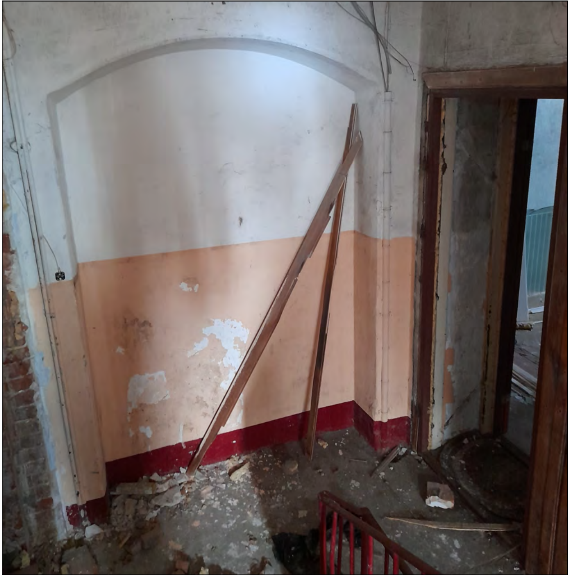
37. Объект культурного наследия «Казарма», в составе комплекса «Казармы 148-го пехотного Каспийского полка (с территорией)», расположенного по адресу: Санкт-Петербург, г. Петергоф, пер. Суворовцев, дом 8, литера А». 2-й этаж. Лестница в осях 1-4/В-Д. Площадка 2-го этажа. 25.05.2021 г.
