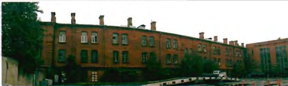
Фото 29. Западный фасад. Общий вид.
