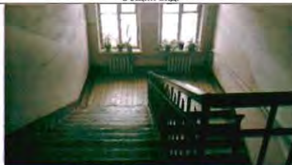
Фото 34. Интерьер. Лестница. Общий вид.
