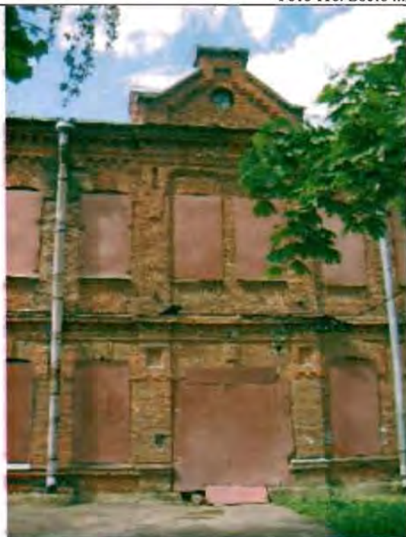
Фото 117. Восточный фасад. Фрагмент центральной части фасада.
