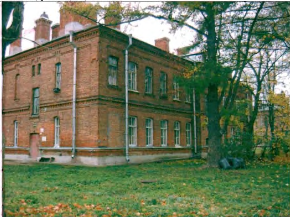
Фото 145. Восточный фасад. Общий вид.
