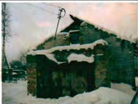
Фото 184. Восточный фасад. Общий вид. 14.01.2015.
