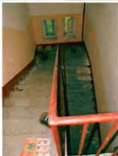
Фото 124. Лестница в южной части здания. Общий вид.
