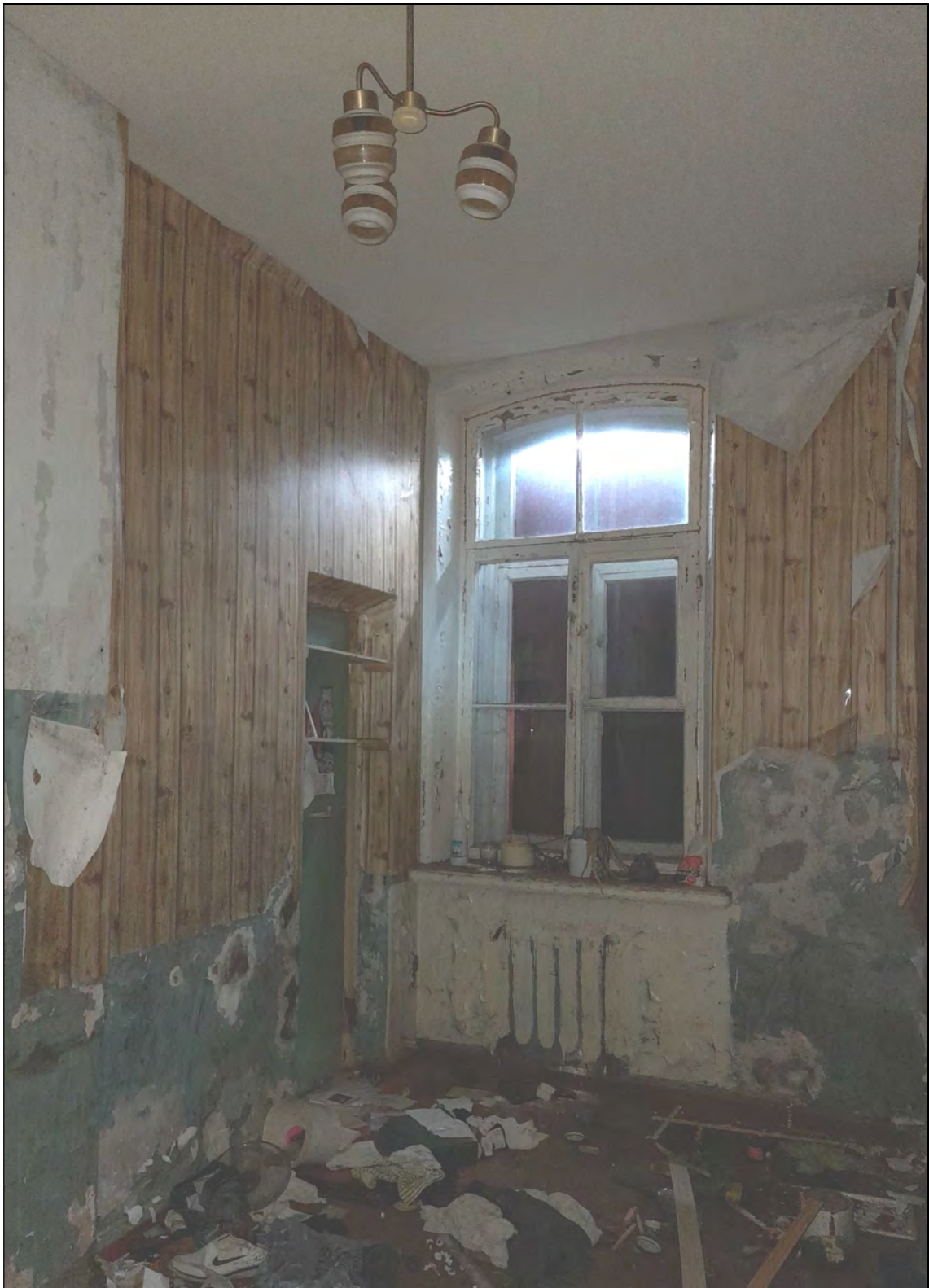
42. Объект культурного наследия «Казарма», в составе комплекса «Казармы 148-го пехотного Каспийского полка (с территорией)», расположенного по адресу: Санкт-Петербург, г. Петергоф, пер. Суворовцев, дом 8, литера А». 2-й этаж. Квартира № 4. Кухня в осях 2-3. 25.05.2021 г.
