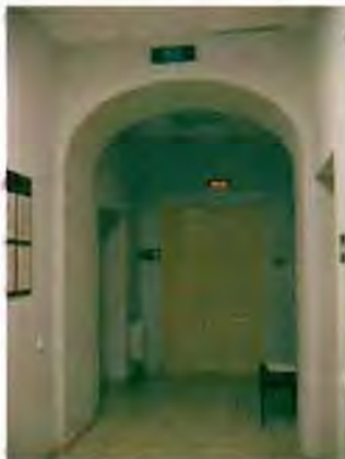
Фото 70. Интерьер. Помещение в уровне 1-го этажа. Общий вид.
