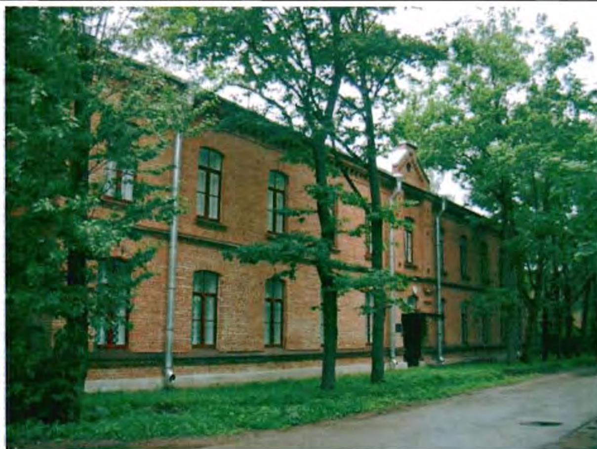
Фото 39. Восточный фасад. Общий вид.
