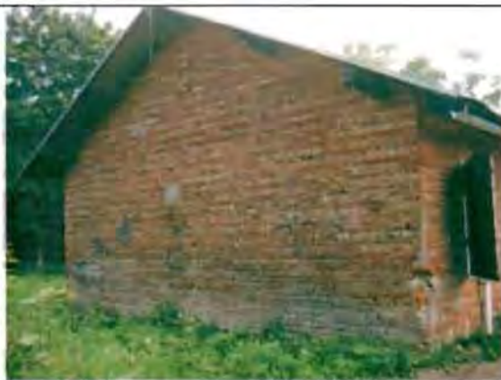
Фото 155. Северный фасад. Общий вид.
