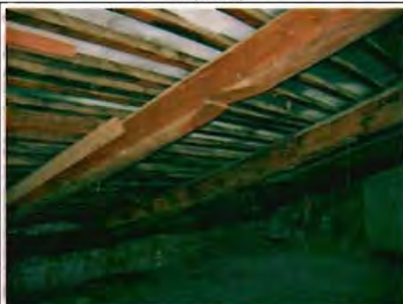
Фото 151. Конструкции крыши. Фрагмент.
