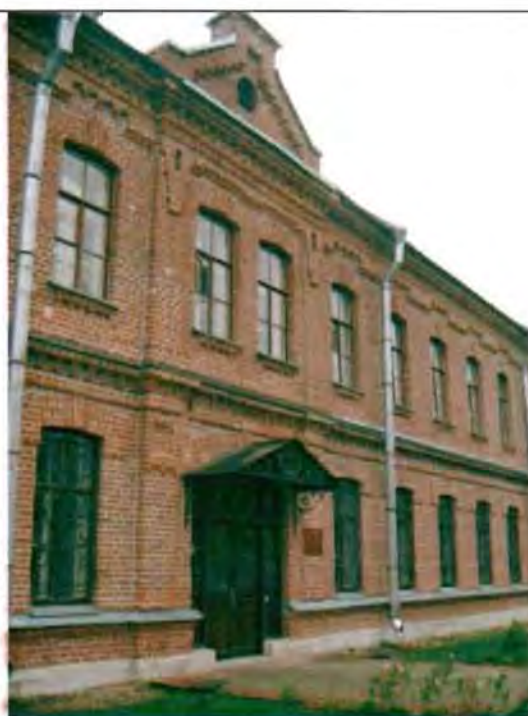
Фото 135. Западный фасад. Фрагмент центральной части фасада.
