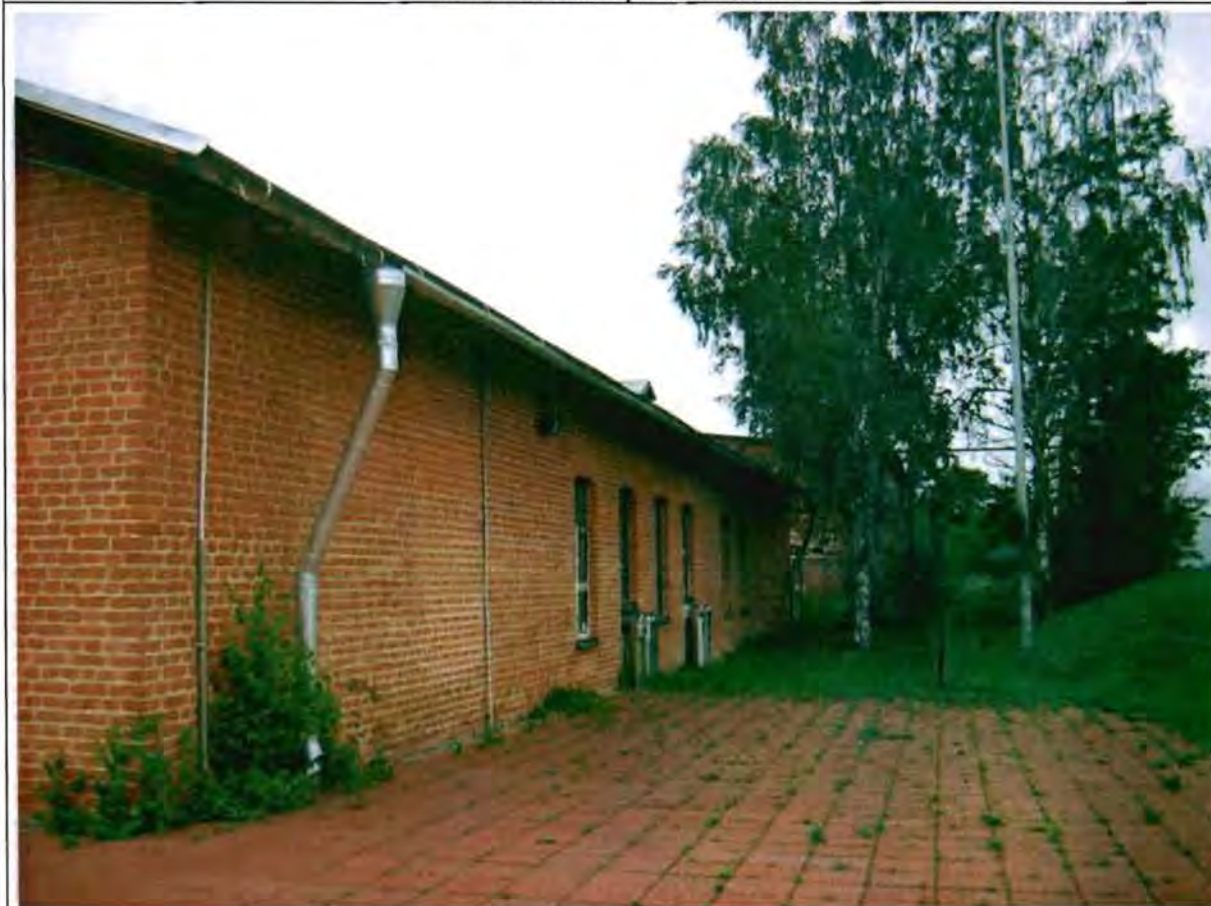
Фото 19. Восточный фасад. Общий вид.
