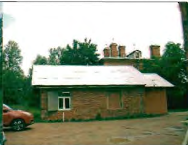
Фото 154. Южный фасад. Общий вид.
