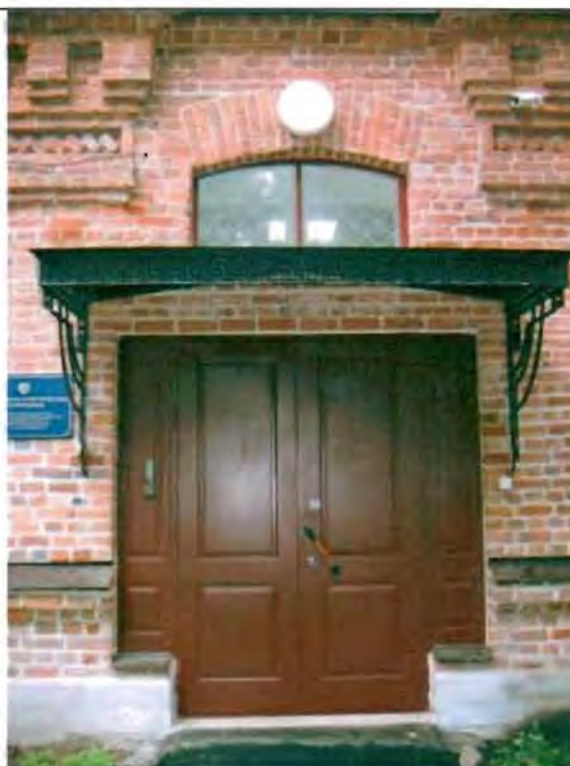
Фото 41. Дверной проем восточного фасада. Общий вид.
