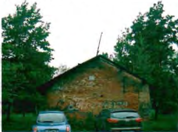
Фото 94. Восточный фасад. Общий вид.
