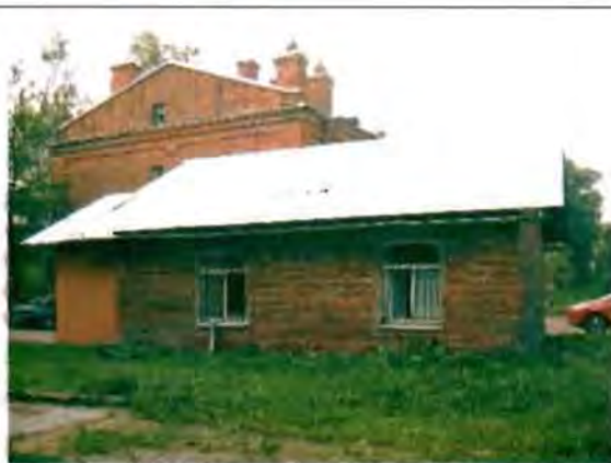
Фото 156. Западный фасад. Общий вид.
