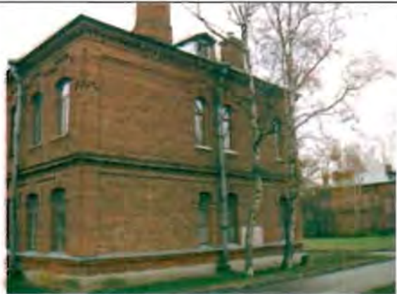
Фото 160. Северный фасад. Общий вид.
