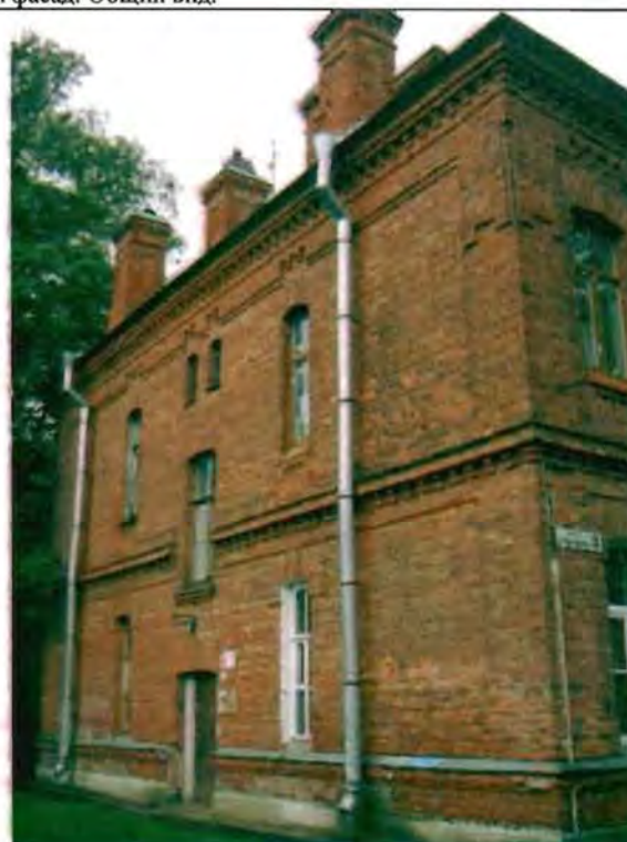
Фото 148. Северный фасад. Общий вид.
