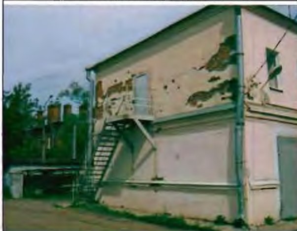
Фото 112. Южный фасад. Общий вид.
