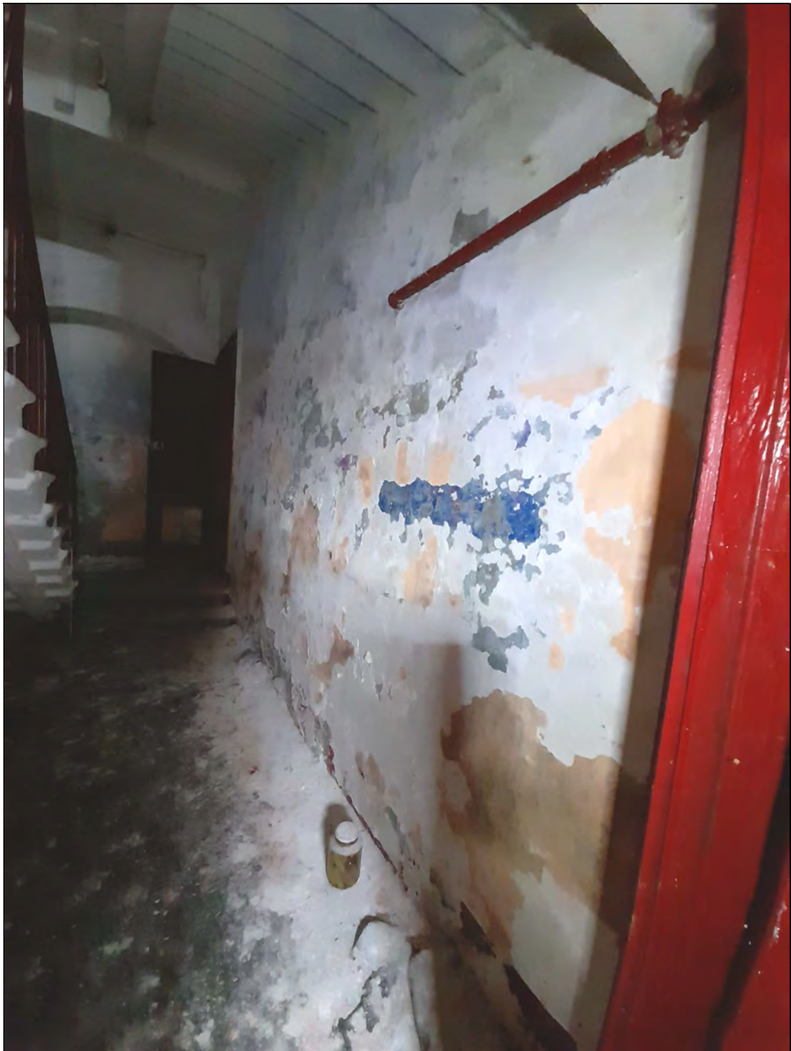
26. Объект культурного наследия «Казарма», в составе комплекса «Казармы 148-го пехотного Каспийского полка (с территорией)», расположенного по адресу: Санкт-Петербург, г. Петергоф, пер. Суворовцев, дом 8, литера А». 1-й этаж. Лестница в осях 7-10/В-Д. Площадка 1-го этажа. Вид от входа. 25.05.2021 г.
