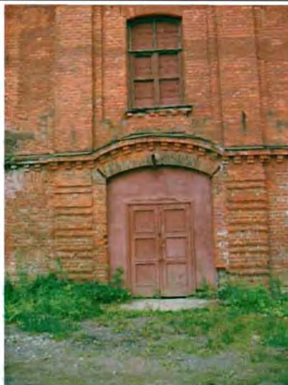
Фото 4. Западный фасад. Фрагмент центральной части фасада.
