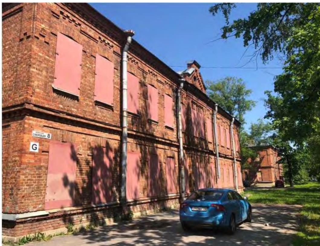
1. Объект культурного наследия «Казарма», в составе комплекса «Казармы 148-го пехотного Каспийского полка (с территорией)», расположенного по адресу: Санкт-Петербург, г. Петергоф, пер. Суворовцев, дом 8, литера А». Общий вид. Вид на северо-запад от переулка Суворовцев. 25.05.2021 г.
