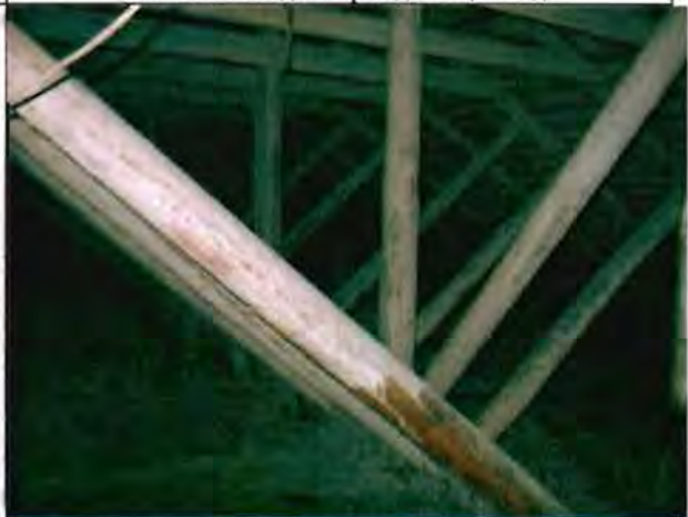
Фото 88. Конструкции крыши. Общий вид.
