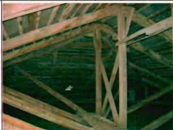
Фото 82. Конструкции крыши. Общий вид.
