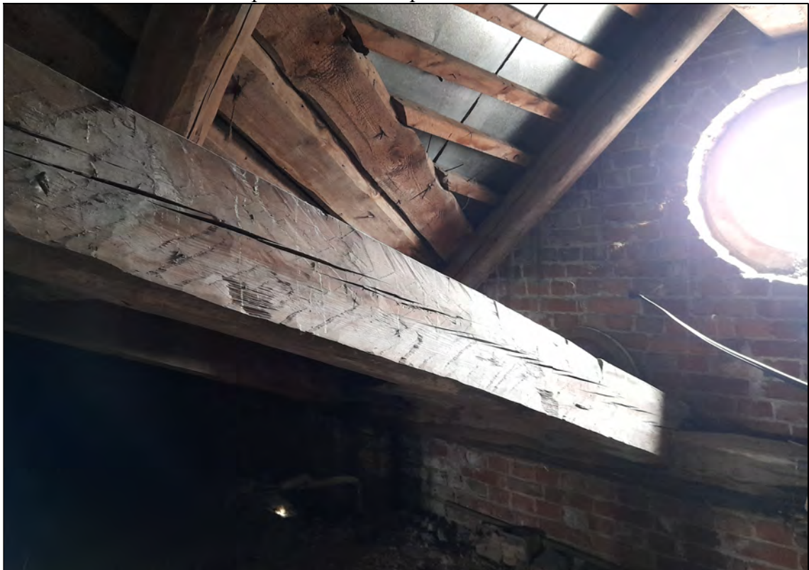
50. Объект культурного наследия «Казарма», в составе комплекса «Казармы 148-го пехотного Каспийского полка (с территорией)», расположенного по адресу: Санкт-Петербург, г. Петергоф, пер. Суворовцев, дом 8, литера А». Чердак. Фронтонный ризалит в осях А/5 25.05.2021 г.
