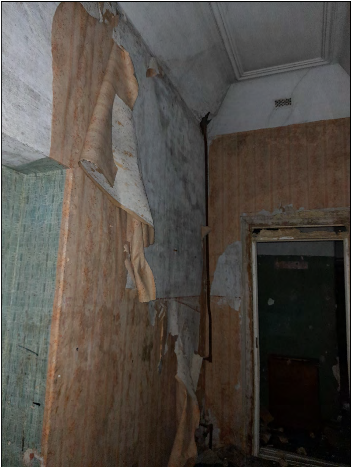
43. Объект культурного наследия «Казарма», в составе комплекса «Казармы 148-го пехотного Каспийского полка (с территорией)», расположенного по адресу: Санкт-Петербург, г. Петергоф, пер. Суворовцев, дом 8, литера А». 2-й этаж. Квартира № 4. Коридор в осях 3-5. 25.05.2021 г.
