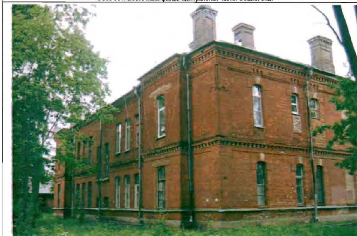
Фото 105. Западный, южный фасады. Общий вид.
