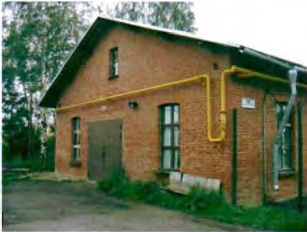
Фото 20. Северный фасад. Общий вид.
