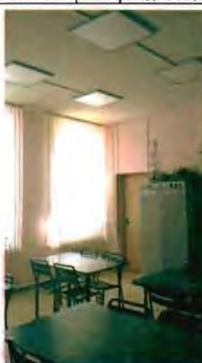
Фото 169. Помещение в уровне 1-го этажа. Общий вид.
