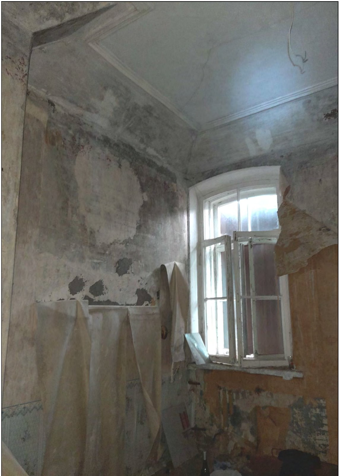
46. Объект культурного наследия «Казарма», в составе комплекса «Казармы 148-го пехотного Каспийского полка (с территорией)», расположенного по адресу: Санкт-Петербург, г. Петергоф, пер. Суворовцев, дом 8, литера А». 2-й этаж. Квартира № 8. Комната в осях 7-8. 25.05.2021 г.
