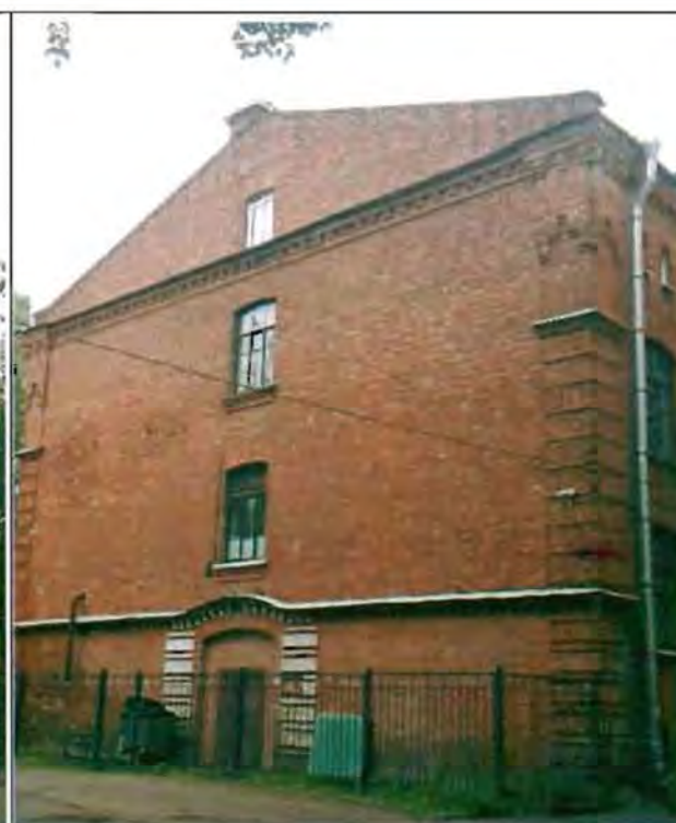
Фото 50. Южный фасад. Общий вид.
