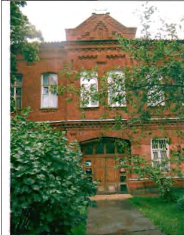
Фото 90. Восточный фасад. Центральная часть. Общий вид.
