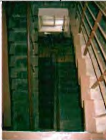
Фото 87. Лестница № 1. Общий вид.
