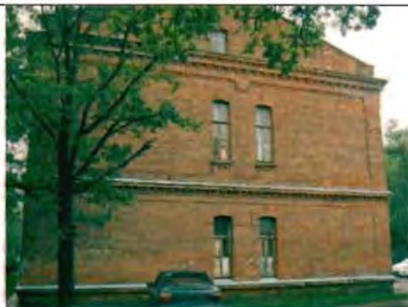
Фото 167. Северный фасад. Общий вид.
