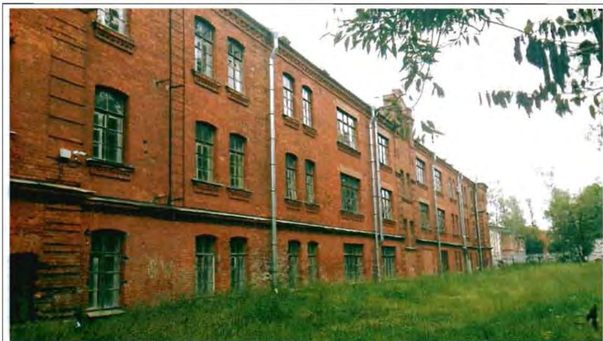
Фото 48. Западный фасад. Общий вид.
