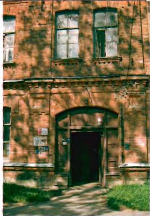
Фото 178. Восточный фасад. Центральная часть. Фрагмент.
