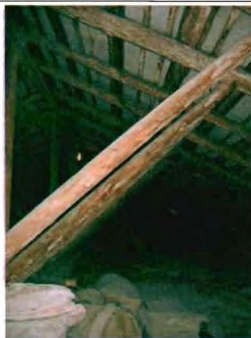
Фото 27. Конструкции крыши. Фрагмент.
