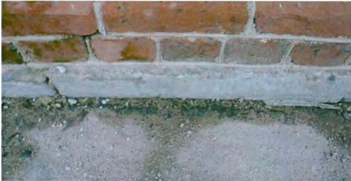
Цоколь, облицованный известняковой скобой. Съемка 20.11.2012, Воронина Н.В.
