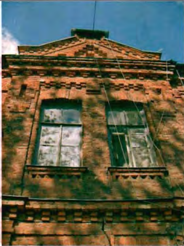
Фото 177. Восточный фасад. Центральная часть. Фрагмент.
