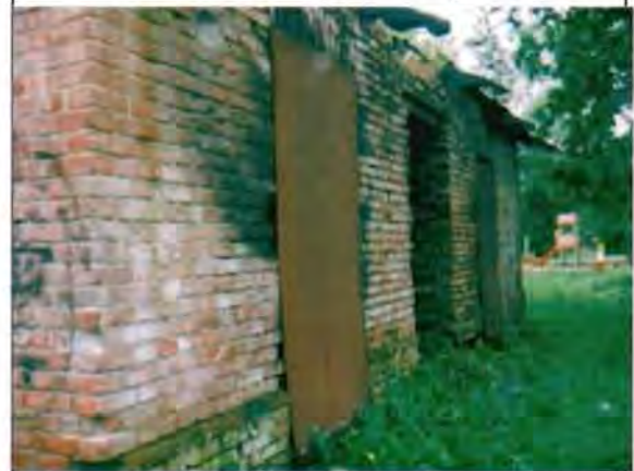
Фото 95. Северный фасад. Общий вид.
