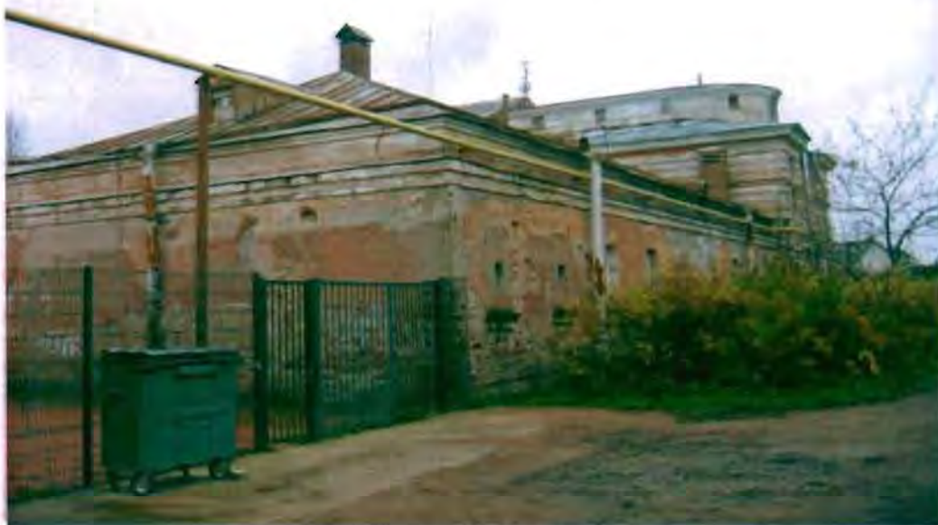
Фото 24. Западный, северный фасады. Общий вид.
