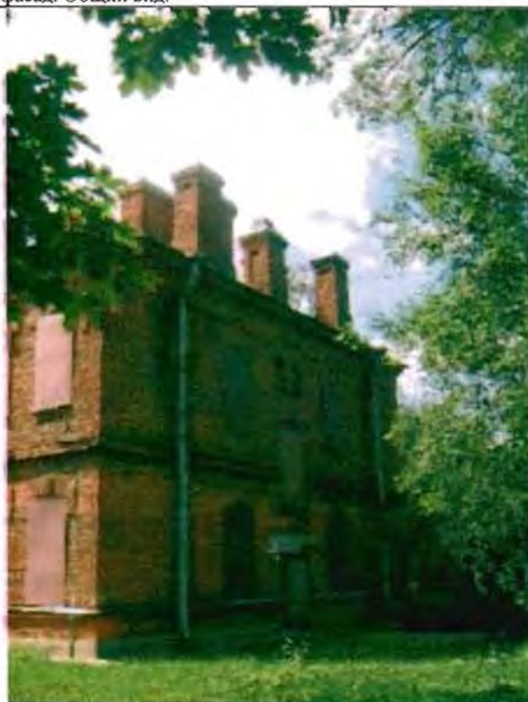
Фото 118. Северный фасад. Общий вид.
