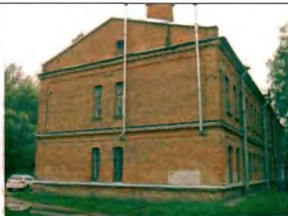
Фото 166. Южный фасад. Общий вид.
