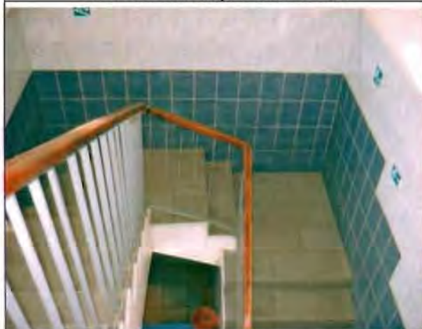
Фото 114. Лестница. Общий вид.
