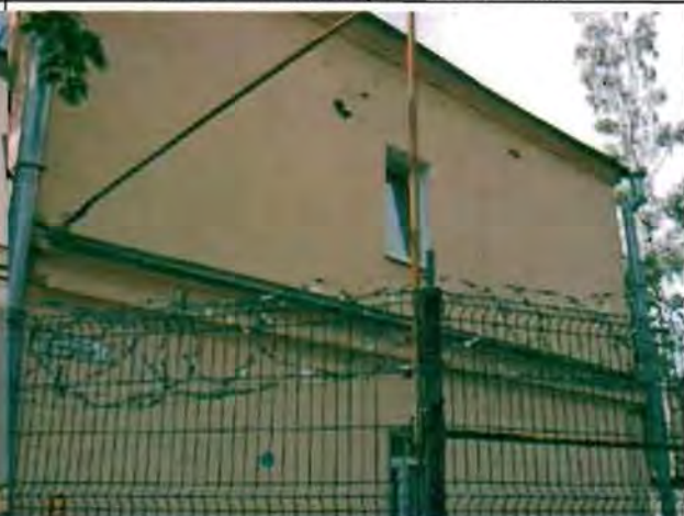
Фото 113. Северный фасад. Общий вид.
