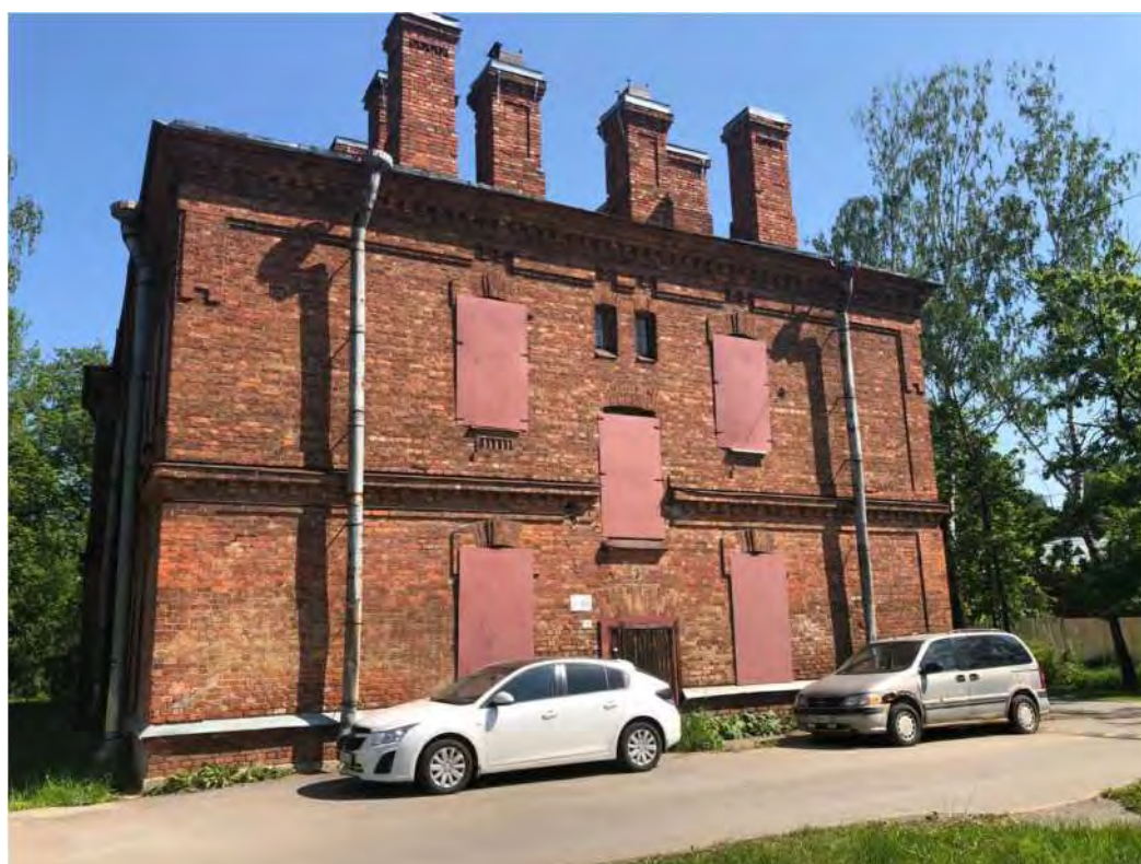
14. Объект культурного наследия «Казарма», в составе комплекса «Казармы 148-го пехотного Каспийского полка (с территорией)», расположенного по адресу: Санкт-Петербург, г. Петергоф, пер. Суворовцев, дом 8, литера А». Фрагмент северного фасада. Вход. Вид на юг. 25.05.2021 г.
