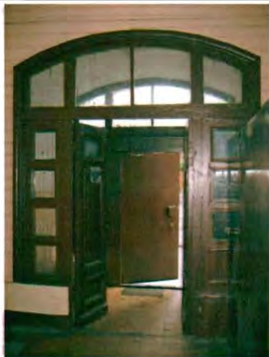
Фото 107. Дверной проем тамбура. Общий вид.
