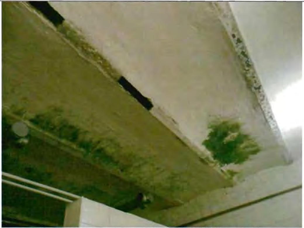
Своды по металлическим балкам. Съемка 27.11.2012, Воронина Н.В.
