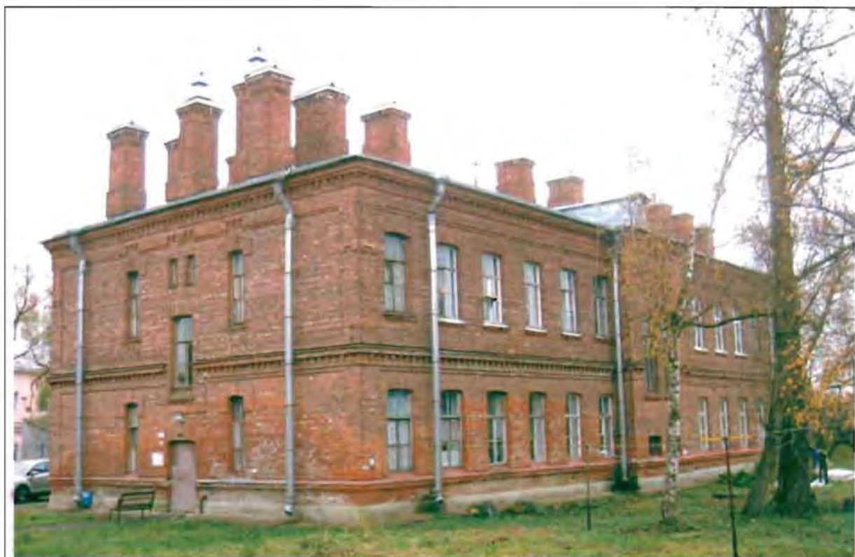
Фото 129. Западный, северный фасады. Общий вид.
