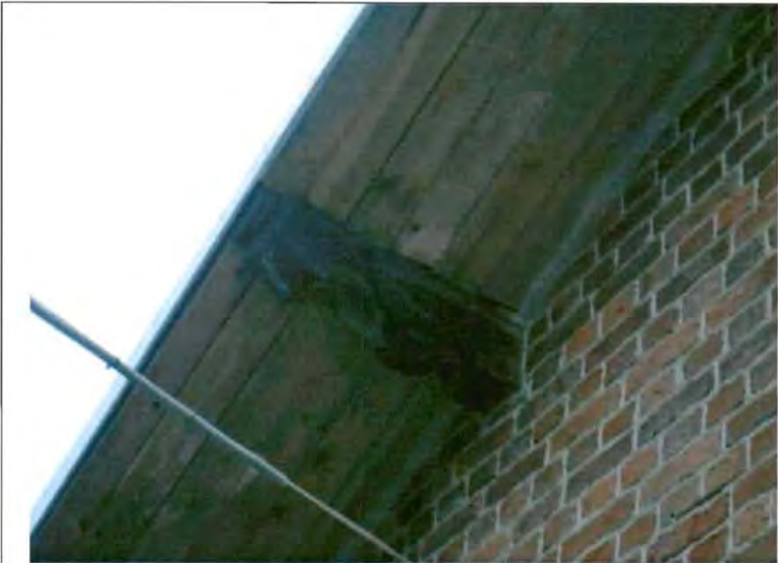
Деревянные кобылки. Съёмка 20.11.2012, Воронина Н.В.
