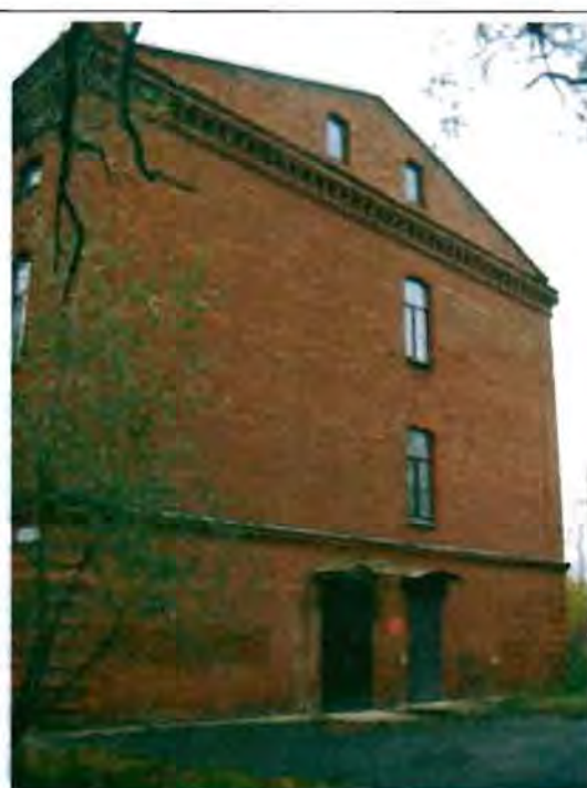
Фото 16. Южный фасад. Общий вид.
