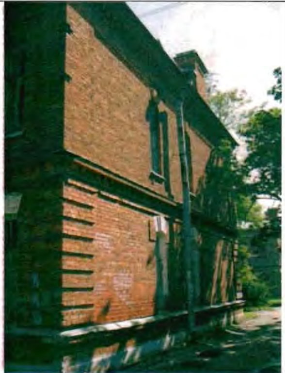
Фото 138. Южный фасад. Общий вид.
