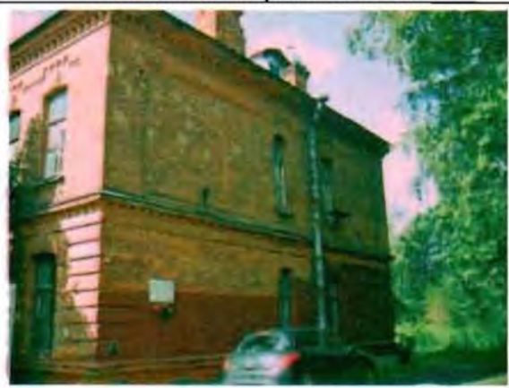
Фото 140. Северный фасад. Общий вид.
