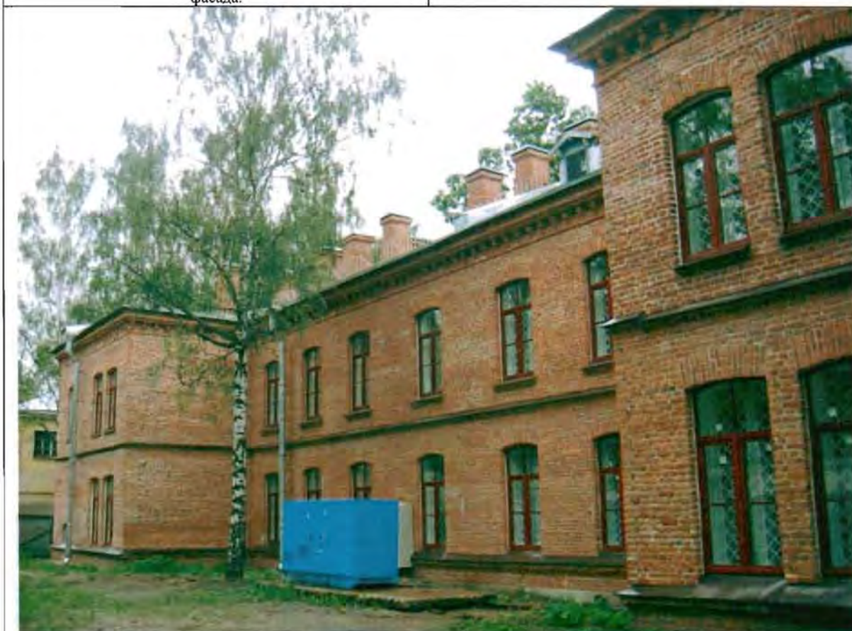
Фото 42. Западный фасад. Общий вид.
