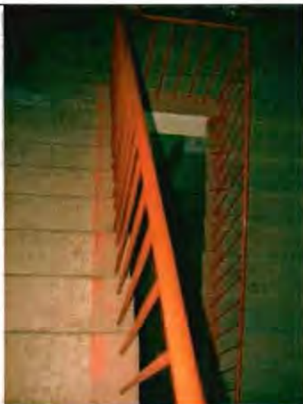
Фото 149. Лестница № 1 в северной части здания. Общий вид.
