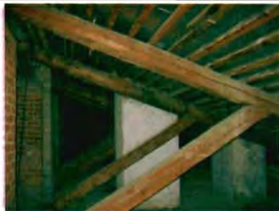
Фото 141. Конструкции крыши. Фрагмент.
