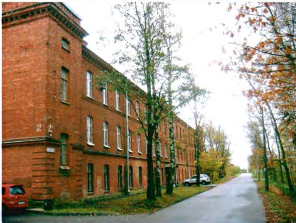
Фото 13. Западный фасад. Общий вид.
