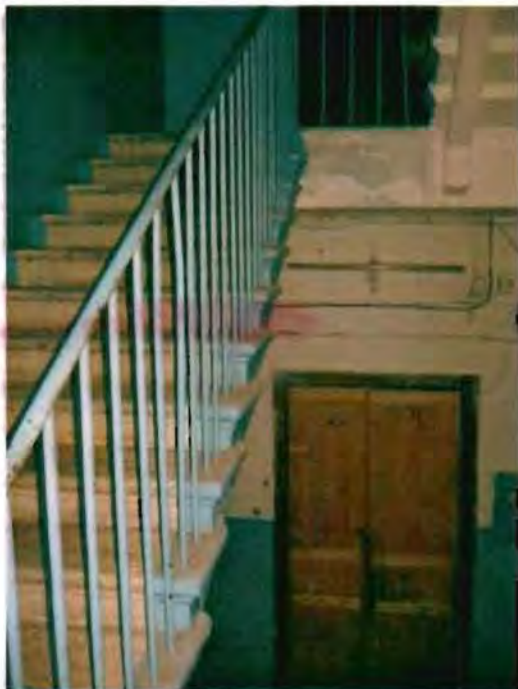
Фото 143. Лестница № 1 в северной части здания. Общий вид.
