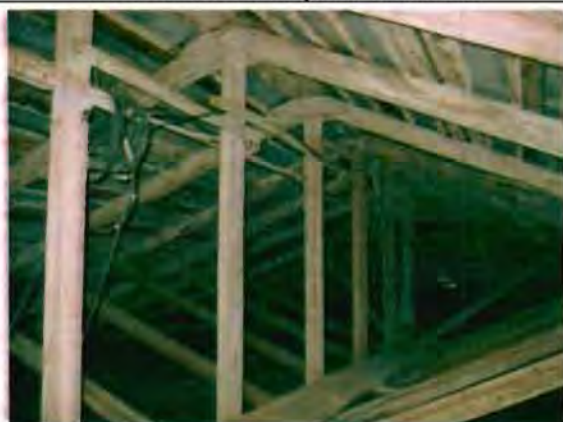
Фото 81 Конструкции крыши. Общий вид.
