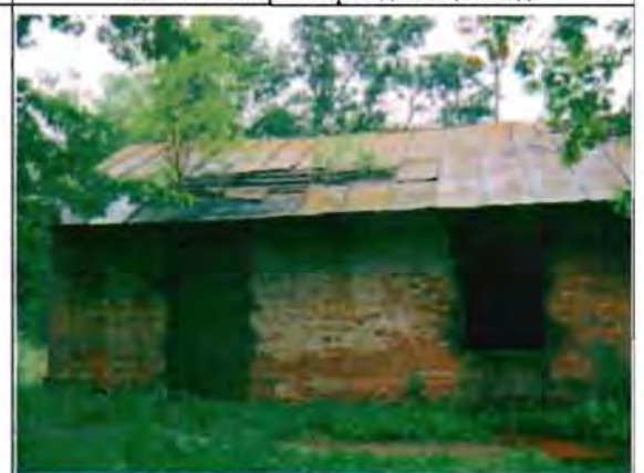
Фото 97. Южный фасад. Общий вид.
