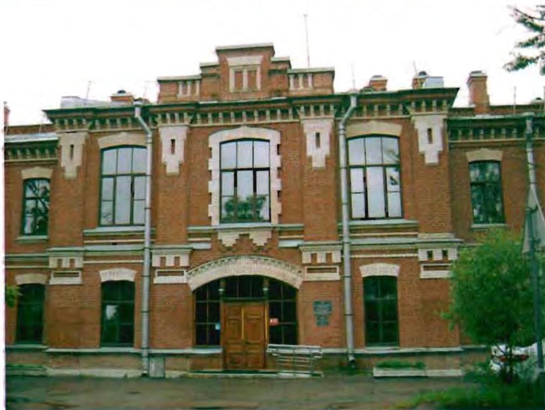
Фото 65. Северный фасад. Фрагмент центральной части фасада.
