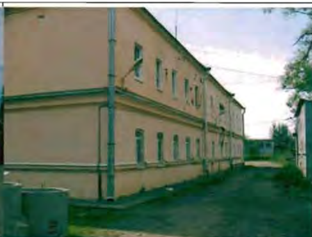
Фото 111. Западный фасад. Общий вид.
