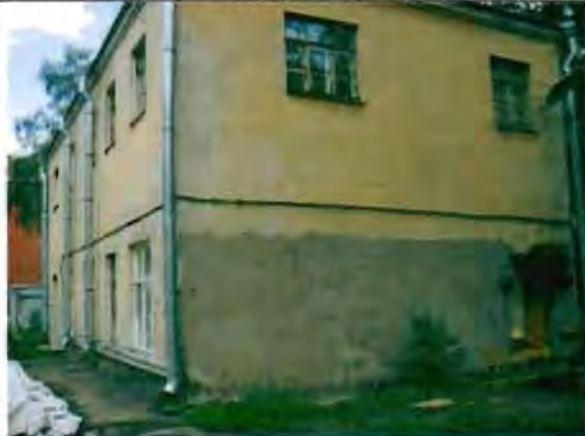
Фото 45. Южный, западный фасад. Общий вид.
