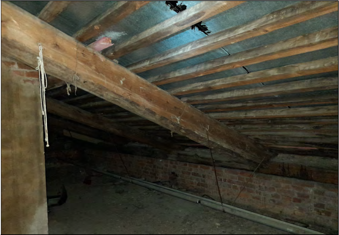
51. Объект культурного наследия «Казарма», в составе комплекса «Казармы 148-го пехотного Каспийского полка (с территорией)», расположенного по адресу: Санкт-Петербург, г. Петергоф, пер. Суворовцев, дом 8, литера А». Чердак. Обрешетка. 25.05.2021 г.
