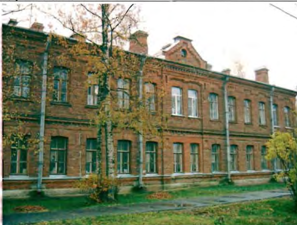
Фото 157. Западный фасад. Общий вид.
