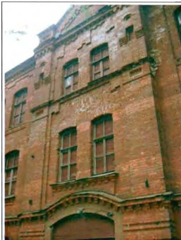
Фото 3. Западный фасад. Фрагмент центральной части фасада.
