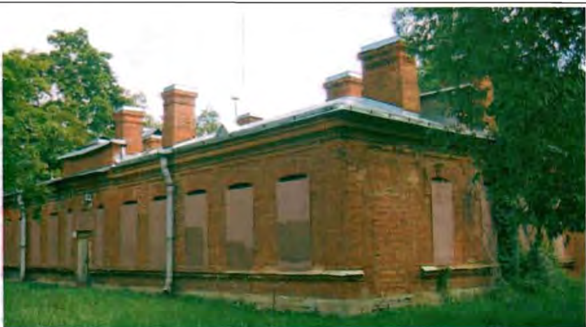
Фото 98. Западный фасад. Общий вид.
