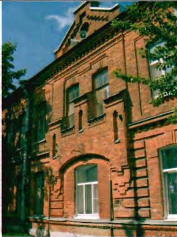
Фото 137. Восточный фасад. Фрагмент.
