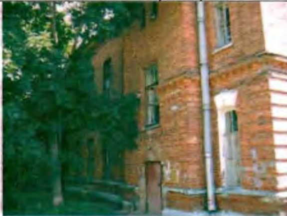
Фото 139. Западный фасад. Фрагмент.
