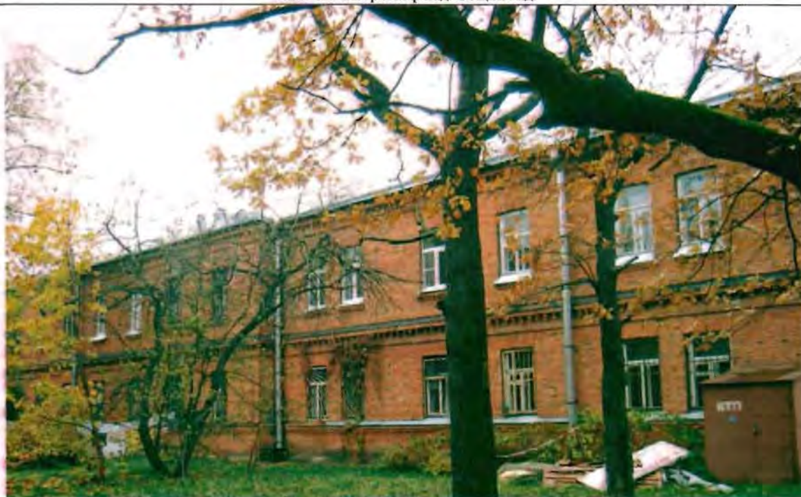
Фото 84. Южный фасад. Общий вид.
