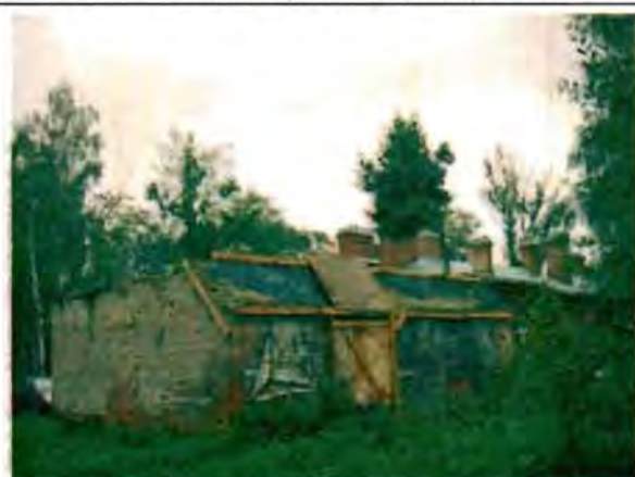
Фото 186. Западный, северный фасады. Общий вид.
