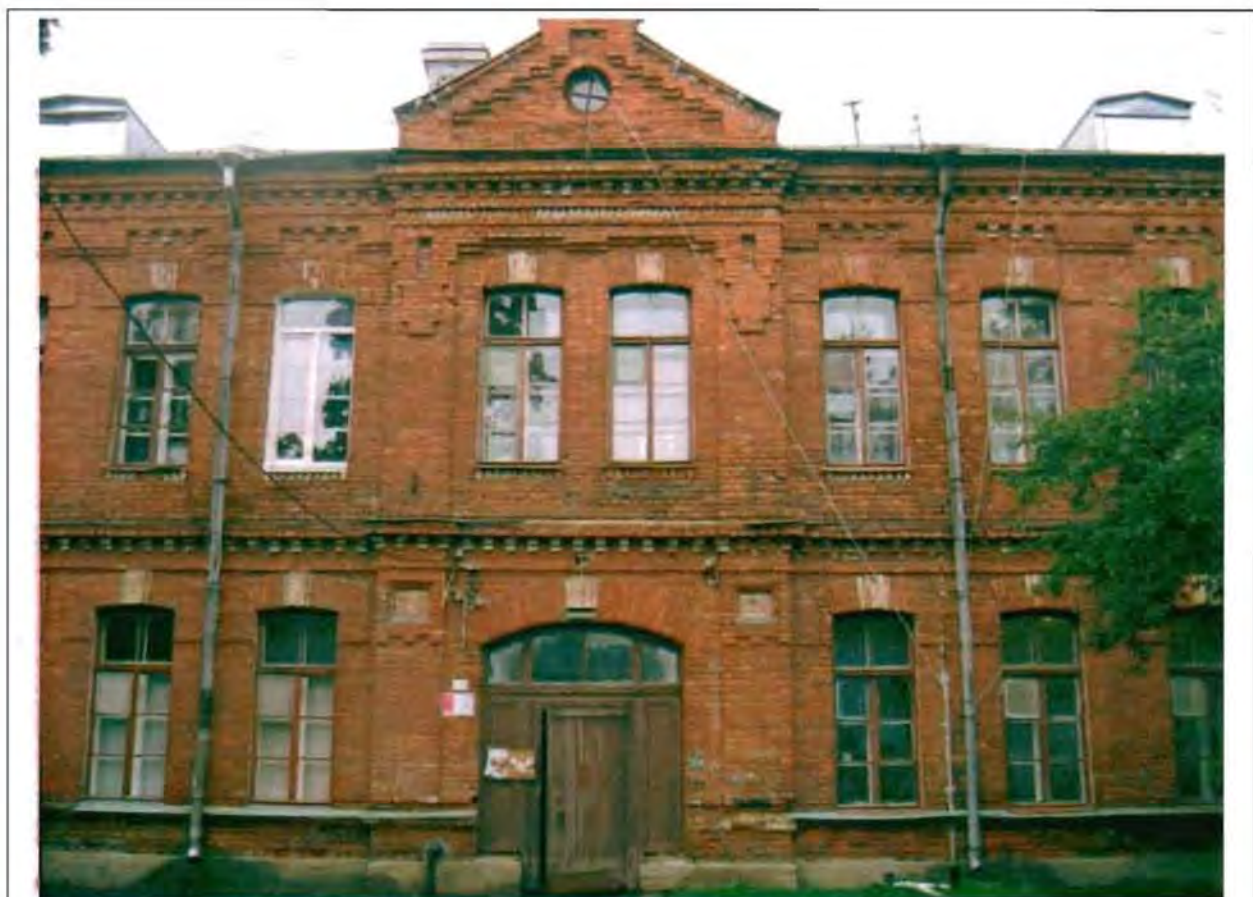
Фото 104. Восточный фасад. Центральная часть. Общий вид.
