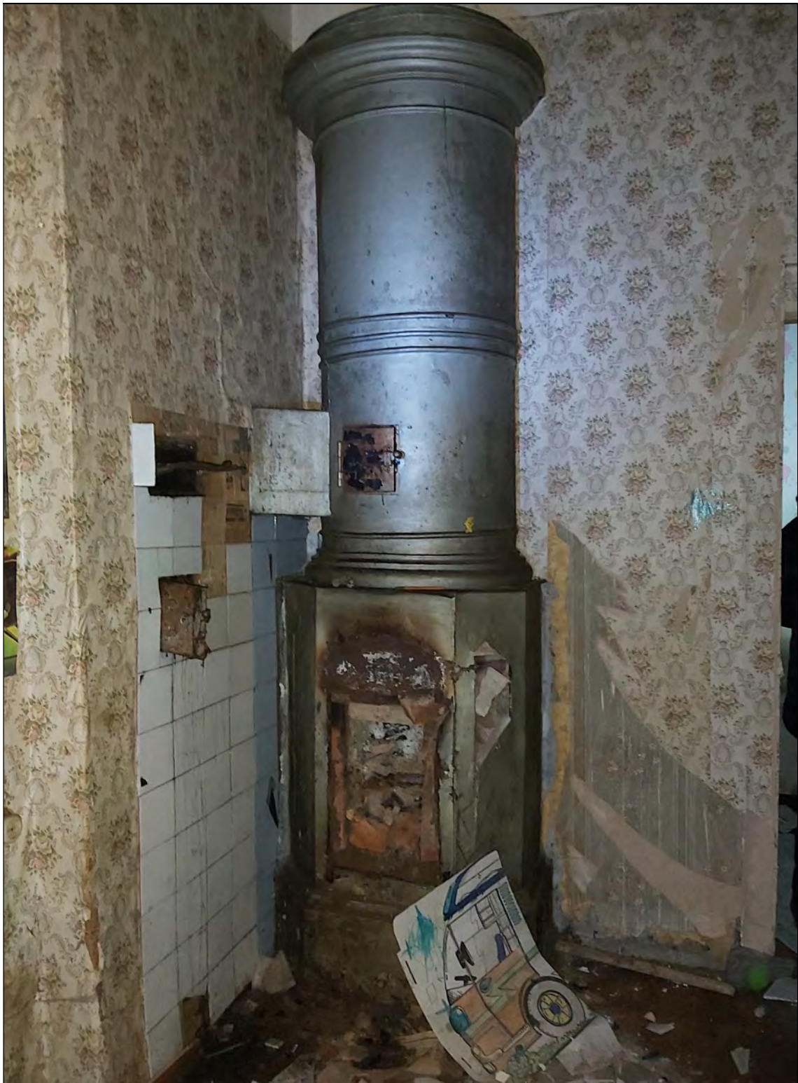
29. Объект культурного наследия «Казарма», в составе комплекса «Казармы 148-го пехотного Каспийского полка (с территорией)», расположенного по адресу: Санкт-Петербург, г. Петергоф, пер. Суворовцев, дом 8, литера А». 1-й этаж. Квартира № 2. Комната в осях 4-5. Печь. 25.05.2021 г.
