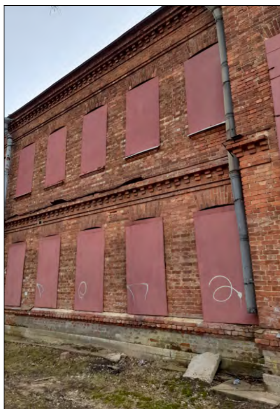
8. Объект культурного наследия «Казарма», в составе комплекса «Казармы 148-го пехотного Каспийского полка (с территорией)», расположенного по адресу: Санкт-Петербург, г. Петергоф, пер. Суворовцев, дом 8, литера А». Северная часть западного фасада. Вид на северо-восток. 25.05.2021 г.
