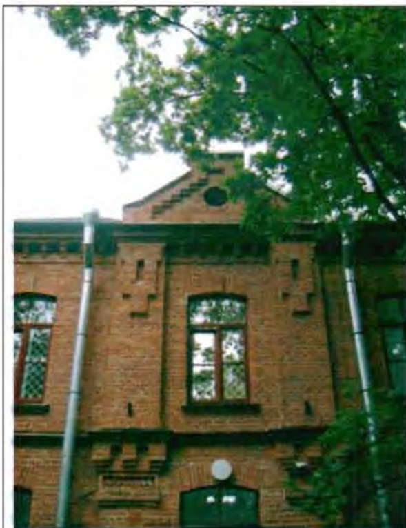
Фото 40. Восточный фасад. Фрагмент центральной части фасада.
