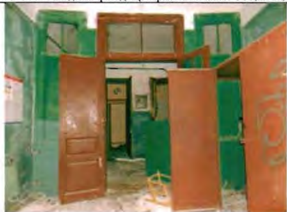
Фото 101. Дверной проем тамбура. Общий вид.
