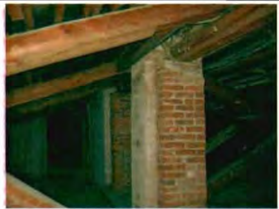
Фото 142. Конструкции крыши. Фрагмент.
