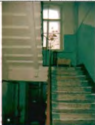
Фото 168. Лестница в южной части здания. Общий вид.
