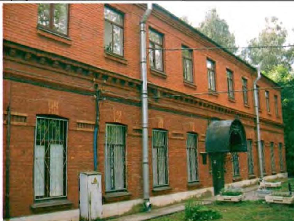
Фото 78. Западнй фасад. Общий вид.
