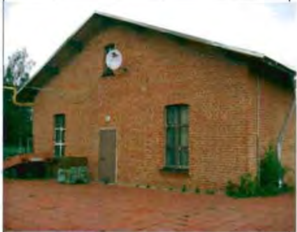
Фото 21. Южный фасад. Общий вид.
