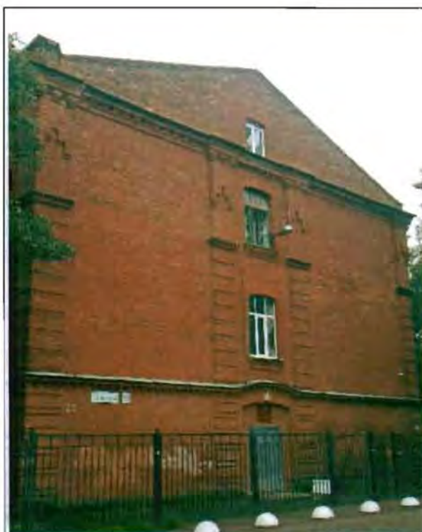
Фото 49. Северный фасад. Общий вид.
