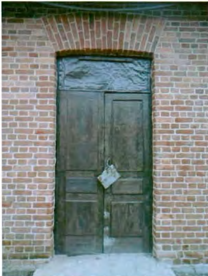
Исторический дверной проём (западный фасад). Съёмка 20.11.2012, Воронина Н.В.
