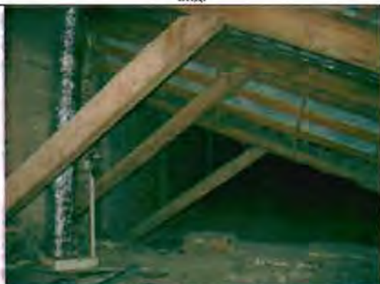
Фото 76. Конструкции крыши. Общий вид.
