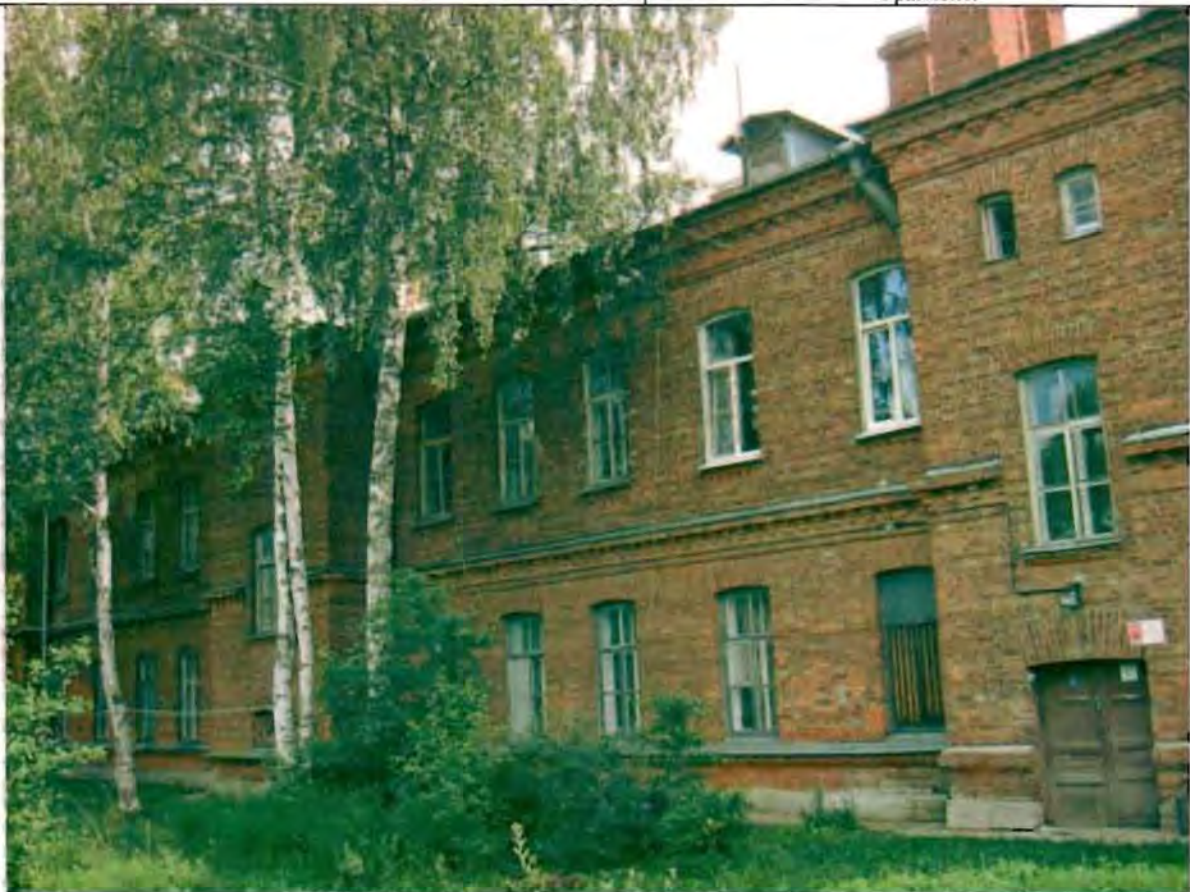
Фото 179. Западный фасад. Общий вид.
