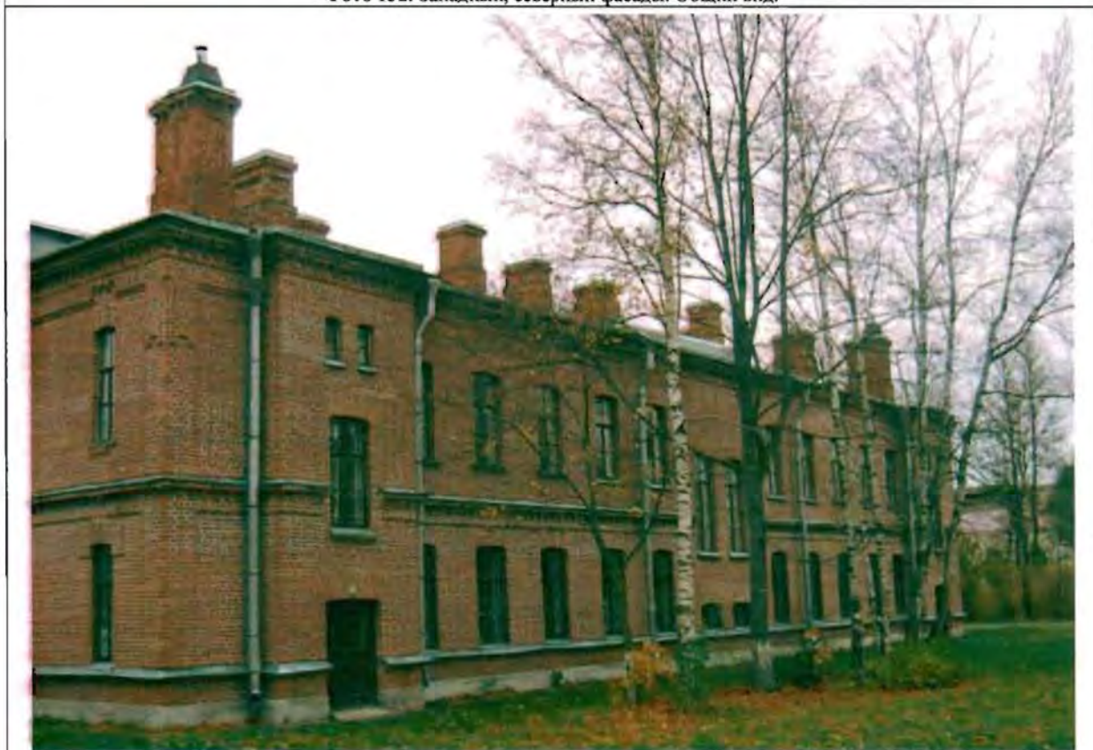
Фото 133. Восточный фасад. Общий вид.
