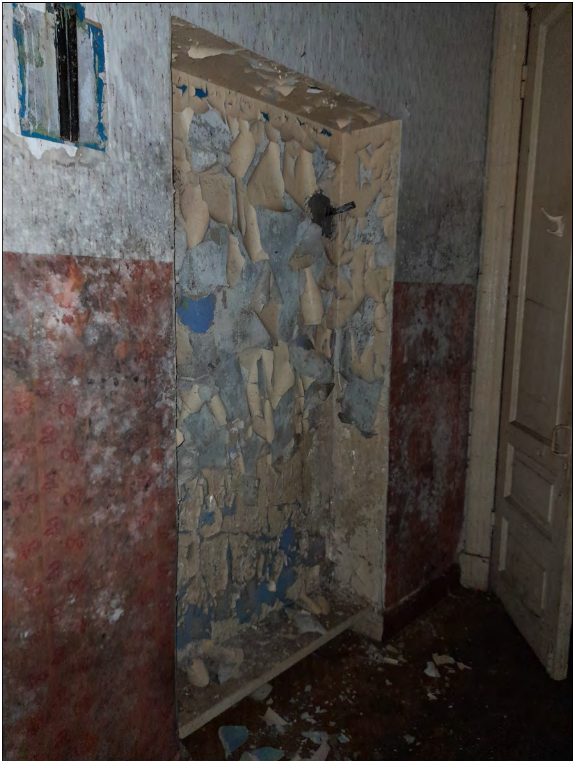
28. Объект культурного наследия «Казарма», в составе комплекса «Казармы 148-го пехотного Каспийского полка (с территорией)», расположенного по адресу: Санкт-Петербург, г. Петергоф, пер. Суворовцев, дом 8, литера А». 1-й этаж. Квартира № 1. Ниша в прихожей по оси Г. 25.05.2021 г.
