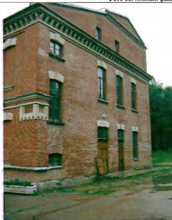
Фото 67. Западный фасад. Общий вид.
