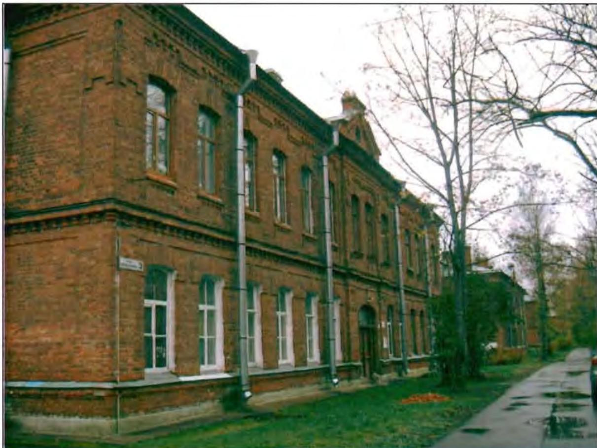
Фото 146. Западный фасад. Общий вид.
