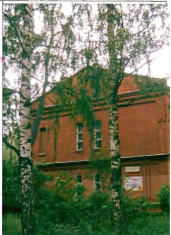
Фото 91. Северный фасад. Общий вид.
