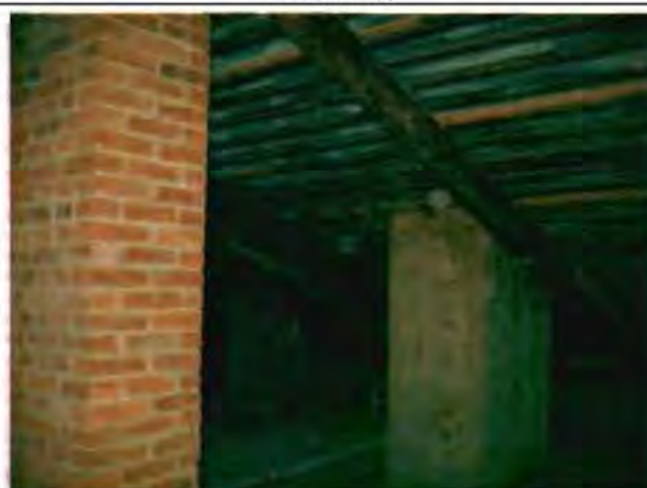
Фото 152. Конструкции крыши. Фрагмент.
