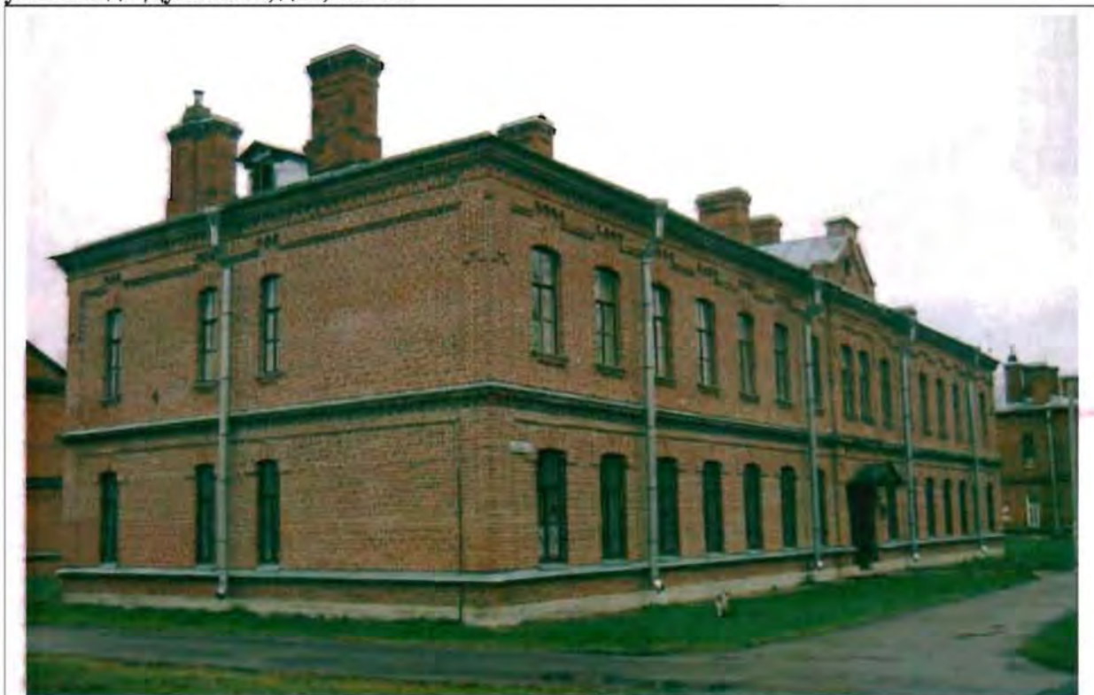
Фото 132. Западный, северный фасады. Общий вид.
