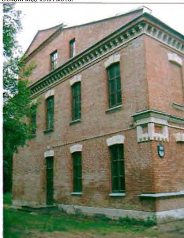
Фото 68. Восточный фасад. Общий вид.
