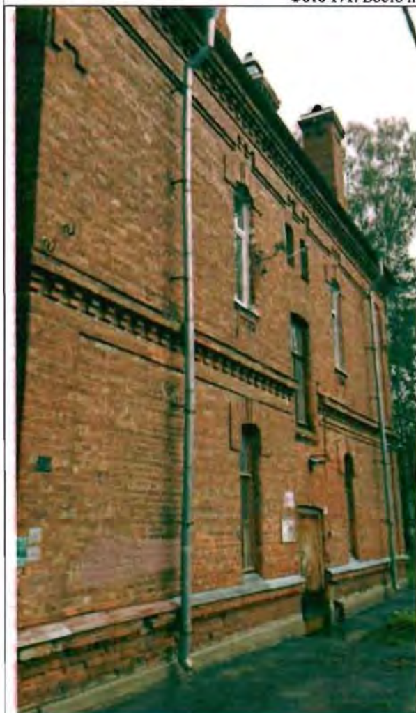
Фото 172. Южный фасад. Общий вид.
