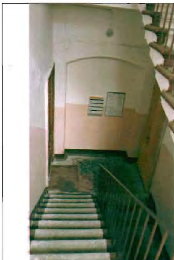
Фото 130. Лестница № 1 в южной части здания. Общий вид.
