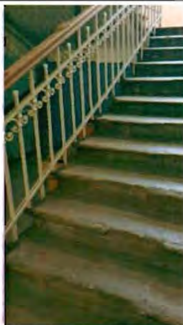
Фото 57. Лестница в центральной части здания. Фрагмент.
