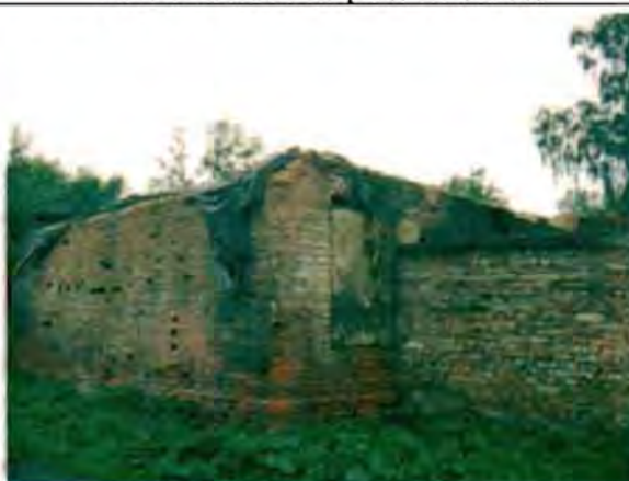
Фото 187. Северный фасад. Общий вид.
