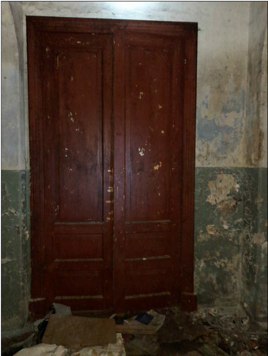
17. Объект культурного наследия «Казарма», в составе комплекса «Казармы 148-го пехотного Каспийского полка (с территорией)», расположенного по адресу: Санкт-Петербург, г. Петергоф, пер. Суворовцев, дом 8, литера А». 1-й этаж. Парадная лестница в осях 5-6. Вход в Вход в квартиру № 6. 25.05.2021 г.
