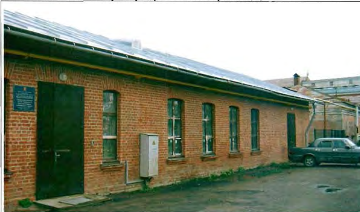
Фото 18. Западный фасад. Общий вид.
