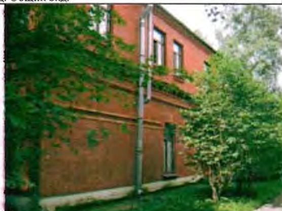
Фото 80. Северный фасад. Фрагмент.
