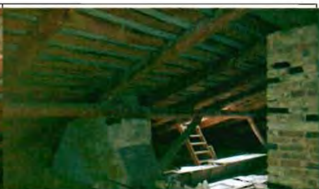
Фото 63. Конструкции крыши. Общий вид.
