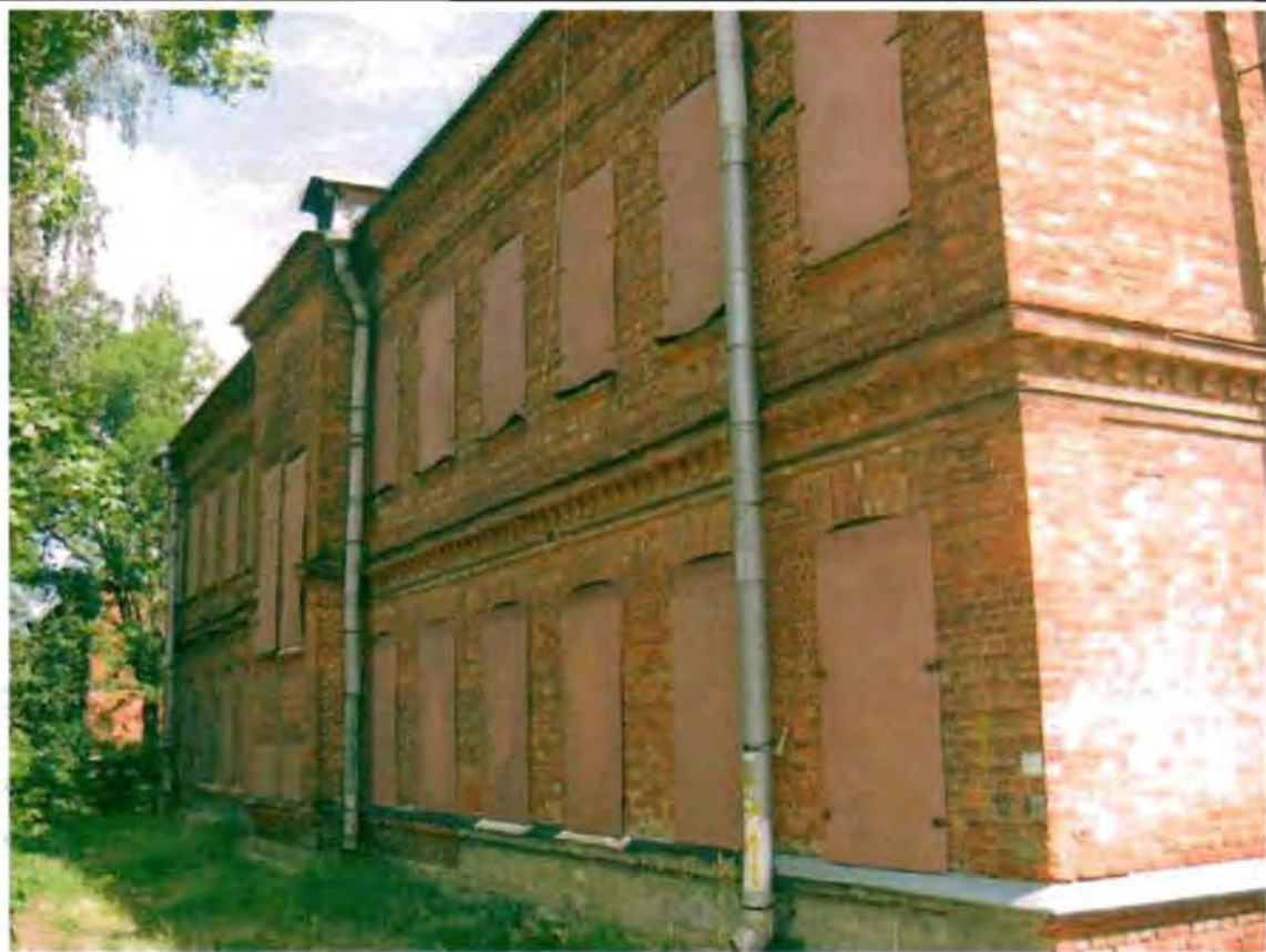
Фото 119. Западный фасад. Общий вид.
