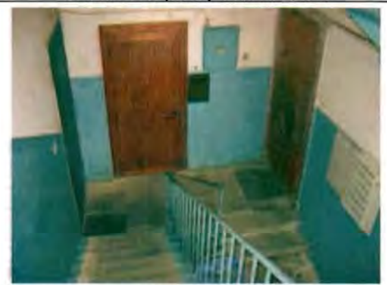
Фото 162. Лестница № 2 в северной части здания. Фрагмент.
