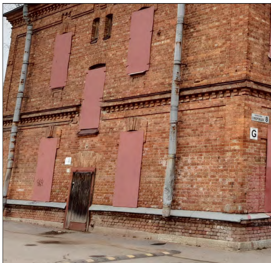
11. Объект культурного наследия «Казарма», в составе комплекса «Казармы 148-го пехотного Каспийского полка (с территорией)», расположенного по адресу: Санкт-Петербург, г. Петергоф, пер. Суворовцев, дом 8, литера А». Южный фасад. Вид на северо-запад. 25.05.2021 г.
