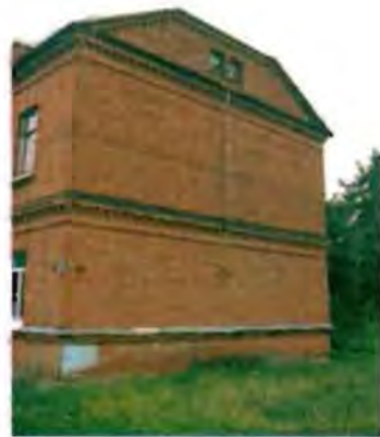
Фото 86. Западный фасад. Общий вид.
