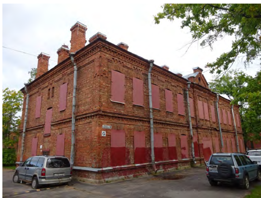
2. Объект культурного наследия «Казарма», в составе комплекса «Казармы 148-го пехотного Каспийского полка (с территорией)», расположенного по адресу: Санкт-Петербург, г. Петергоф, пер. Суворовцев, дом 8, литера А». Восточный фасад. Вид на северо-запад. 25.05.2021 г.
