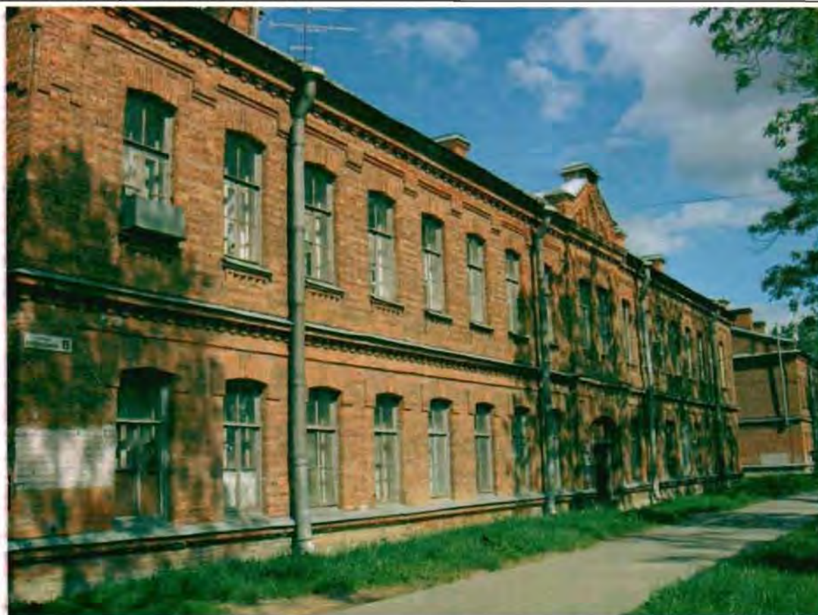
Фото 176. Восточный фасад. Общий вид.
