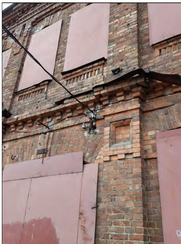
4. Объект культурного наследия «Казарма», в составе комплекса «Казармы 148-го пехотного Каспийского полка (с территорией)», расположенного по адресу: Санкт-Петербург, г. Петергоф, пер. Суворовцев, дом 8, литера А». Фрагмент центральной части восточного фасада. Ввод сети электроснабжения у оси А/6. Вид на запад. 25.05.2021 г.
