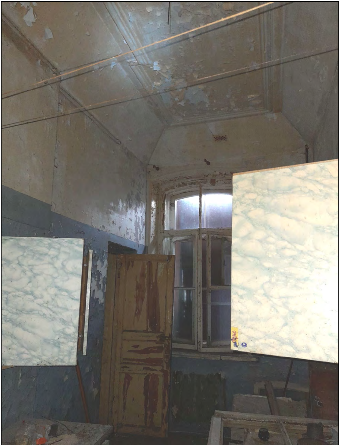
45. Объект культурного наследия «Казарма», в составе комплекса «Казармы 148-го пехотного Каспийского полка (с территорией)», расположенного по адресу: Санкт-Петербург, г. Петергоф, пер. Суворовцев, дом 8, литера А». 2-й этаж. Квартира № 8. Кухня в осях 8-9. 25.05.2021 г.
