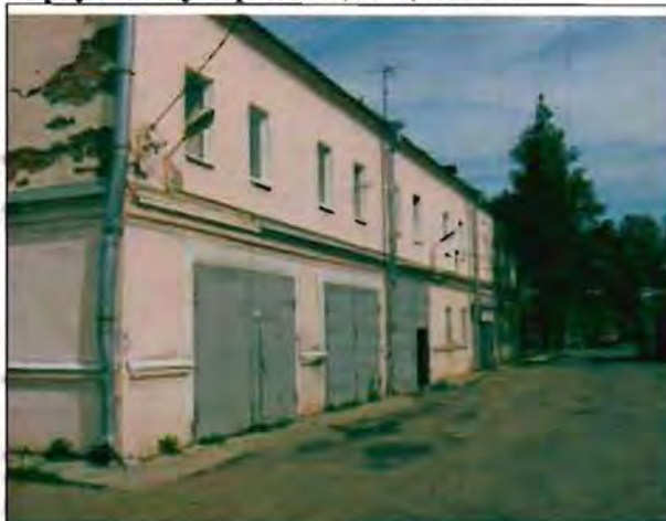
Фото 110. Восточный фасад. Общий вид.
