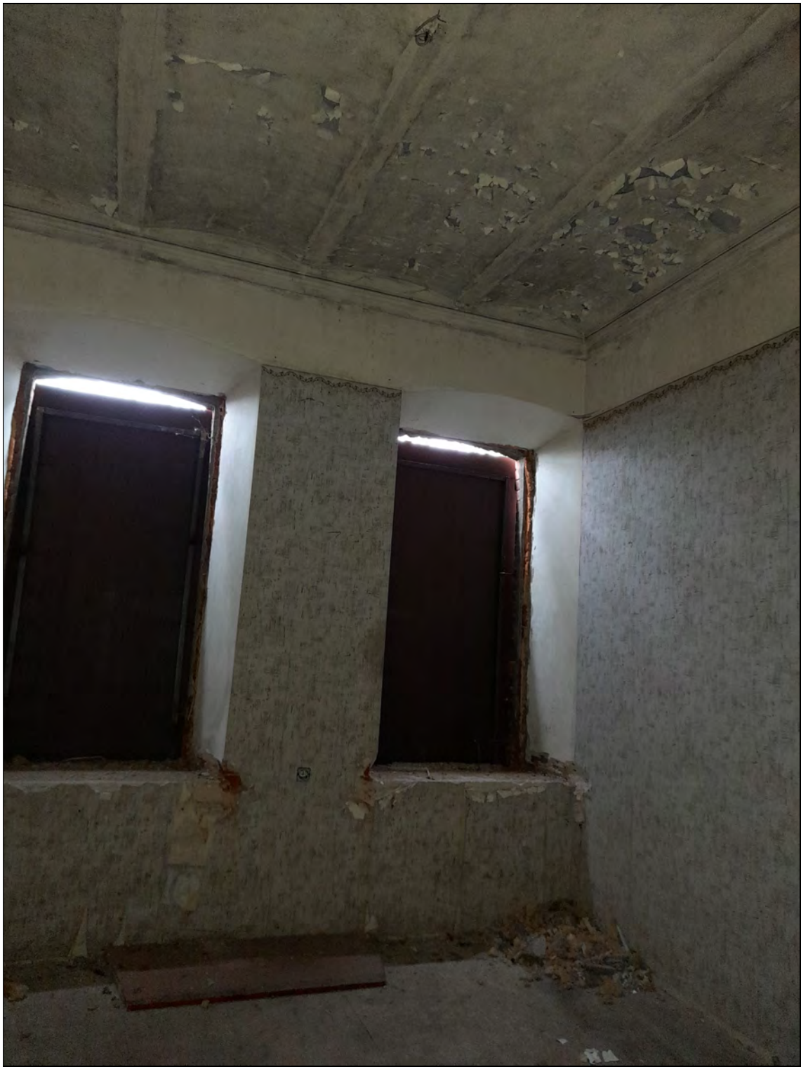
30. Объект культурного наследия «Казарма», в составе комплекса «Казармы 148-го пехотного Каспийского полка (с территорией)», расположенного по адресу: Санкт-Петербург, г. Петергоф, пер. Суворовцев, дом 8, литера А». 1-й этаж. Квартира № 5. Комната в осях 6-7. 25.05.2021 г.
