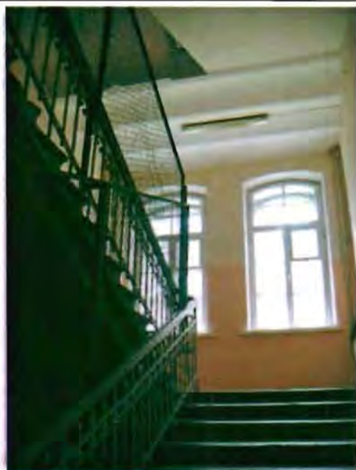
Фото 56. Лестница в центральной части здания. Фрагмент.
