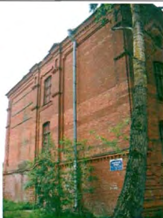
Фото 6. Северный фасад. Общий вид.
