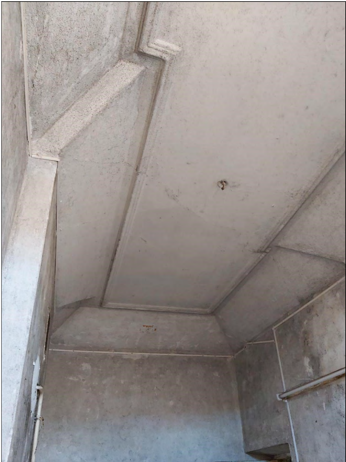
41. Объект культурного наследия «Казарма», в составе комплекса «Казармы 148-го пехотного Каспийского полка (с территорией)», расположенного по адресу: Санкт-Петербург, г. Петергоф, пер. Суворовцев, дом 8, литера А». 2-й этаж. Квартира № 3. Кухня в осях 2-3. 25.05.2021 г.
