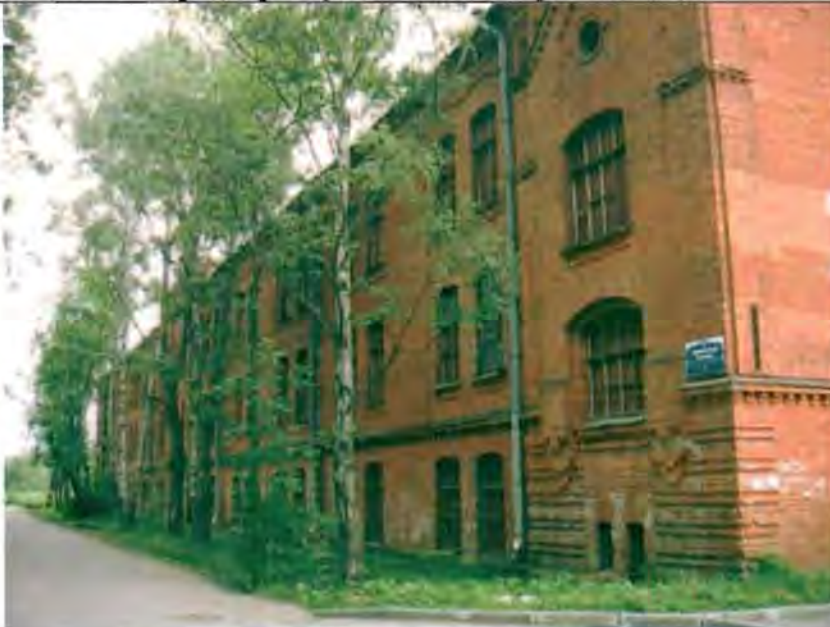
Фото 1. Западный фасад. Общий вид.
