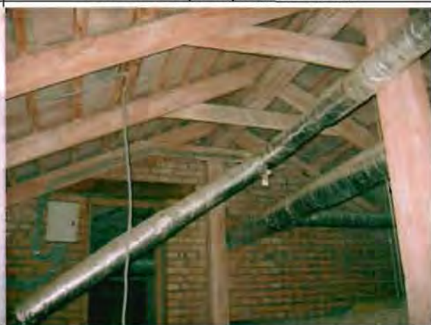
Фото 115. Конструкции крыши. Фрагмент.
