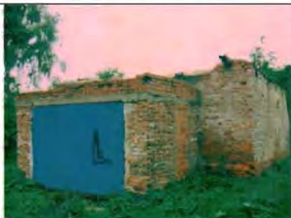
Фото 185. Восточный фасад. Общий вид.
