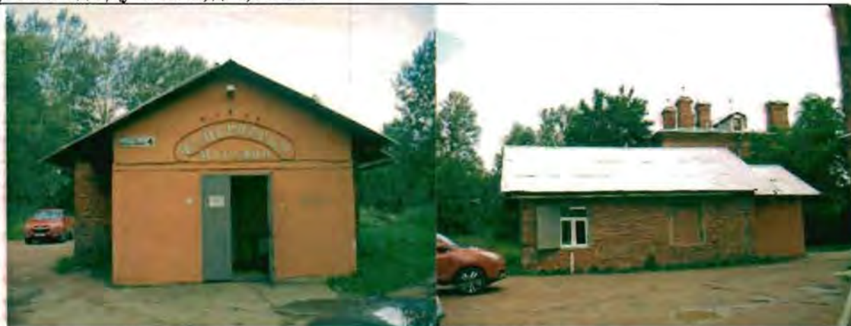
Фото 153. Восточный фасад. Общий вид.
