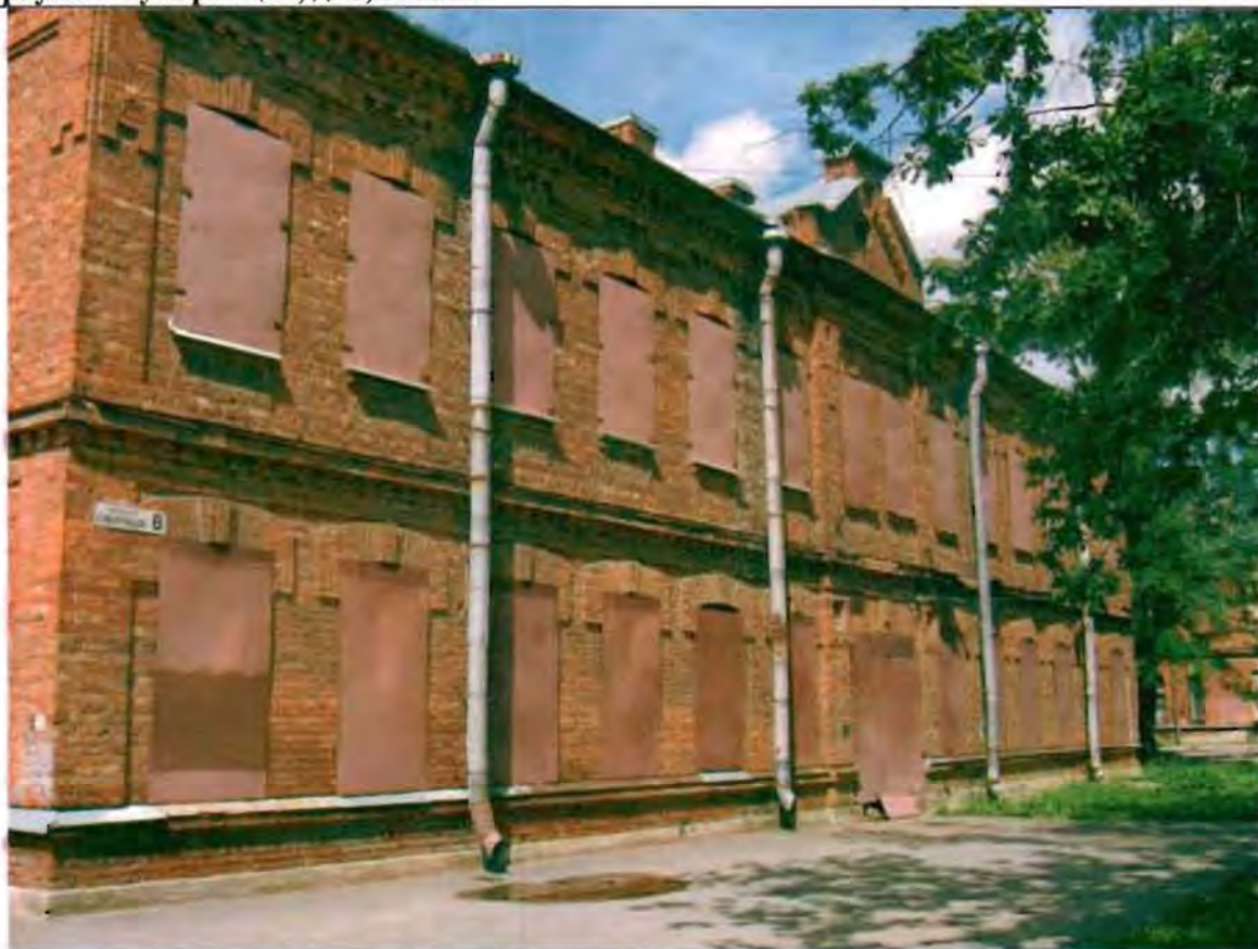
Фото 116. Восточный фасад. Общий вид.
