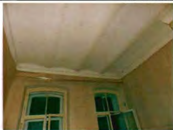
Фото 120. Помещение 1-го этажа. Общий вид.
