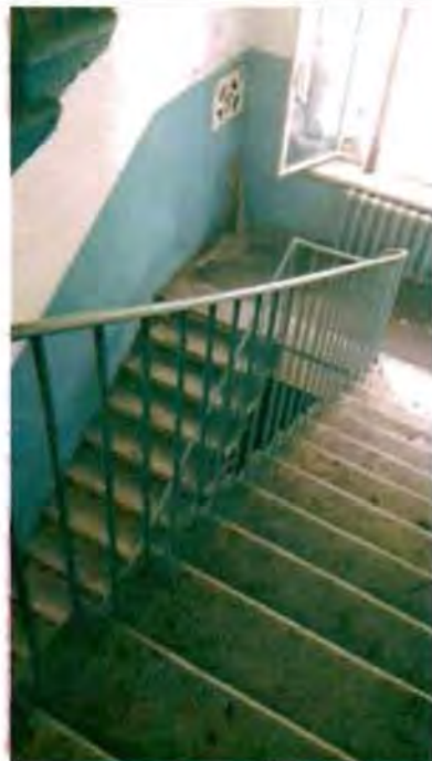
Фото 144. Лестница № 2 в южной части здания. Общий вид.
