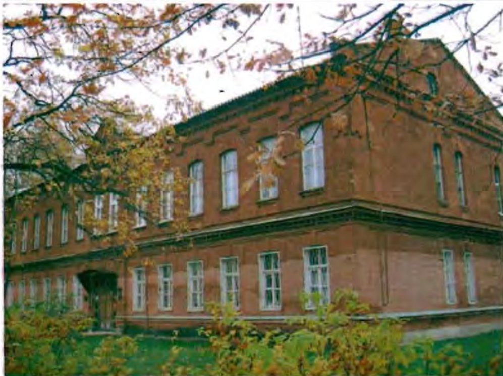
Фото 89. Западный, южный фасады. Общий вид.
