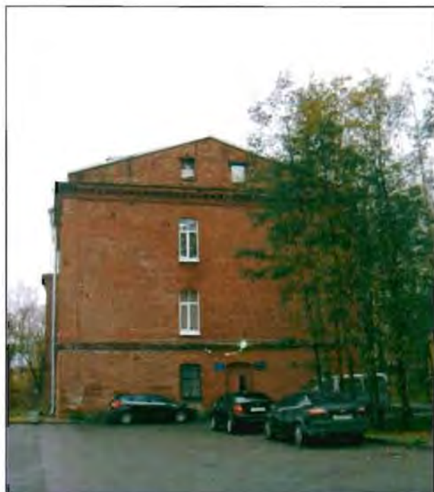
Фото 15. Северный фасад. Общий вид.
