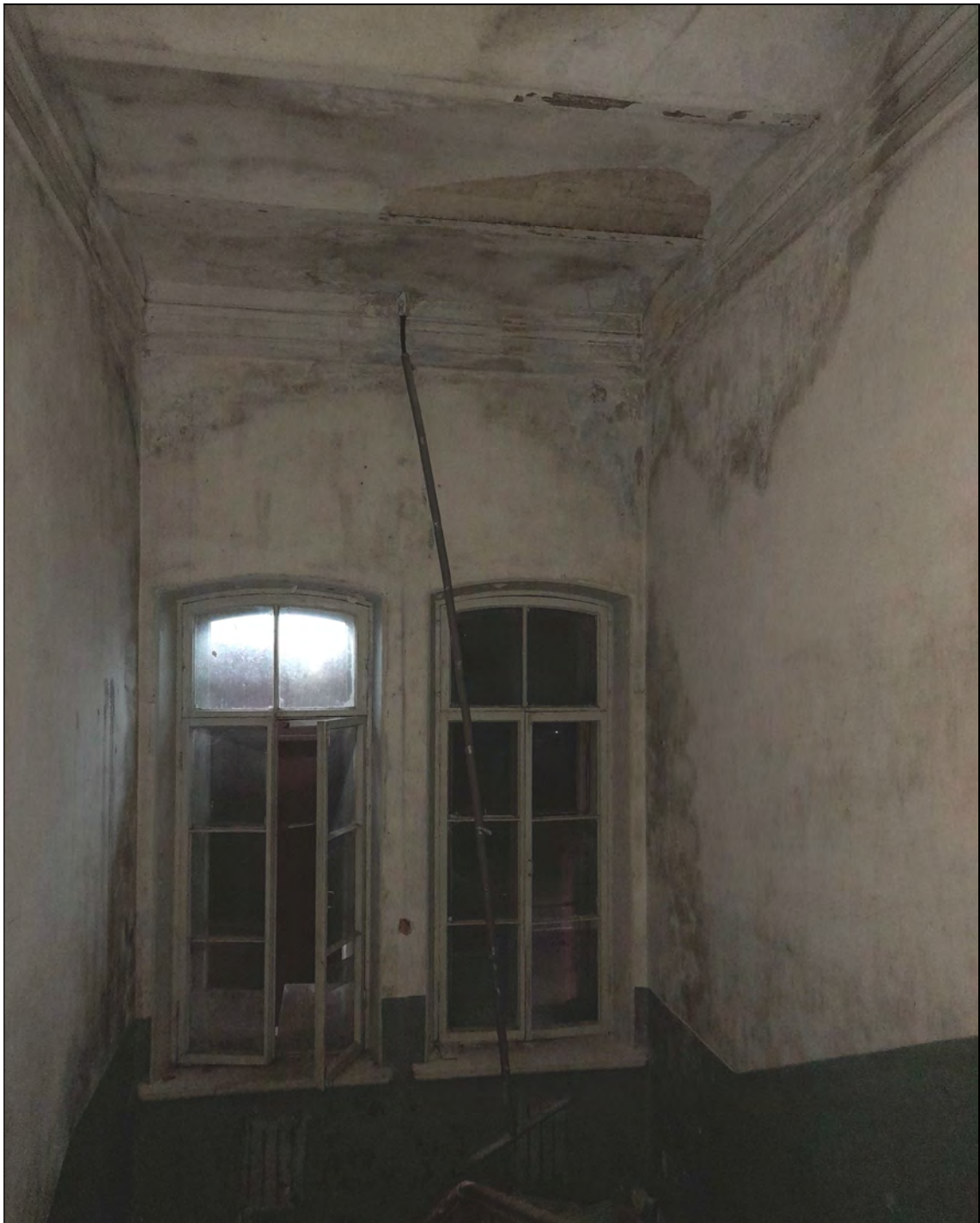
33. Объект культурного наследия «Казарма», в составе комплекса «Казармы 148-го пехотного Каспийского полка (с территорией)», расположенного по адресу: Санкт-Петербург, г. Петергоф, пер. Суворовцев, дом 8, литера А». 2-й этаж. Парадная лестница в осях 5-6. Оконные проемы. 25.05.2021 г.
