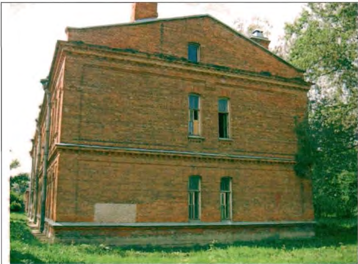
Фото 180. Северный фасад. Общий вид.
