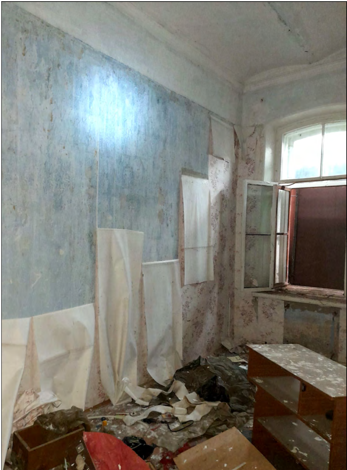
32. Объект культурного наследия «Казарма», в составе комплекса «Казармы 148-го пехотного Каспийского полка (с территорией)», расположенного по адресу: Санкт-Петербург, г. Петергоф, пер. Суворовцев, дом 8, литера А». 1-й этаж. Квартира № 6. Комната в осях 6-7. 25.05.2021 г.
