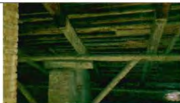
Фото 38. Конструкции крыши. Фрагмент.
