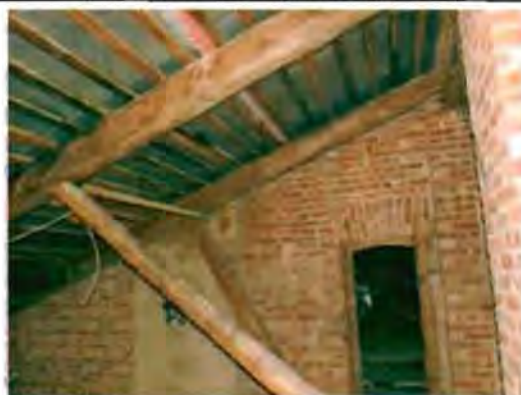
Фото 127. Конструкции крыши. Общий вид.
