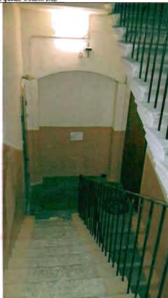
Фото 173. Лестница № 1 в северной части здания. Фрагмент.
