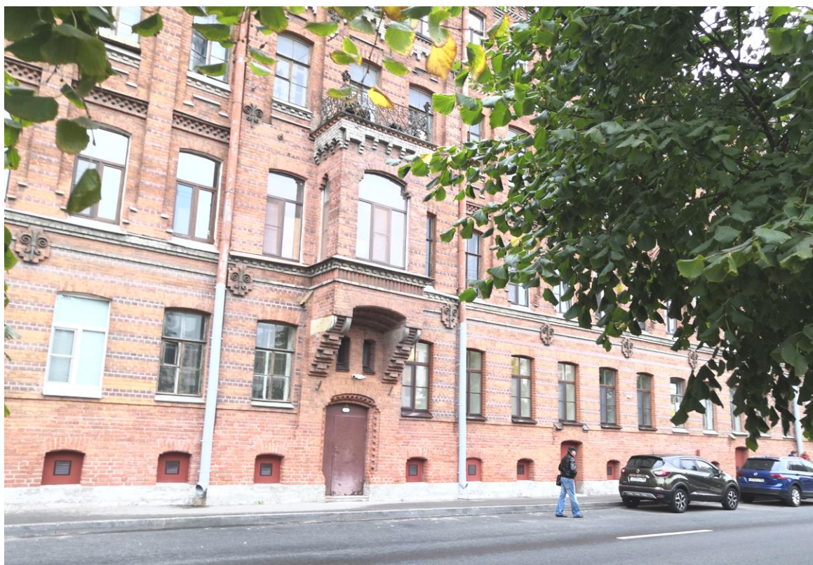
Фото 6. Фрагмент лицевого (южного) фасада по наб. р. Фонтанки. Вид с юго-запада.
