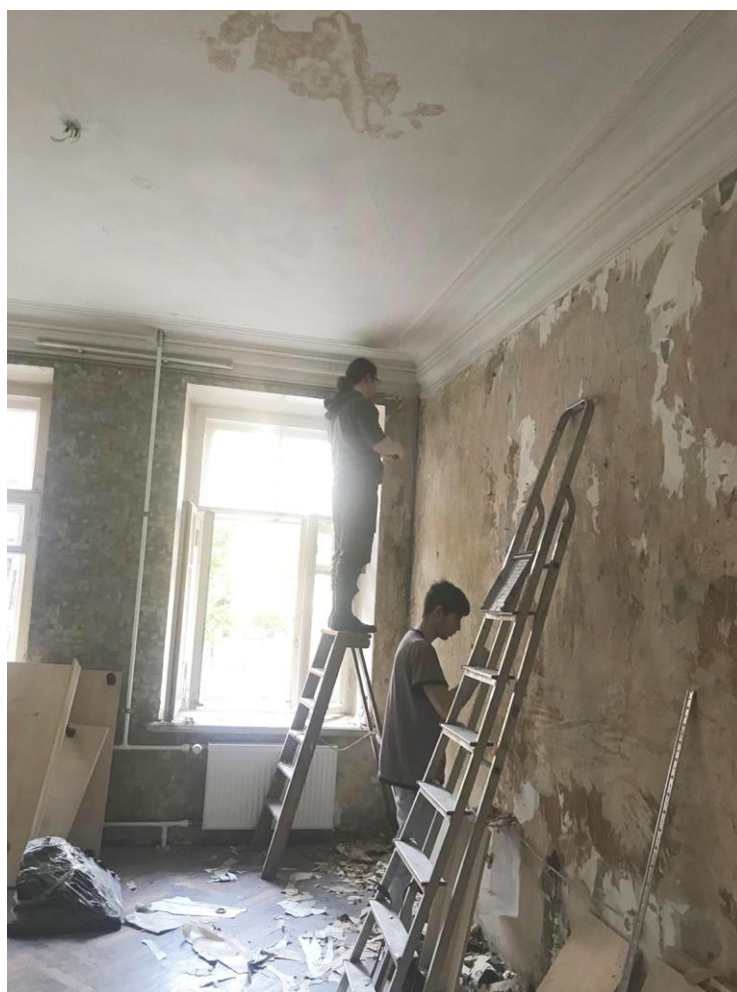
Фото 22. Помещение (комната) 3. Вид в сторону окон.
