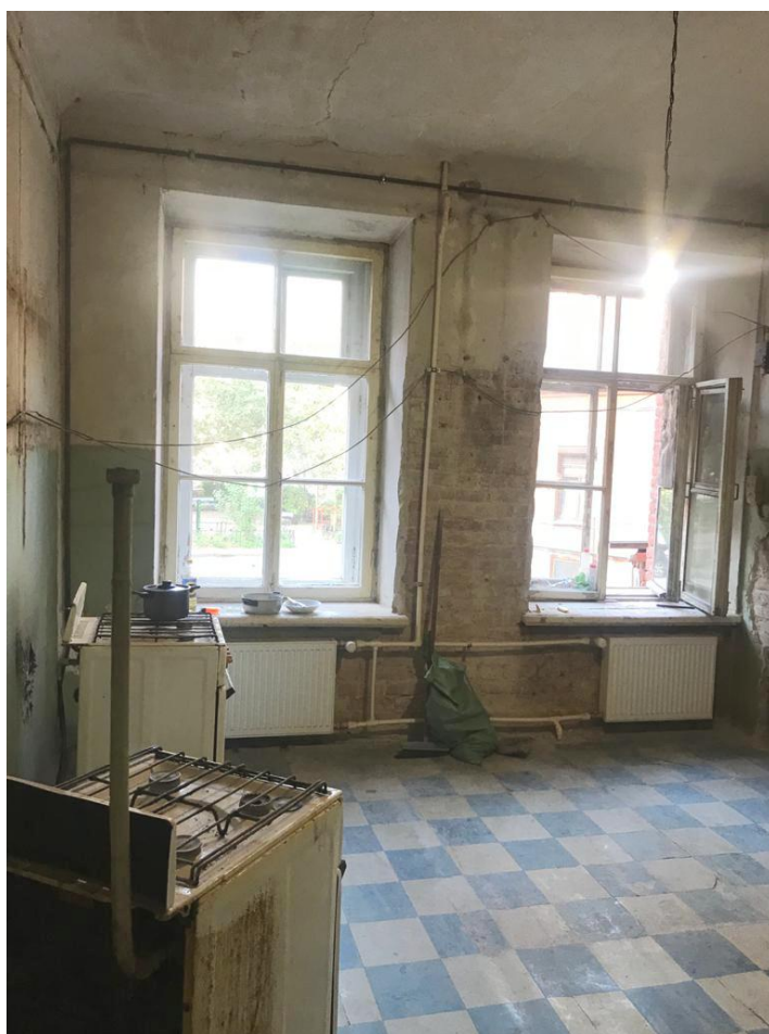
Фото 23. Кухня (помещение 4). Вид в сторону окон.
