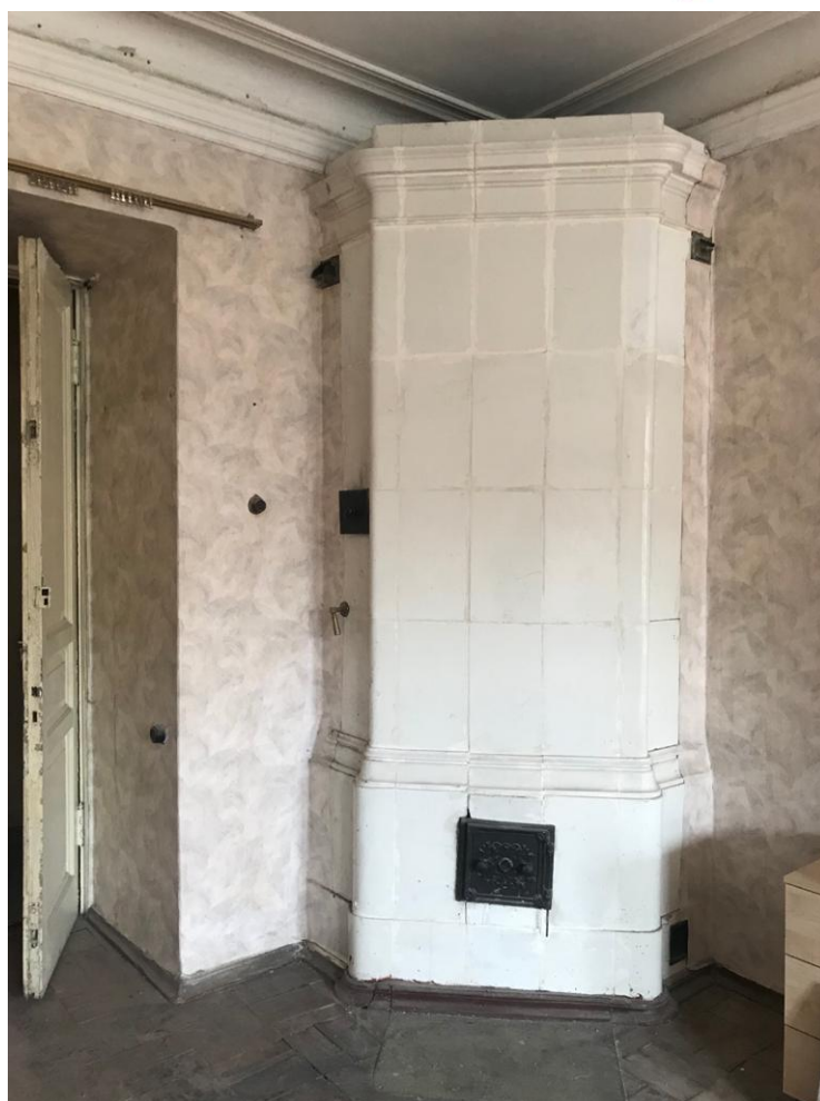
Фото 29. Угловая печь в помещении 9.
