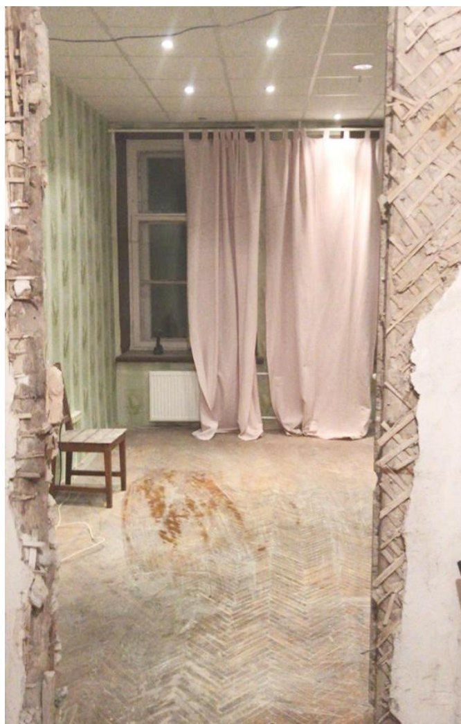
Фото 20. Помещение 2 до демонтажа перегородки между помещениями 1 и 2.
