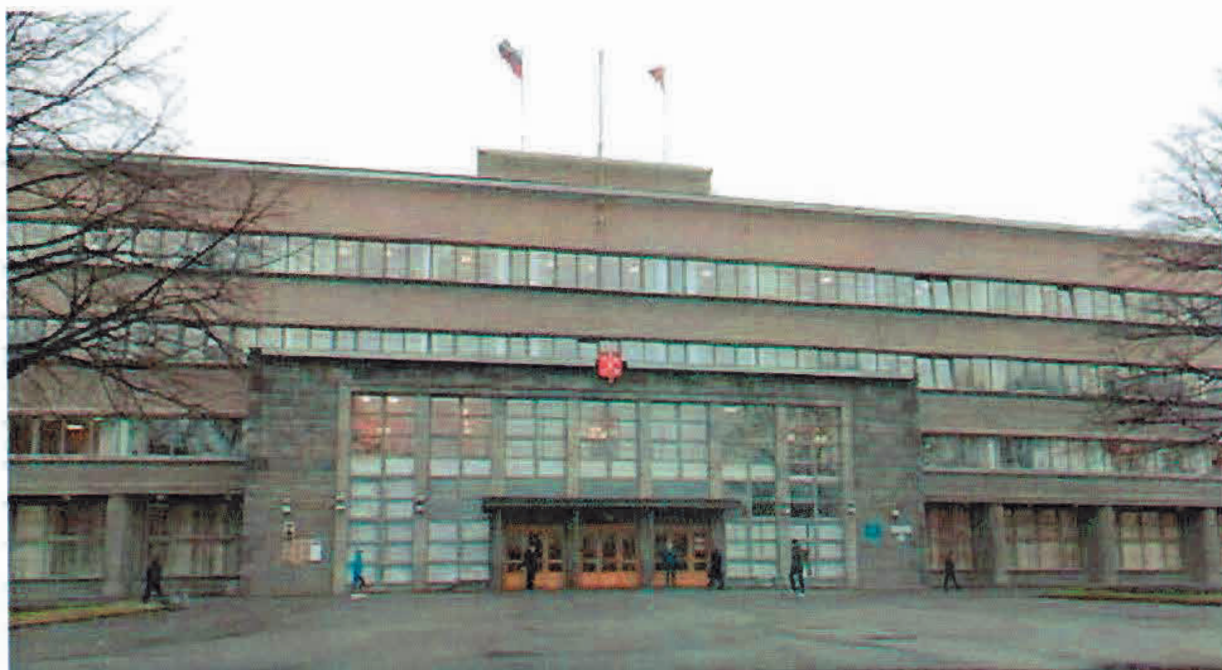
1. Лицевой фасад основного объема. Главный вход
