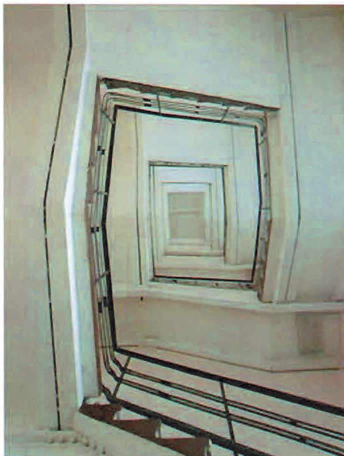
14. Угловая башня. Лестница
