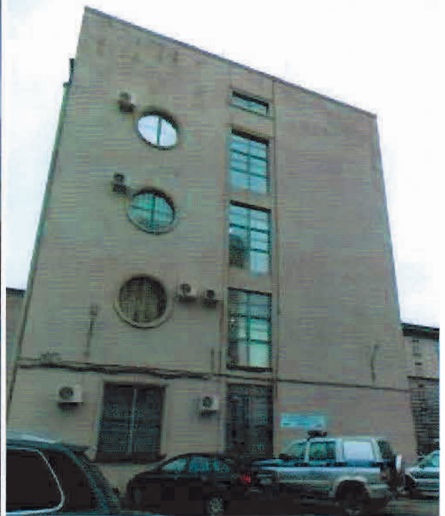
6. Основной объем. Торцевой фасад
