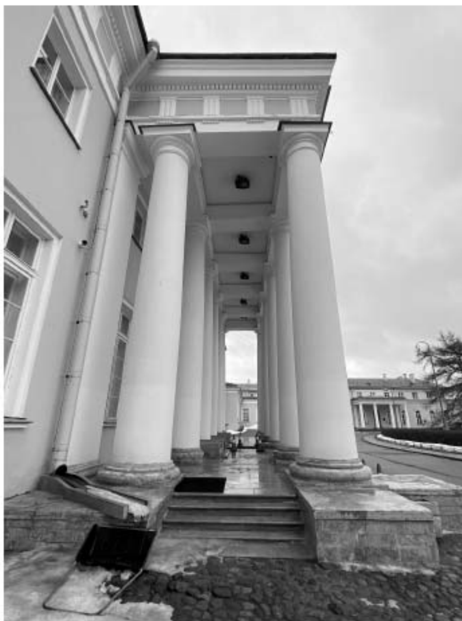
4. Колоннада центрального портика Парадного двора объекта культурного наследия федерального значения «Дворец Таврический. Дворец». 01.12.2020
