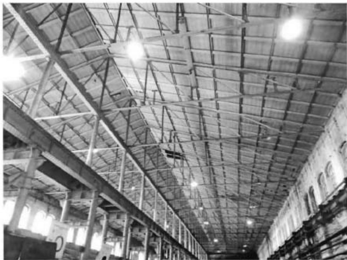
11. Интерьеры. Строение 5 (литера АЕ).
