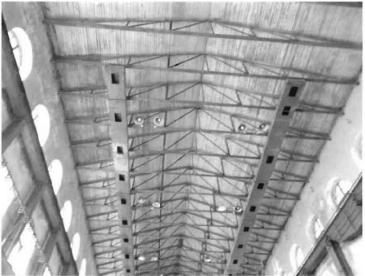
4. Интерьер. Металлические фермы, подкрановые балки и колонны крановой эстакады.
