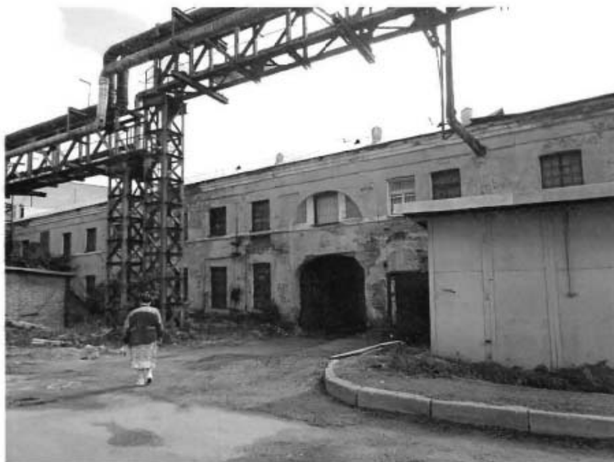
5. Фрагмент северо-западного фасада.
