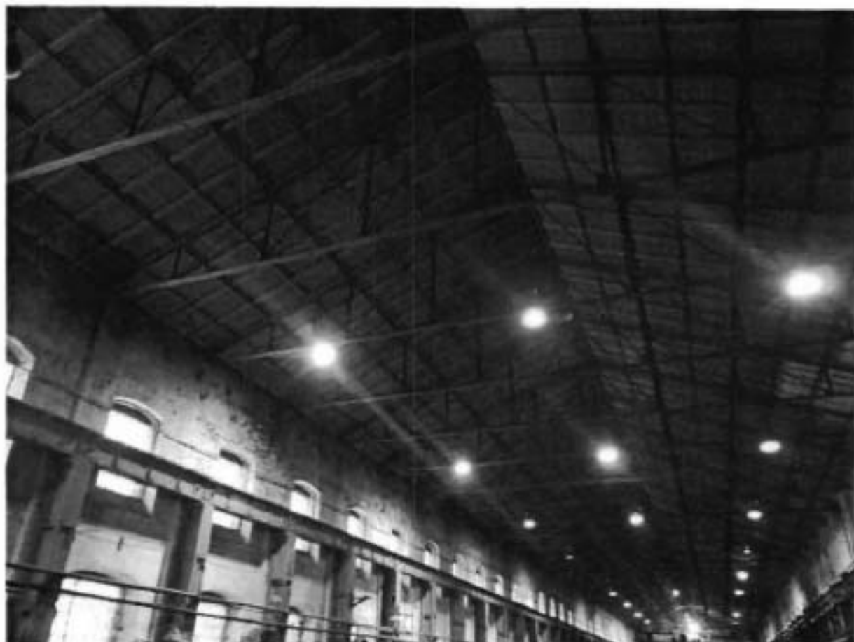
12.Интерьеры. Строение 5 (литера АЕ).
