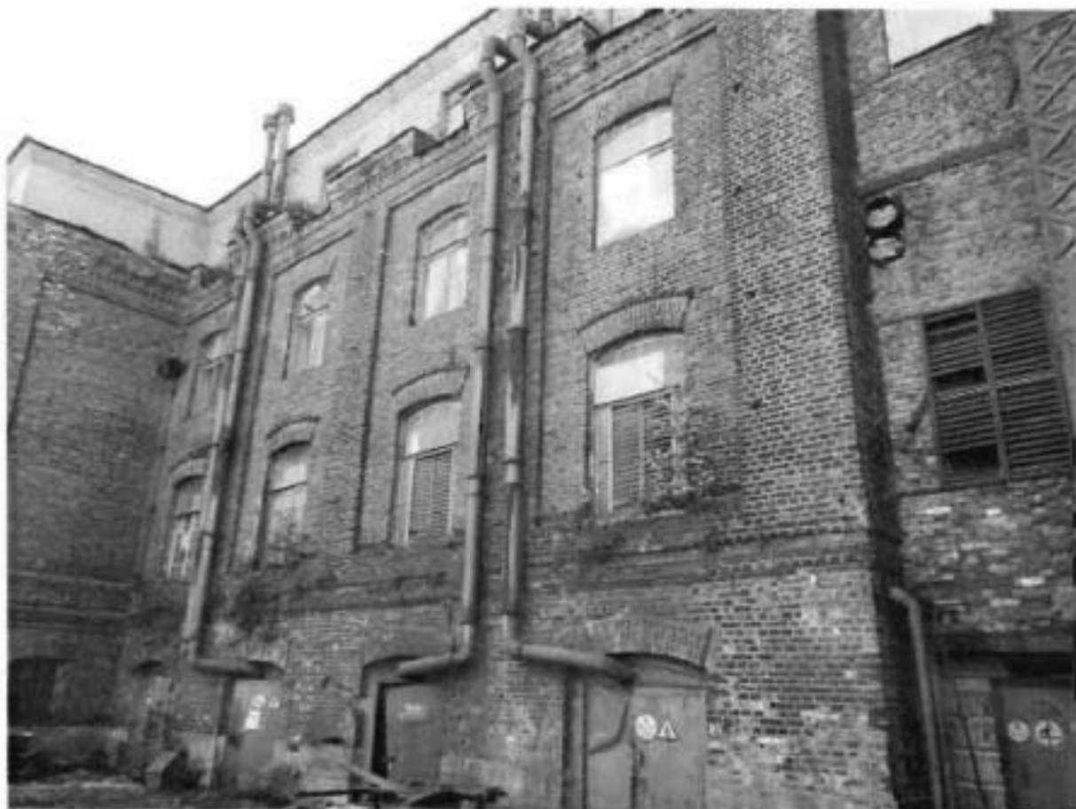
3. Северный фасад. Литера АМ.
