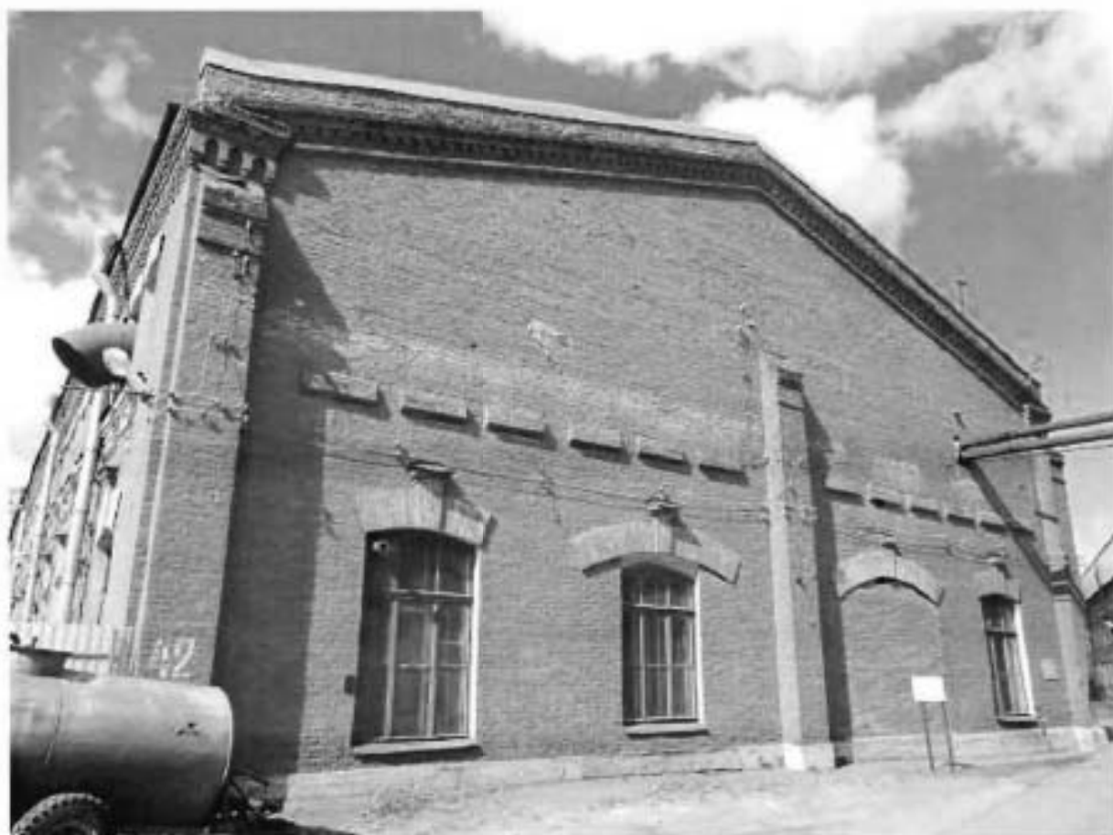
9. Восточный фасад. Строение 5 (литера АЕ).
