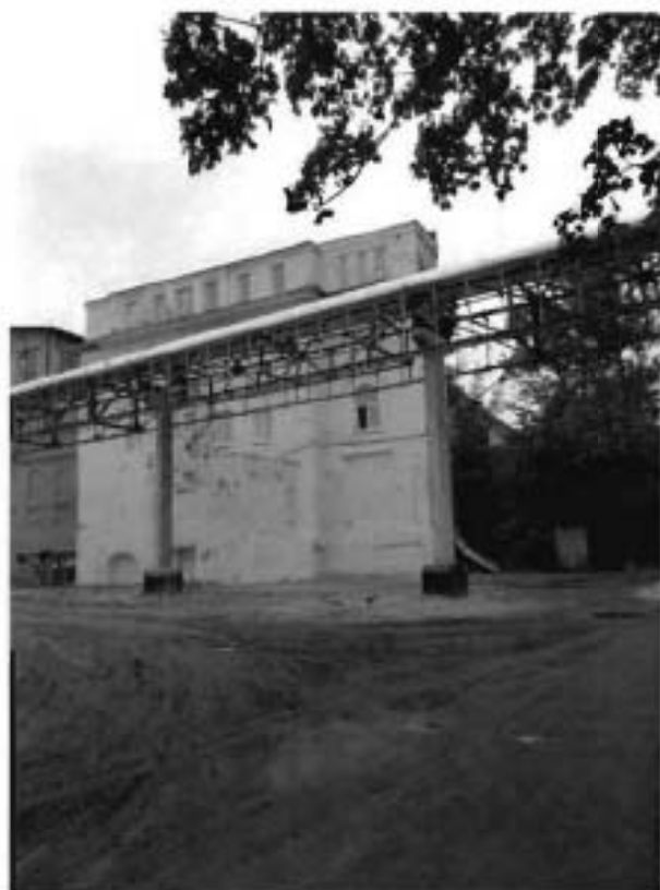
2. Южный фасад объекта культурного наследия.
