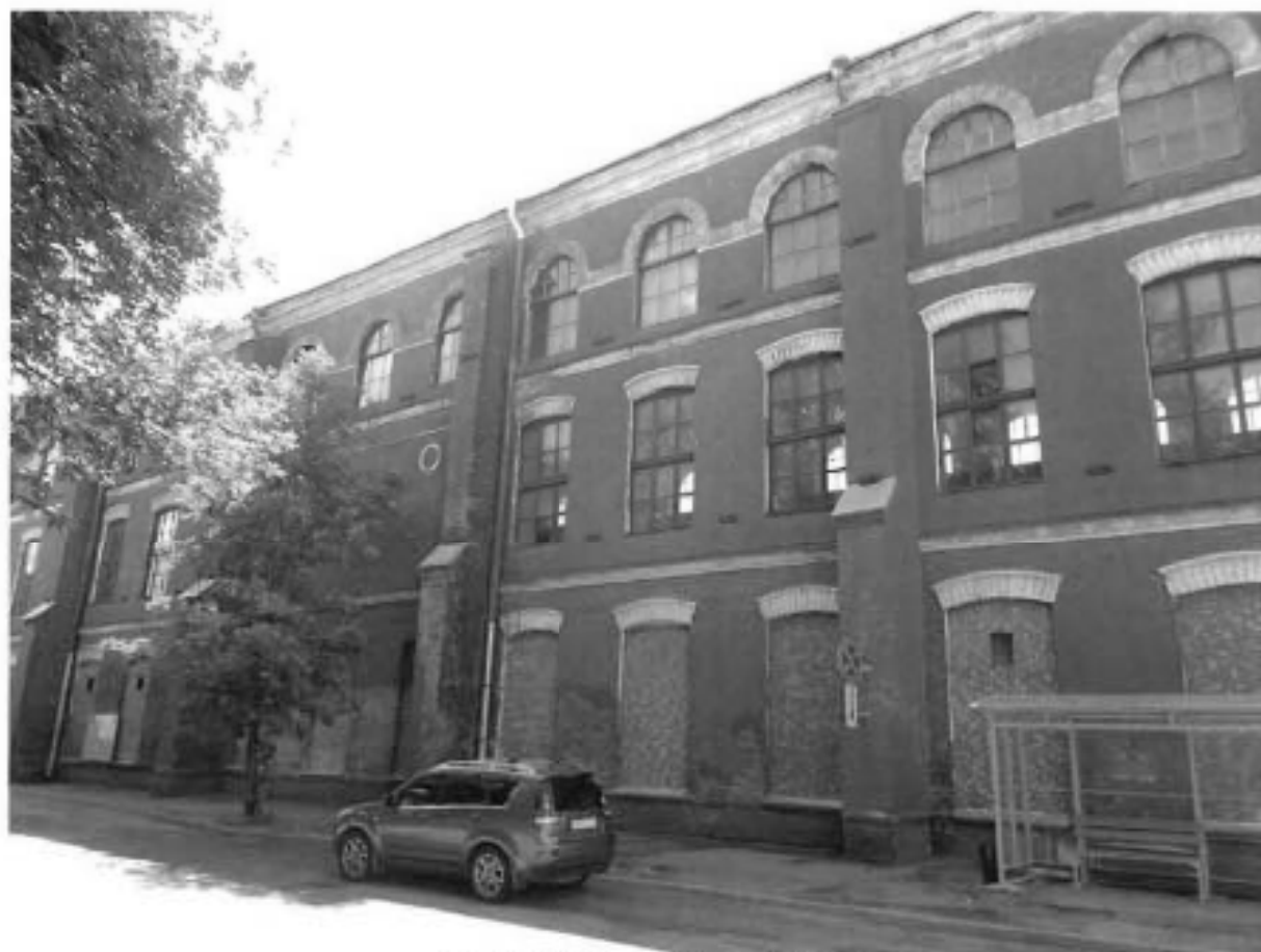
1. Фрагмент северного фасада.
