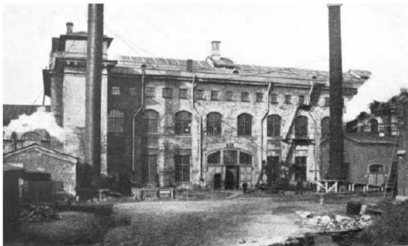
Ил.34. Здание станочной мастерской, часть восточного фасада, примыкающего к зданию бывшей карточной фабрики (в 1912 г. – пожарная часть, водоканал, училище и квартиры сторожей). 1912 г. Каптерев Н.А.
