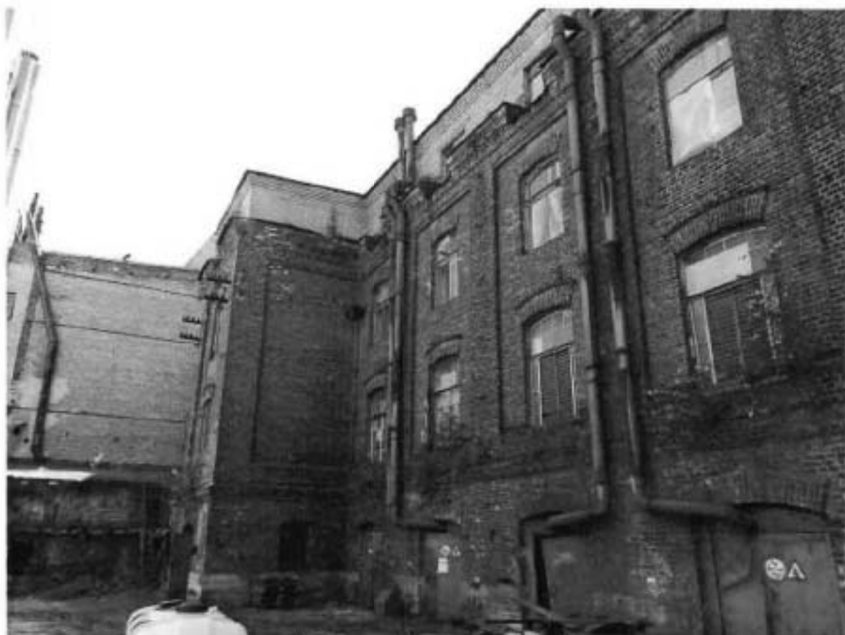
4. Северный фасад. Литера АМ.
