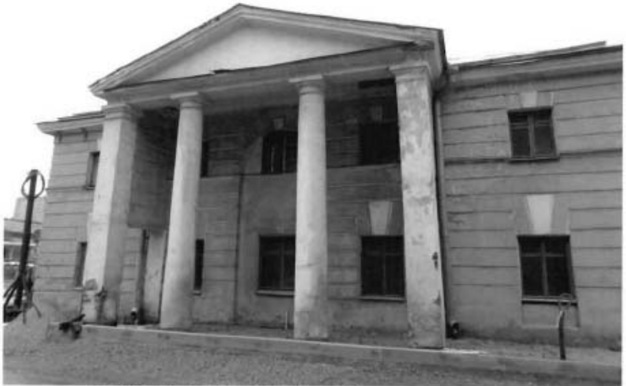
1. Фрагмент юго-западного фасада объекта культурного наследия. Северо-западный портик.
