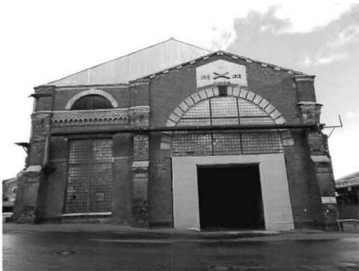
8. Восточный фасад. Строение 5 (литера АЕ).
