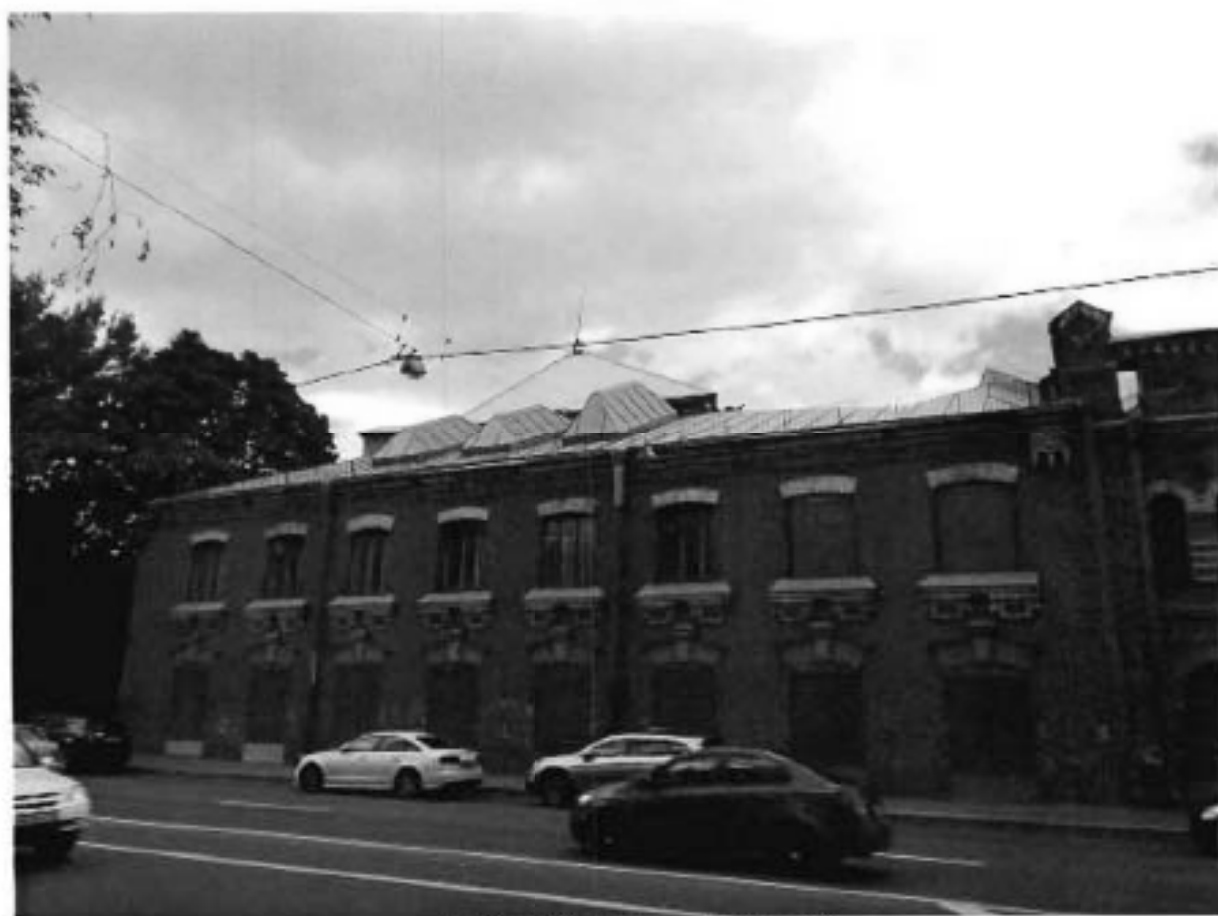
1. Южный фасад. Литера АМ.
