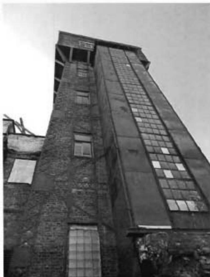
5. Северо-восточная башня. Литера АМ.
