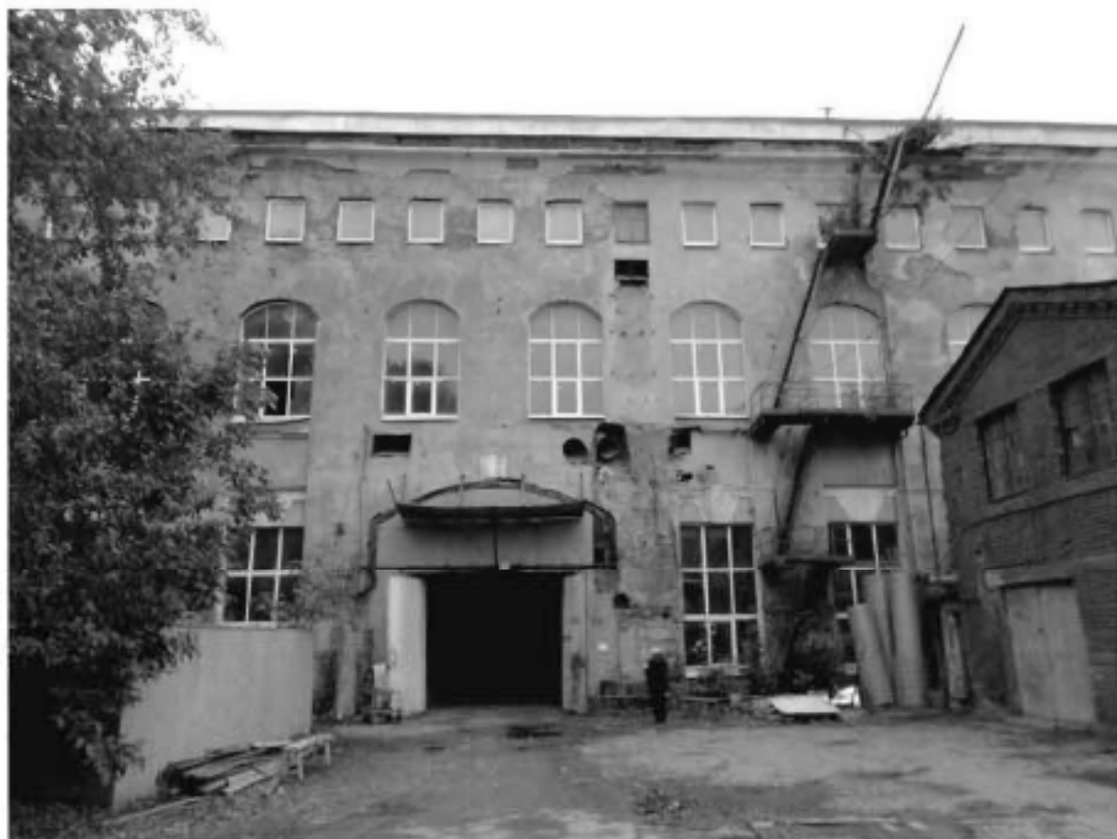
1. Фрагмент восточного фасада объекта культурного наследия.
