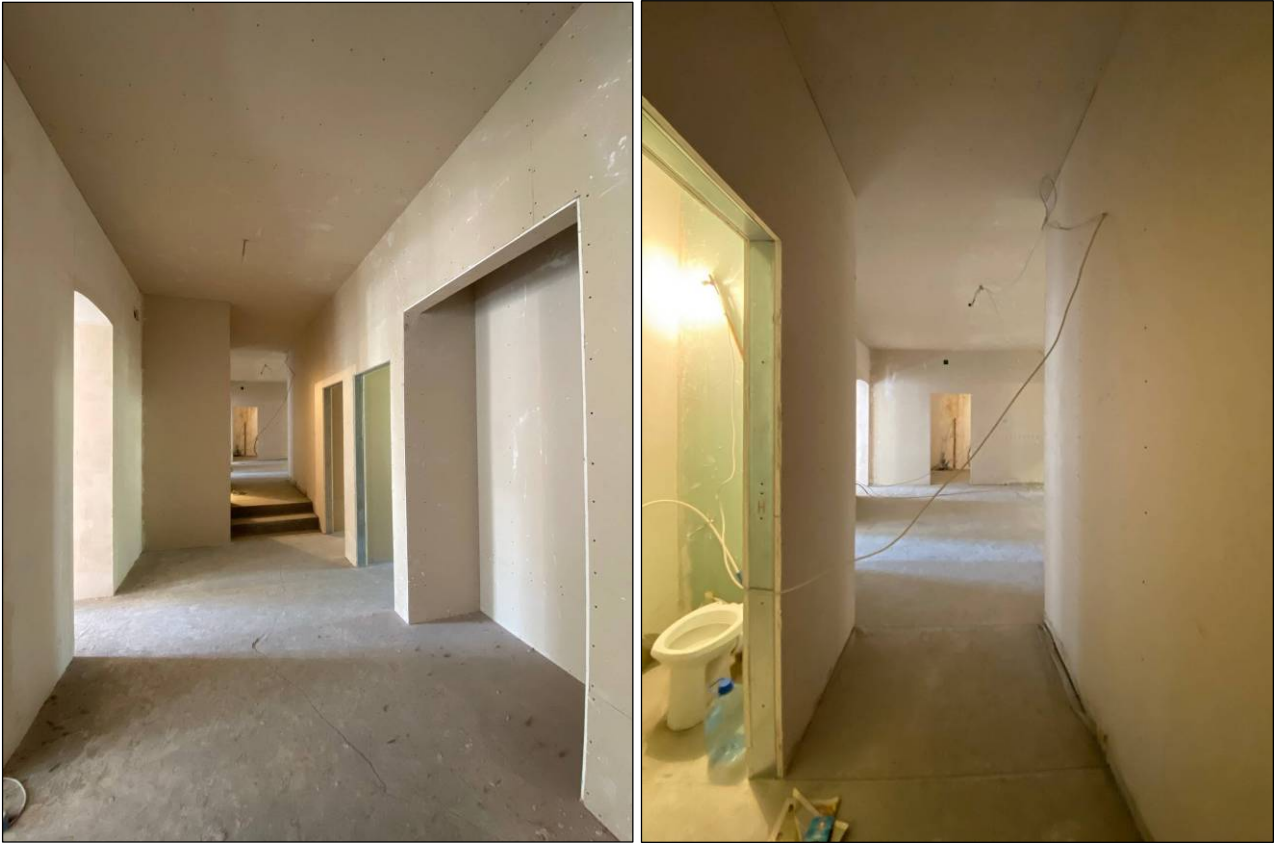
4. Третий этаж, квартира № 4. Восточная часть холла пом. 1 (50,4 м 2 )*.
