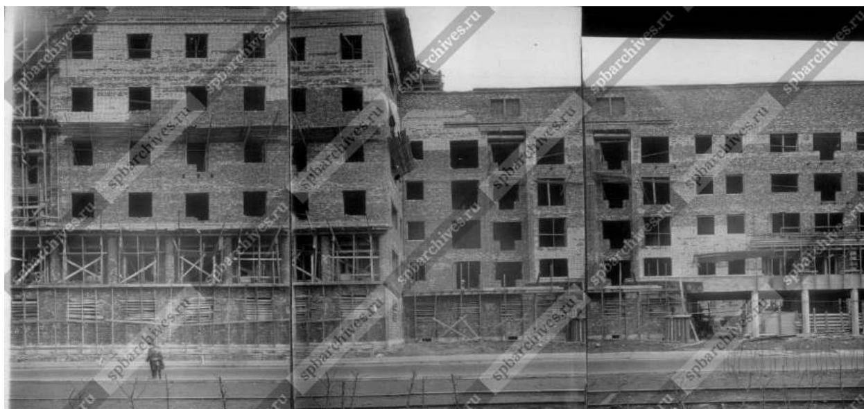
Илл. 7. Вид части фасада дома №61 корп.1 (лит.А) на Лесном проспекте на этапе строительства (панорама из 3-х снимков). Фото 1934 г. ЦГАКФФД СПб. Вр 43262.
