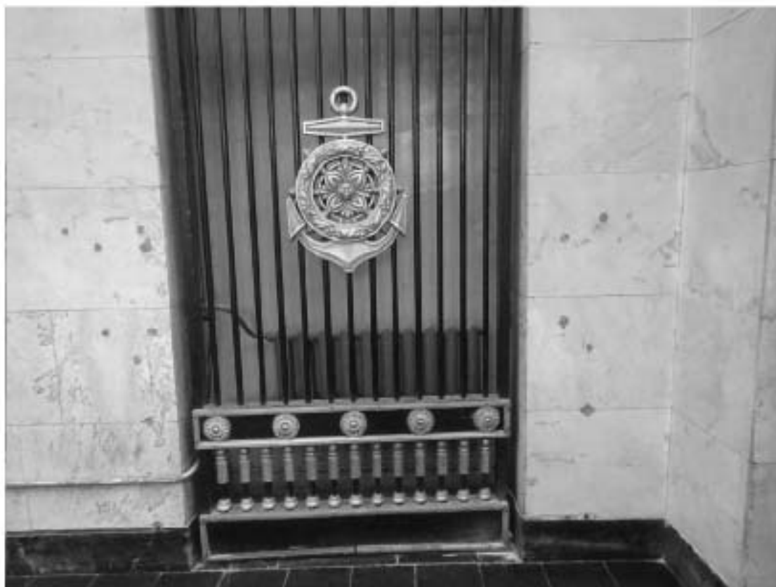
Фото 29. Объект культурного наследия регионального значения «Станция метро «Балтийская» (с перронным залом)». Вид части кассового зала. Решетка.
