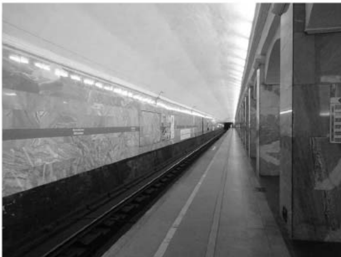
Фото 3. Объект культурного наследия регионального значения «Станция метро «Балтийская» (с перронным залом)». Перронный зал. Вид путей.
