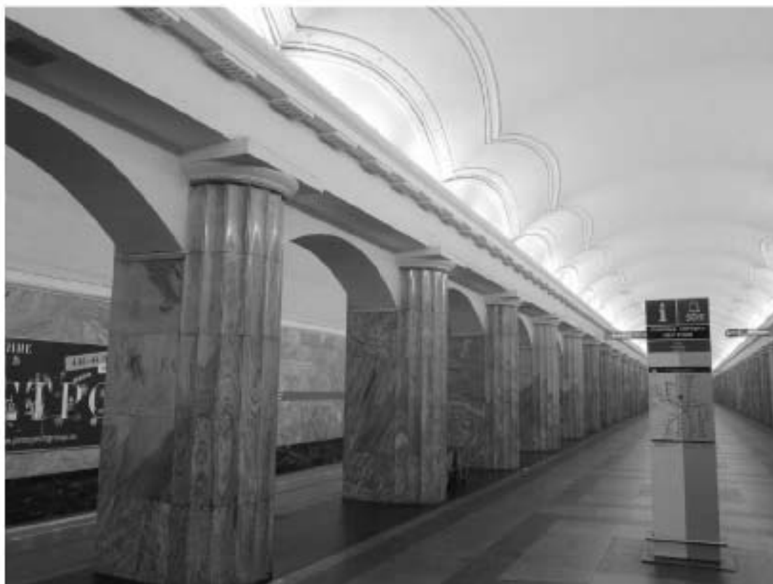
Фото 5. Объект культурного наследия регионального значения «Станция метро «Балтийская» (с перронным залом)». Перронный зал.
