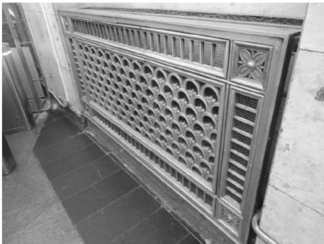
Фото 27. Объект культурного наследия регионального значения «Станция метро «Балтийская» (с перронным залом)». Вид части кассового зала. Решетка радиатора.
