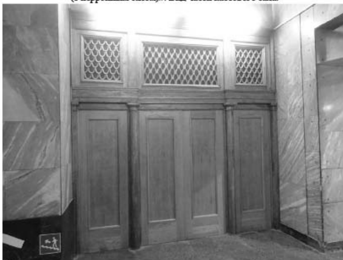
Фото 26. Объект культурного наследия регионального значения «Станция метро «Балтийская» (с перронным залом)». Вид части кассового зала.
