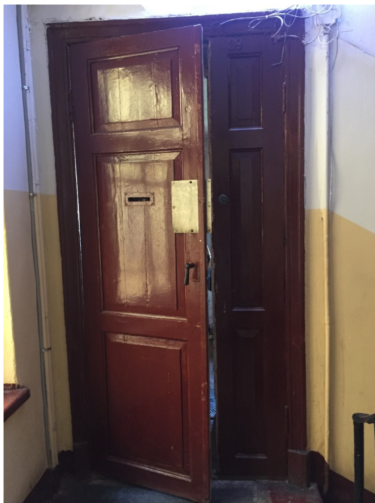
Фото 50. Выход из квартиры на черную лестницу. Вид с северо-востока.
