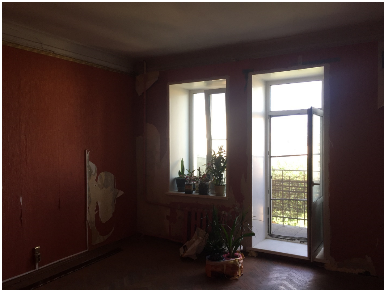
Фото 22. Общий вид жилой комнаты (помещение № 5). Вид с юга.
