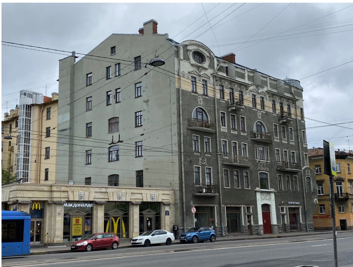
Фото. 2. Общий вид торцевого фасада объекта культурного со стороны Загородного проспекта. Вид с юга.
