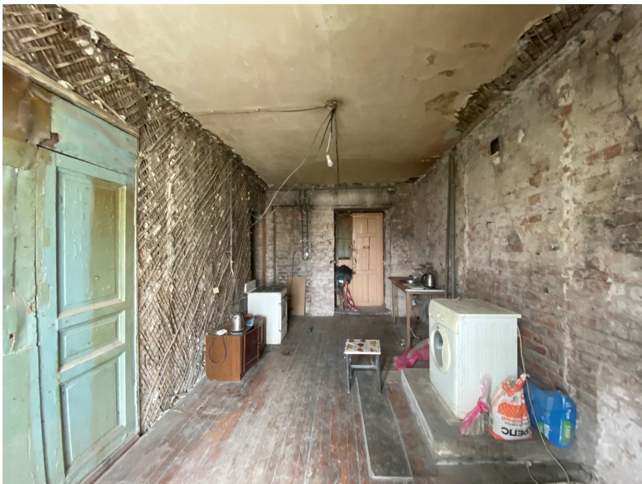
Фото 31. Общий вид кухни (помещение № 1). Вид с северо-востока.
