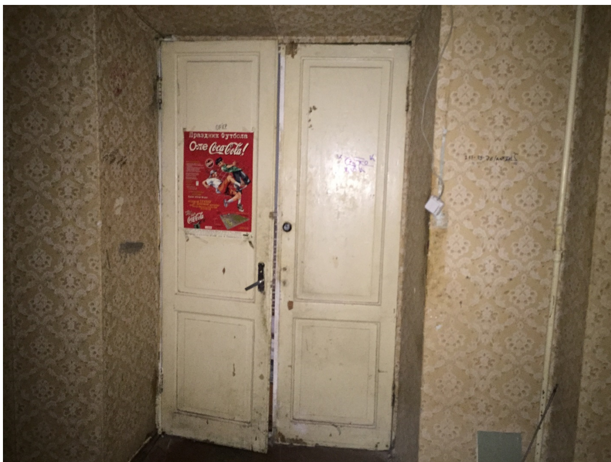
Фото 15. Общий вид коридора (помещение № 7). Дверное заполнение. Вид с юго-востока.
