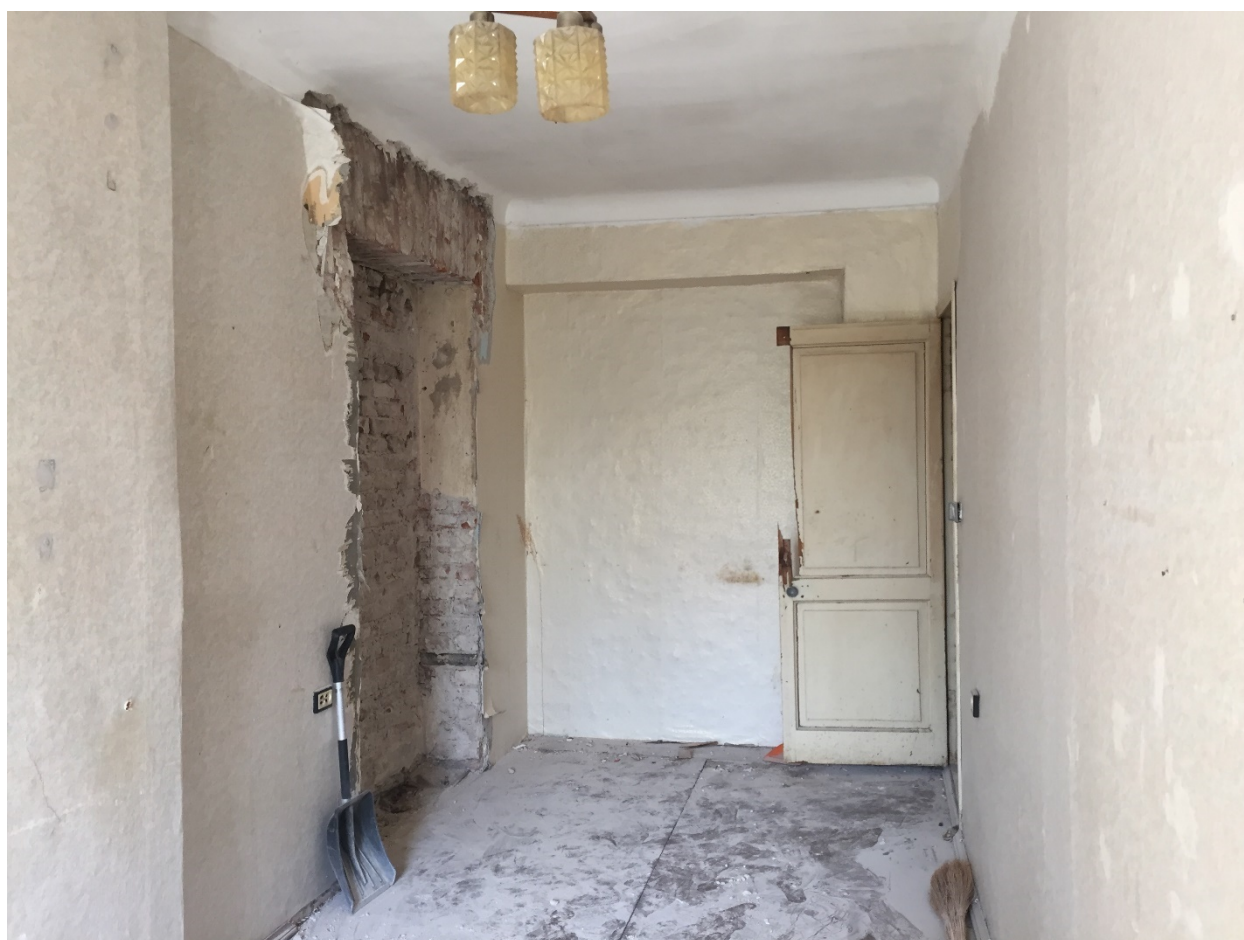
Фото 41. Общий вид жилой комнаты (помещение № 10). Вид с юго-запада.
