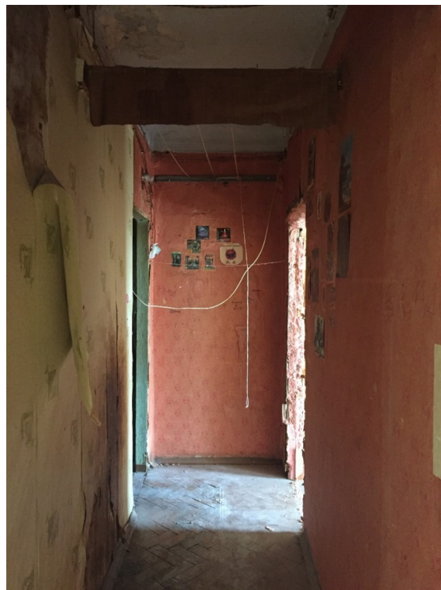
Фото 39. Общий вид коридора (помещение № 15). Вид с северо-запада.
