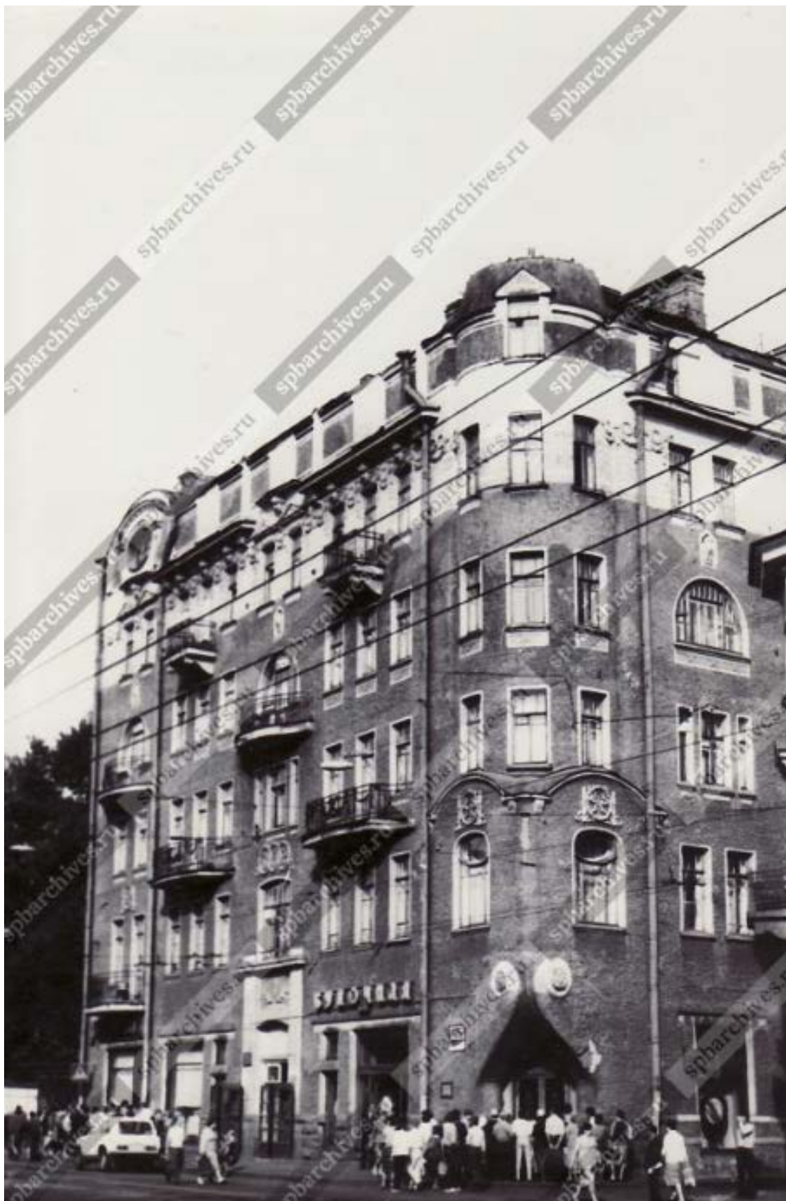
Илл. 10. «Общий вид фасада жилого дома № 45/13 на углу Загородного проспекта и переулка Ильича (бывший доходный дом А.Н.Штальман, архитектор И.Ю.Мушинский, 1906 г.)». Источник: ЦГАКФФД СПб. Архивный шифр: Ар 211992.
