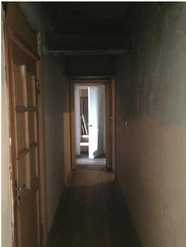
Фото 32. Общий вид коридора (помещение № 2). Вид с северо-запада.
