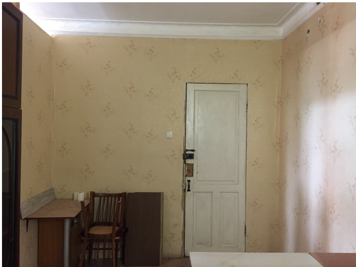
Фото 45. Общий вид коридора (помещение № 16). Вид с юго-востока.
