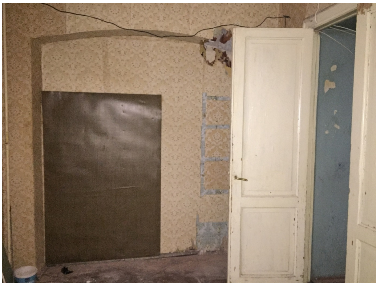
Фото 13. Общий вид ниши в коридоре (помещение № 7). Вид с северо-востока.
