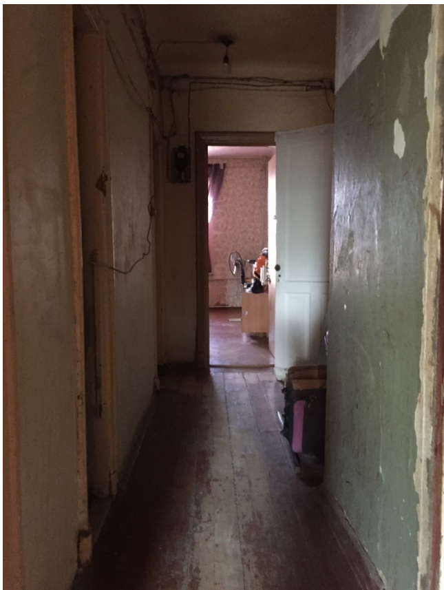
Фото 34. Общий вид коридора (помещение № 11). Вид с юго-запада.
