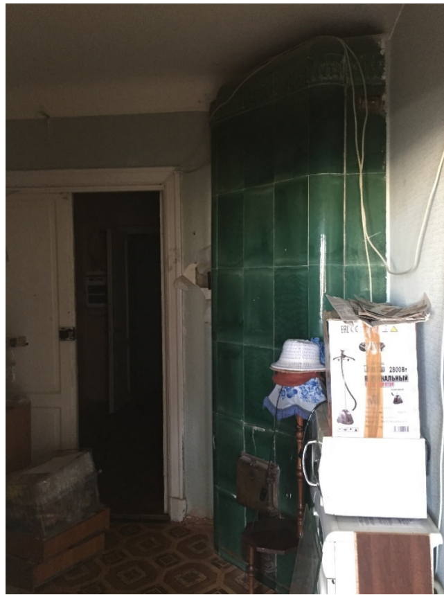
Фото 17. Общий вид коридора (помещение № 17). Изразцовая одноярусная печь. Вид с юго-востока.
