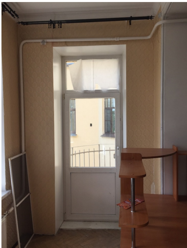
Фото 48. Выход на балкон из помещения № 8. Вид с юго-востока.
