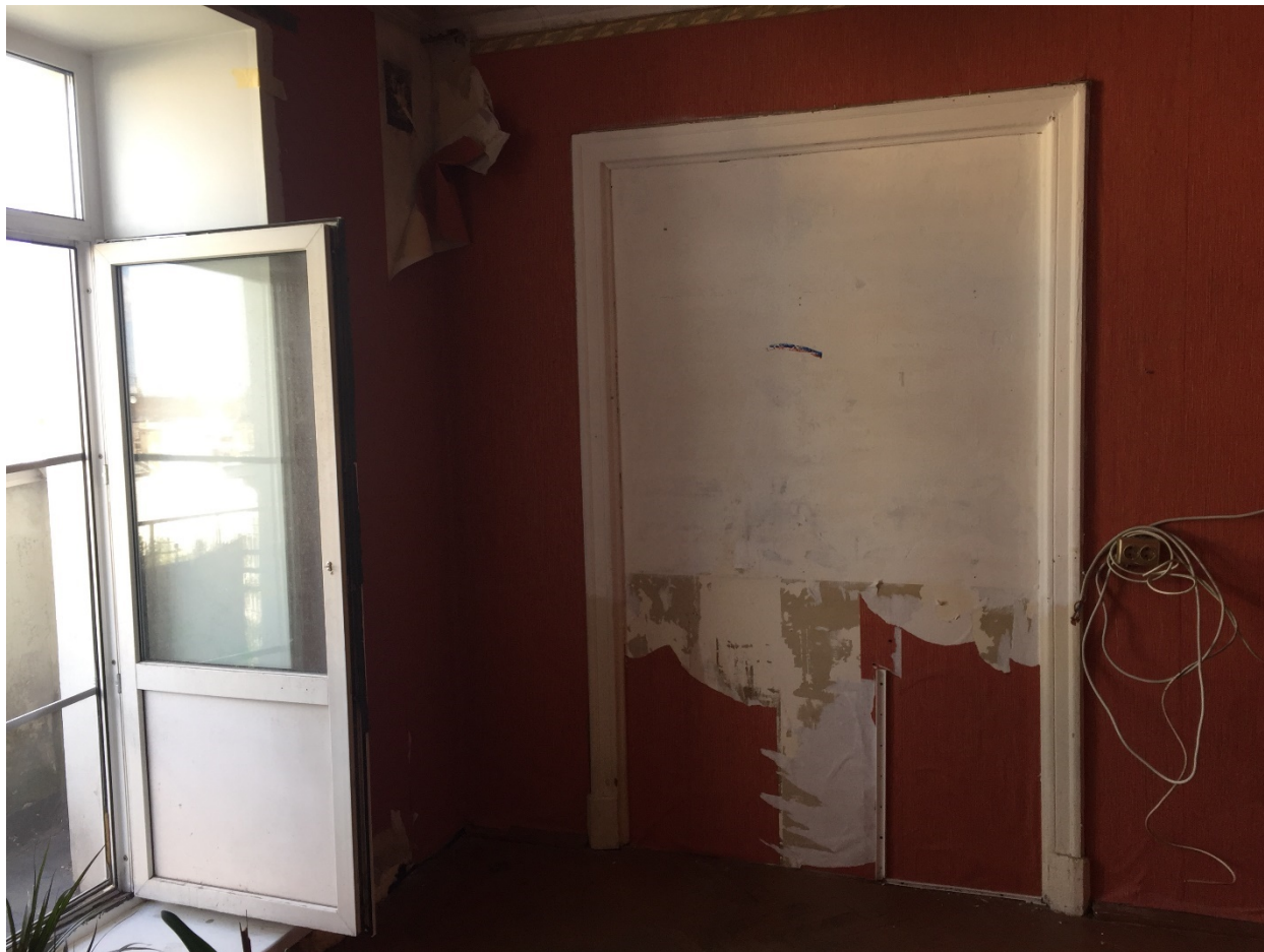
Фото 23. Общий вид жилой комнаты (помещение № 5). Вид с северо-запада.
