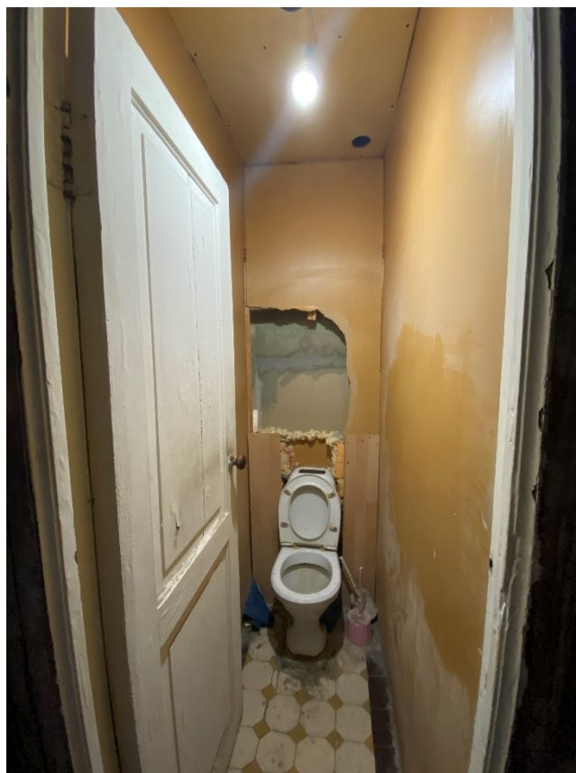
Фото 35. Туалет (помещение № 12). Вид с северо-востока.
