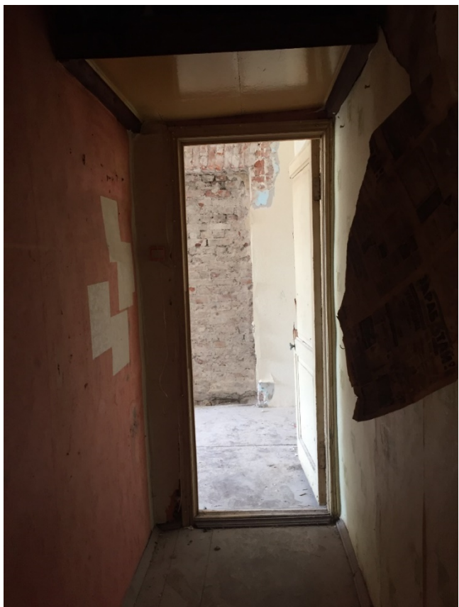
Фото 38. Общий вид коридора (помещение № 15). Вид с юго-востока.
