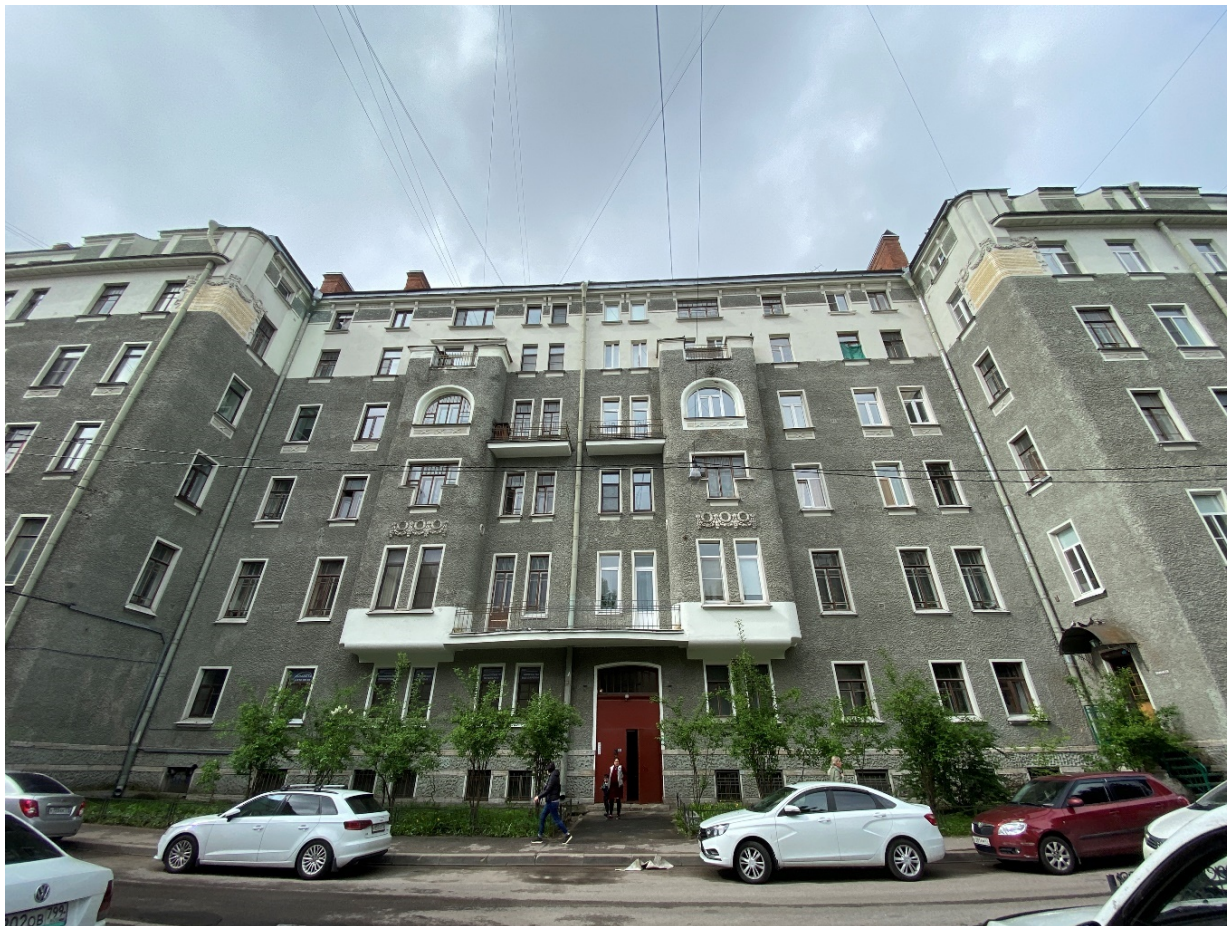
Фото. 5. Фрагмент лицевого северо-восточного фасада по Большому Казачьему переулку. Вид с северо-востока.
