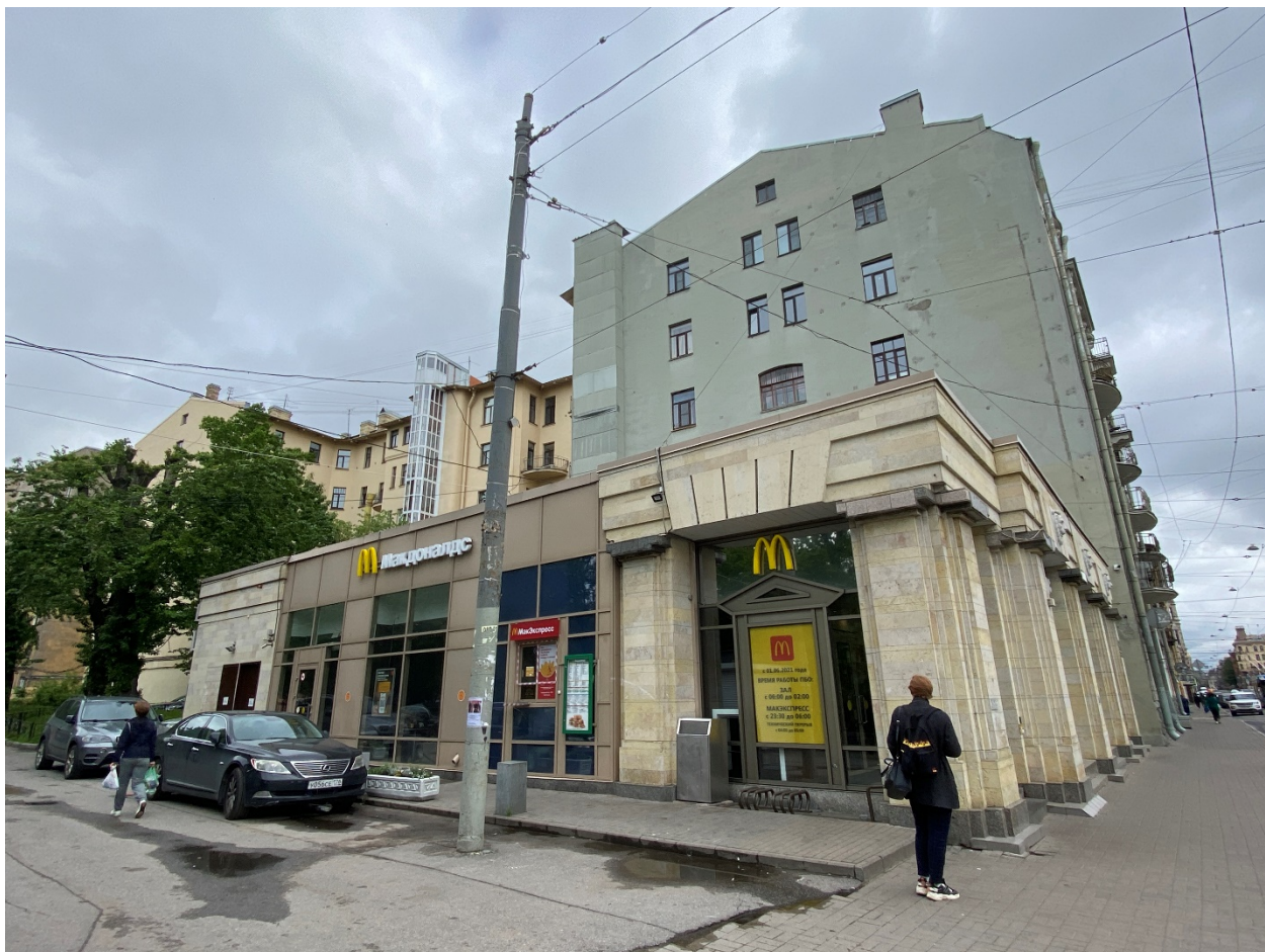
Фото. 7. Общий вид объекта со стороны Лазаретного переулкa. Вид с юга.
