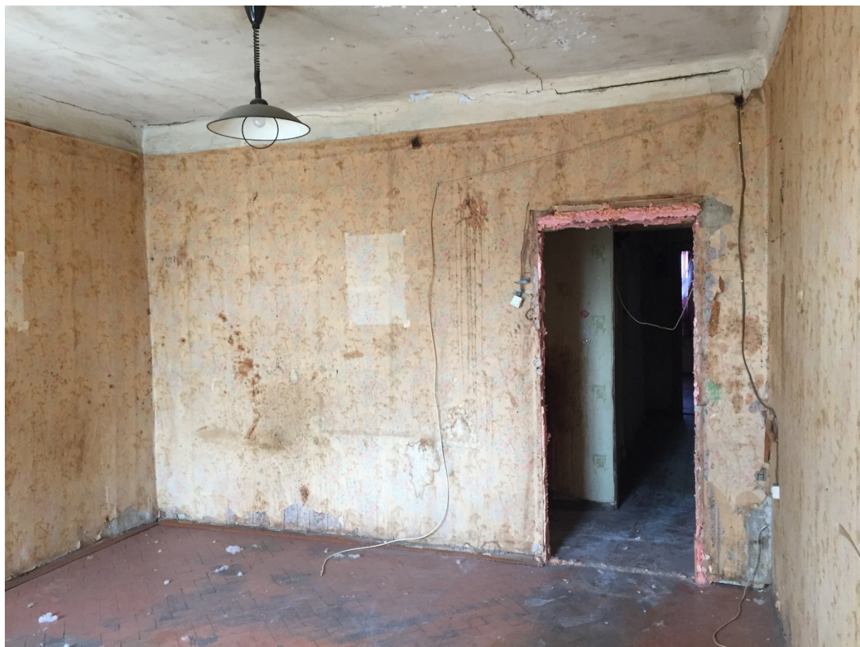
Фото 43. Общий вид жилой комнаты (помещение № 9). Вид с юго-запада.
