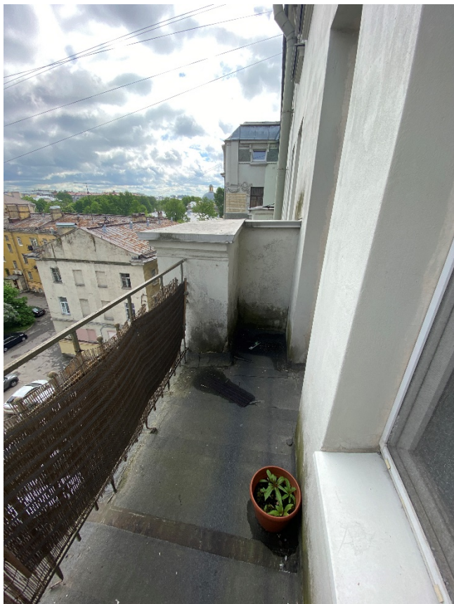
Фото 25. Общий балкона. Вид северо-запада.
