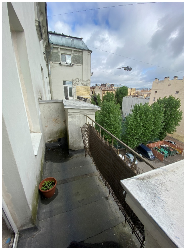
Фото 26. Общий вид балкона. Вид с юго-востока.
