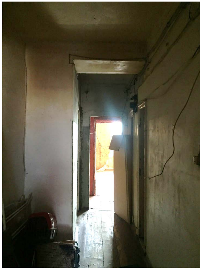
Фото 33. Общий вид коридора (помещение № 11). Вид с северо-востока.
