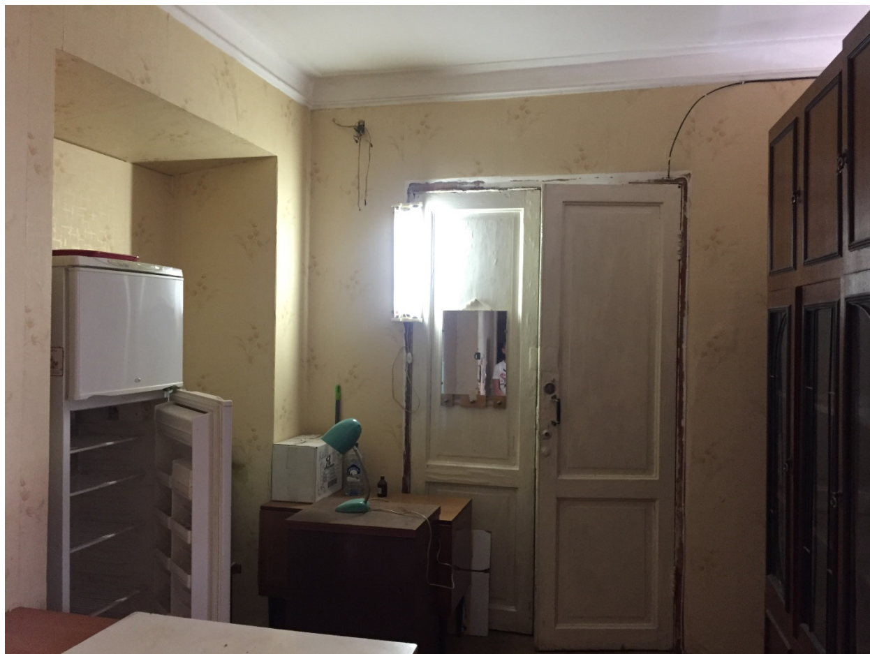
Фото 44. Общий вид коридора (помещение № 16). Вид с северо-запада.
