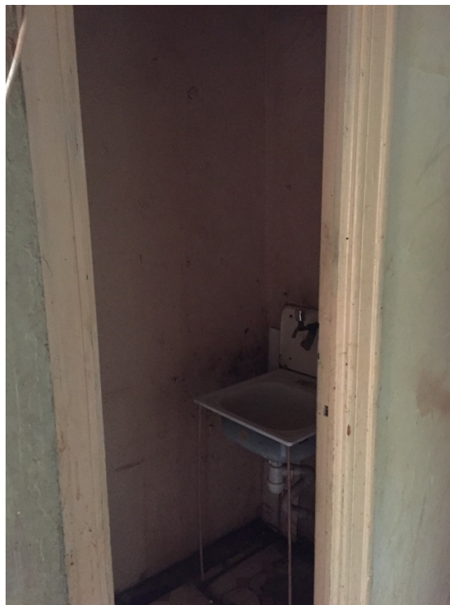
Фото 37. Умывальная (помещение № 14). Вид с северо-востока.
