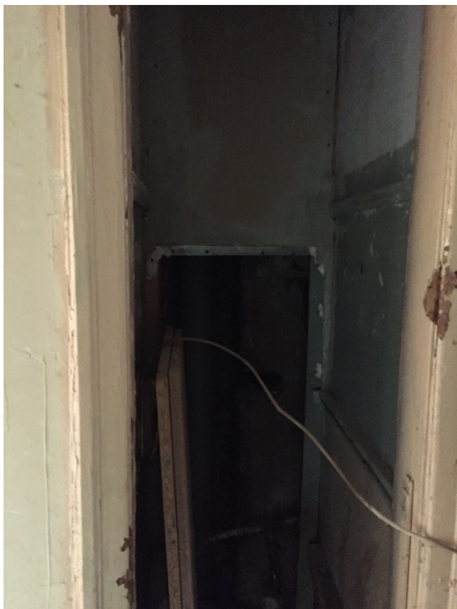
Фото 36. Кладовая (помещение № 13). Вид с юго-востока.
