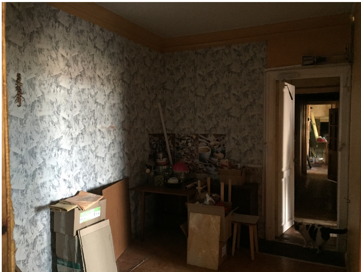
Фото 20. Общий вид коридора (помещение № 18). Вид с юго-востока.
