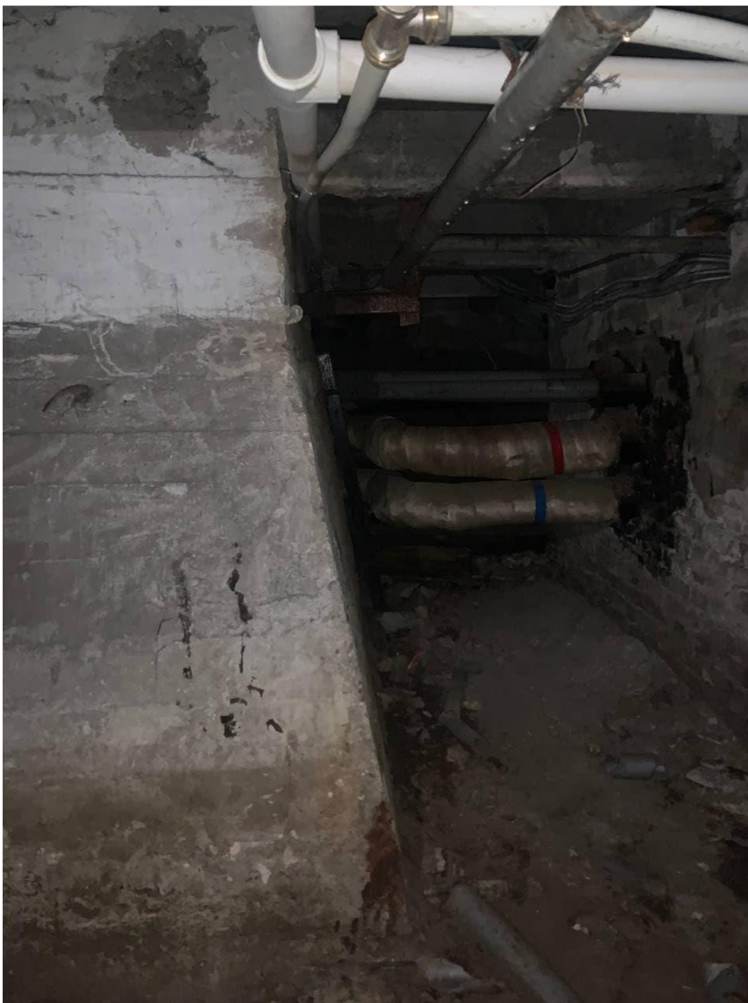
Фото 14. Объект культурного наследия регионального значения «Жилой дом специалистов «Свирьстрой», Санкт-Петербург, Малый проспект П.С., 84-86, лит.А. Помещение б/н10 (2).
