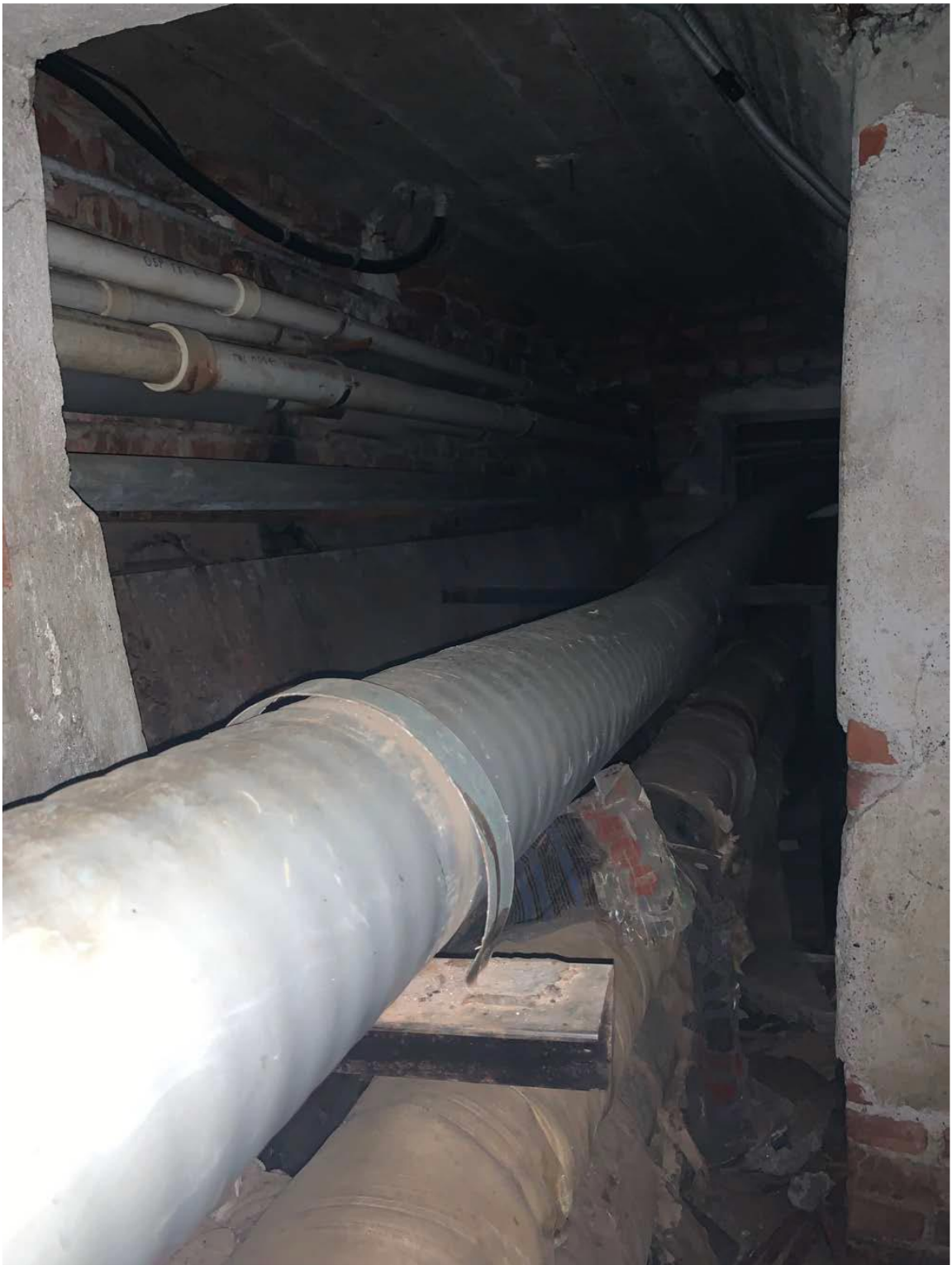
Фото 20. Объект культурного наследия регионального значения «Жилой дом специалистов «Свирьстроя», Санкт-Петербург, Малый проспект П.С., 84-86, лит.А. Помещение б/н15 (1) вид на ЛК-3.
