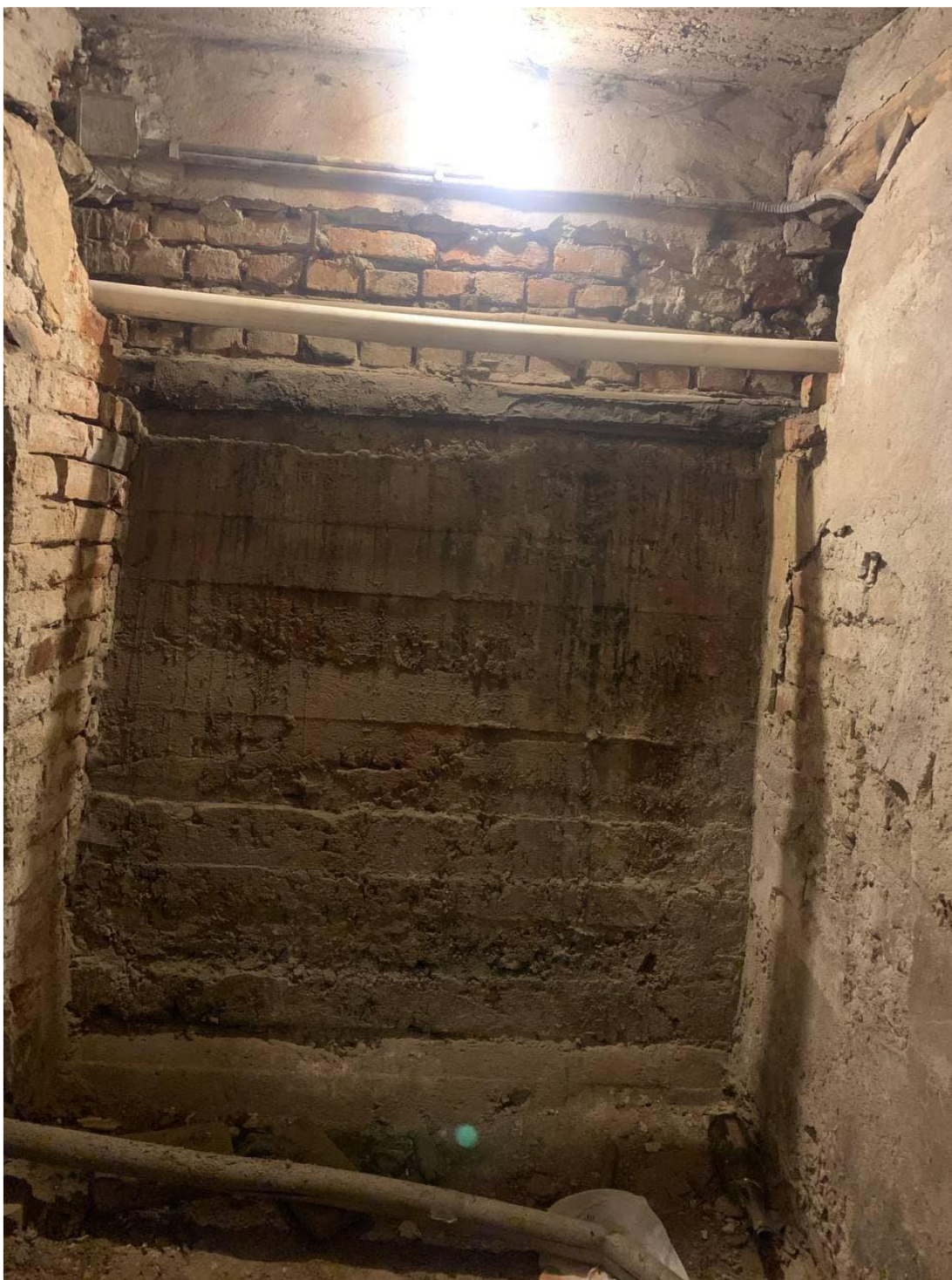
Фото 10. Объект культурного наследия регионального значения «Жилой дом специалистов «Свирьстрой», Санкт-Петербург, Малый проспект П.С., 84-86, лит.А. Помещение б/н1 (1).
