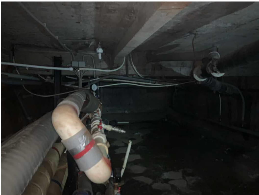
Фото 19. Объект культурного наследия регионального значения «Жилой дом специалистов «Свирьстрой», Санкт-Петербург, Малый проспект П.С., 84-86, лит.А. Помещение б/н15 (1).
