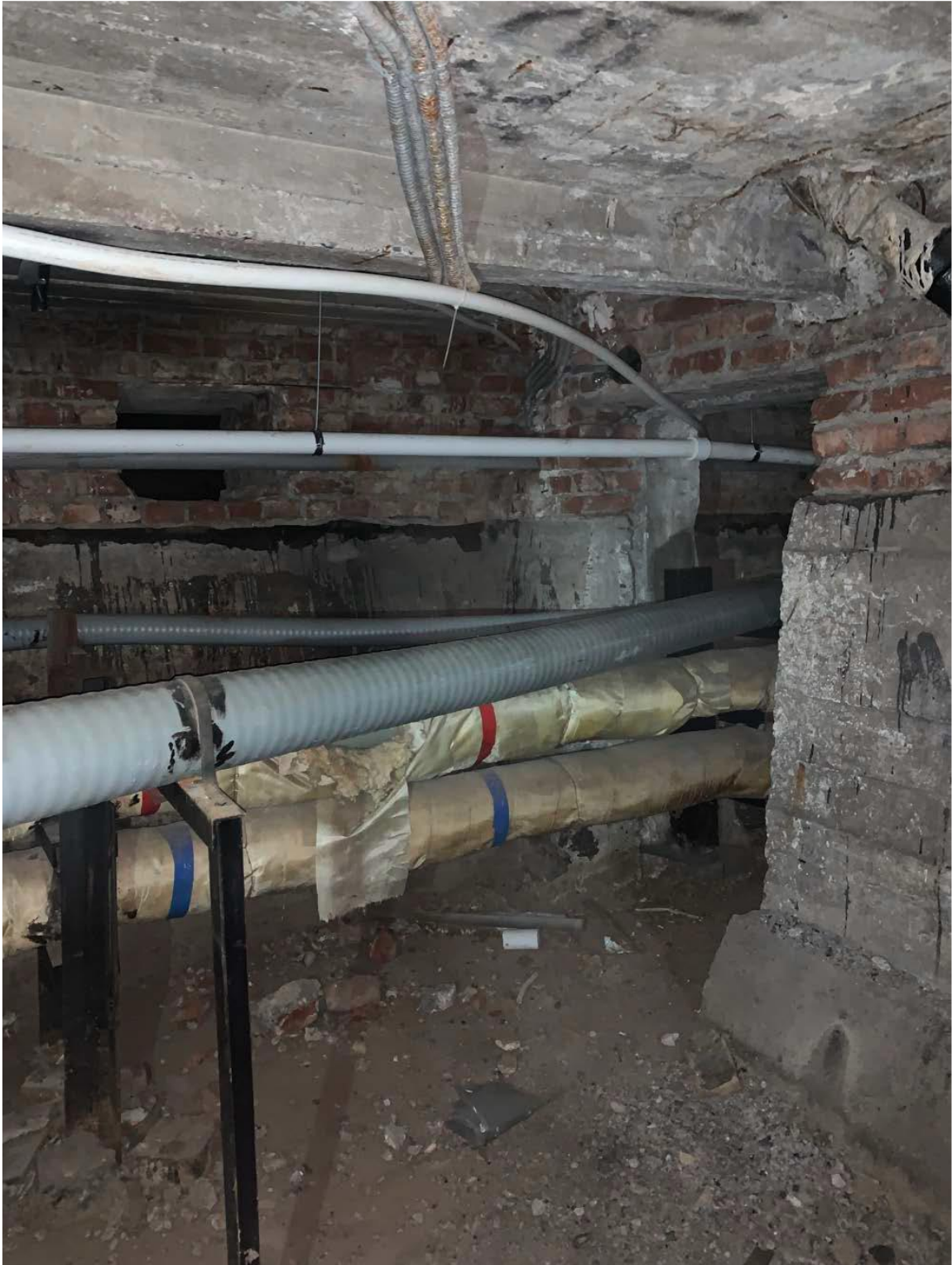
Фото 17. Объект культурного наследия регионального значения «Жилой дом специалистов «Свирьстрой», Санкт-Петербург, Малый проспект П.С., 84-86, лит.А. Помещение б/н14 (1).
