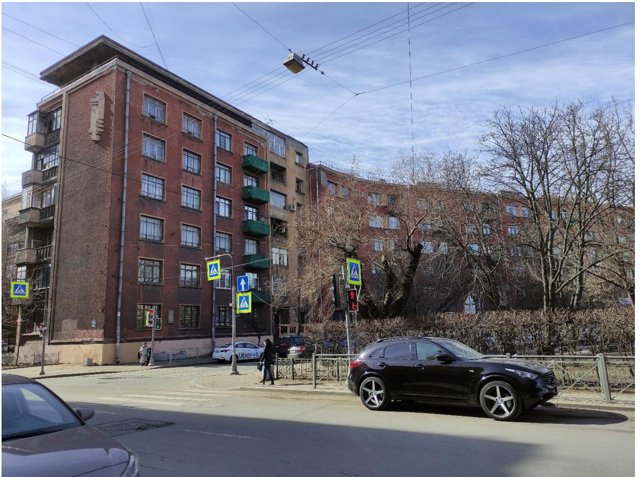
Фото 4. Объект культурного наследия регионального значения «Жилой дом специалистов «Свирьстроя», Санкт-Петербург, Малый проспект П.С., 84-86, лит.А. Западный лицевой фасад. Фрагмент. Вид от Малого проспект П.С.
