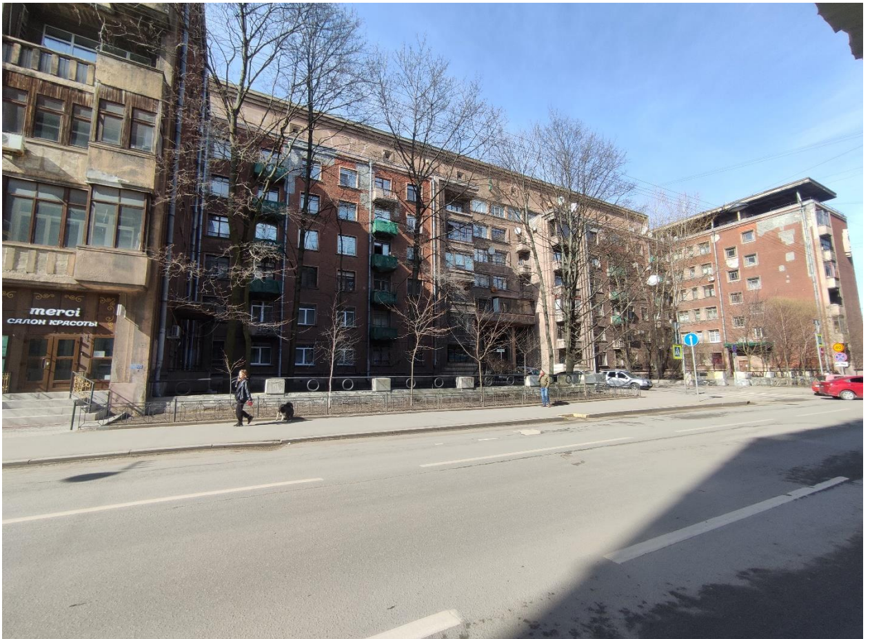
Фото 2. Объект культурного наследия регионального значения «Жилой дом специалистов «Свирьстроя», Санкт-Петербург, Малый проспект П.С., 84-86, лит.А. Юго-восточный лицевой фасад. Лицевой корпус с курдонером. Вид с Малого проспекта П.С.
