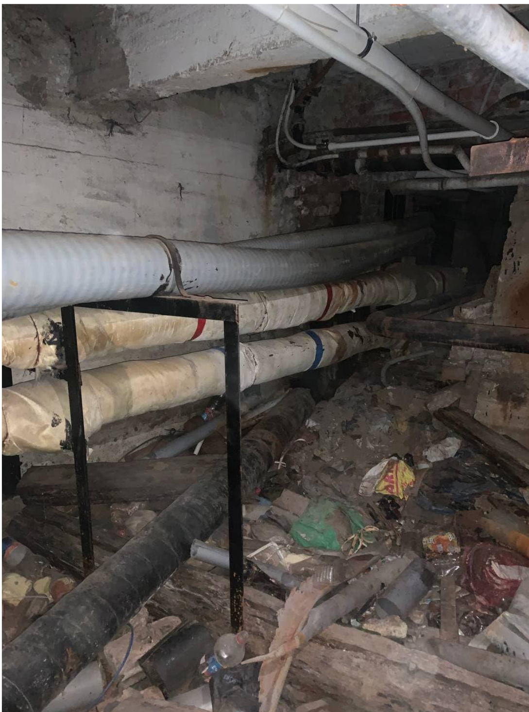
Фото 15. Объект культурного наследия регионального значения «Жилой дом специалистов «Свирьстрой», Санкт-Петербург, Малый проспект П.С., 84-86, лит.А. Помещение б/н10 (2).
