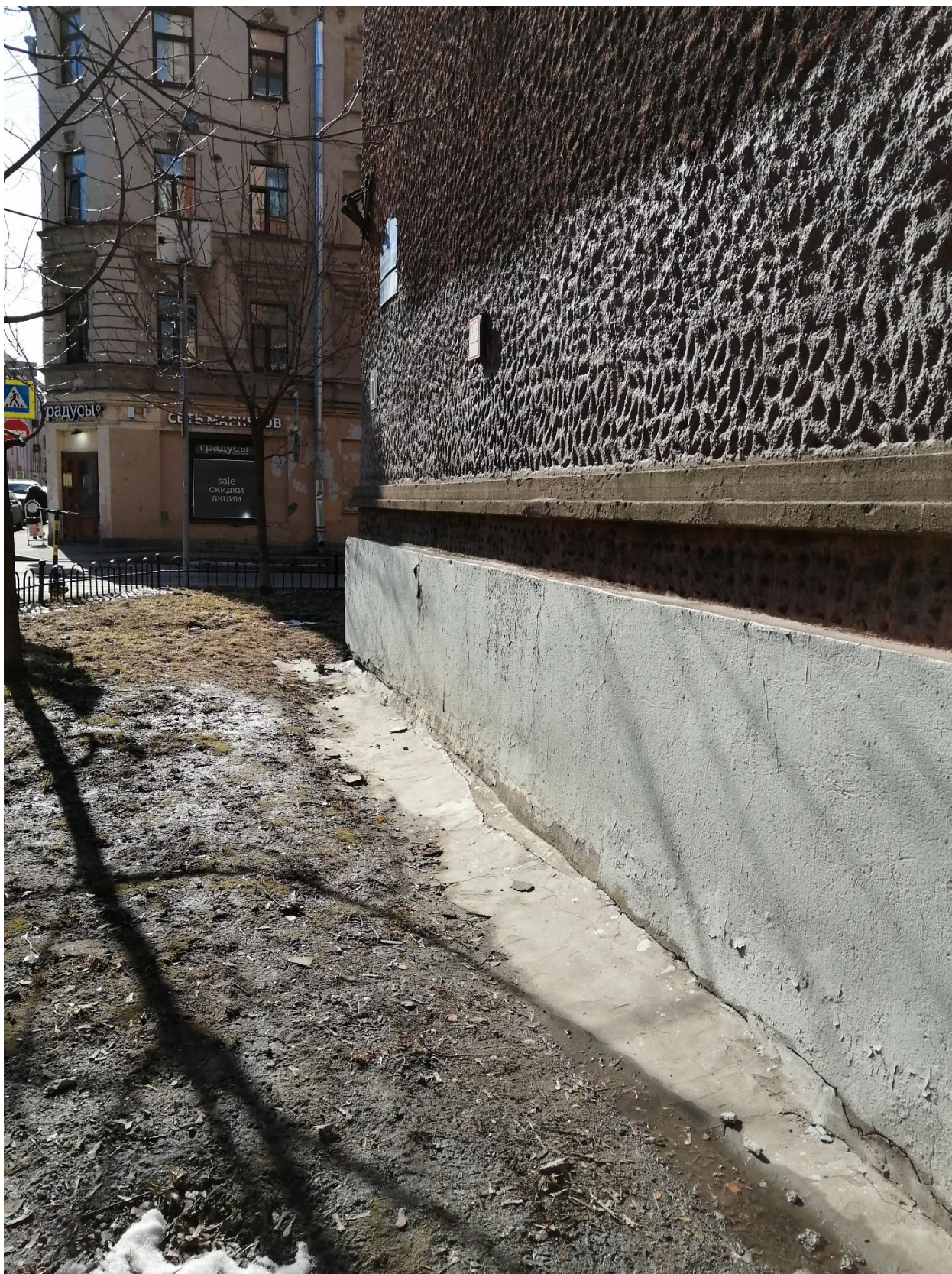
Фото 8. Объект культурного наследия регионального значения «Жилой дом специалистов «Свирьстроя», Санкт-Петербург, Малый проспект П.С., 84-86, лит.А. юго-восточный лицевой фасад. Фрагмент (левая часть). Состояние отмостки в месте предполагаемого прохода трассы тепловой сети.
