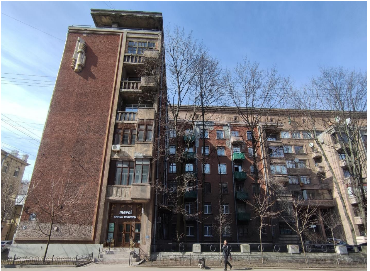
Фото 1. Объект культурного наследия регионального значения «Жилой дом специалистов «Свирьстроя», Санкт-Петербург, Малый проспект П.С., 84-86, лит.А. Юго-восточный лицевой фасад. Фрагмент (левая часть). Вид с Малого проспекта П.С.
