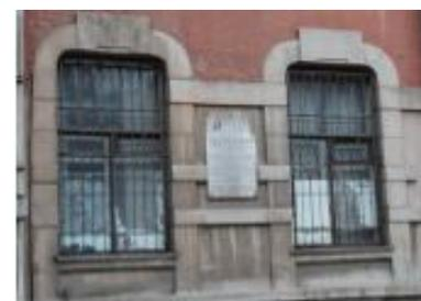
тяга простого профиля терразитовой штукатурки под оконными проемами 1-го этажа;
