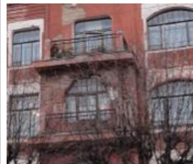
заполнения балконных проемов – историческая расстекловка (с фрамугами геометрической расстекловки), цвет (темно-коричневый);
