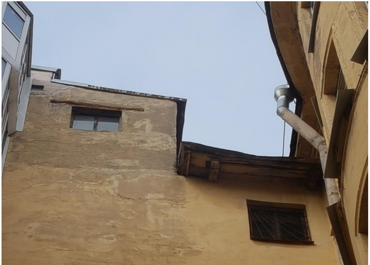
Фото 24. Карниз. Дворовой северный фасад.
