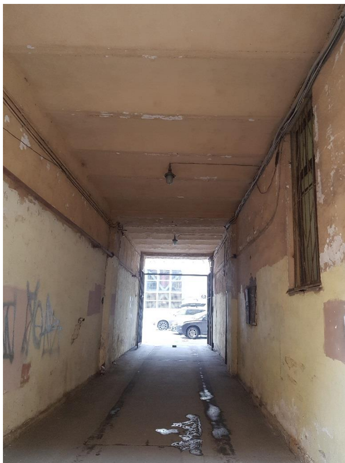
Фото 35. Проезд из первого двора во второй. Вид во второй двор.
