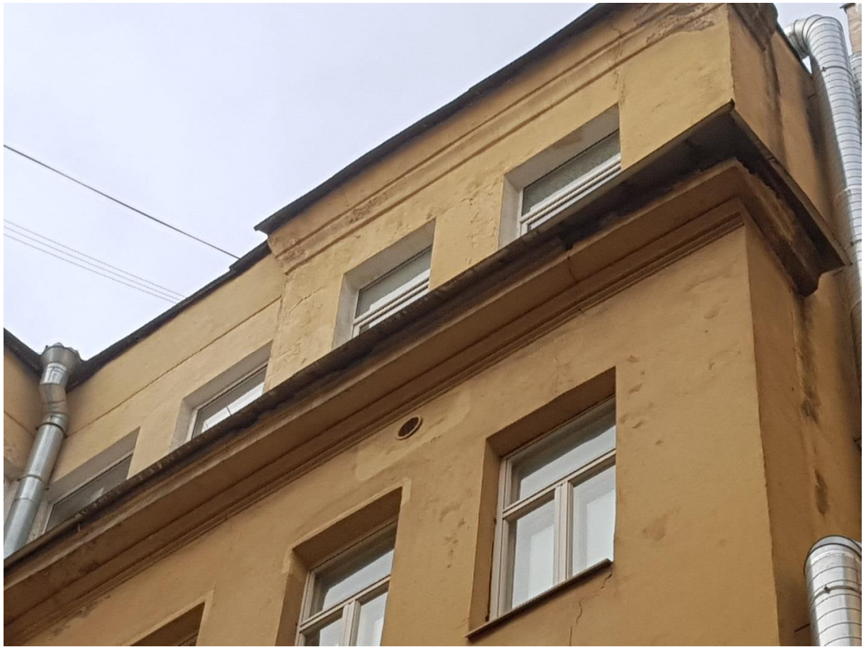
Фото 23. Карнизы. Дворовой северный фасад.
