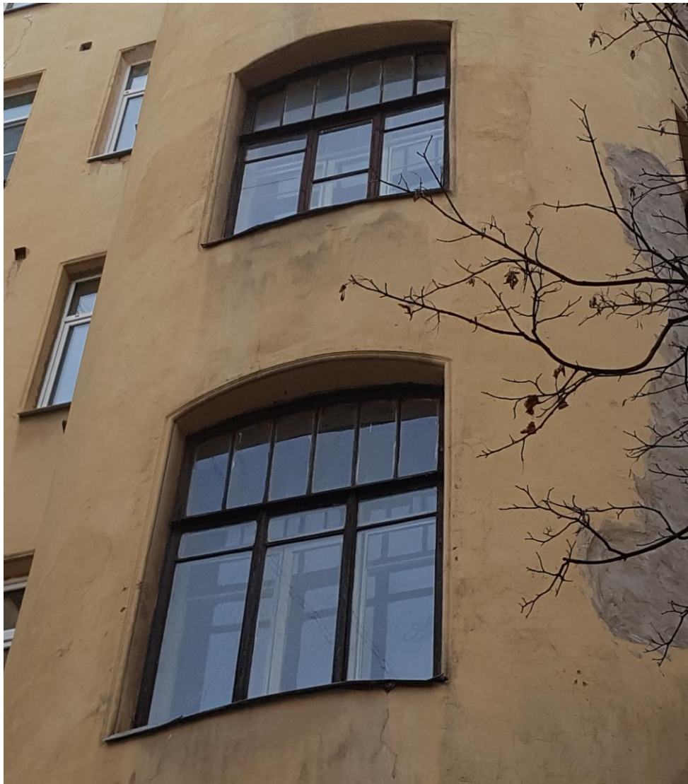
Фото 44. Окна ризалита на фасаде второго двора.
