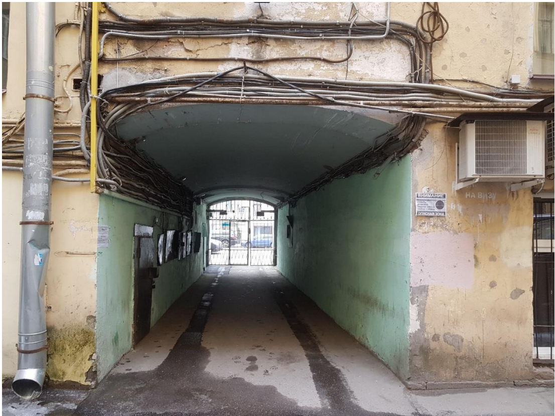
Фото 18. Арочный проход со стороны первого двора на ул. Марата.
