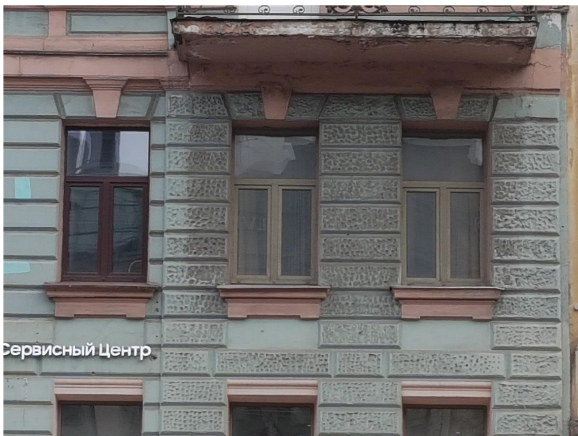
Фото 6. Оформление оконных проемов в уровне 3-го этажа
