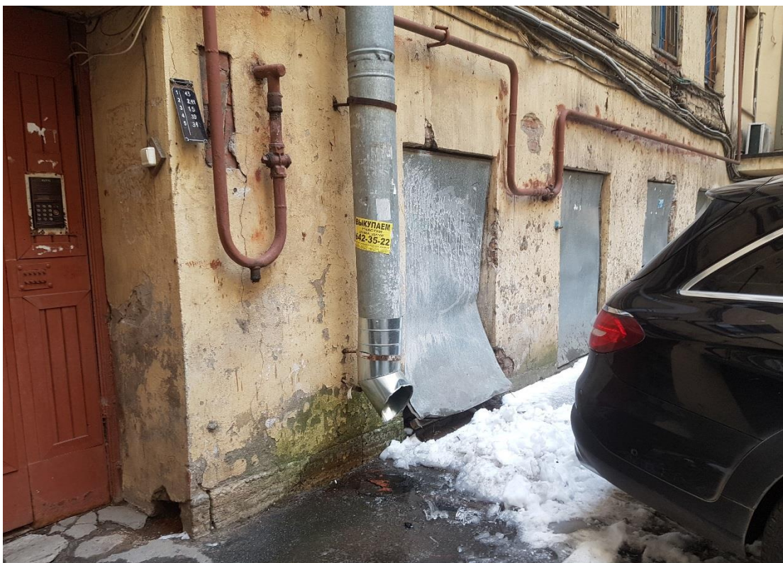
Фото 33. Цоколь. Зона первого этажа дворового южного фасада.
