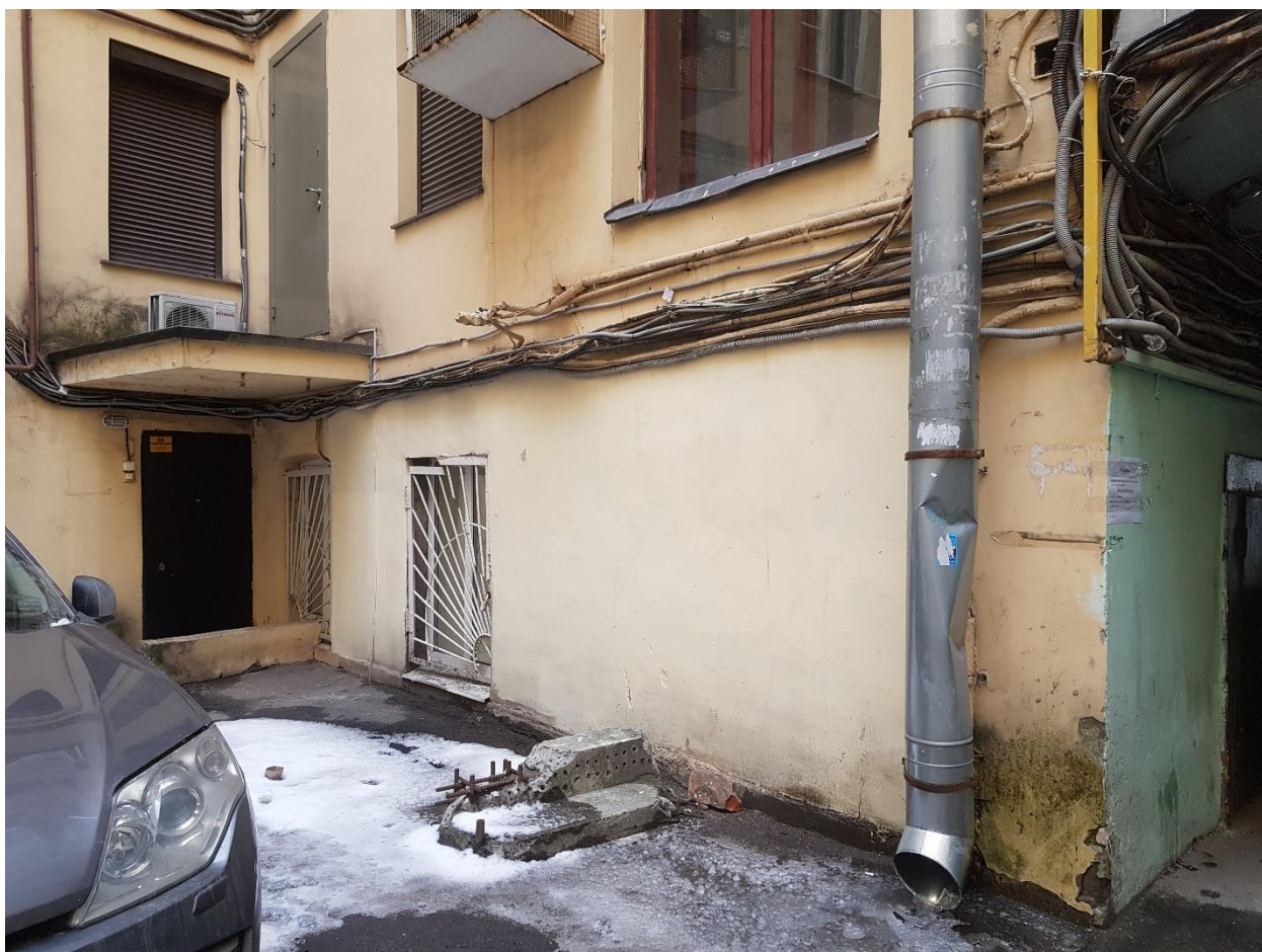
Фото 21. Уровень 1-го этажа дворового фасада лицевого корпуса.
