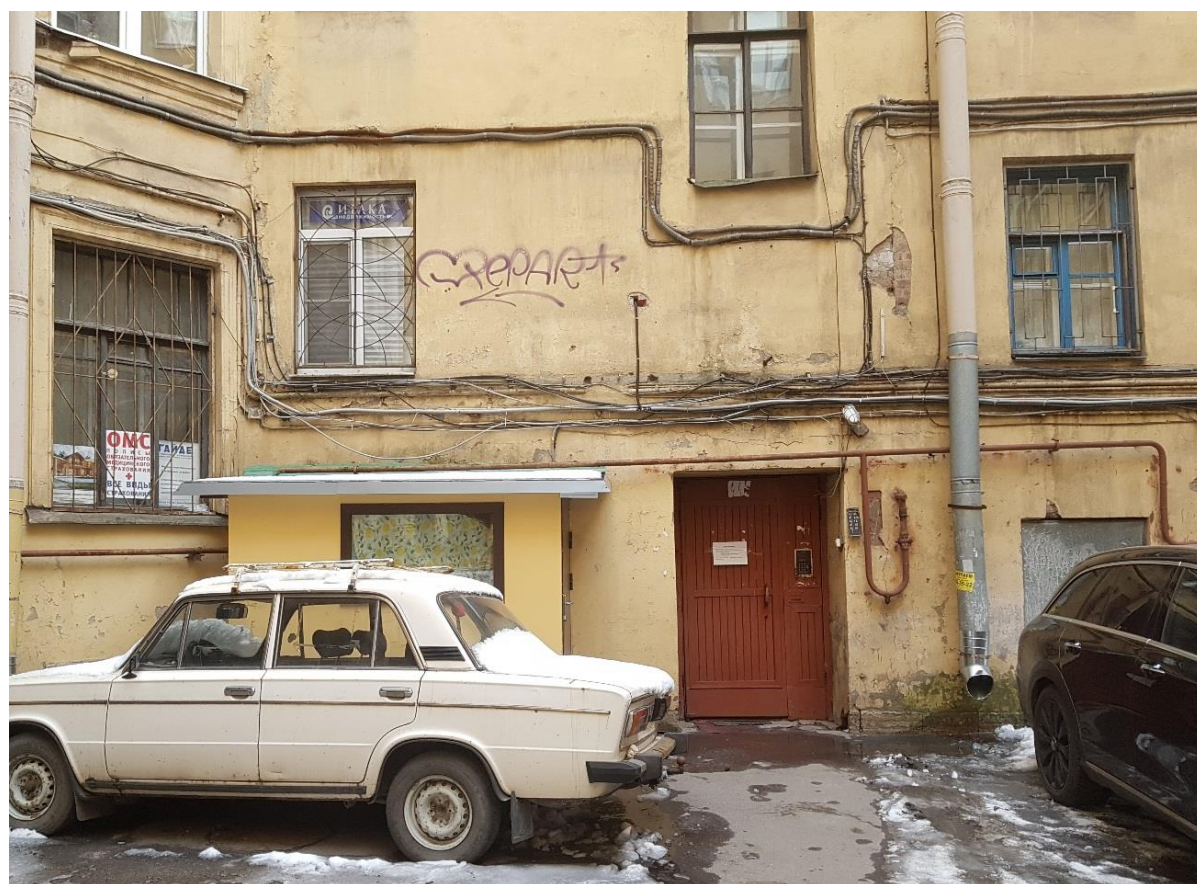
Фото 32. Зона первого и второго этажей дворового южного фасада.
