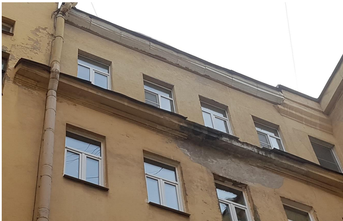
Фото 31. Карнизы. Дворовой южный фасад.
