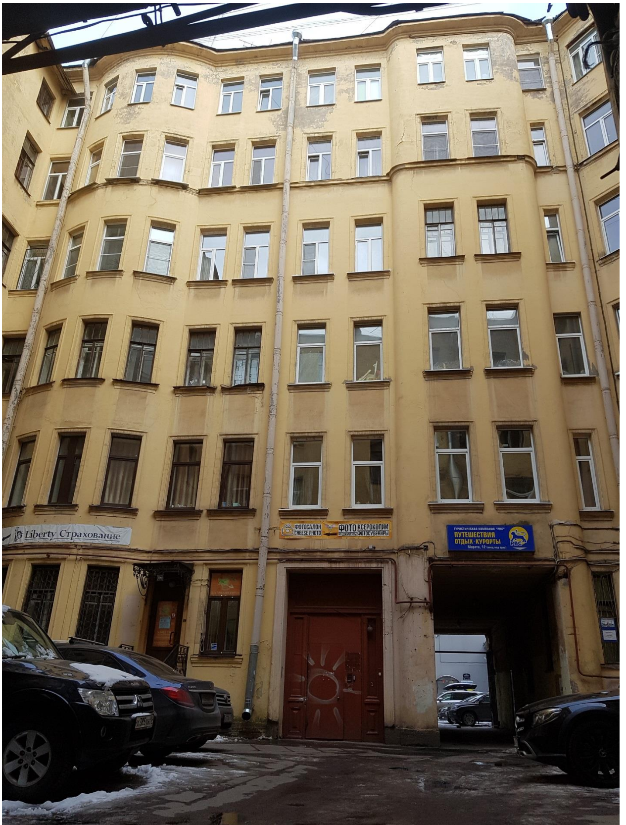
Фото 27. Дворовой восточный фасад.
