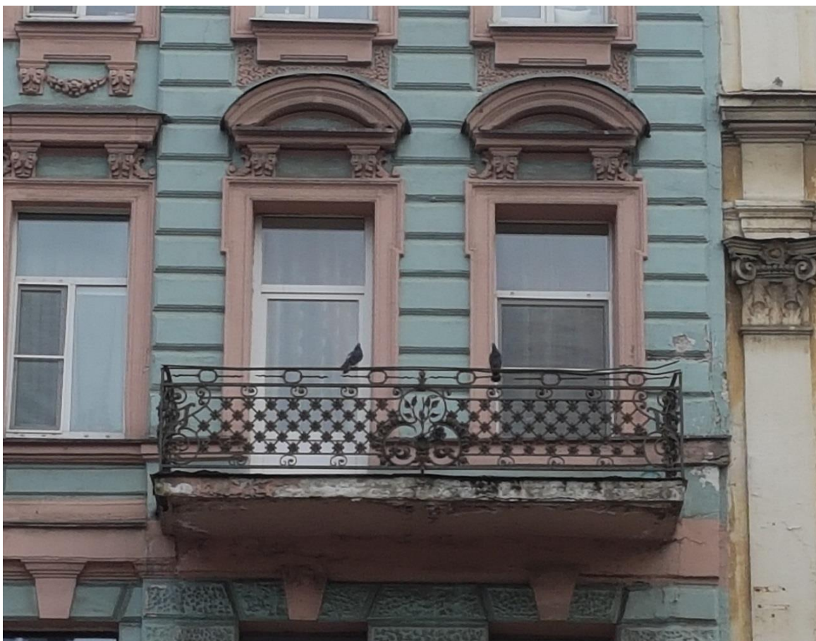
Фото 5. Оформление оконных проемов в уровне 4-го этажа. Балкон.
