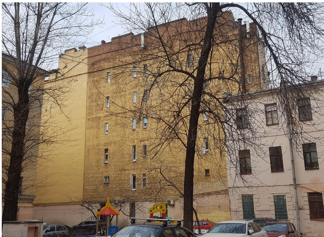
Фото 14. Стена дома со стороны двора дома №14.
