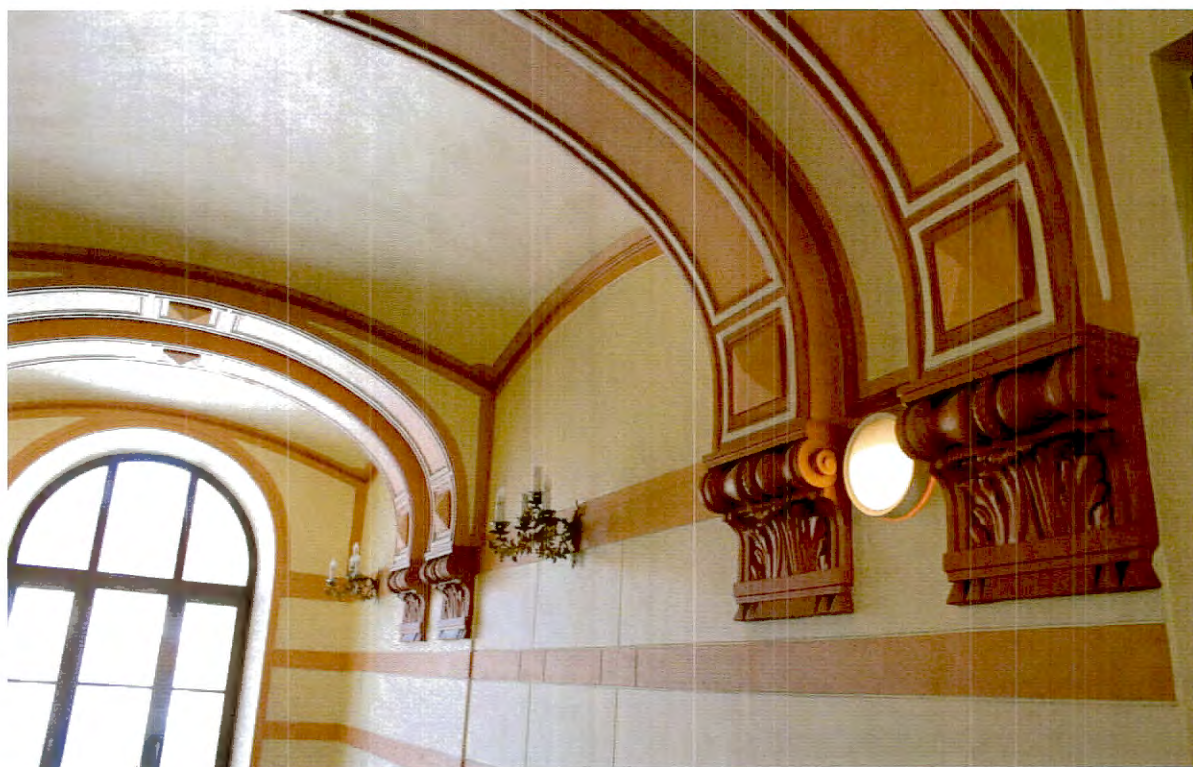
Фото №6. Перекрытие парадной лестницы.
