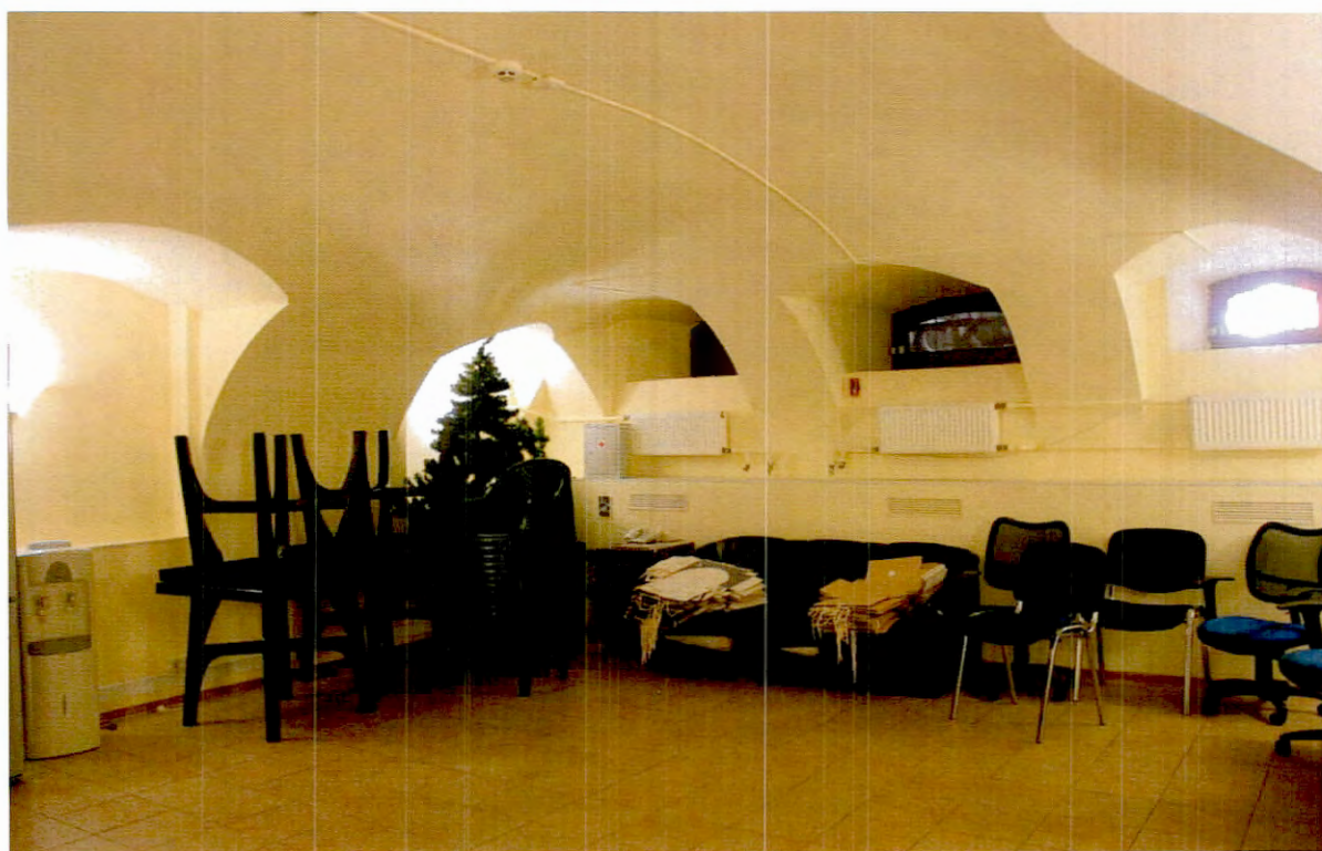
Фото №13. Помещение цокольного этажа.
