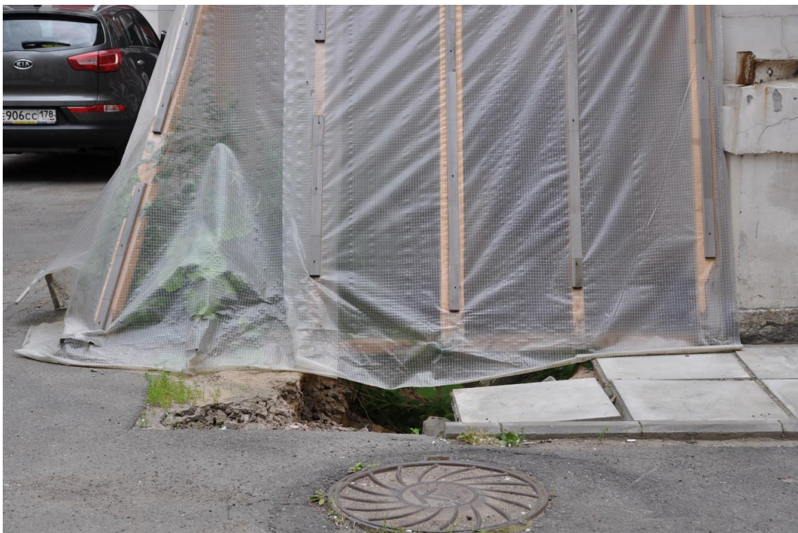
3. Фрагмент северного дворового фасада.
