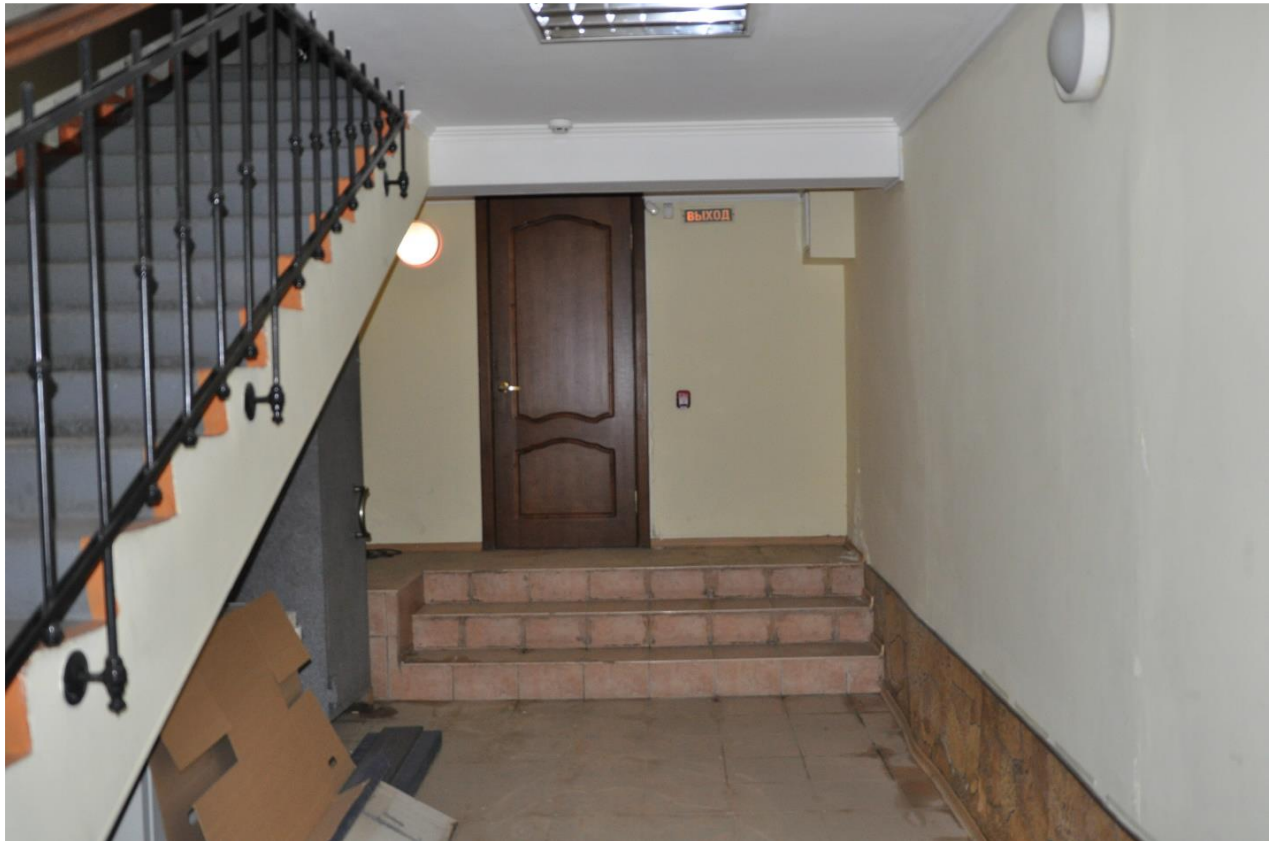
10. Подлестничное пространство, помещение 1-Н, эвакуационный выход.
