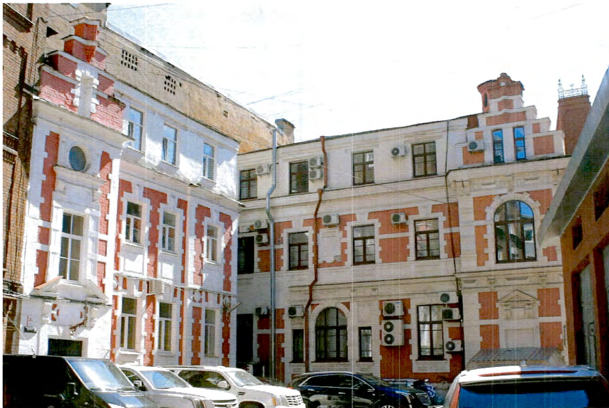
Фото №2. Вид со стороны внутреннего двора.
