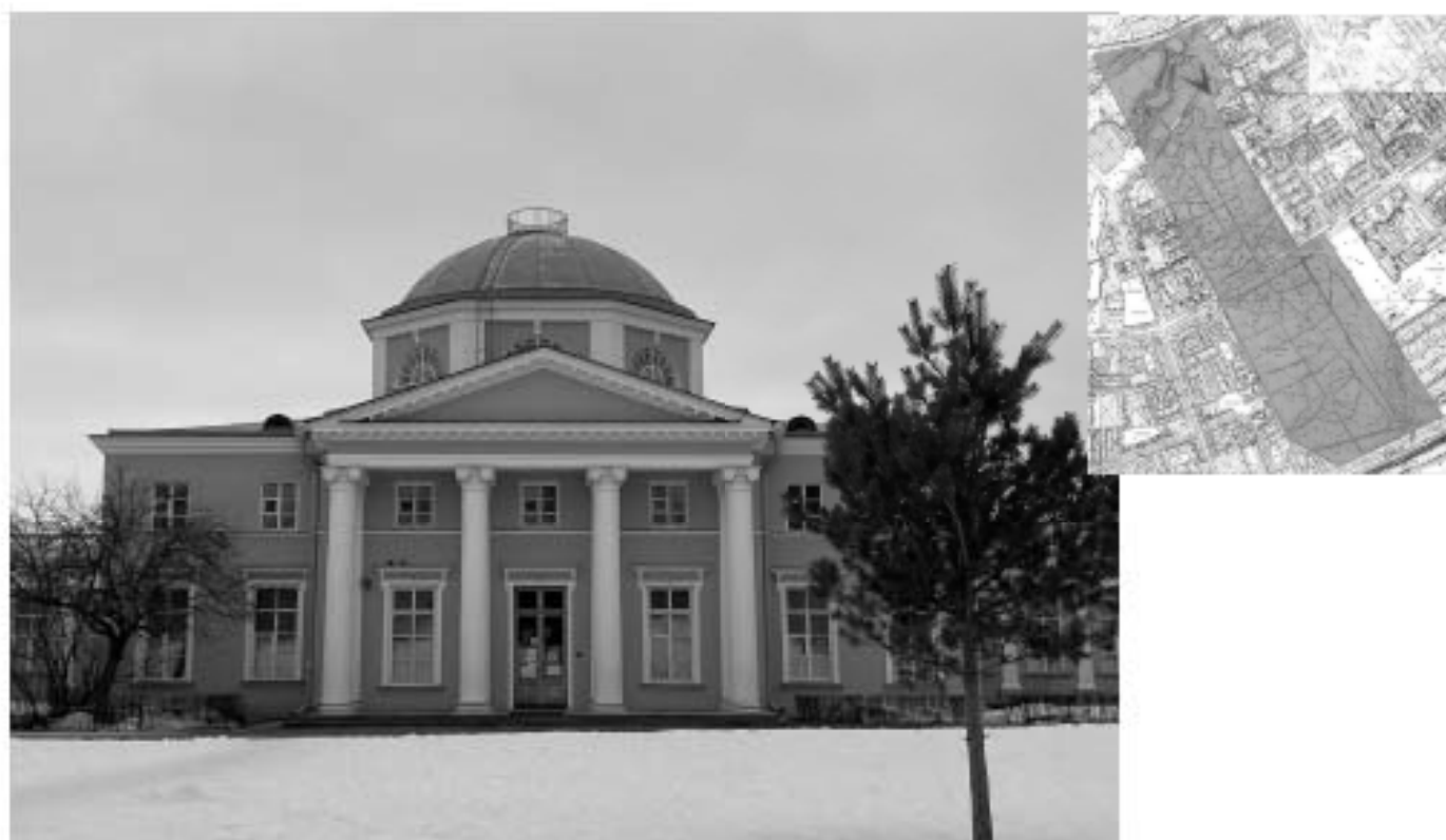
Фото 31. Центральная часть юго-восточного фасада объекта «Дача И.Г. Чернышева». Направление северо-запад. Дата съемки: 21.02.2022 г.
