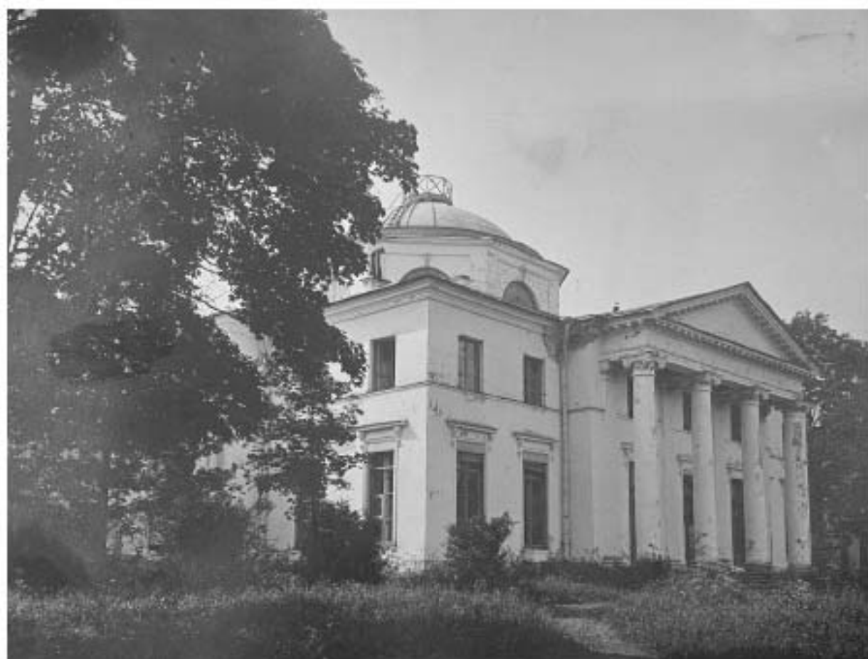
Илл. 28. Вид усадьбы с северо-востока. 1920-е гг. // Архив КГИОП Инв. №: Н-13880
