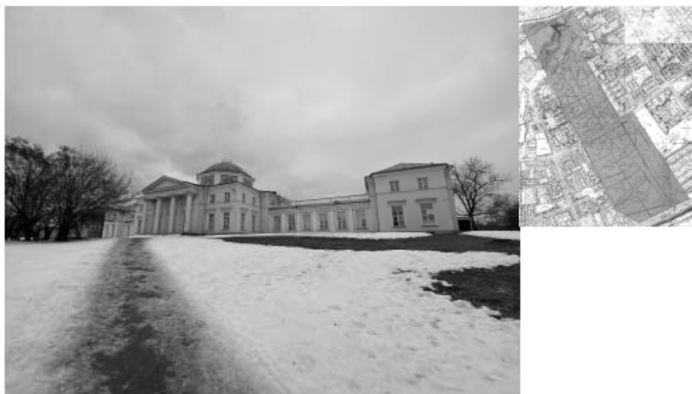
Фото 34. Общий вид объекта «Дача И.Г. Чернышева» с северо-запада. Дата съемки: 21.02.2022 г.
