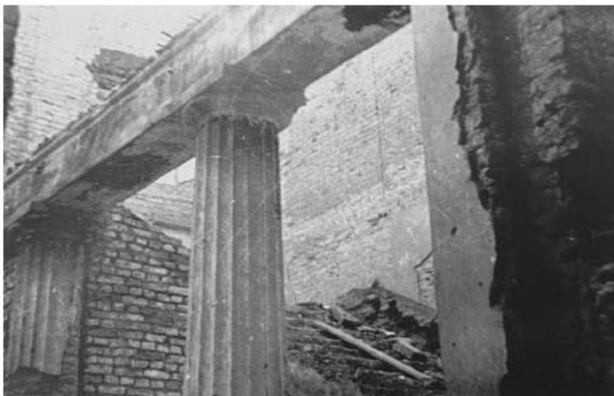
Илл. 45. Вестибюль. Вид на юго-запад. 1940-е гг. // Архив КТИОП. Инв. №: Н-15188
