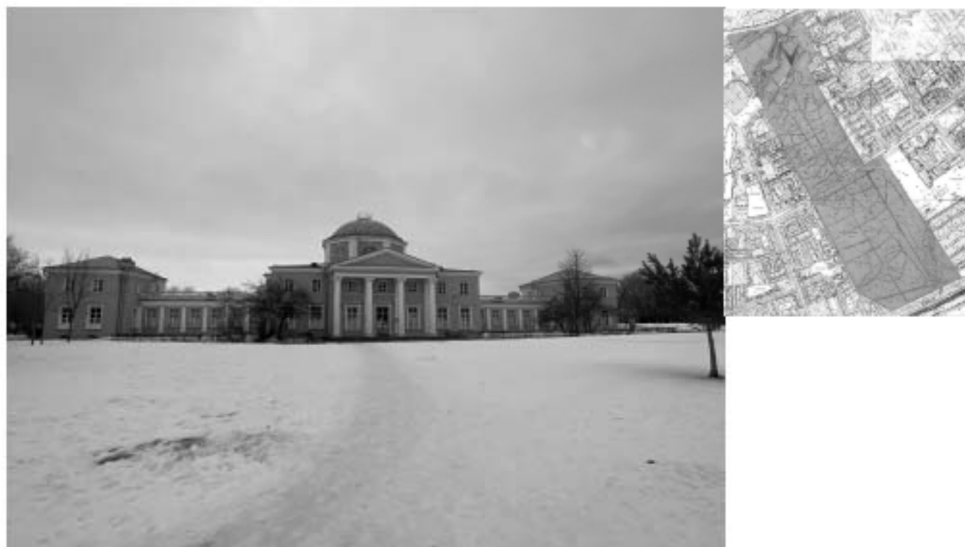
Фото 32. Общий вид объекта «Дача И.Г. Чернышева» с юга. Дата съемки: 21.02.2022 г.
