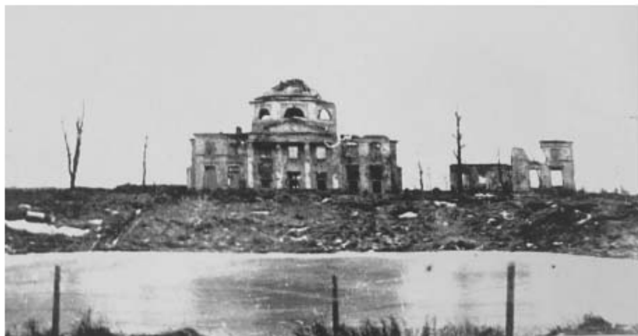
Илл. 41. Северный фасад усадьбы. 1944 г. // Архив КГИОП. Инв. №: Н-15188
