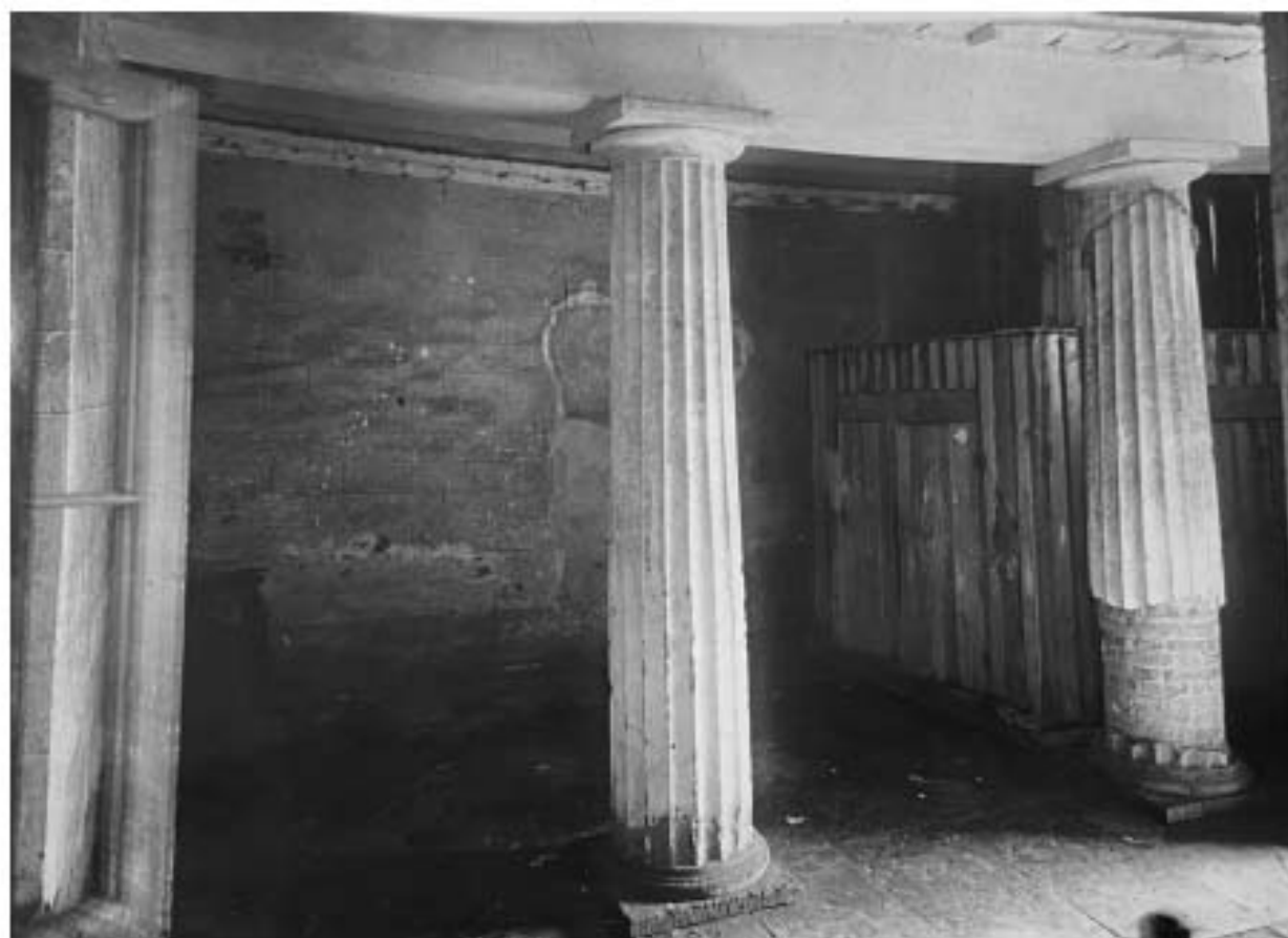
Илл. 35. Нижний вестибюль. 1930-е гг. // Архив КТИОП. Инв. №: Н-13880
