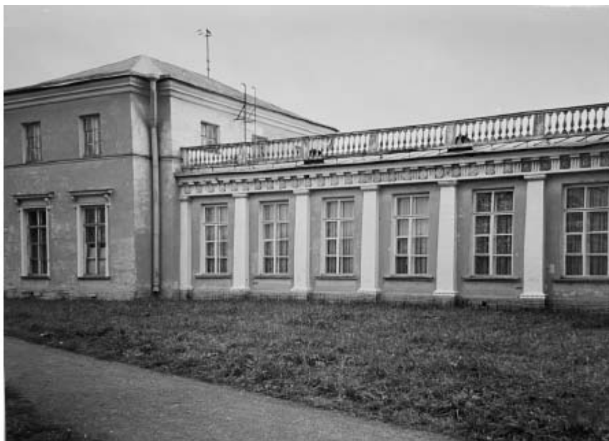
Илл. 82. Дача Чернышева И. Г. «Александрино» с парком. Главный дом. Северный фасад. Восточный флигель и галерея. Ноябрь 2000 г. // Архив КГИОП. Инв. №: 1039л.
