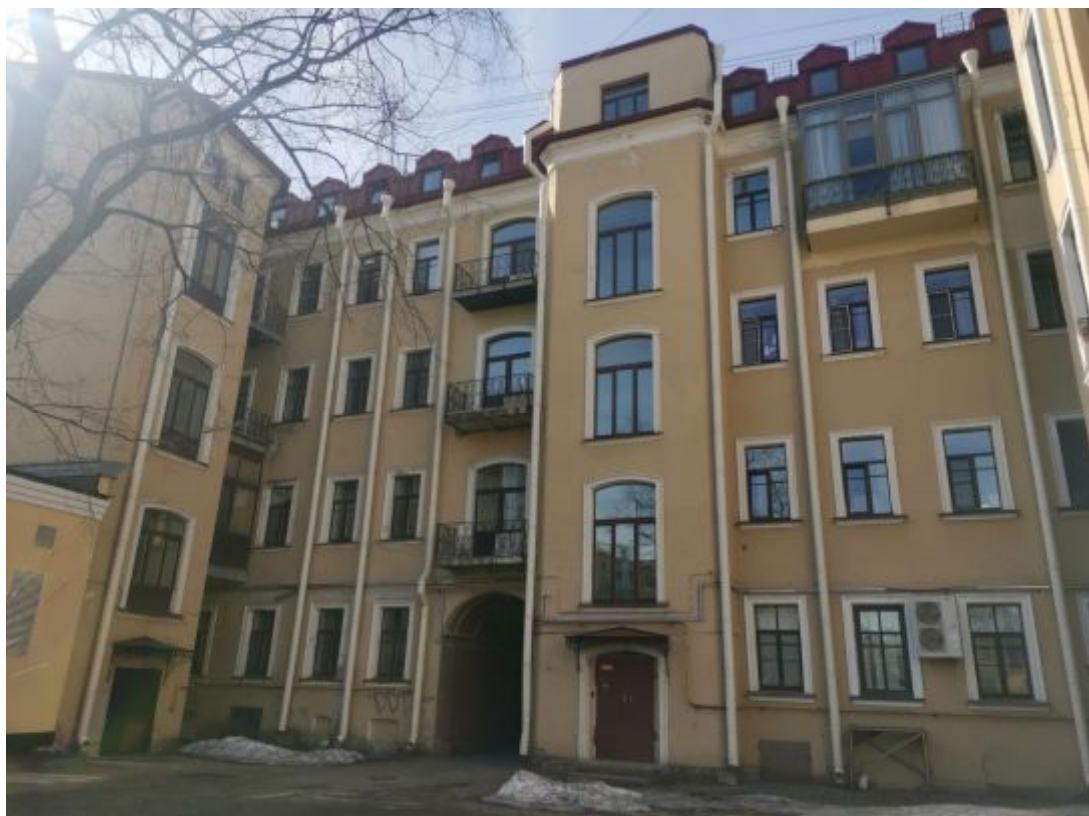
Фото № 3. Общий вид дворового фасада здания
