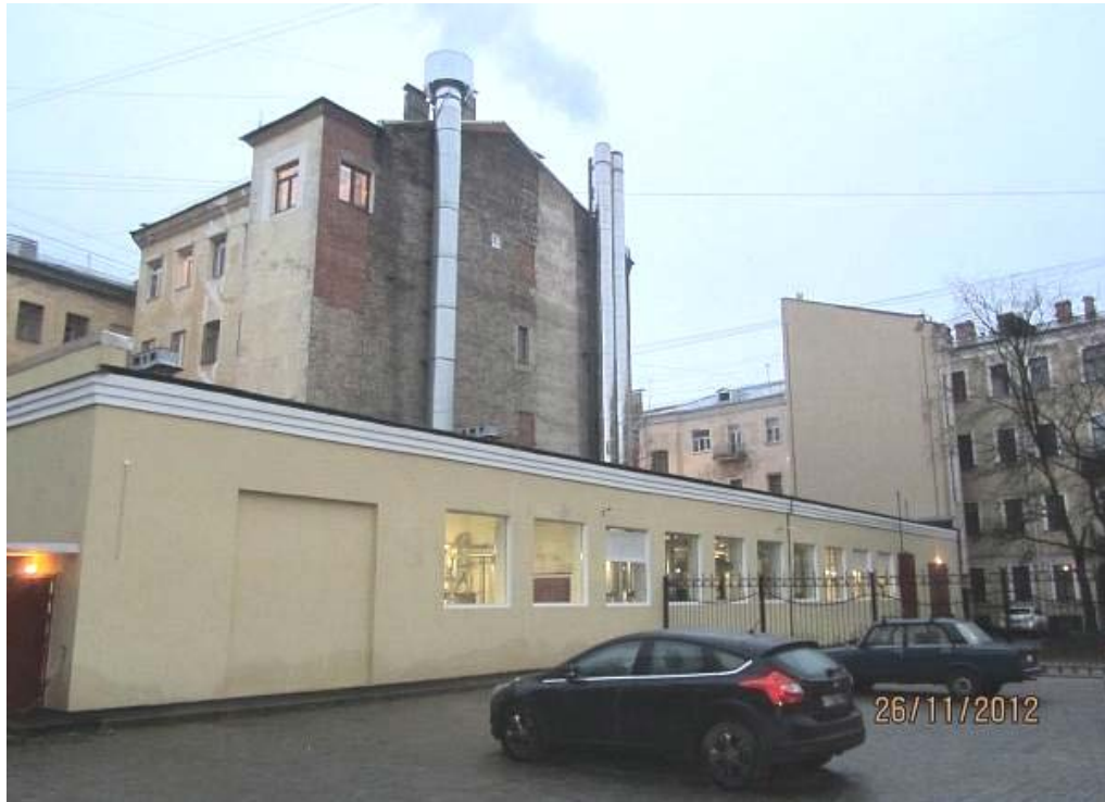
Илл. 15. Социалистическая ул., дом 8 лит. Б (котельная). Фотоснимок 2012 г. (справа – фрагмент дворового фасада дома 8 лит. А)
