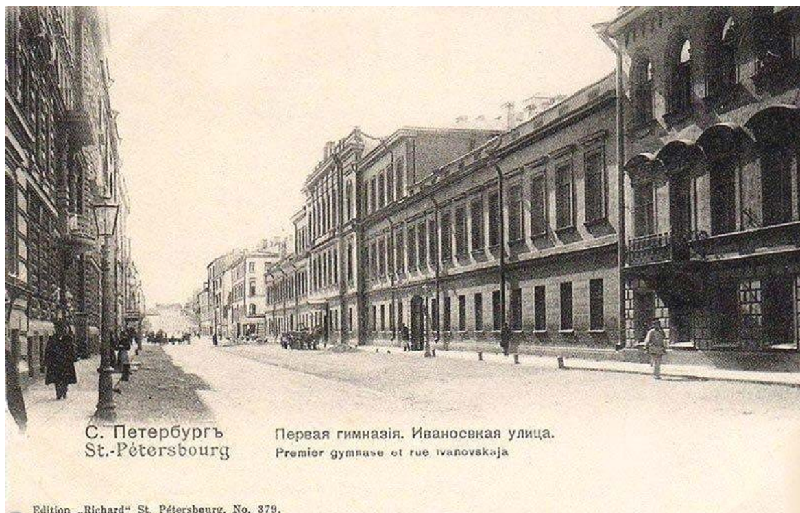
Илл. 12. Ивановская улица. Фотоснимок с открытки начала XX в. (слева – фрагмент фасада дома 8)
