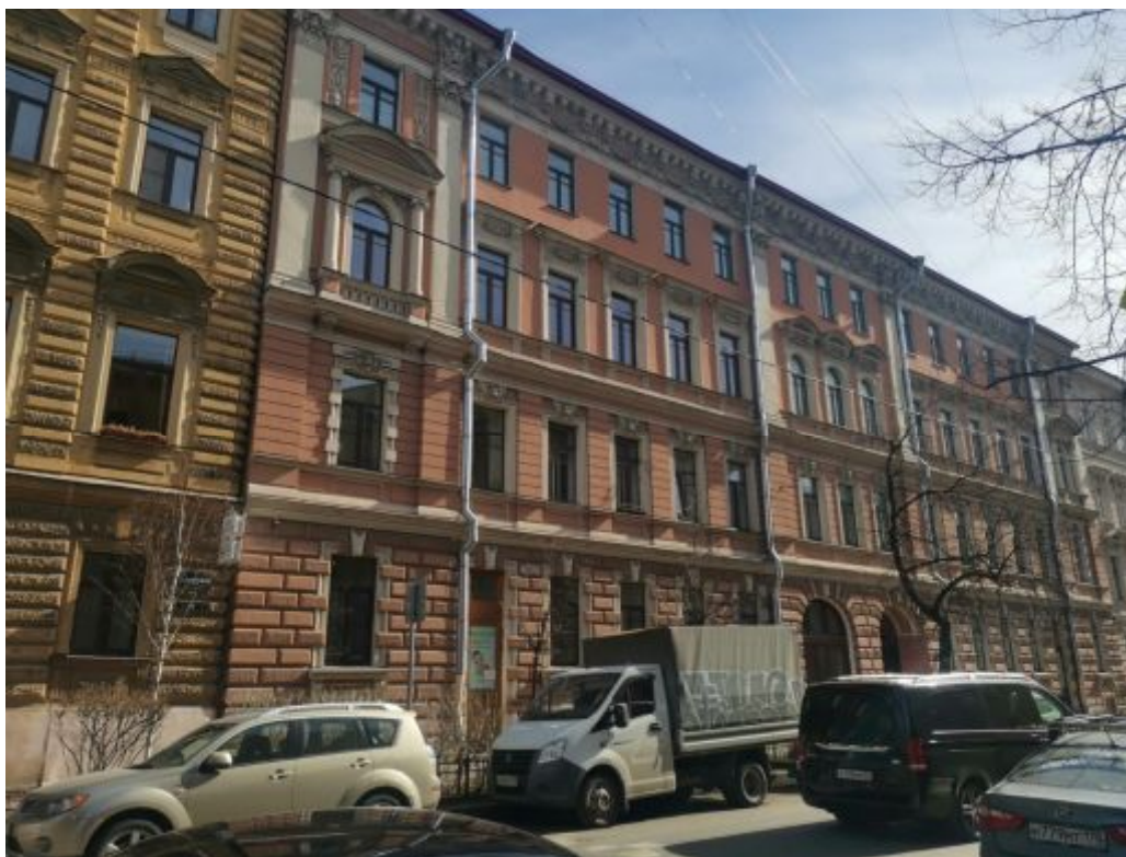
Фото № 1. Общий вид лицевого фасада здания
