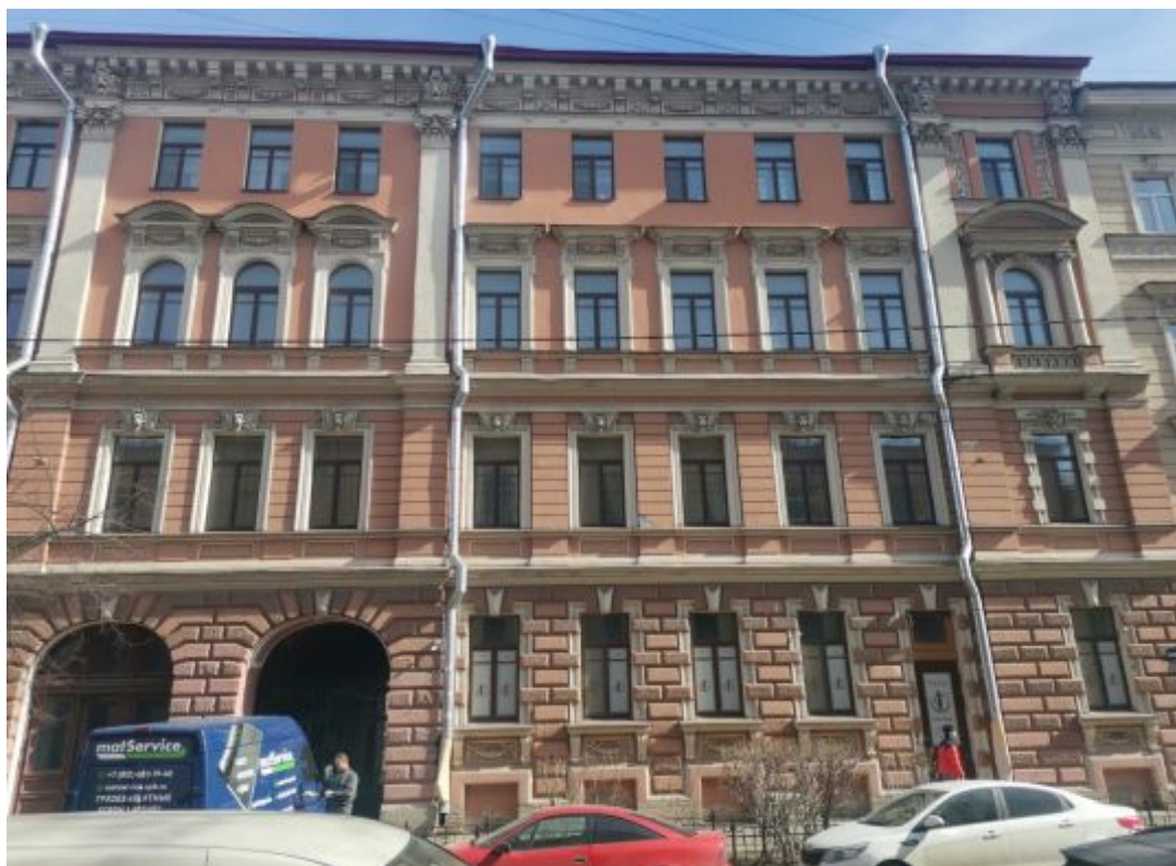
Фото № 2. Фрагмент фасада здания
