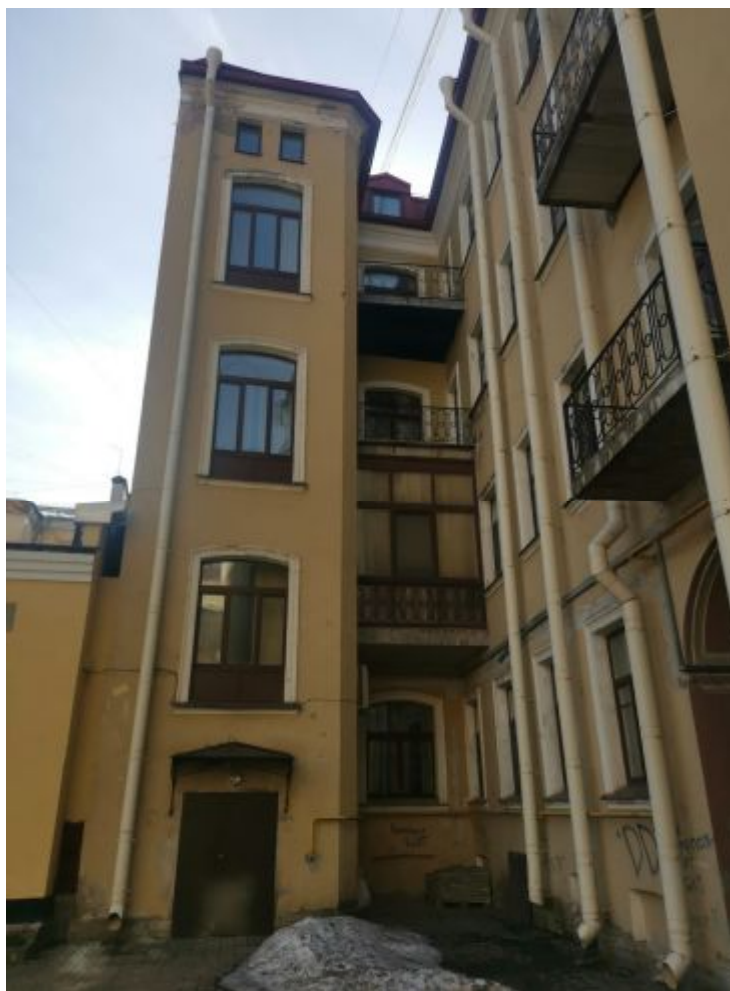
Фото № 4. Фрагмент дворового фасада здания
