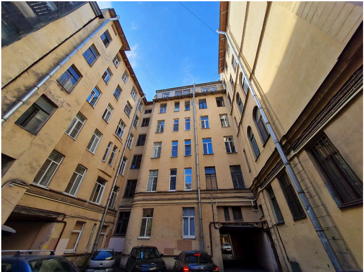
3. Выявленный объект культурного наследия «Дом М.Н. и Е.В. Беляевых» (Санкт-Петербург, Лермонтовский пр., д. 50, лит. А). Дворовый фасад.
