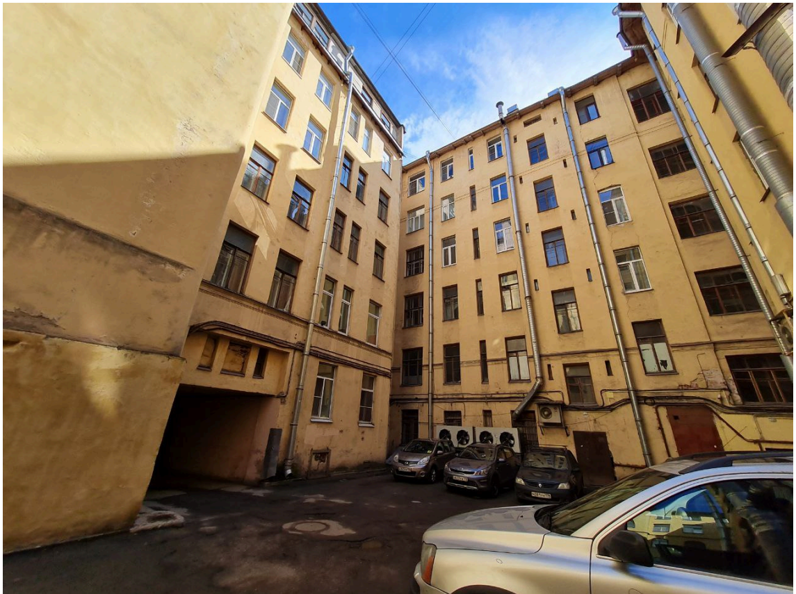
7. Выявленный объект культурного наследия «Дом М.Н. и Е.В. Беляевых» (Санкт-Петербург, Лермонтовский пр., д. 50, лит. А). Дворовый фасад.
