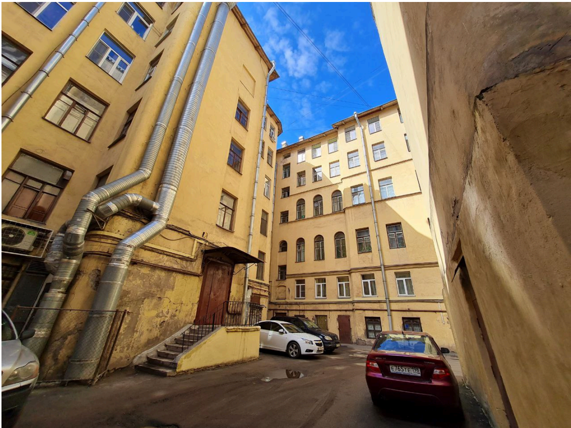
5. Выявленный объект культурного наследия «Дом М.Н. и Е.В. Беляевых» (Санкт-Петербург, Лермонтовский пр., д. 50, лит. А). Дворовый фасад.
