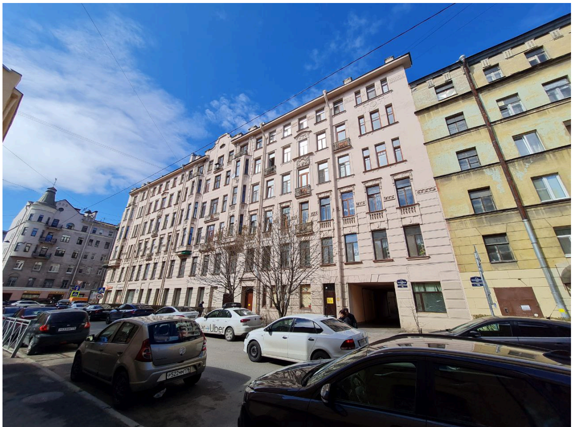
2. Выявленный объект культурного наследия «Дом М.Н. и Е.В. Беляевых» (Санкт-Петербург, Лермонтовский пр., д. 50, лит. А). Южный фасад.
