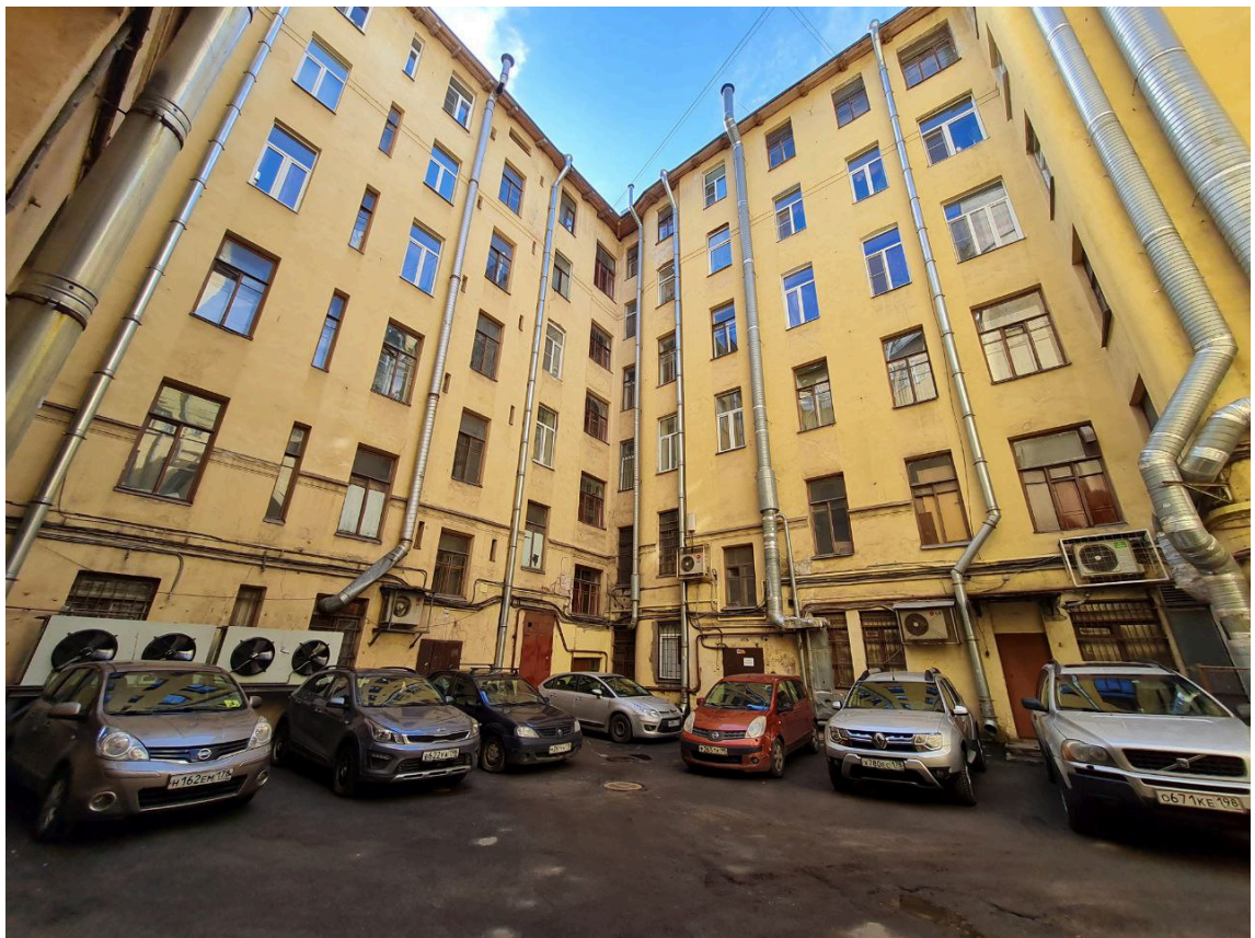
4. Выявленный объект культурного наследия «Дом М.Н. и Е.В. Беляевых» (Санкт-Петербург, Лермонтовский пр., д. 50, лит. А). Дворовый фасад.
