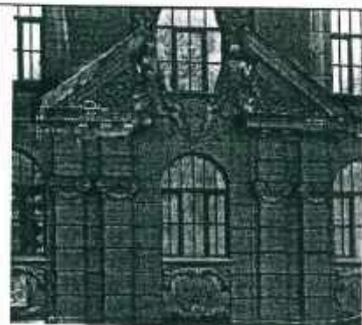
эркер на лицевом фасаде с балконом на уровне 4-го этажа с металлическим ограждением простого рисунка, филеятым фризом в завершении; основание эркера с выпущенными балками, образующими кессоны;
