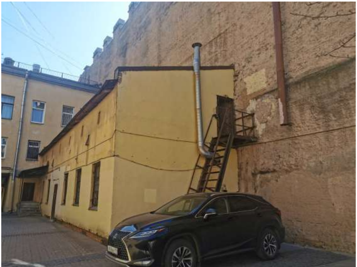
Фото 4. Вид на фасад со стороны двора детского сада.
