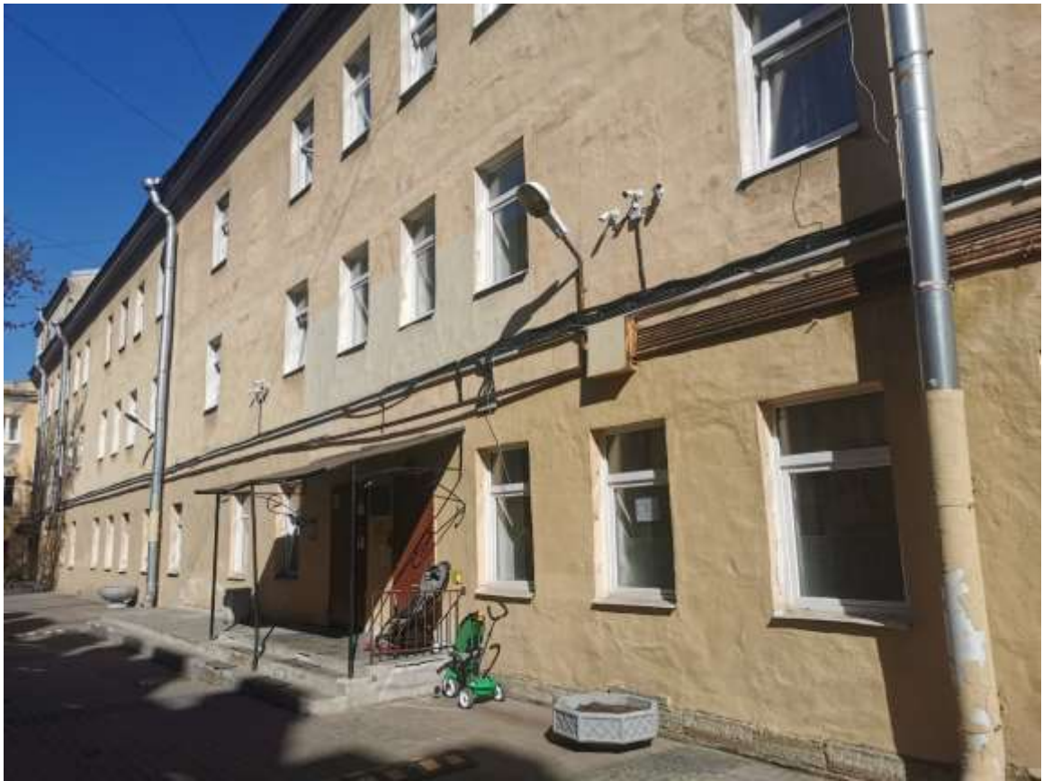
Фото 5. Вид на центральный вход в детский сад со стороны двора.
