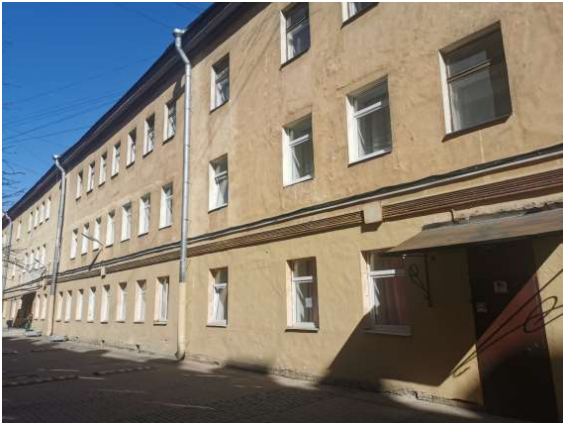
Фото 3. Вид на фасад со стороны двора детского сада.
