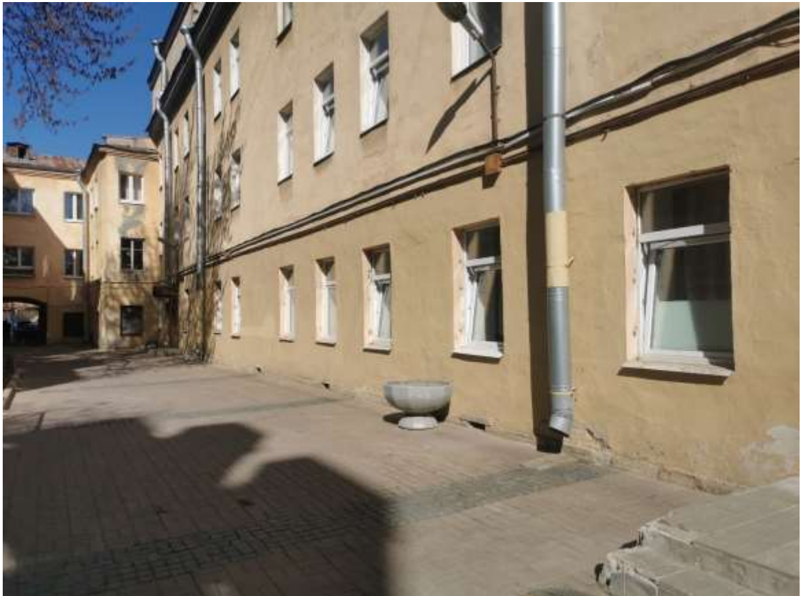
Фото 6. Вид на фасад со стороны двора детского сада.
