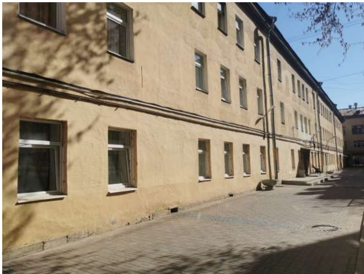
Фото 8. Вид на центральный вход в детский сад со стороны двора.
