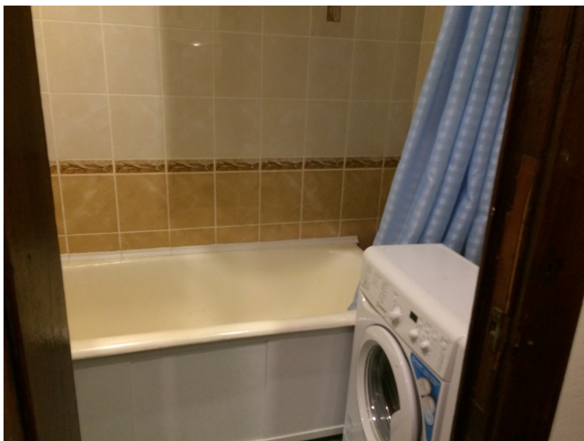
Фото 15. Интерьер кв. 20 (Помещение 6).
