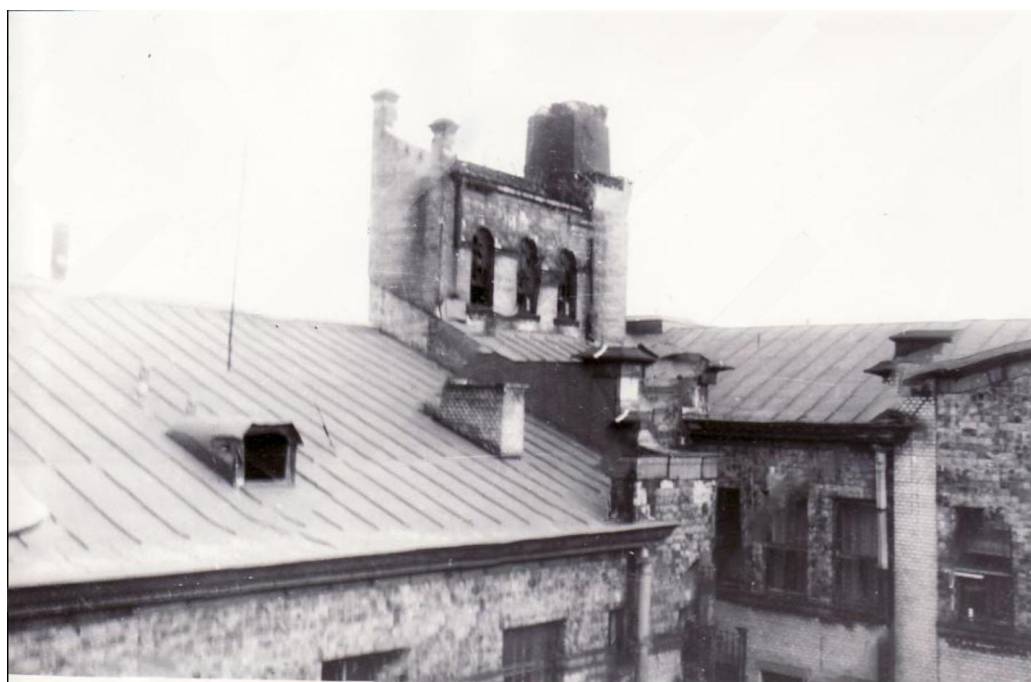
Илл 51. Вид кровли дома № 72 по улице Марата ( бывший дом "Торгово - Промышленного товарищества Ф.Г.Бажанова и А.П..Чувалдиной", архитектор П.Ф.Алешин.) 1987 г. ЦГАКФФД СПб Ар 217786
