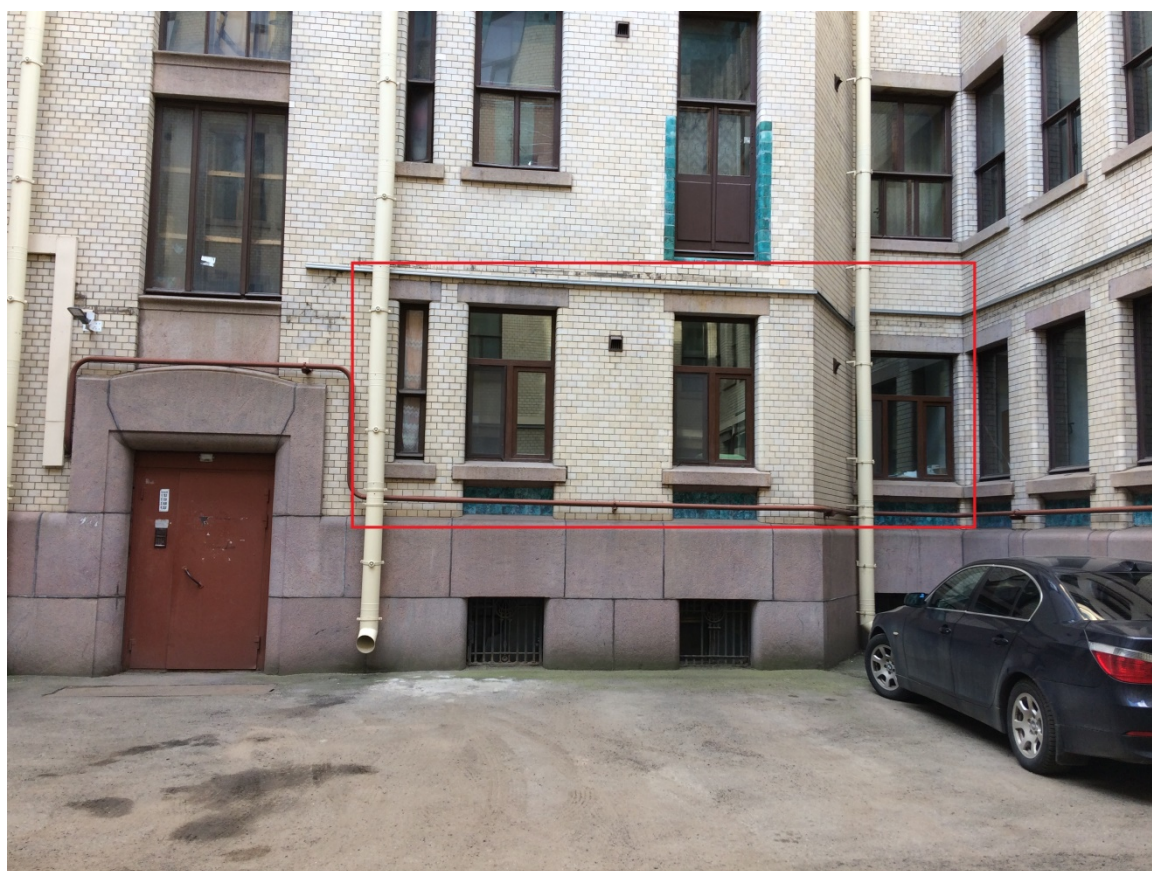
Фото 2. Вид на дворовой фасад. Оконные проемы квартиры 20.
