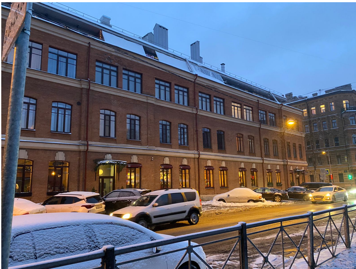
1. Лицевой фасад со стороны Виленского переулка
